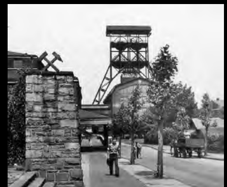
Blick auf den Förderturm der Zeche Dahlbusch (1950er Jahre).
