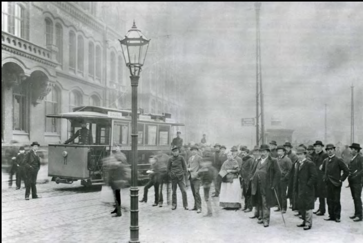
Eine sehr frühe Aufnahme der Straßenbahn am Neumarkt (um 1895). Vorn eine sechseckige Gas-Modellleuchte mit Schnittbrenner auf einem Bündelpfeiler, Bild Siemens Historical Institute
