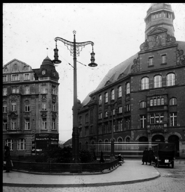
Oben links: Doppelarmige Gashängelicht-Kandelaber mit Invert-Hängeleuchten für Handbedienung (vermutlich Graetzin) am Ückendorfer Platz, rechts hinten noch eine Rech Elektra-Aufsatzleuchte; rechts doppellarmiger Mast mit gusseisernem Sockel und zwei Pressgas-Hängeleuchten, im Hintergrund das Postamt; unten einfacher doppellarmiger Betonlichtmast mit Graetzin-Hängeleuchten am Horster Stern, im Hintergrund das 1912 erbaute Amtshaus. Bildquellen oben May Majer/Sammlung Weichelt; unten Forum Gelsenkirchener Geschichten
