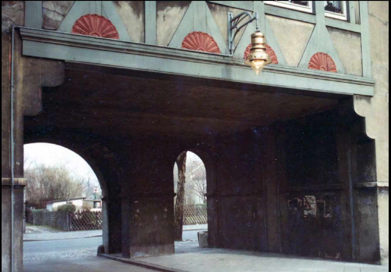
Jugendstil-Wandarm mit Gogas-Hängeleuchte Modell 049. Auffällig auch die lange Gasleitung. Bild Dieter Grundmann
