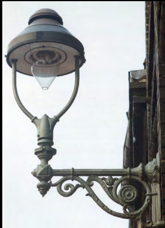
V.l.n.r.: Abgesetzter Stahlmast; Wandarm aus Stahlrohr mit GICS-Modell Neulicht-52; Mitte und rechts Gusswandarm mittelrheinische Bauart mit GICS-Modell Neulicht-52. Bildreihe oben Klaus Gevatter; unten Dieter Grundmann
