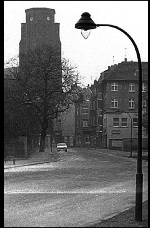
Oben: GICS Modell Neulicht-52 mit Auer P40-Glocke; GICS Modell Neulicht-52 an Benteler-Auslegermast, Lichtpunkthöhe 5m; Ausleger 1,25 m; rechts GICS Modell Neulicht-konvex. Bilder links Klaus Gevatter, in der Mitte Dieter Grundmann, rechts Forum Gelsenkirchener Geschichten
