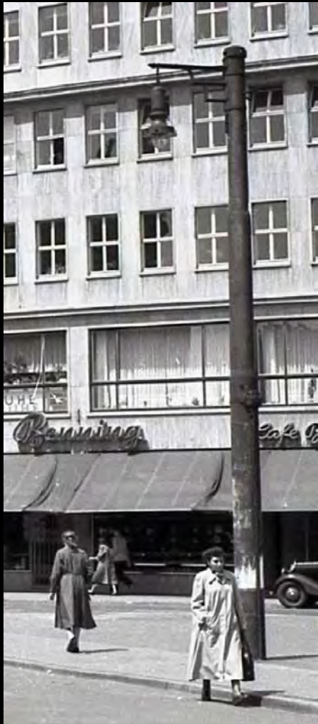
Oben: Am Neumarkt (1953), Graetzin-Hängeleuchte an Ausleger, der an einem Fahrlitungsmast der Straßenbahn montiert ist: Rechts Graetzin-Hängeleuchte an Stahlmast in der Florastraße (1953)
