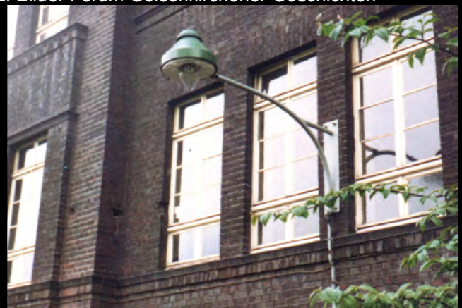
Stahlrohr-Wandarme von Benteler mit GICS-Leuchten Modell Neulicht-52, vierflammig in der Arendtstraße; rechts gleiches Leuchten-Modell, aber sechsflammig, in der Fontanestraße/Berufskolleg. Bilder Klaus Gevatter
