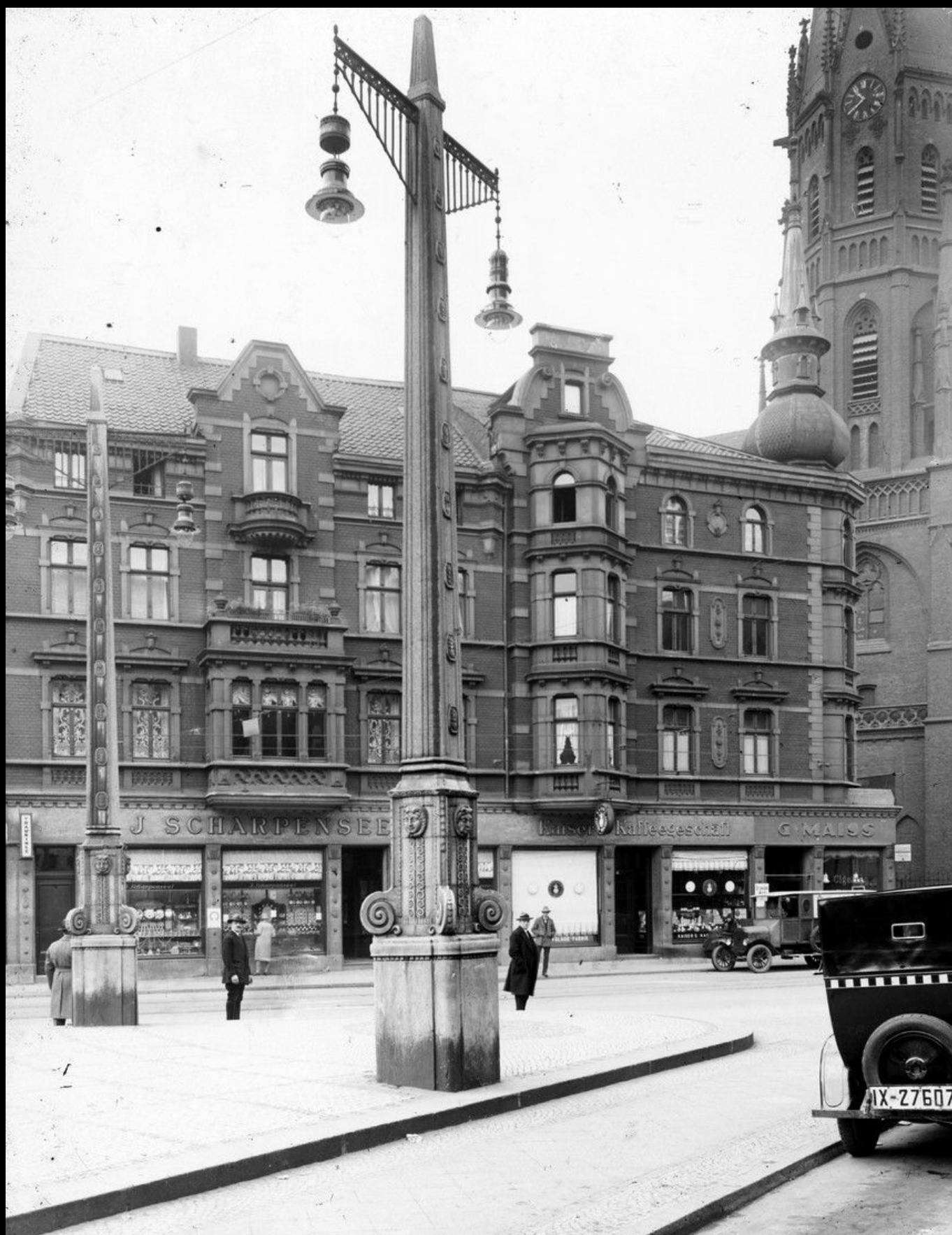
Monumentale Lichtständer auf Granitsockeln am Neumarkt. Schmiedeeiserne Ausleger, daran Gashängeleuchten aus der frühen Ära mit außen liegendem Fernzündler, eine Hängeleuchte wurde bereits durch ein neues Modell ausgetauscht (Graetzin, neunflammig) Die Lichtmaste wirken wie Jugendstil, wurden aber wohl erst nach 1920 aufgestellt. Über die Herkunft bzw. den Hersteller, Entwerfer war bisher nichts herauszubekommen. Bildquelle Max Majer/Sammlung Weichelt
