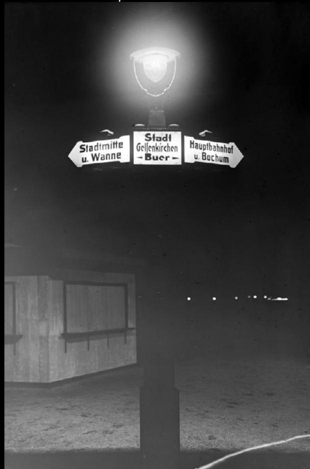
Tag/Nacht-Vergleich. Die Glasglocke ist teilmatteiert, ähnlich dem späteren Modell Wiesbaden
