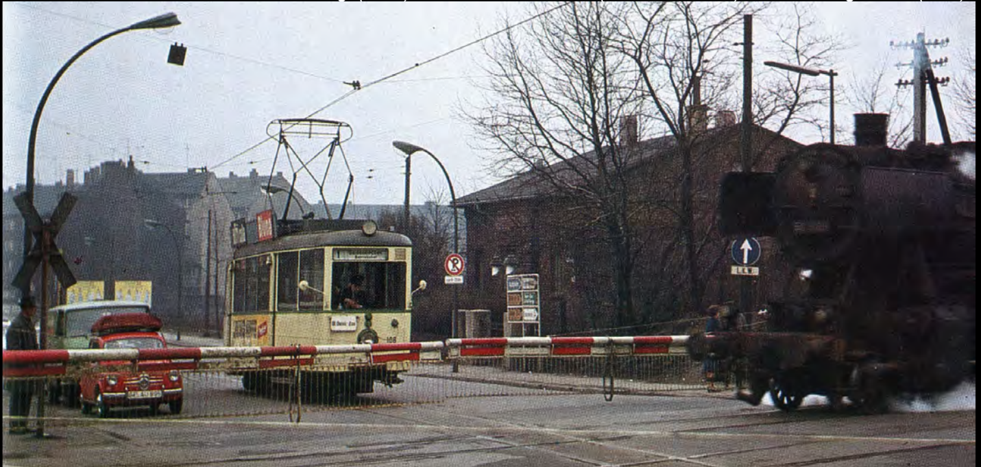
Reihenleuchten von GICS (L56 vorn) und Bamag (U13H hinten), außerdem zwei GICS-Verkehrsschild-Gasleuchten (unten ein anderer Bildausschnitt, besser zu sehen, siehe dazu auch Seite 38) in Bildmitte an Bahnübergang Bismarckstraße (1965). Bild Frits van der Gragt.
