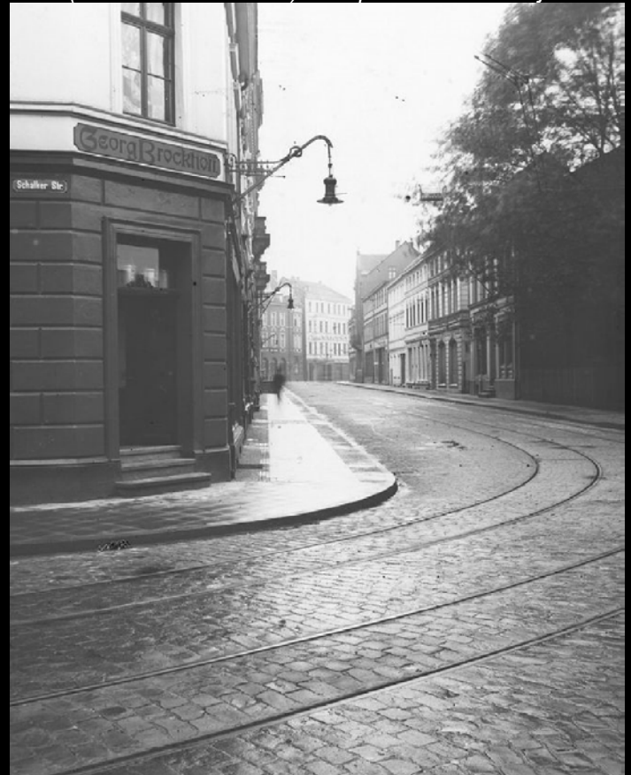
Viele Gashängeleuchten waren in der Stadt installiert worden. Oben ein frühes Modell (vermutlich Himmel mit außen liegendem Fernzündler) auf dem Kaiserplatz (um 1920); unten links Pressgas-Hängeleuchte (Graetzin oder Himmel) an einem Mast, Ausleger ähnlich wie die aus Berlin bekannten „Bischofsstäbe“, in der Bankstraße; rechts Graetzin-Hängeleuchten an Wandauslegern in der Schalker Straße (beides 1920er Jahre). Bildquellen Archiv Majer
