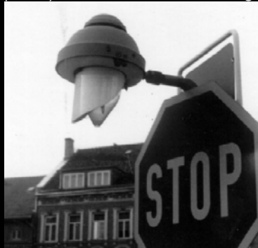
Reihenleuchten von GICS (L56 vorn) und Bamag (U13H hinten), außerdem zwei GICS-Verkehrsschild-Gasleuchten (unten ein anderer Bildausschnitt, besser zu sehen, siehe dazu auch Seite 38) in Bildmitte an Bahnübergang Bismarckstraße (1965). Bild Frits van der Gragt.
