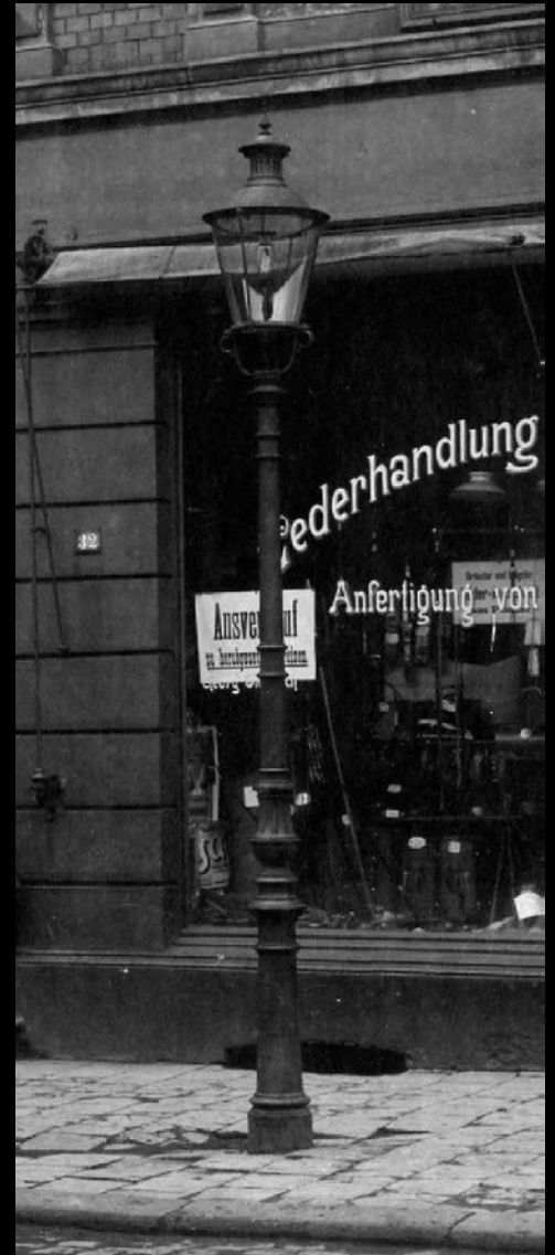
Ritter-Rundmantellaterne in Gelsenkirchen (Standort nicht bekannt) um 1910. Stehendes Gasglühlicht. Bildausschnitt. (Komplett auf Seite 51)
