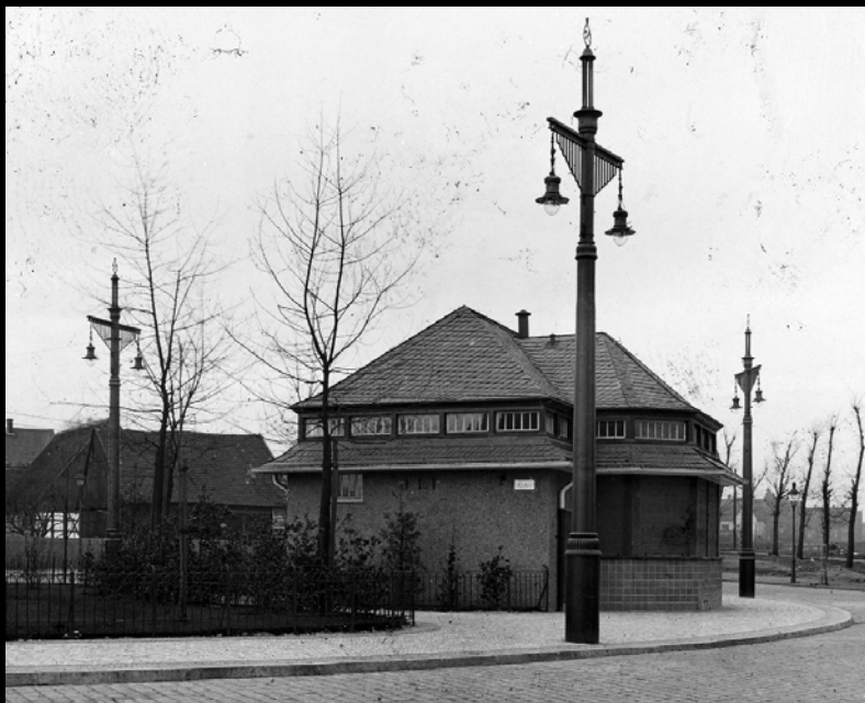
Oben links: Doppelarmige Gashängelicht-Kandelaber mit Invert-Hängeleuchten für Handbedienung (vermutlich Graetzin) am Ückendorfer Platz, rechts hinten noch eine Rech Elektra-Aufsatzleuchte; rechts doppellarmiger Mast mit gusseisernem Sockel und zwei Pressgas-Hängeleuchten, im Hintergrund das Postamt; unten einfacher doppellarmiger Betonlichtmast mit Graetzin-Hängeleuchten am Horster Stern, im Hintergrund das 1912 erbaute Amtshaus. Bildquellen oben May Majer/Sammlung Weichelt; unten Forum Gelsenkirchener Geschichten
