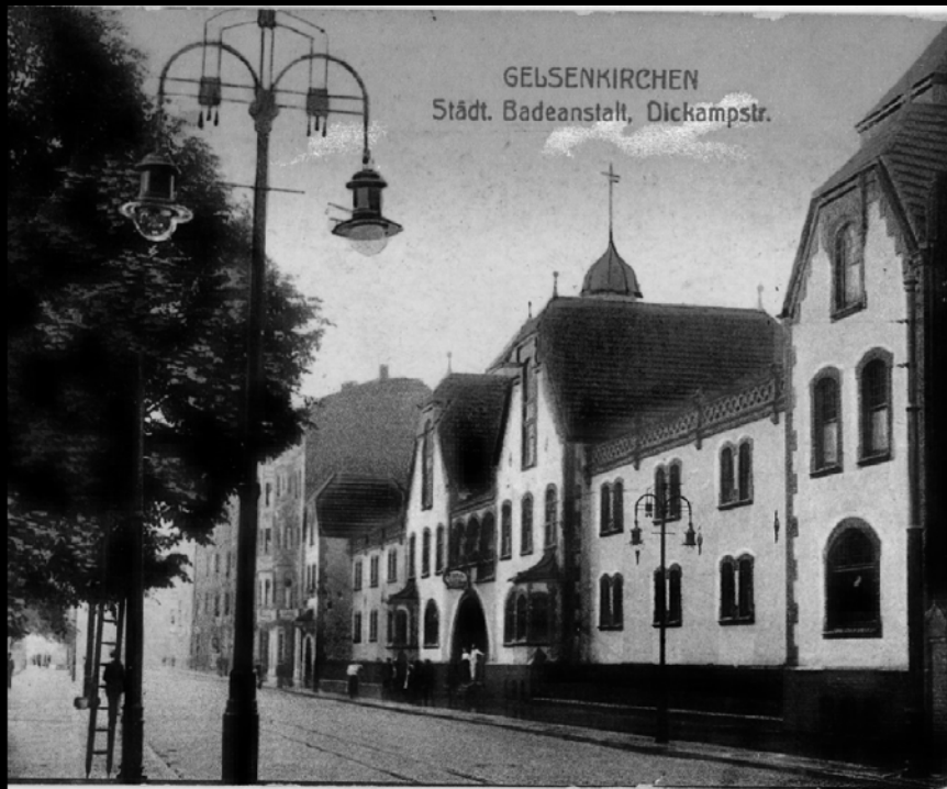
Oben Kandelaberaufsatz mit Doppelhängelicht von G. Himmel, mit Invert-Hängeleuchten für Handbedienung, Unten Pressgas-Hängeleuchte an Überspannung, Dickampstraße um 1910. Bild oben Postkarte; unten Karlheinz Weichelt.
