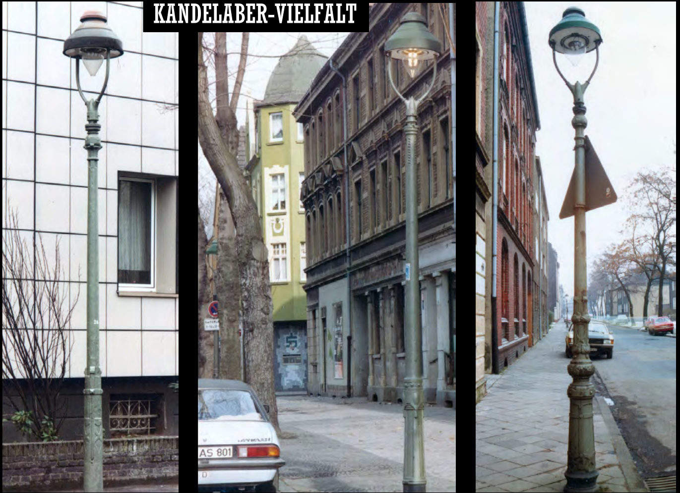
Obere Reihe v.l.n.r.: Gusskandelaber ähnlich Essen mit GICS-Leuchte Neulicht-52, Gusskandelaber ebenfalls mit Neulicht-52, Gusskandelaber schwere Bauart mit GICS-Leuchte Neulicht-Konvex
