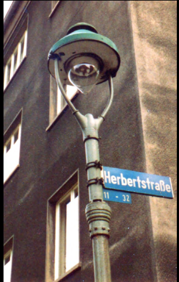
V.l.n.r.: Mannesmann-Stahlkandelaber Modell Rhein-Ruhr mit GICS Modell Neulicht-konvex; Modell Neulicht-52 mit Erdgas-Zündflamme und Auer P40-Glocke; Modell Neulicht-konvex auf Kandelaber-Verlängerung
