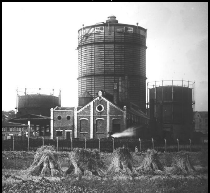
Das Gaswerk Buer nach der Erweiterung 1920 mit dem 46 Meter hohen Gasometer. Bild Stadtarchiv GE
