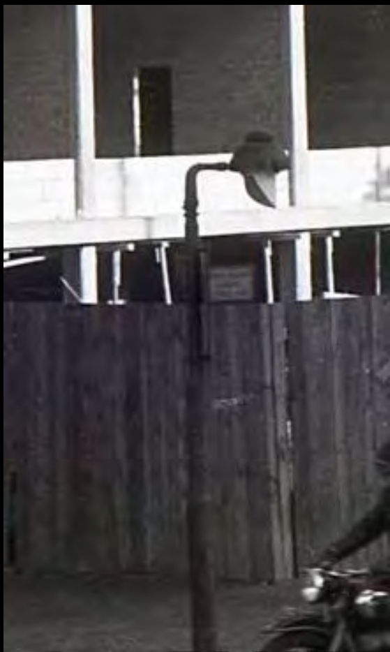
Eine weitere Besonderheit stellt ab 1952 diese Verkehrsschildleuchte von Schneider dar. Die Aufnahme stammt aus der Overwegstraße.
