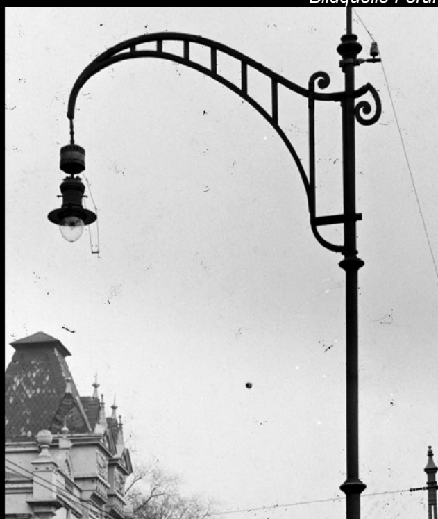
Links Bochumer Straße, Jugendstilkandelaber mit Ausleger, daran Invert-Gashängeleuchten (vermutlich Graetzin) mit Fernzündergehäuse; rechts Überspannung mit Herablassvorrichtung für Gashängeleuchte (vermutlich Graetzin) in der Hochstraße (vor 1910). Bild unten links Max Majer; rechts Forum Gelsenkirchener Geschichten
