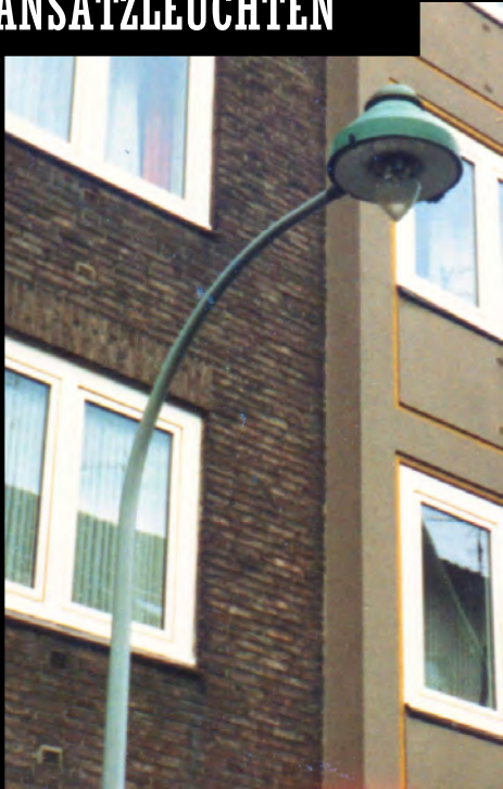
Oben: GICS Modell Neulicht-52 mit Auer P40-Glocke; GICS Modell Neulicht-52 an Benteler-Auslegermast, Lichtpunkthöhe 5m; Ausleger 1,25 m; rechts GICS Modell Neulicht-konvex. Bilder links Klaus Gevatter, in der Mitte Dieter Grundmann, rechts Forum Gelsenkirchener Geschichten
