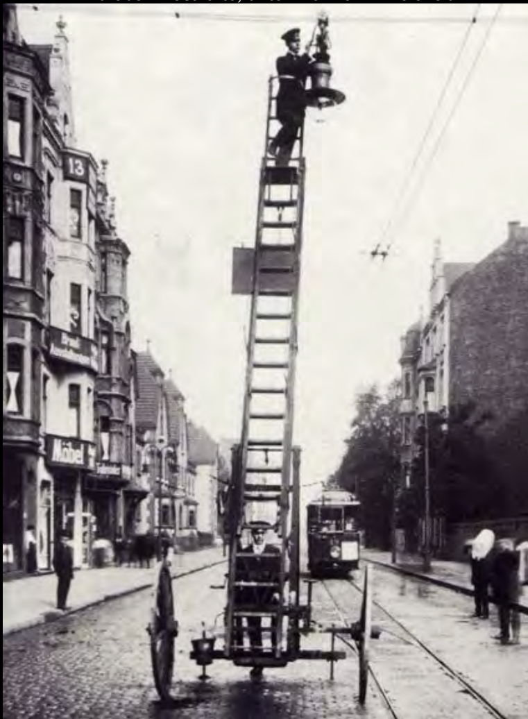
Oben Kandelaberaufsatz mit Doppelhängelicht von G. Himmel, mit Invert-Hängeleuchten für Handbedienung, Unten Pressgas-Hängeleuchte an Überspannung, Dickampstraße um 1910. Bild oben Postkarte; unten Karlheinz Weichelt.
