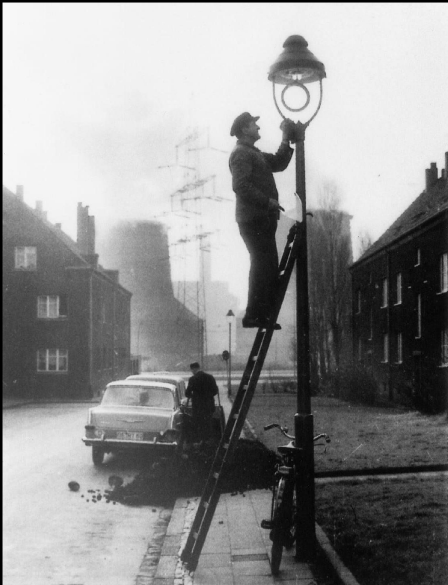
Gute Beleuchtung ist das „A“ und „O“! Wartung einer Gasauflaufleuchte in der Hagebittenstraße (1960er Jahre). Bildquelle Fotoarchiv Ruhmuseum
