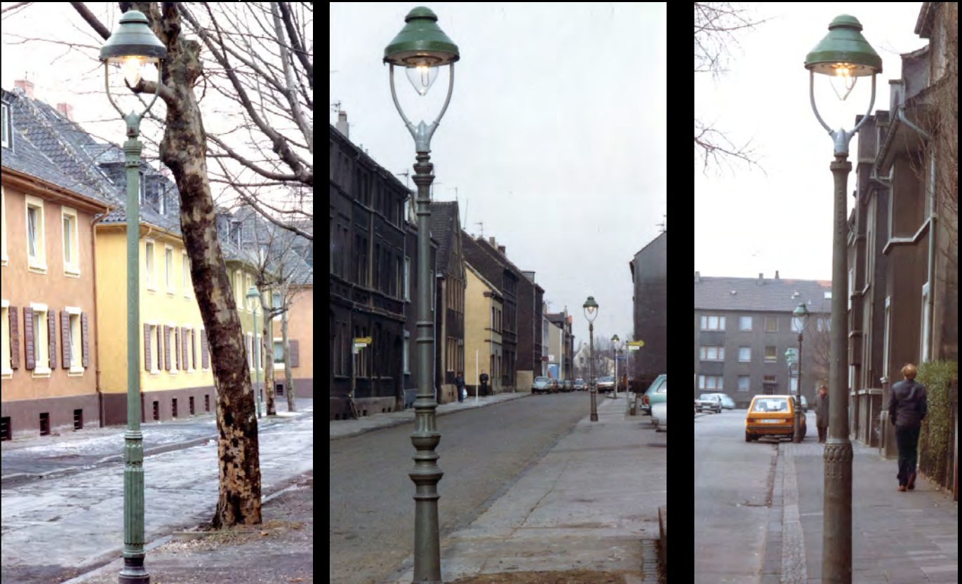
V.l.n.r.: Kandelaber mit „Stahlseele“ und Gusssockel sowie Kapitell, Gusskandelaber mittelrheinischer Bauart mit GICS-Leuchte Modell Neulicht-konvex, Gusskandelaber Bauart Köln mit Verzierung. Bilder Dieter Grundmann
