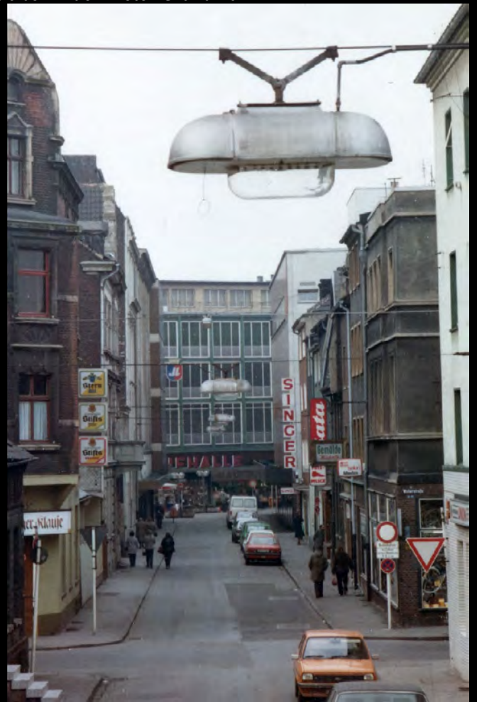
Bis Mitte der 1980er Jahre konnte man in Gelsenkirchen Gashängeleuchten bestaunen, die an Überspannungen über der Straße angebracht waren. Oben die neunflammige Rech-Gashängeleuchte Modell Bielefeld in der Augustastraße; unten die Gasleuchte von Stein & Vendel, eine Hänge/Reihenleuchte mit zehn Flammen. Sie gab es nur in Gelsenkirchen wie hier in der Beskenstraße. Bilder Dieter Grundmann
