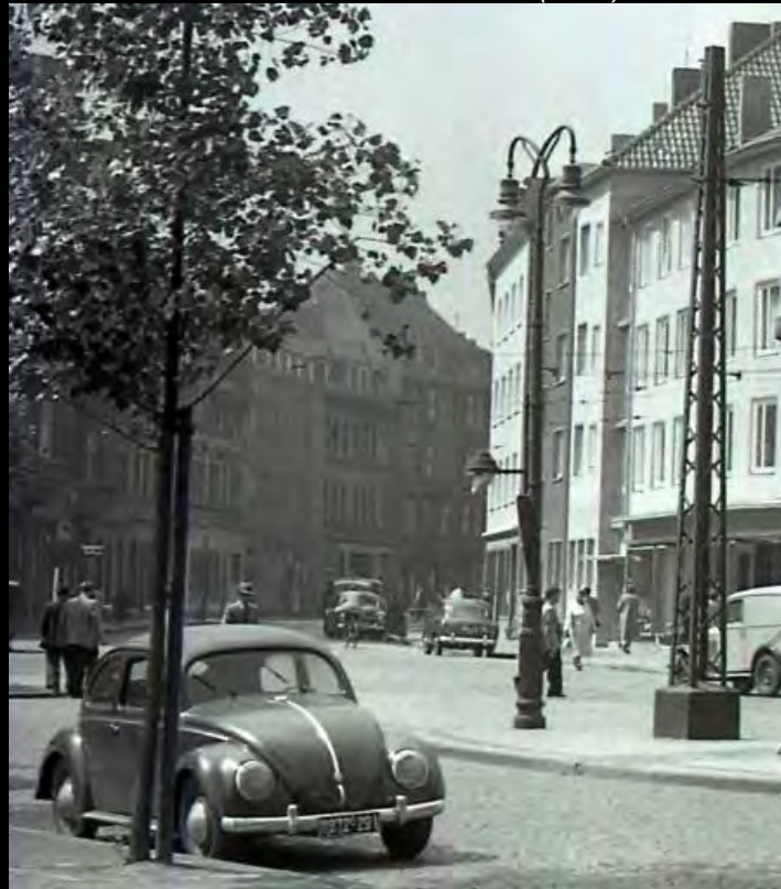
Oben: Am Neumarkt (1953), Graetzin-Hängeleuchte an Ausleger, der an einem Fahrlitungsmast der Straßenbahn montiert ist: Rechts Graetzin-Hängeleuchte an Stahlmast in der Florastraße (1953)
