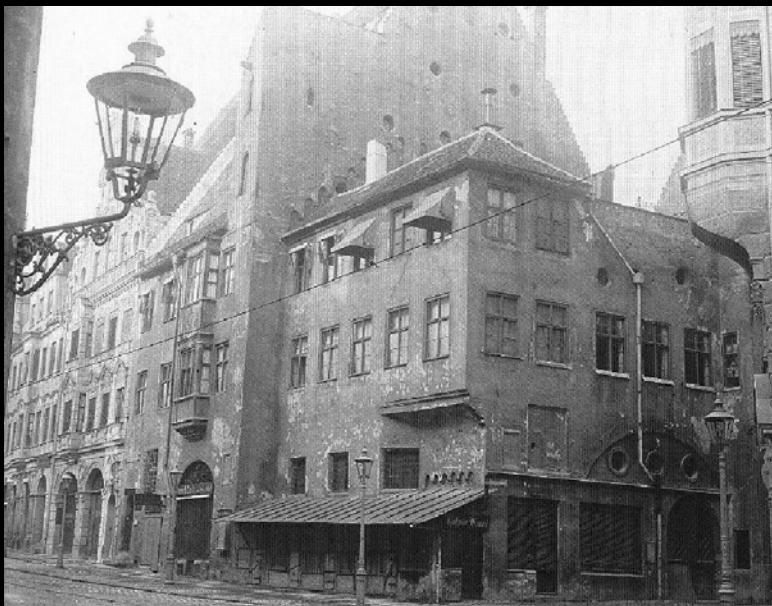
Sechseckige Riedinger-Laternen auf Gusskandelabern oder Wandkonsolen. Bild unbekannt/Sammlung ProGaslicht
