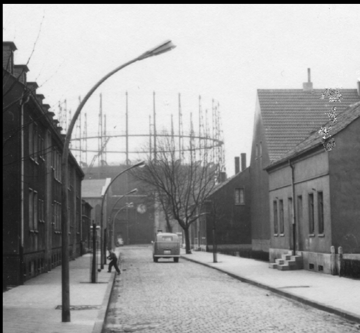
GICS-Gasreihenleuchten L56 in der Gasstraße mit Blick auf den Gasbehälter. Bild GICS Archiv
