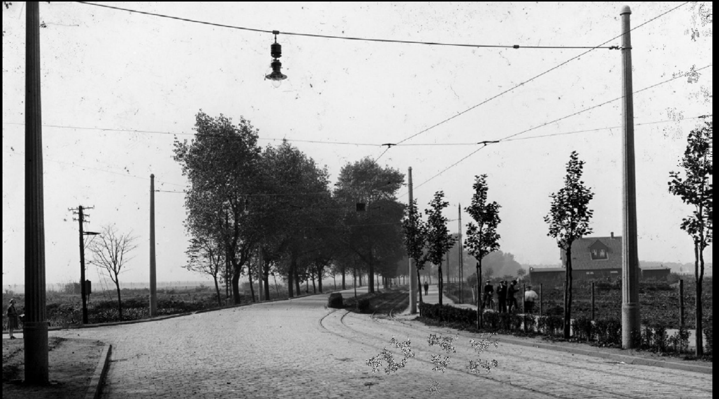
Oben: Feldmarkstraße (Mitte der 1920er Jahre). Überspannungen (System Gelsenkirchen) an säulenartig gestalteten Betonmasten mit Invert-Gashängeleuchten (vermutlich Graetzin); unten frühes Überspannungssystem mit Invert-Hängeleuchten (wahrscheinlich Graetzin) in der Bochumer Straße. Bildquelle Archiv Majer
