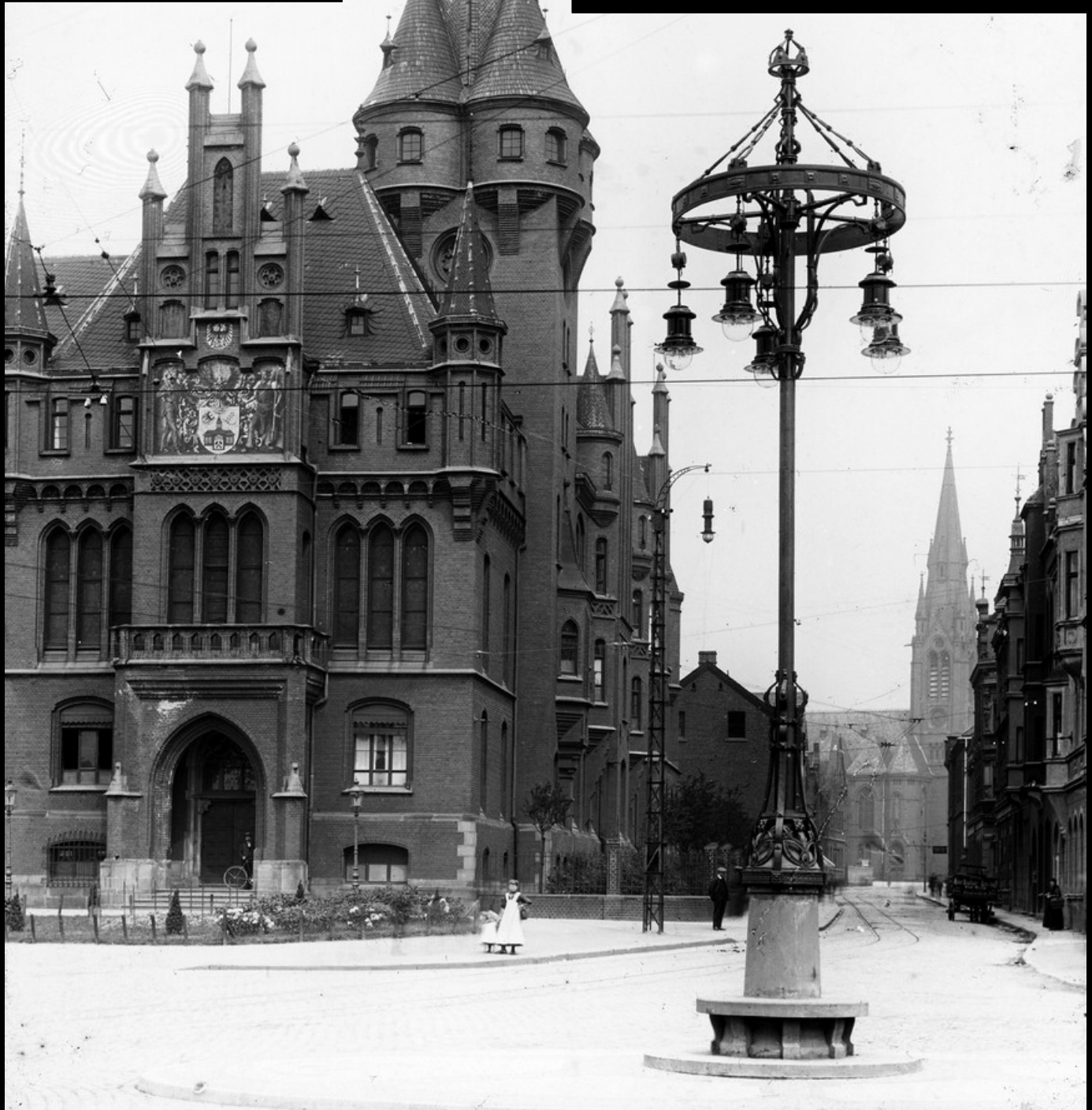
Hochmast im Jugendstil mit frühen Invert-Gashängeleuchten von Graetzin, im Hintergrund ein Gittermast mit elektrischer Kohlenbogenlampe, weitere Rundmantellaternen vor dem Rathaus. Bild Max Majer/Sammlung Weichelt
