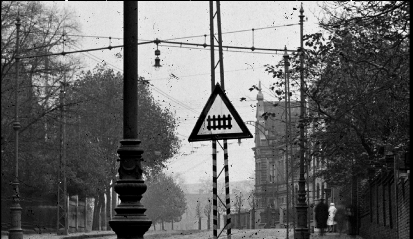
Oben: Feldmarkstraße (Mitte der 1920er Jahre). Überspannungen (System Gelsenkirchen) an säulenartig gestalteten Betonmasten mit Invert-Gashängeleuchten (vermutlich Graetzin); unten frühes Überspannungssystem mit Invert-Hängeleuchten (wahrscheinlich Graetzin) in der Bochumer Straße. Bildquelle Archiv Majer
