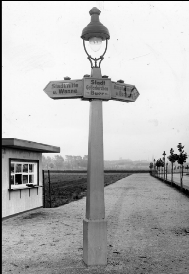
Tag/Nacht-Vergleich. Die Glasglocke ist teilmatteiert, ähnlich dem späteren Modell Wiesbaden
