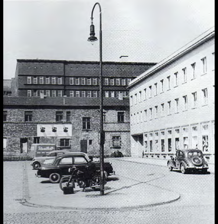
Links Blick in die Tilsiter Straße (um 1957). Hier eine Gasaufsatzleuchte mit Stahlmast. Die Siedlung an der Tilsiter Straße war für Vertriebene errichtet worden; rechts Gashängeleuchte (Graetzin) in der Hans-Sachs-Straße (vor 1956).
