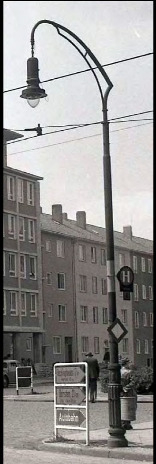
Die auffälligen Hängelichtmaste Gelsenkirchens mit Auslegern im Jugendstil und gusseisernem Ziersockel. Neunflammige Hängeleuchte von Graetzin.
