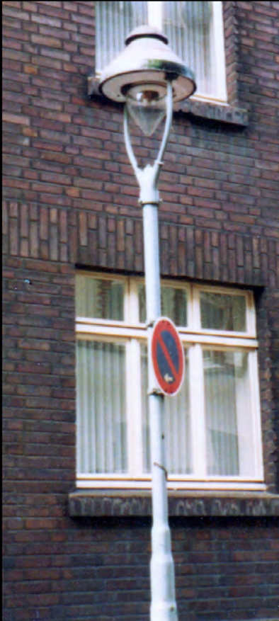
V.l.n.r.: Mannesmann-Stahlkandelaber Modell Rhein-Ruhr mit GICS Modell Neulicht-konvex; Modell Neulicht-52 mit Erdgas-Zündflamme und Auer P40-Glocke; Modell Neulicht-konvex auf Kandelaber-Verlängerung
