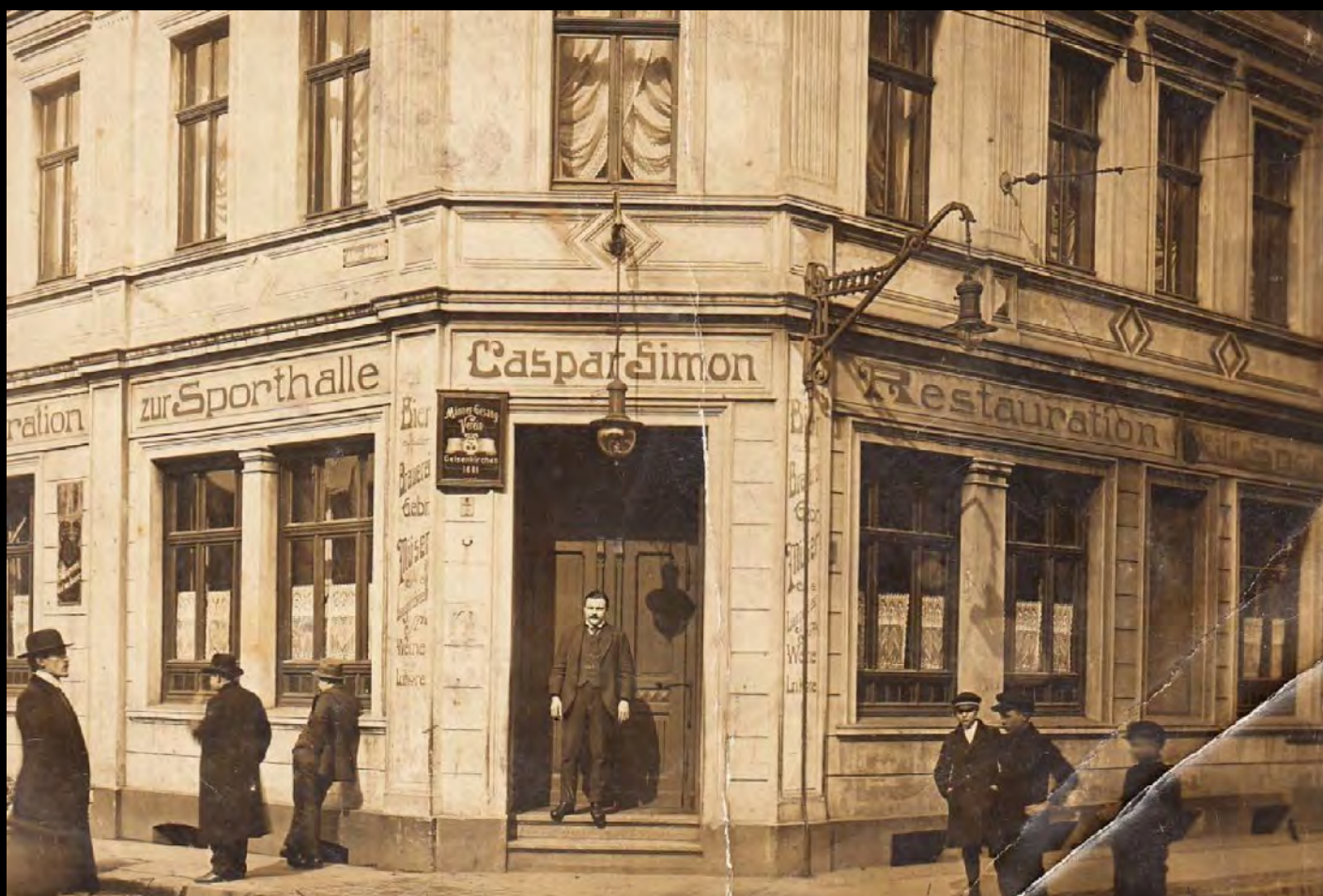
Alter Markt: Gaststätte zur Sporthalle, über dem Eingang eine private Gashängelampe mit stehendem Gasglühlicht, am Haus ein Wandarm im Jugendstil mit Invert-Gashängeleuchte (vermutlich Himmel).
