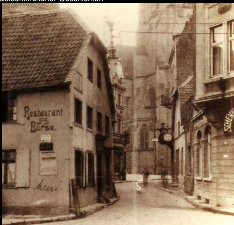
Links Bochumer Straße, Jugendstilkandelaber mit Ausleger, daran Invert-Gashängeleuchten (vermutlich Graetzin) mit Fernzündergehäuse; rechts Überspannung mit Herablassvorrichtung für Gashängeleuchte (vermutlich Graetzin) in der Hochstraße (vor 1910). Bild unten links Max Majer; rechts Forum Gelsenkirchener Geschichten
