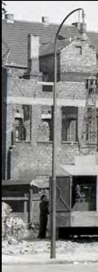
Oben: Am Neumarkt (1953), Graetzin-Hängeleuchte an Ausleger, der an einem Fahrlitungsmast der Straßenbahn montiert ist: Rechts Graetzin-Hängeleuchte an Stahlmast in der Florastraße (1953)
