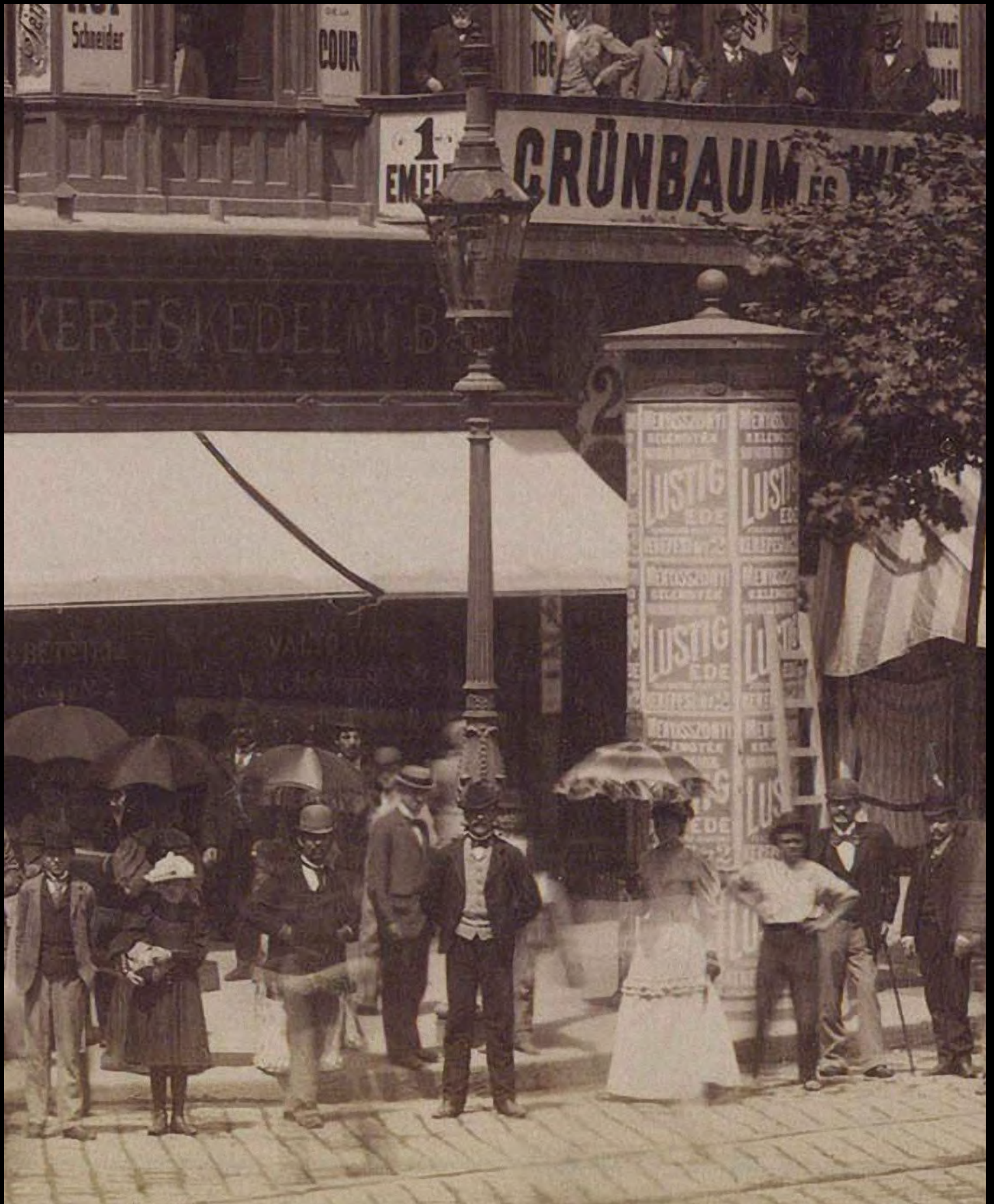
Eine Regenerativ-Gaslaterne mit hohem Schlot im Jahr 1894 auf der Kossuth Lajos Utca (Kossuth Lajos Straße). Leider ist die Technik im Inneren der Laterne nicht genau zu erkennen. Bild Fortepan 82451 (Ausschnitt)
