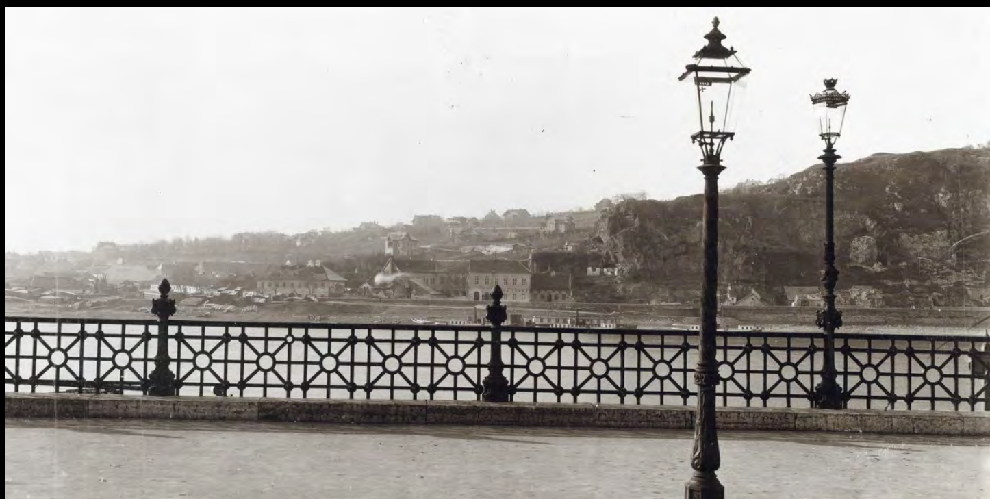
Frühe Gasbeleuchtung, vier- und sechseckige Modelleuchten, vorn mit Glasdach (um 1880). Beide mit offener Flamme. Bildquelle unbekannt/Sammlung ProGaslicht
