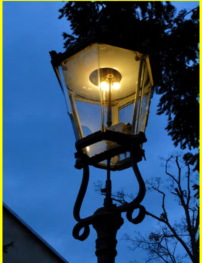
Typisch für Dresden: Eine sechsseitige Gaslaterne mit (leider nur) drei Glühkörpern. Bild Bettina Raetzer-Grimm
