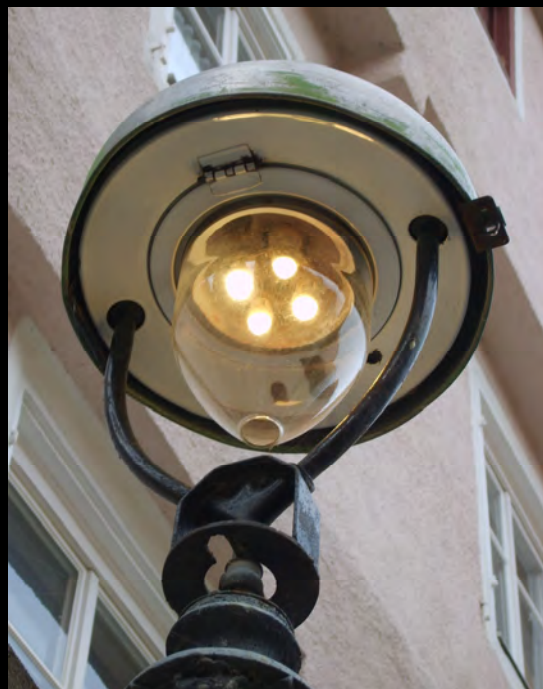
Eine Gasaufsatzleuchte BAMAG U7 wie sie bisher in Nördlingen anzutreffen waren. Bild Oliver Frühschütz
