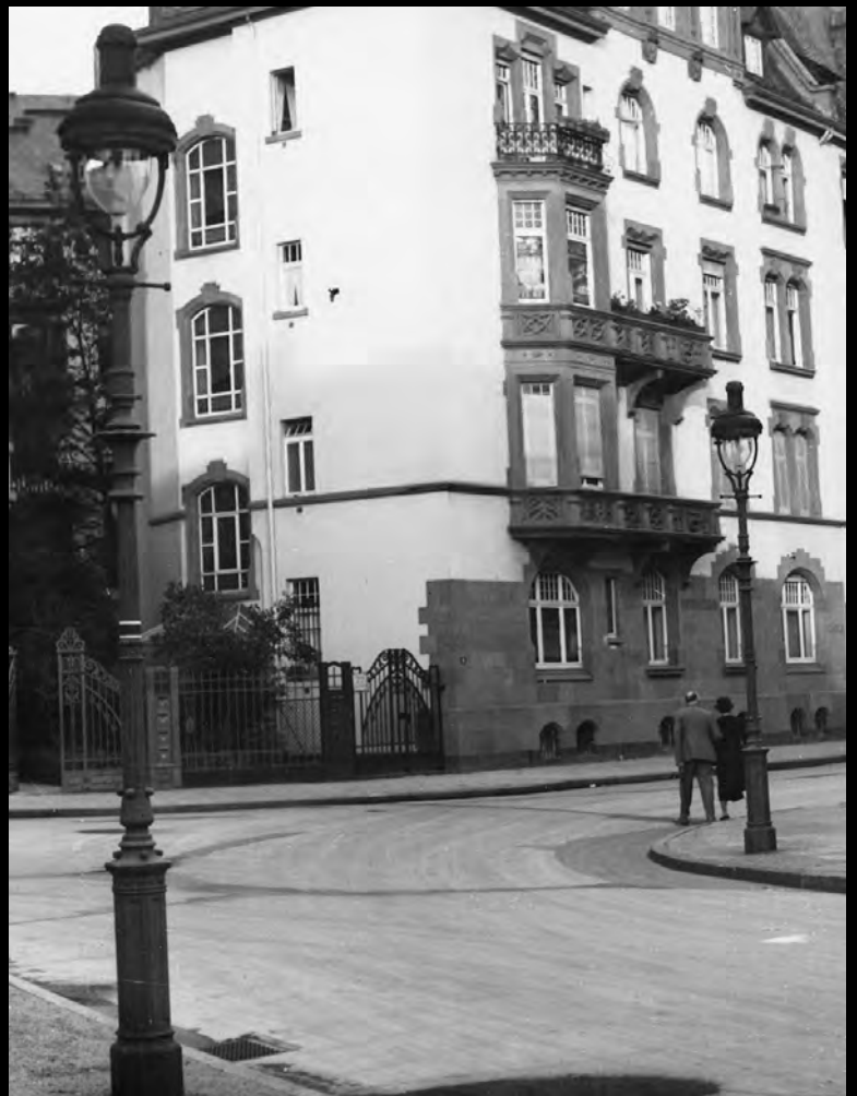
Frankfurt am Main 1937. Zwei Gusskandelaber „Modell Sachsenhausen“ mit Gasaufsatzleuchten von Rech „Modell Frankfurt“. Die vordere Leuchte ist mit dem Laternenring (Zeichen „Halbnachtschaltung“) versehen. Bild Institut für Stadtgeschichte
