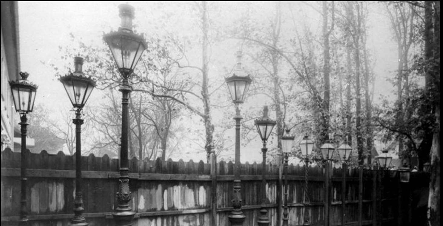
Präsentation verschiedener Budapester Gasleuchten-Modelle um 1890. Kurz zuvor war das Gasglühlicht eingeführt worden. Die Laternen wurden mit Auer-Brennern und stehenden Glühstrümpfen ausgerüstet.
