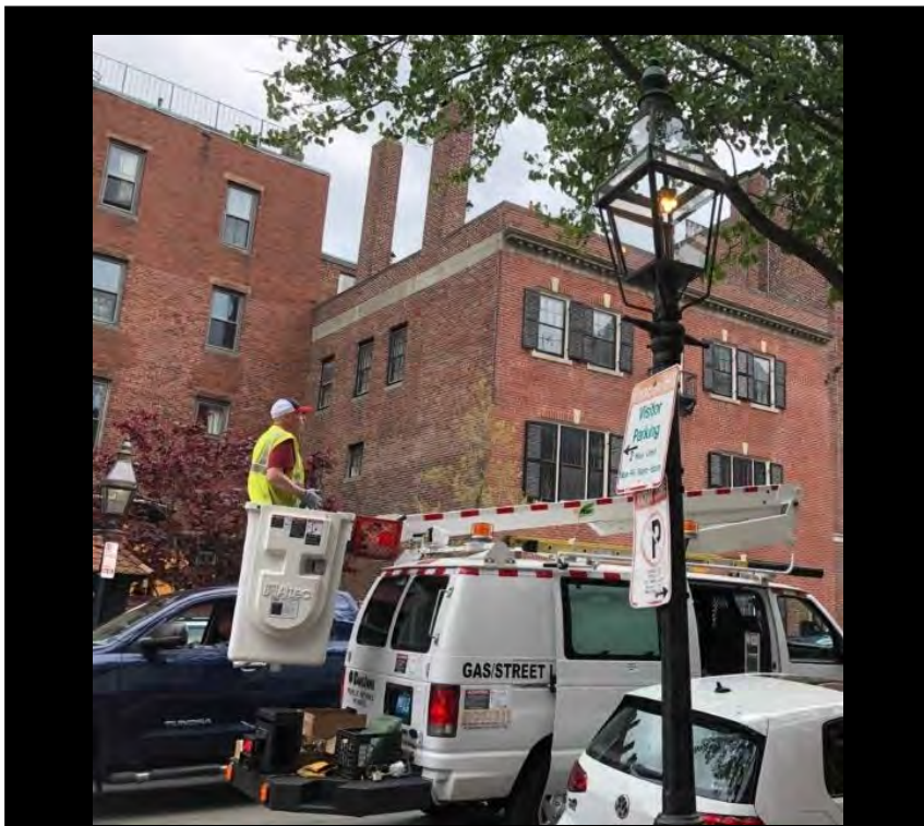
Oben Gaslaternenwartung mit Hubwagen; in der Mitte und unten die beiden in Boston vertretenen Gasleuchten-Modelle
