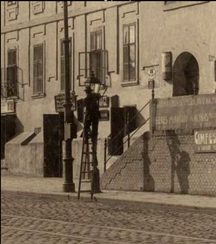
Links Gaslaternen-Wartung mit Schattenspiel vor dem Restaurant Szarvas ház (1914). Bildquelle unbekannt; rechts eine bereits auf stehendes Glühlicht umgebaute Gaslaterne am kreisrunden Platz Kodály körönd. Bildquelle Fortepan17897
