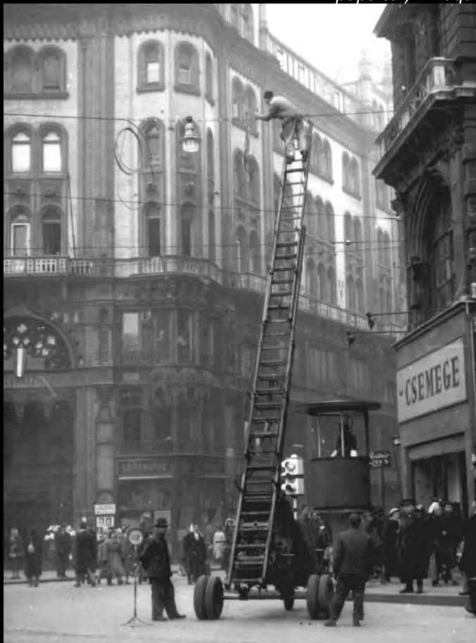
In den 1950er Jahren begannen großflächige Elektrifizierungen, zum Teil nutzte man die Gaskandelaber für die Installation von elektrischen Leuchten. Bildquellen Fortepan NY19561130011 und NY19571017006
