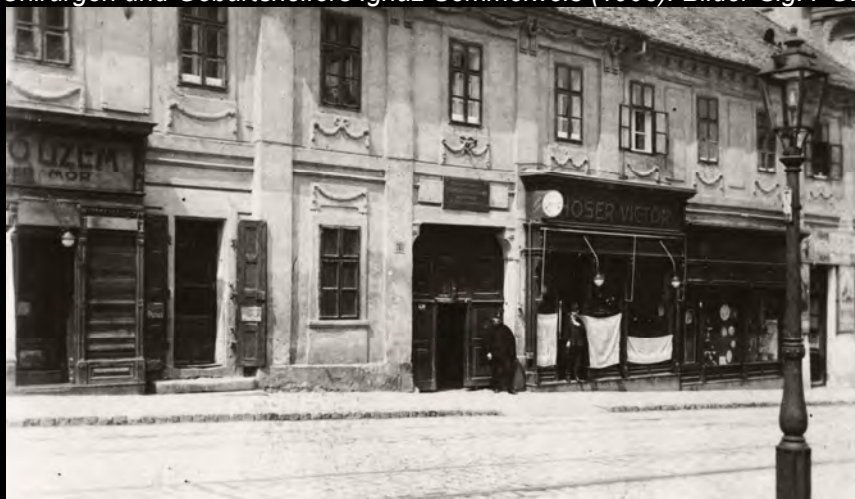
Oben: Dreiarziger Gaskandelaber auf dem Landhausplatz; unten viereckige Gaslaterne mit stehendem Gasglühlicht am Geburtshaus des Chirurgen und Geburtshelfers Ignaz Semmelweis (1906). Bilder Slg. PGL
