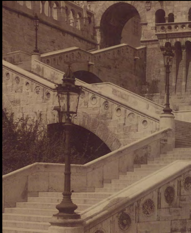
Links mehrarmiger Gaskandelaber mit Modelleuchten (um 1900). Bildausschnitt Fortepan 82503; rechts gusseiserne Maueraufsätze mit Sondergasleuchten 1902 an der Fischerbastei (Halászbástya) Bild Fortepan 82647
