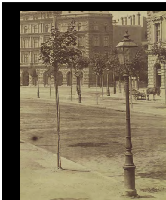
Gasleuchte um 1880 mit offener Flamme. Bild Slg. PGL
