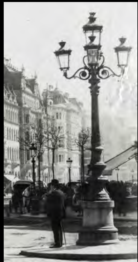
Mehrmögiger Gaskandelaber mit offenen Flammen um 1887. Bild Slg. PGL
