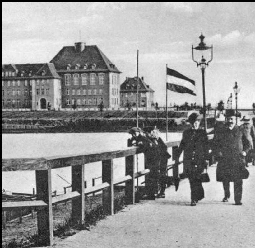
Links: Die Hohe Straße, eine der Hauptverkehrsstraßen der Stadt, ausgestattet mit Zylinder-Gasleuchten (Typ Freilicht), die seitlichen Rohrstreben gebogen. Mit Doppel-Stehlicht; rechts die Teichbrücke mit Blick auf das Realgymnasium. Hier ebenfalls eine Zylinder-Gasleuchte, die seitlichen Rohrstreben zweifach angewinkelt. Der Bamag-Fernzündler ist gut zu erkennen. Bildarchiv Ostpreußen, links 001207 2-20\_1207; rechts 013202
