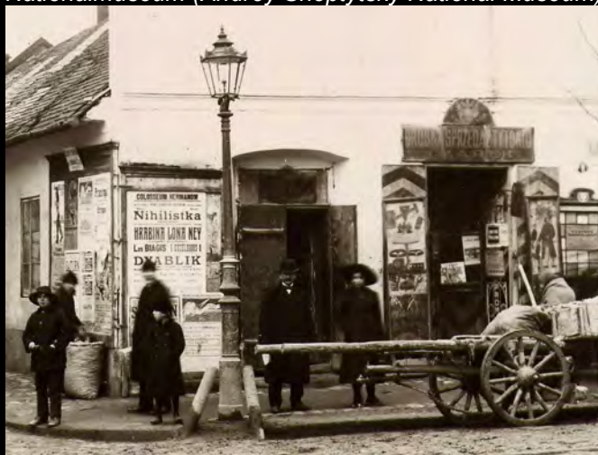
Gaskandelaber unbekannter Bauart mit sechseckiger Gaslaterne, im Dach Lüftungsschlitze
