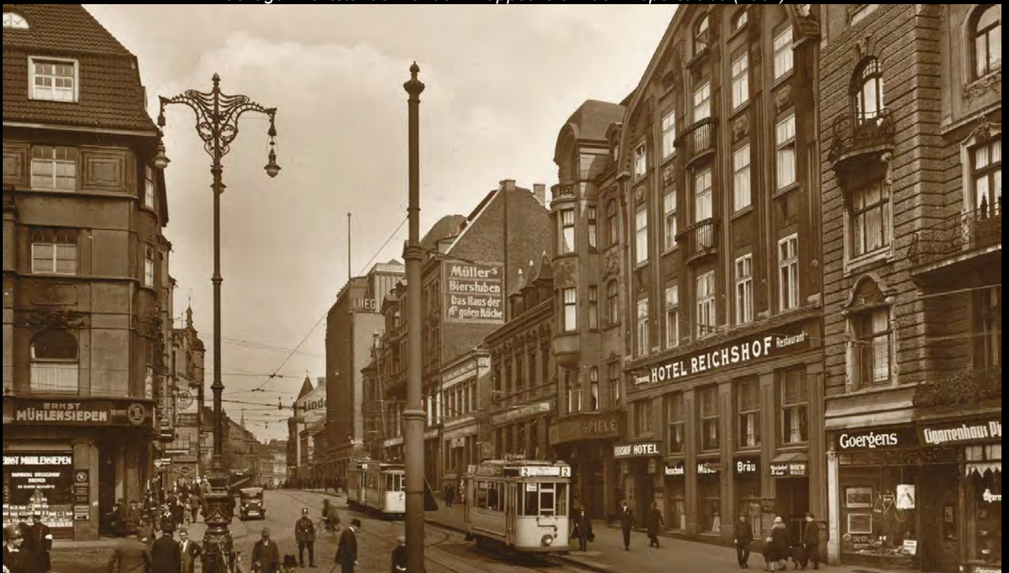
Die Bahnhofstraße mit einem Hochmast, der einen aufwändigen schweren Sockel besitzt. Daran ein schmiedeeiserner Doppelausleger für elektrische Hängeleuchten. Unten typische Siemens-Elektroleuchte für Überspannungen (ab 1930er Jahre. Bildquellen Postkarten/Ausschnitte, Sammlung PGL
