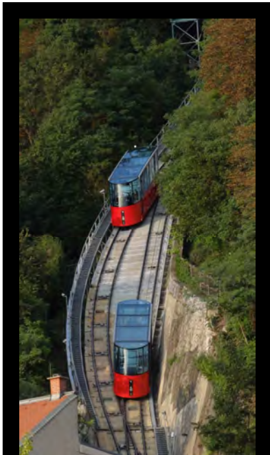
Auch die Schloßbergbahn, mit der man bequem auf den Schloßberg hinaufkommt, steht unter Denkmalschutz. Bild Joachim Raetzer
