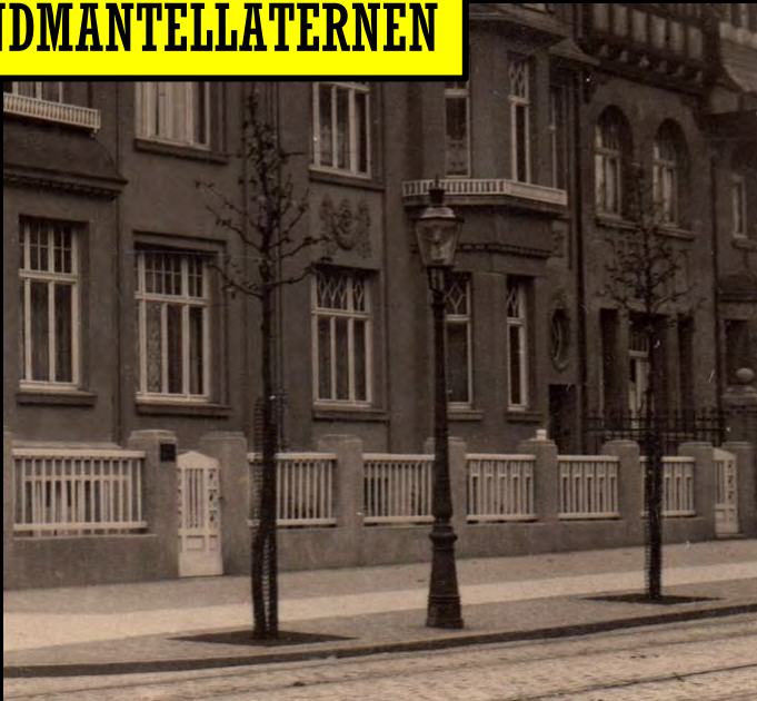
Oben links: Ritter-Rundmantellaterne in der Königsallee (1910); rechts gleiches Modell mit schlankem Mast unbekannter Bauart vor dem Krankenhaus Bergmannsheil (1912), beide Gaslaternen mit stehendem Glühlicht, links auch mit Fernzündler
