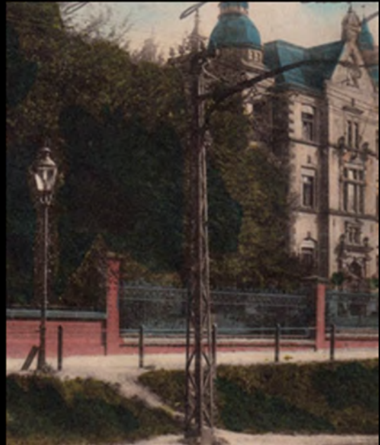
Oben links: Ritter-Rundmantellaterne in der Königsallee (1910); rechts gleiches Modell mit schlankem Mast unbekannter Bauart vor dem Krankenhaus Bergmannsheil (1912), beide Gaslaternen mit stehendem Glühlicht, links auch mit Fernzündler
