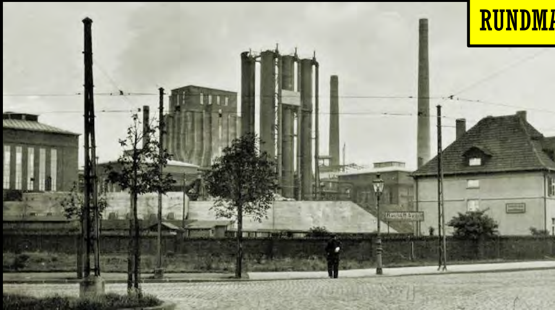
Rundmantellaterne mit stehendem Gasglühlicht und Bamag-Fernzünder in der Bruchstraße, hinten die Kokerei (um 1930)
