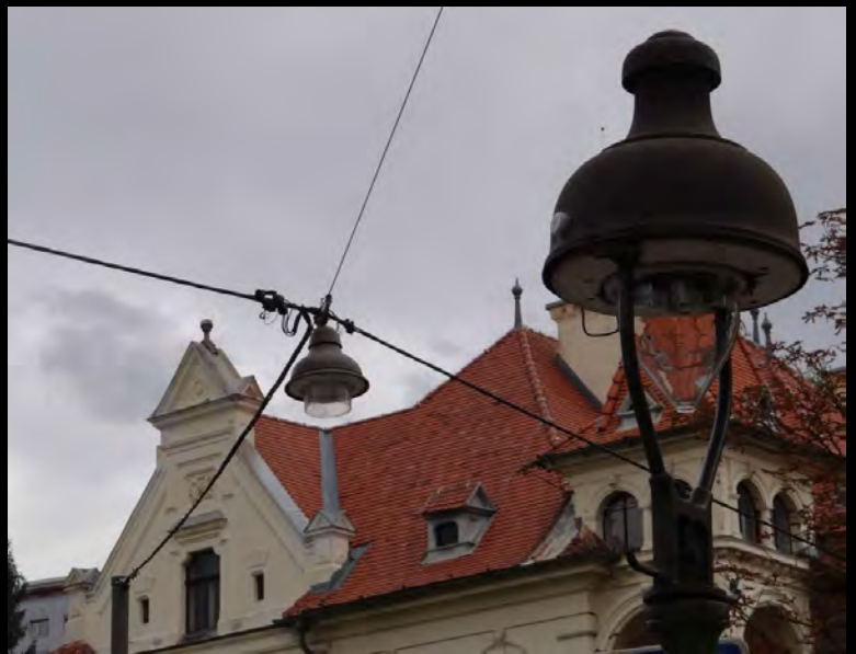
Gaslaterne in der Schubertstraße, leider wird die Straße zusätzlich mit elektrischen Leuchten, wie wir sie auch aus Wien kennen („Maiglöckchen“) an Überspannungen beleuchtet. Bild Bettina Raetzer-Grimm
