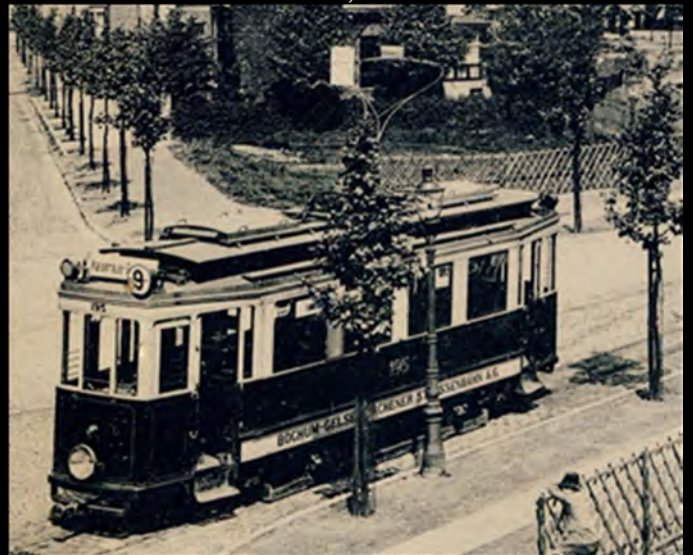
Oben links: Ritter-Rundmantellaterne in der Königsallee (1910); rechts gleiches Modell mit schlankem Mast unbekannter Bauart vor dem Krankenhaus Bergmannsheil (1912), beide Gaslaternen mit stehendem Glühlicht, links auch mit Fernzündler
