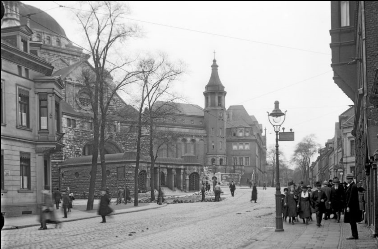
Essen war viele Jahrzehnte vom Bergbau und von Zechen geprägt. Auch das Gaslicht war überall präsent. Hier das Steeler Tor, vermutlich in den 1920er Jahren. Die Gaslaterne ist ein Modell „Elektra Bauart Essen“ auf einem der zahlreichen unterschiedlichen Gusskandelaber der Stadt. Bildquelle unbekannt
