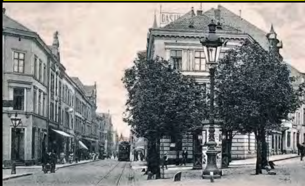
Links: Sechseckige Gaslaterne auf einem Kurz-Kandelaber als Maueraufsatz am Kriegerdenkmal (um 1900); rechts die Gabelung Bahnhof- und Friedrichstraße um 1900. Wuchtiger Kandelaber mit einer Regenerativ-Gaslaterne, hier allerdings mit stehendem Glühlicht, am linken Rand ein typischer Bochumer Kandelaber mit sechseckiger Gaslaterne.
