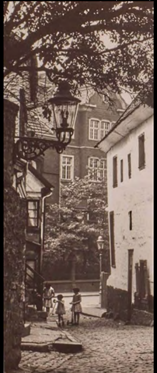
Rundmantellaternen (unbekanntes Modell) als Wandlaterne, im Hintergrund mit Mast. Ausrüstung mit Doppel-Stehlicht und Meteor-Fernzünder. Rechts Ausschnittvergrößerung. Standort Weilenbrink im Gerberviertel (1920er Jahre).
