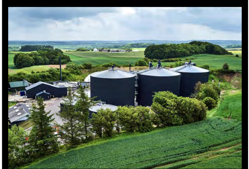
Die 1999 in Betrieb genommene Biogasanlage in Gistrup/Dänemark. Pro Jahr werden hier rund 100 Gigawattstunden Biogas hergestellt. Als Substrate werden 75 % Gülle und 25 % organische Abfälle verwendet. Bild www.gas-hat-zukunft.ch
