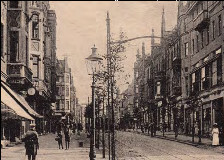
Oben links: Ritter-Rundmantellaterne in der Königsallee (1910); rechts gleiches Modell mit schlankem Mast unbekannter Bauart vor dem Krankenhaus Bergmannsheil (1912), beide Gaslaternen mit stehendem Glühlicht, links auch mit Fernzündler
