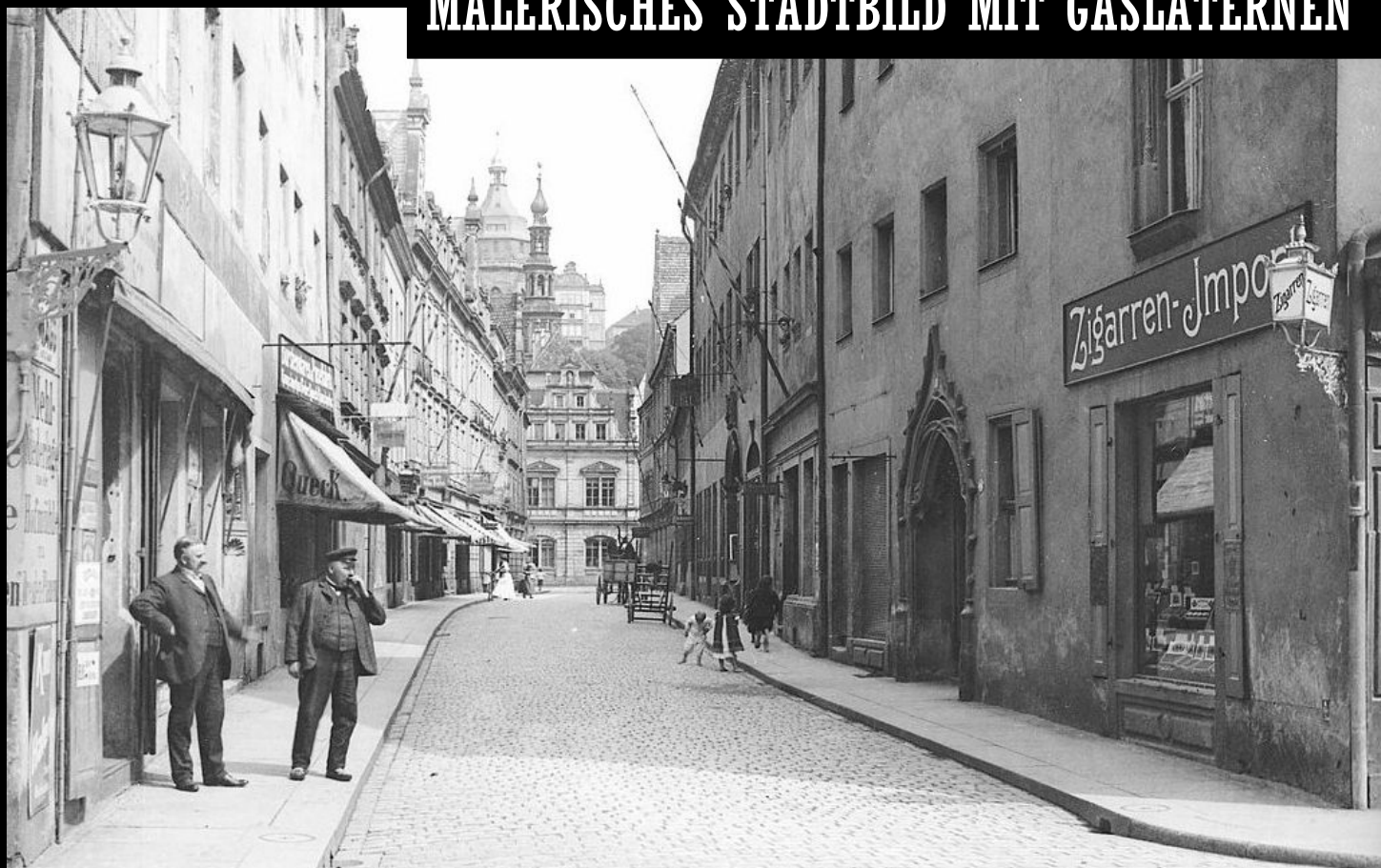
Die Schlossergasse 1908. Links eine sechseckige Gaslaterne (Magdeburger Modell) an einem Wandarm; rechts eine private Transparent-Gaslaterne mit Werbebeschriftung, ebenfalls an einem Wandarm.
