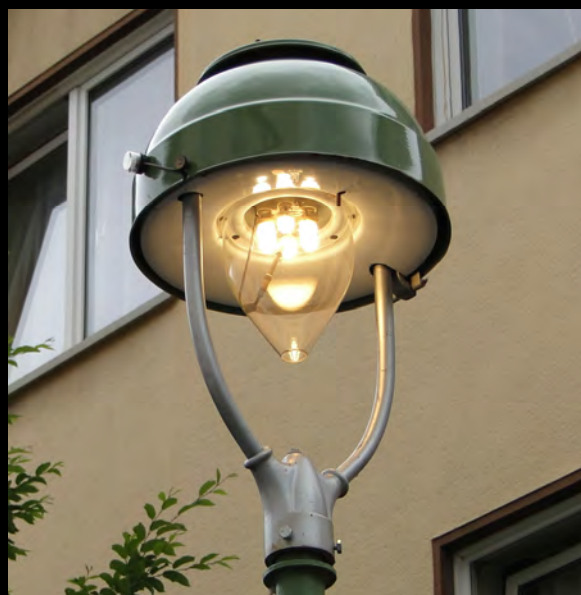
In den 1950er Jahren eingeführt und in vielen Stadtteilen bis heute ortsbildprägend: Die Leuchte „Modell 52“ der Firma Schneider (GICS) in Hamm, hier als Ansatz- und als Aufsatzvariante, jeweils mit sechs Flammen. Die Besonderheit bei der Ansatzleuchte ist die seitlich „weggeklappte“ Lyra, was optisch gewöhnungsbedürftig ist. Bilder Nico Wolf
