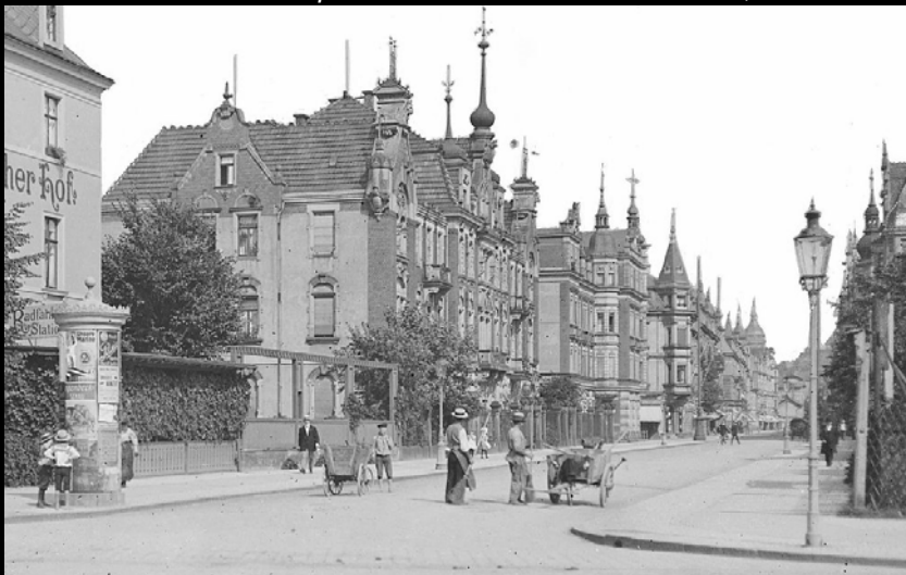
Links: Die Gartenstraße mit einem Bündelpfeilmast und einer nicht näher bestimmbar Rundmantellaterne (1915); rechts ein Stahlmast mit daran montierten Invert-Gashängeleuchten vor dem Maria-Anna-Heim
