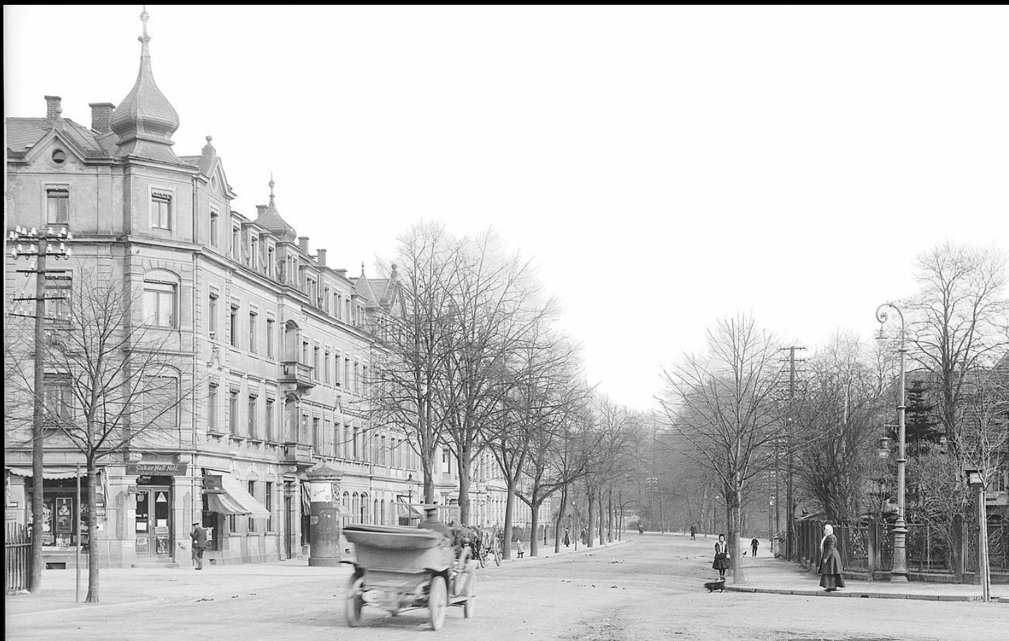
Oben: Die Reitbahnstr im Jahr 1914; auch hier ist rechts eine Strom/Gas-Kombination zu erkennen (wie auf der vorherigen Seite). Hier ist aber nur ein Ausleger mit Invert-Gashängeleuchte angebracht. Interessant sind auch die aufgestellten Holzposte mit Porzellan-Isolatoren und zahlreichen Drähten für Telefon/Telegrafie und Strom.
