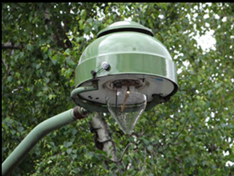
In den 1950er Jahren eingeführt und in vielen Stadtteilen bis heute ortsbildprägend: Die Leuchte „Modell 52“ der Firma Schneider (GICS) in Hamm, hier als Ansatz- und als Aufsatzvariante, jeweils mit sechs Flammen. Die Besonderheit bei der Ansatzleuchte ist die seitlich „weggeklappte“ Lyra, was optisch gewöhnungsbedürftig ist. Bilder Nico Wolf
