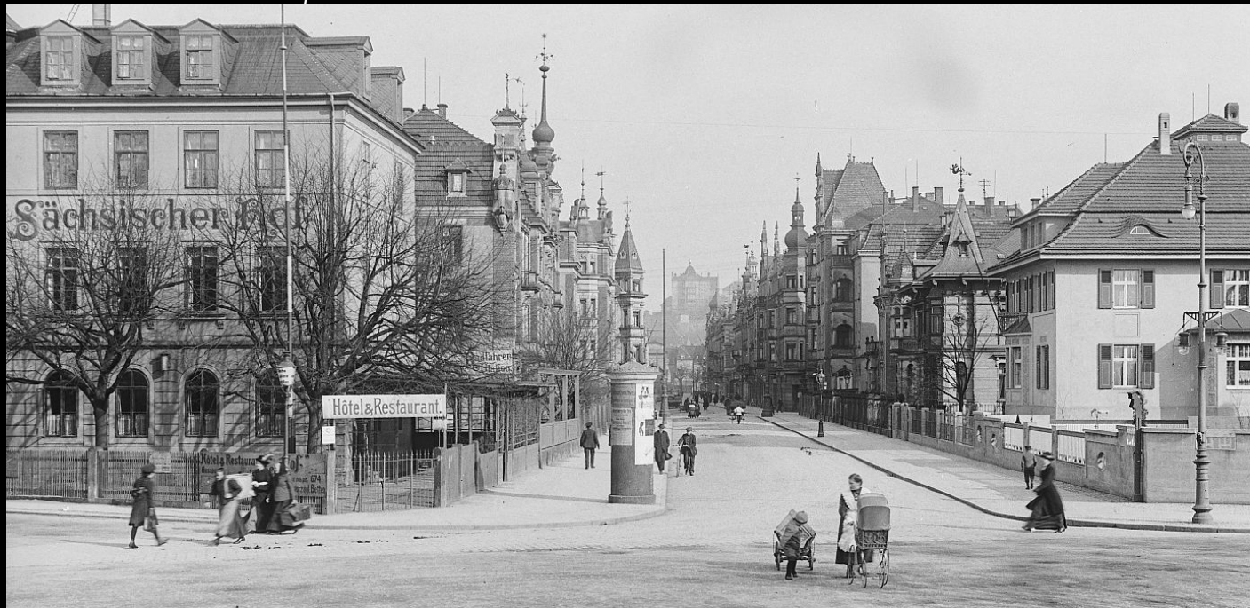
Oben die Gartenstraße um 1915 mit einer sechseckigen Gaslaterne an einem Mast mit Ausleger; unten nochmals die Gartenstraße aus einer anderer Perspektive. Rechts ein Hängelichtmast („Bischofsstab“) mit elektrischer Leuchte, vermutlich eine Bogenlampe. Der Lichtmast dient als Kombimast für Strom und Gas, auf halber Höhe befinden sich zwei Ausleger mit Invert-Gashängeleuchten (eventuell Graetzin). Links ist am Eingang zum Hotel Sächsischer Hof eine Transparent-Gaslaterne zu erkennen. Interessant ist auch die Litfaßsäule.
