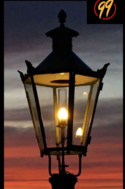
Sechseckiges Modell „Alt-Düsseldorfer“ mit stehendem Gasglühlicht und Handkettenzug. Bilder Louis Kopp
