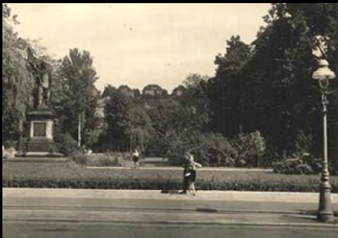
Oben: Die Reitbahnstr im Jahr 1914; auch hier ist rechts eine Strom/Gas-Kombination zu erkennen (wie auf der vorherigen Seite). Hier ist aber nur ein Ausleger mit Invert-Gashängeleuchte angebracht. Interessant sind auch die aufgestellten Holzposte mit Porzellan-Isolatoren und zahlreichen Drähten für Telefon/Telegrafie und Strom.
