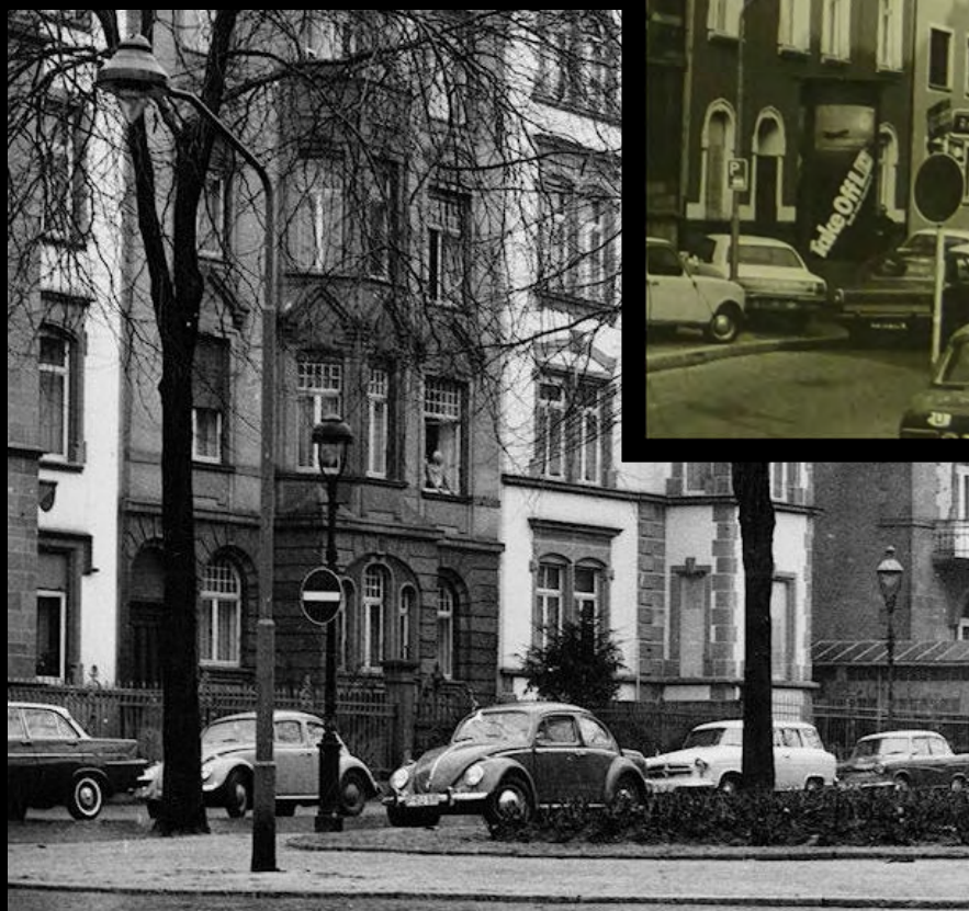
Links: Die Günthersburgallee im Stadtteil Bornheim. Gleich drei verschiedene Leuchtentypen sind hier zu sehen. Vorn eine Ansatzleuchte von Schneider (GICS), Modell „Neulicht-52“ mit einer 245mm-Glocke. Dahinter eine Aufsatzleuchte Modell 52 auf dem Sachsenhäuser Kandelaber, rechts das Modell „U5“ von BAMAG, eine ähnliche Form wie die als „Modell Köln“ oder „Bauart Köln“ bezeichneten Typen anderer Hersteller. Oben: Blick in die Jungstraße in Bockenheim (1980) mit Gasansatzleuchten (Schneider Modell 52A). Bilder Institut für Stadtgeschichte
