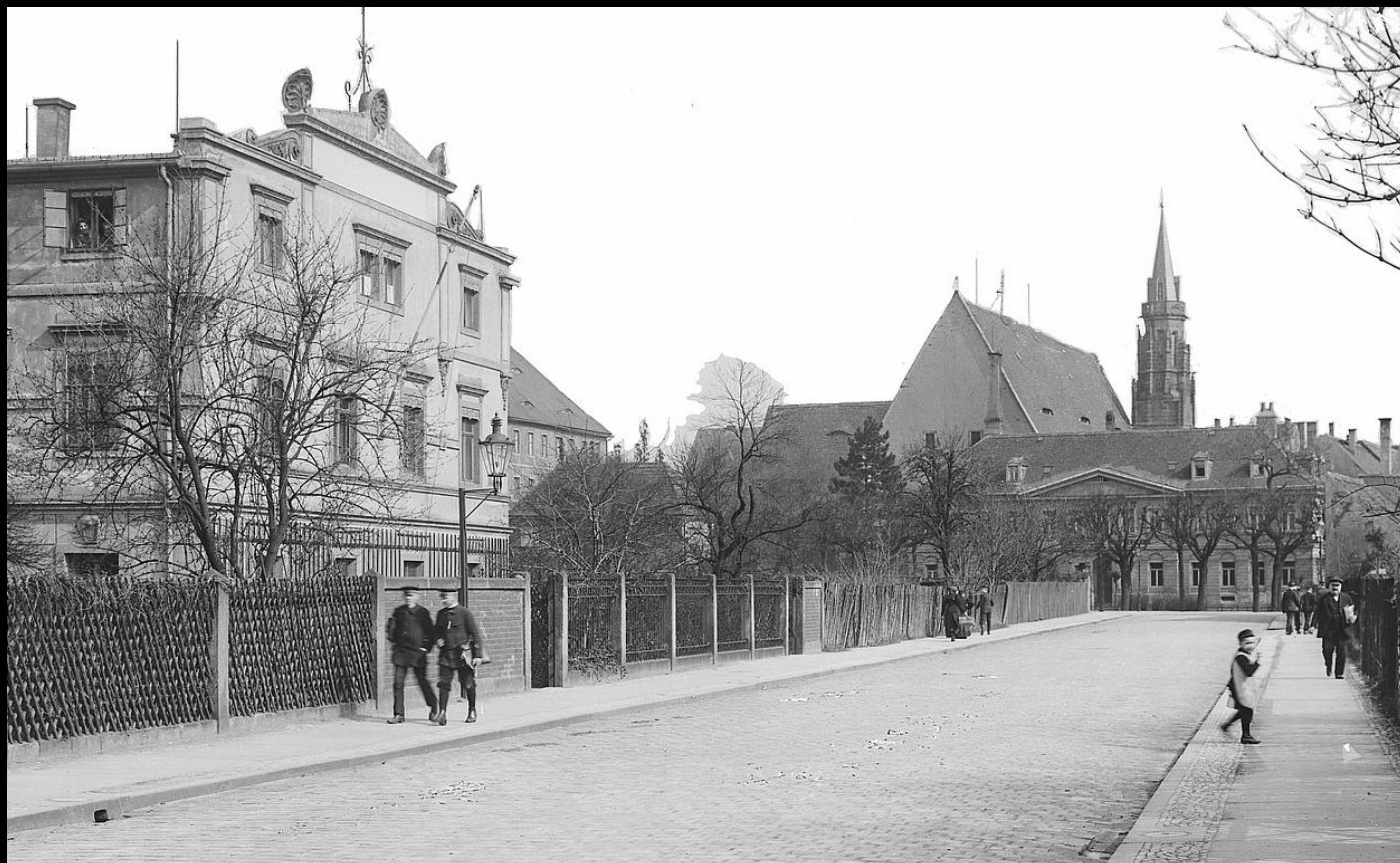
Oben die Gartenstraße um 1915 mit einer sechseckigen Gaslaterne an einem Mast mit Ausleger; unten nochmals die Gartenstraße aus einer anderer Perspektive. Rechts ein Hängelichtmast („Bischofsstab“) mit elektrischer Leuchte, vermutlich eine Bogenlampe. Der Lichtmast dient als Kombimast für Strom und Gas, auf halber Höhe befinden sich zwei Ausleger mit Invert-Gashängeleuchten (eventuell Graetzin). Links ist am Eingang zum Hotel Sächsischer Hof eine Transparent-Gaslaterne zu erkennen. Interessant ist auch die Litfaßsäule.
