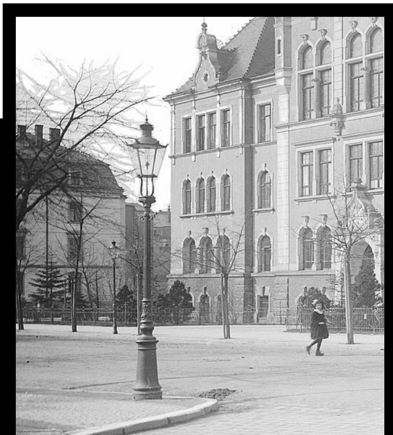
Gaskandelaber vor dem Realgymnasium (um 1914). Die Leuchte ähnelt dem Modell 444 der Firma Schneider, später bekannt als „Alt-Bonn“, hier aber mit flacherem Dach und Entlüftung. Bildquelle Deutsche Fotothek
