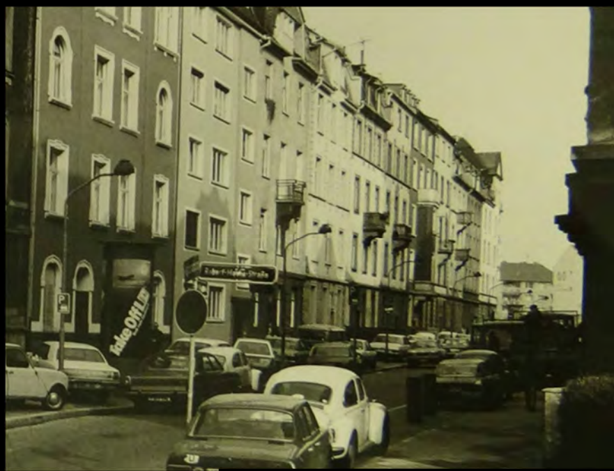
Links: Die Günthersburgallee im Stadtteil Bornheim. Gleich drei verschiedene Leuchtentypen sind hier zu sehen. Vorn eine Ansatzleuchte von Schneider (GICS), Modell „Neulicht-52“ mit einer 245mm-Glocke. Dahinter eine Aufsatzleuchte Modell 52 auf dem Sachsenhäuser Kandelaber, rechts das Modell „U5“ von BAMAG, eine ähnliche Form wie die als „Modell Köln“ oder „Bauart Köln“ bezeichneten Typen anderer Hersteller. Oben: Blick in die Jungstraße in Bockenheim (1980) mit Gasansatzleuchten (Schneider Modell 52A). Bilder Institut für Stadtgeschichte
