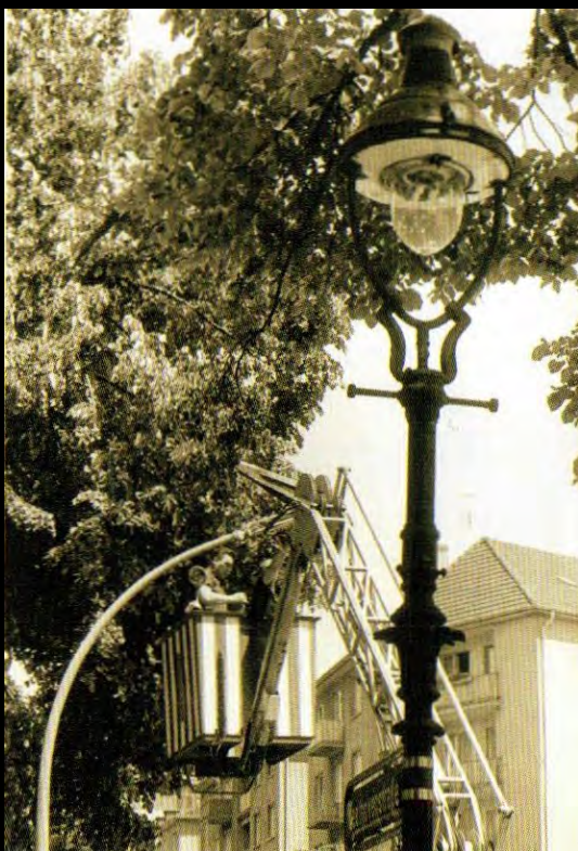
Ab Ende der 1960er Jahre eroberte die Schneider-Gasreihenleuchte „L56“ viele Frankfurter Straßen. Sie ersetzte vor allem ältere Gasleuchtenmodelle wie Viereckklaternen oder Typen ähnlich der Bauart Köln (Bild links, Straße nicht bekannt), später aber auch Gasaufsatzleuchten „Modell 52“ von Schneider. Bild rechts: Hammanstraße Anfang der 1960er Jahre.
