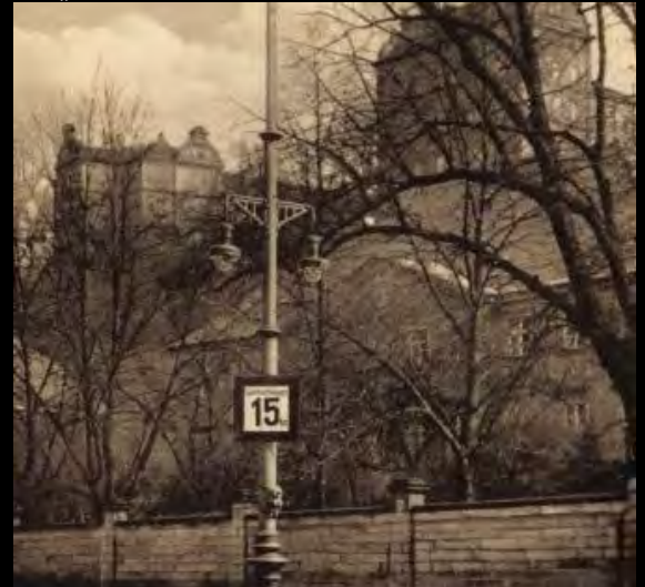
Links: Die Gartenstraße mit einem Bündelpfeilmast und einer nicht näher bestimmbar Rundmantellaterne (1915); rechts ein Stahlmast mit daran montierten Invert-Gashängeleuchten vor dem Maria-Anna-Heim
