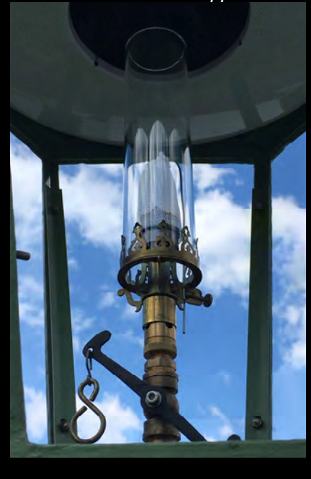
Sechseckiges Modell „Alt-Düsseldorfer“ mit stehendem Gasglühlicht und Handkettenzug. Bilder Louis Kopp
