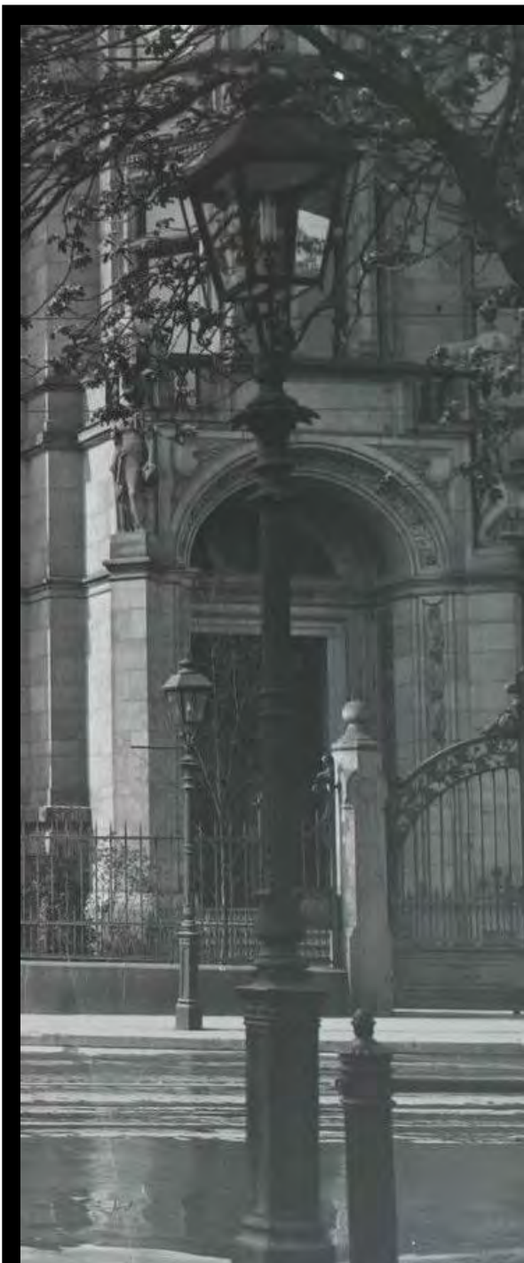
Der Klassiker: Viereckige Gaslaterne in einer Korbkonstruktion auf einem sogenannten „Sachsenhäuser Kandelaber“, hier mit stehendem Gasglühlicht um 1910. Diese Kandelaber-Type wurde vor 1900 auch in Düsseldorf verwendet. Bild Sammlung ProGaslicht
