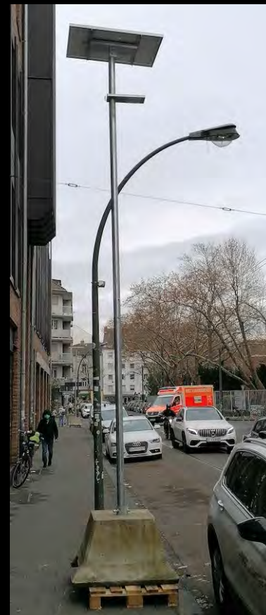
Solarbetriebene LED-Leuchte als Provisorium auf der Sternstraße (November 2021)
