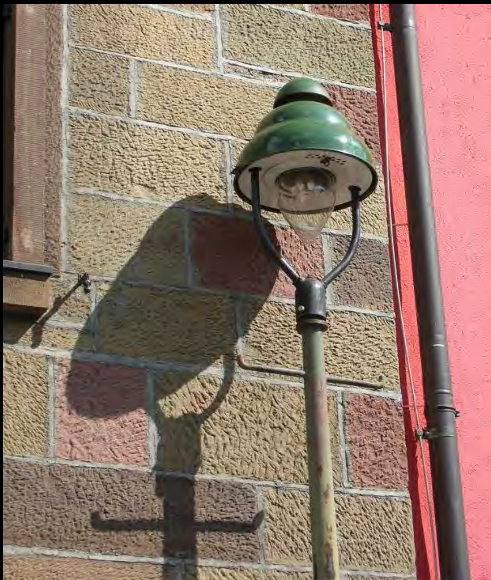
↑ Diese wunderschöne Bamag U7 aus der Nachkriegsproduktion mit dünnem Fuss „D“ im Unteren Weg wurde inzwischen abgerissen.
