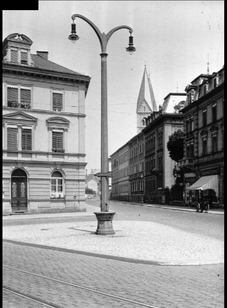
Oben Doppelarmiger Betonkandelaber mit Gashängeleuchten (Hirschhorn) an der Ecke Virchow- und Weingartenstraße (1928); unten Rudolf-Wille-Sechsecklaterne in der Mergentheimer Straße (1939)
