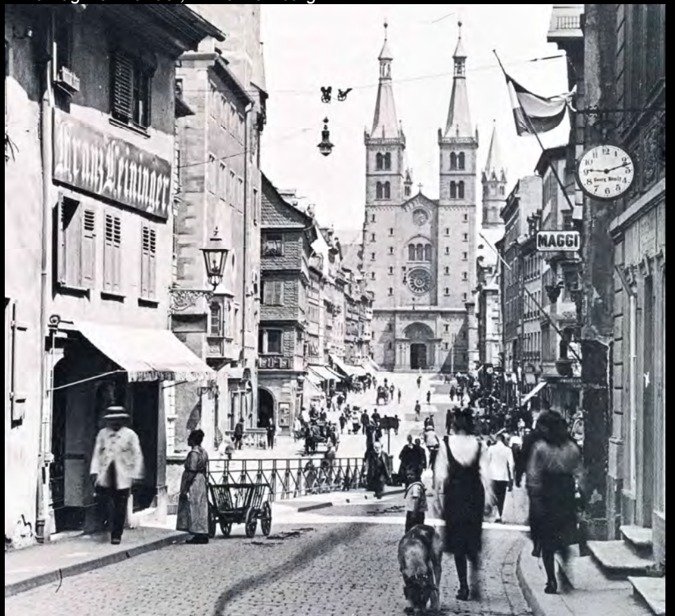
Viereckige Gasleuchten mit unterschiedlichen Dachformen, stehendes Gasglühlicht, links oben und rechts unten bereits mit Bamag-Fernzündler, in Alt-Würzburg
