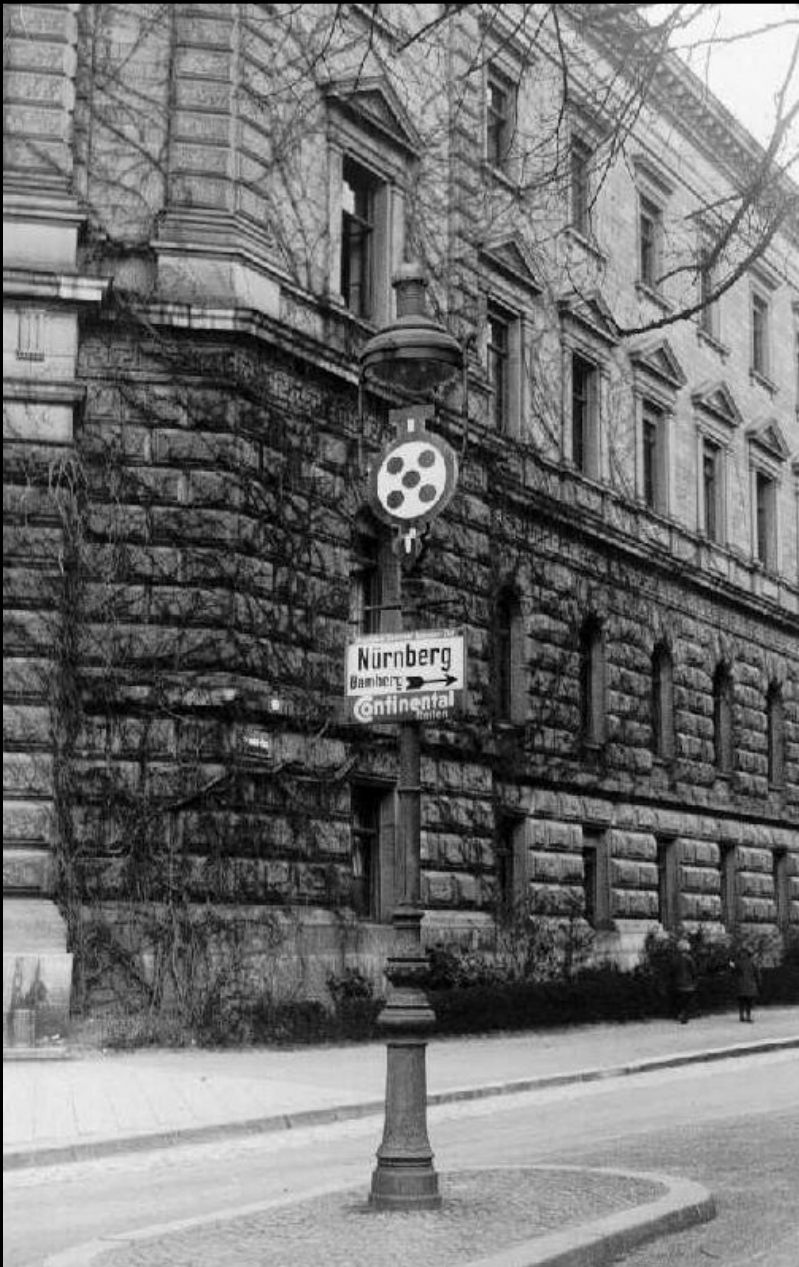
Oben eine Sonderbauform: Eine Schildleuchte im Sanderring (1927). Hersteller möglicherweise die Firma Rech.
