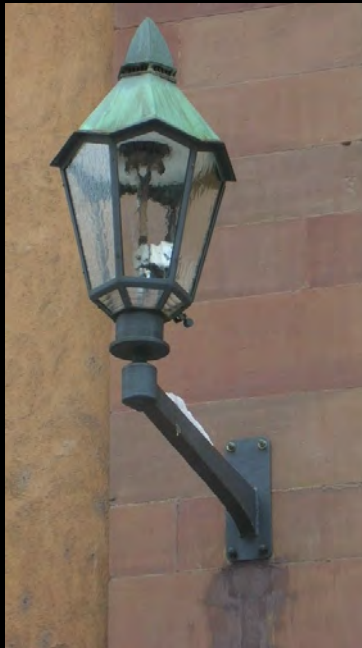
Links: Die Rudolf-Wille-Gasleuchte wirkt mit ihrem „zipfelmützenartigen“ Dach recht kurios; rechts eine der wenigen Rech-Modell „Neulicht“ Gasansatzleuchten, hier an einem Stahlmast mit Leitereisen. Bilder Sammlung ProGaslicht
