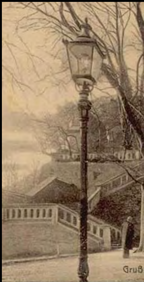
Viereckige Gasleuchten mit unterschiedlichen Dachformen, stehendes Gasglühlicht, links oben und rechts unten bereits mit Bamag-Fernzündler, in Alt-Würzburg
