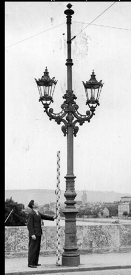
Oben sechseckige Gasleuchte mit Lochbrenner vor dem Amtsgericht (1893); unten Fahrleitungsmast der Straßenbahn mit Schmuckauslegern und sechseckigen Gasleuchten auf der Ludwigsbrücke (ca. 1929)
