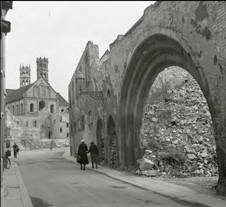
Links ein Blick in die verwüstete Domerschulstraße im Jahr 1946. Das einzige, was hier intakt zu sein scheint, ist die Wand-Gasleuchte, Modell „Bamag U7“; rechts Rech-Aufsatzleuchte mit Handbedienung in Karlstadt. Nach dem Zweiten Weltkrieg übernahm Würzburg die Gasversorgung in Karlstadt und stellte Gasleuchten wie im Stadtgebiet von Würzburg auf.
