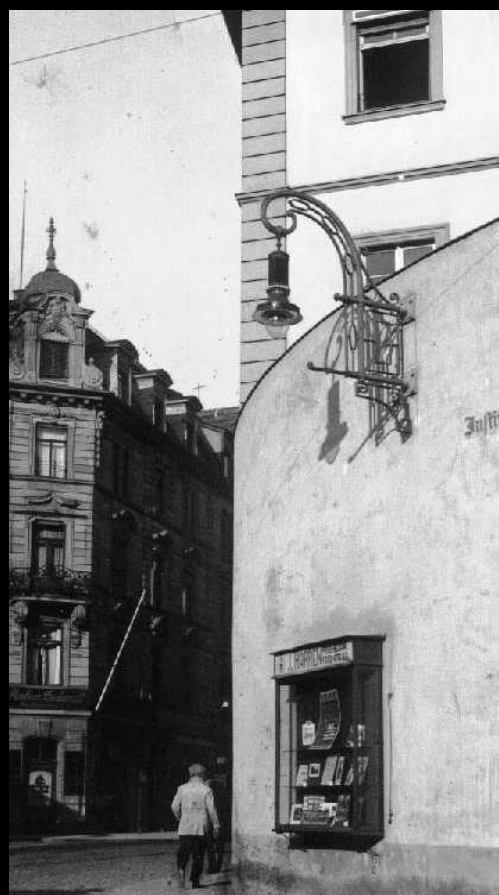
Gashängeleuchten in Würzburg: Oben links Temperaturmessung bei einer Graetzin-Gashängeleuchte; rechts ein Modell von Hirschhorn mit der Flacheisen-Konsole „Modell Würzburg“; unten links eine Graetzin-Gashängeleuchte an einem Jugendstil-Wandarm in der Augustinerstraße (1937); in der Mitte eine Gashängeleuchte (Modell unklar) an einem Wandarm der Firma Manfey; rechts ein Betonkandelaber mit zwei Auslegern und Gashängeleuchten der Firma Graetzin auf dem Bahnhofsplatz (1928).
