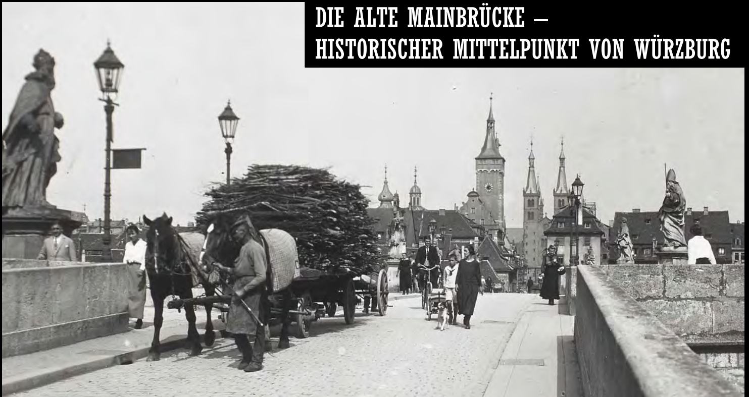
Oben die Alte Mainbrücke um 1920 mit nicht näher bestimmbarern sechseckigen Modelleuchten. Während bei der vorderen Leuchte ein Bamag-Fernzünder zu erkennen ist, scheint die hintere kein Innenleben zu haben; unten die Alte Mainbrücke 1936, jetzt ausgestattet mit Rudolf-Wille-Sechsecklaternen. Nachbauten dieser Leuchte – allerdings elektrischer Betrieb – stehen auch heute auf dieser Brücke.
