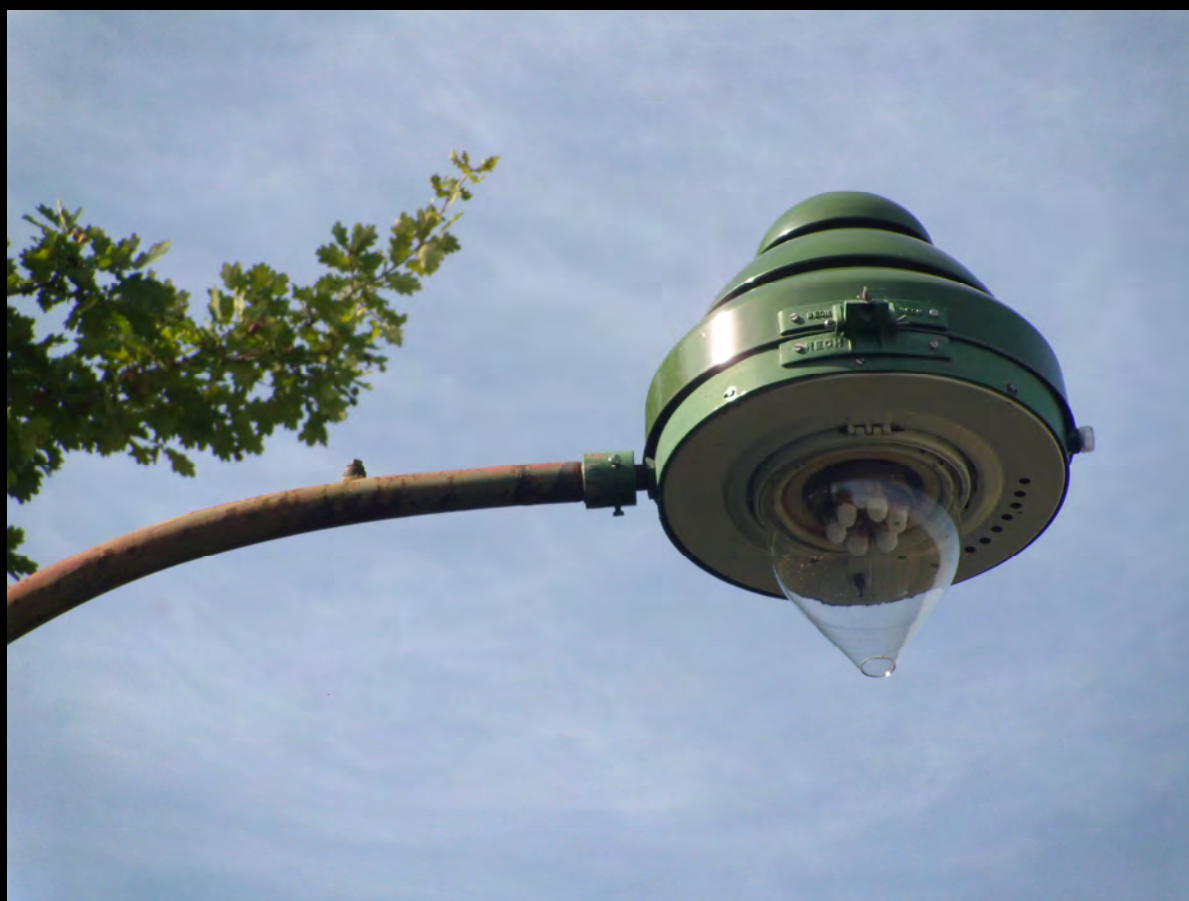
Rech-Gasansatzleuchte, die von den Stadtwerken Mainz übernommen wurde. Bild Klaus Gevatter
