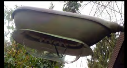
Oben: Rech-Gasreihenleuchte „Modell Essen“ mit Außenreflektor, sechsflammig.
