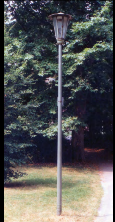
Gas-Pilzleuchte von Rech, kleines „Modell Frankfurt“ im Ringpark
