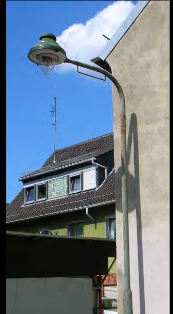
Links: Die Rudolf-Wille-Gasleuchte wirkt mit ihrem „zipfelmützenartigen“ Dach recht kurios; rechts eine der wenigen Rech-Modell „Neulicht“ Gasansatzleuchten, hier an einem Stahlmast mit Leitereisen. Bilder Sammlung ProGaslicht
