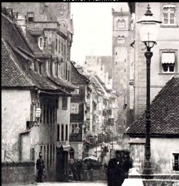
Oben viereckige Laterne mit Wandarm und stehendem Glühlicht; unten sechseckige Laterne mit Glasdach auf süddeutschem Kandelaber, noch mit offener Flamme.
