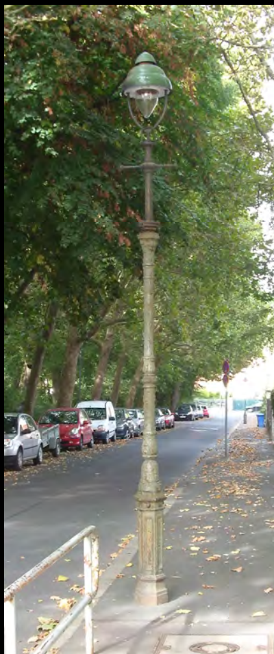
Oben: Gusskandelaber süddeutscher Bauart mit Verlängerungsstück inklusive Leitereisen und Bamag U7-Gasleuchte, Werkingstraße; unten Francke-Kandelaber in Heidingsfeld, Am Salmannsturm
