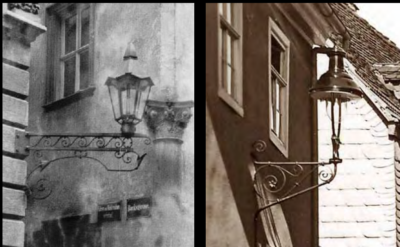
Oben links: Wille-Sechseckgasleuchte auf Wandarm, unbekannter Hersteller; rechts Bamag U5-Gasaufsatzleuchte auf einem Wandarm von Carl Francke, Bremen
