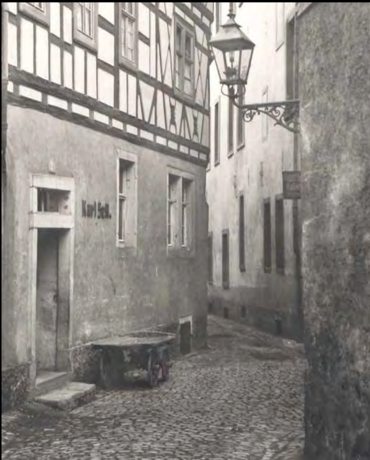
Viereckige Gasleuchten mit unterschiedlichen Dachformen, stehendes Gasglühlicht, links oben und rechts unten bereits mit Bamag-Fernzündler, in Alt-Würzburg
