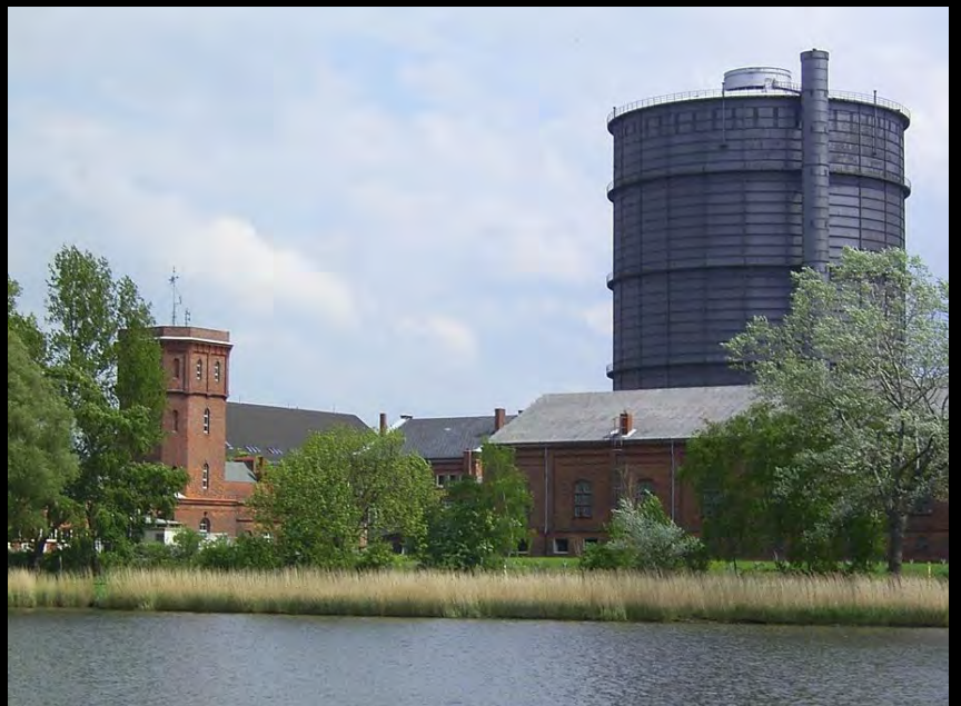
Der Klönne-Gasbehälter in Lübeck im Jahr 2003. Bild Kasperky
