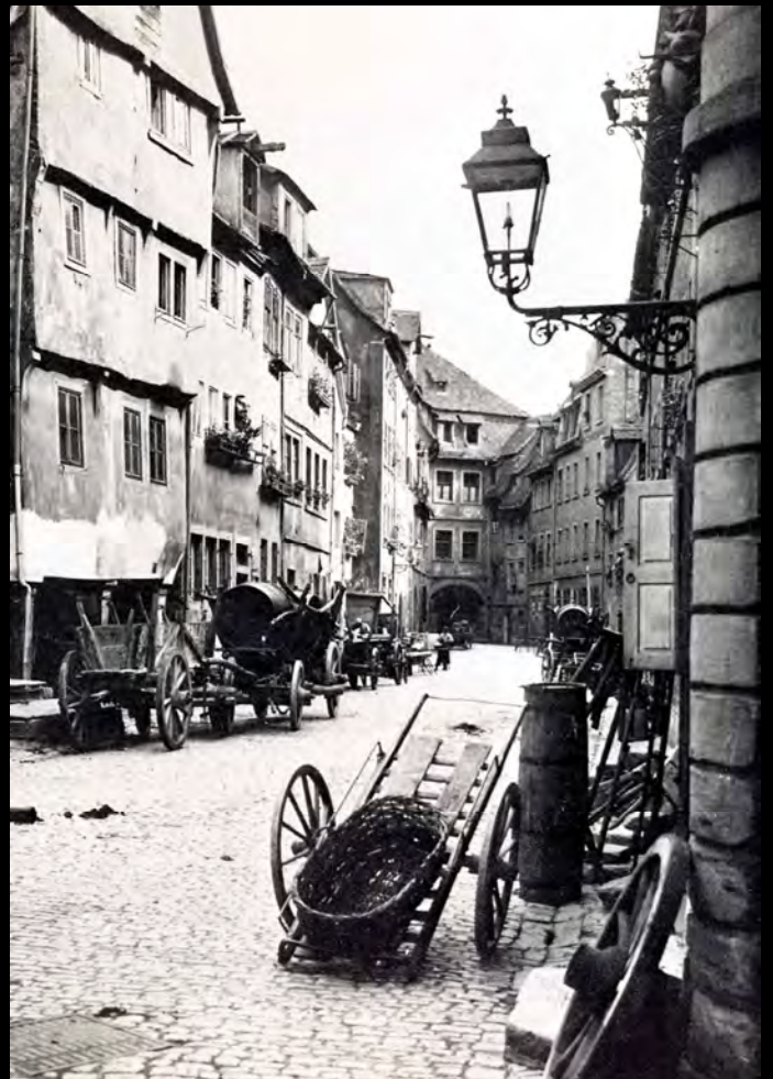
Viereckige Gasleuchten mit unterschiedlichen Dachformen, stehendes Gasglühlicht, links oben und rechts unten bereits mit Bamag-Fernzündler, in Alt-Würzburg
