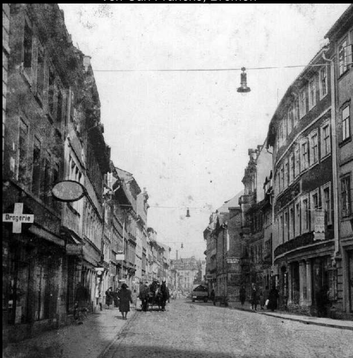
Straßen-Überspannungen mit Hirschhorn-Gashängeleuchten, Semmelstraße
