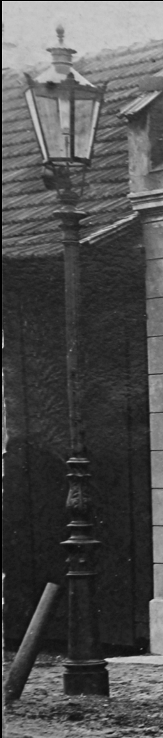
Modell „Alt-Düsseldorf“ mit stehendem Gasglühlicht im Lichtenbroicher Weg um 1900. Bildarchiv PGL
