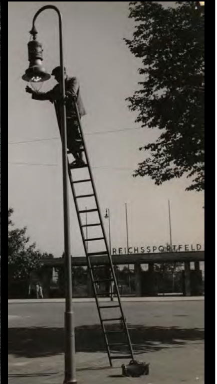
Links Berliner Modelleuchte in Spandau um 1960; rechts Wartung einer Gashängeleuchte am S-Bahnhof Reichssportfeld (1957)
