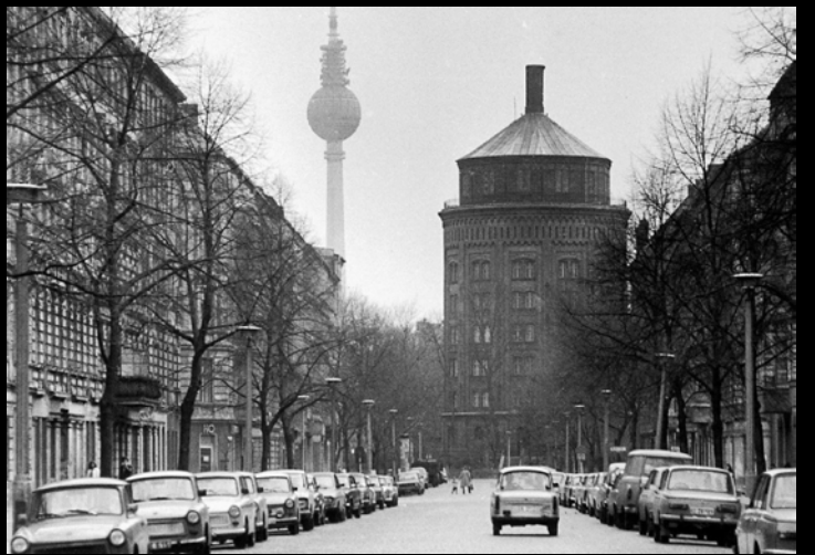
Berlin-Prenzlauer Berg in den 1980er Jahren. Kein Gaslicht mehr, dafür RSL-Leuchten auf Betonmasten, typisch für die gesamte DDR. Bildquelle unbekannt/Archiv PGL
