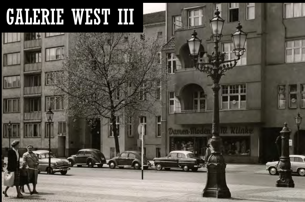
Links: Der Klausenerplatz in Charlottenburg um 1960. Dreiarmiger Gaskandelaber mit Modellleuchten, diese sind mit leicht mattiertem Glas ausgestattet, was sich bei der Gasbeleuchtung jedoch nicht durchsetzte; rechts die Kochstraße in Kreuzberg, ein ursprünglich für Pressgas konstruierter Kandelaber mit Gashängeleuchte, Entwurf der GASAG von 1906, Hersteller Lauchhammer (1960).
