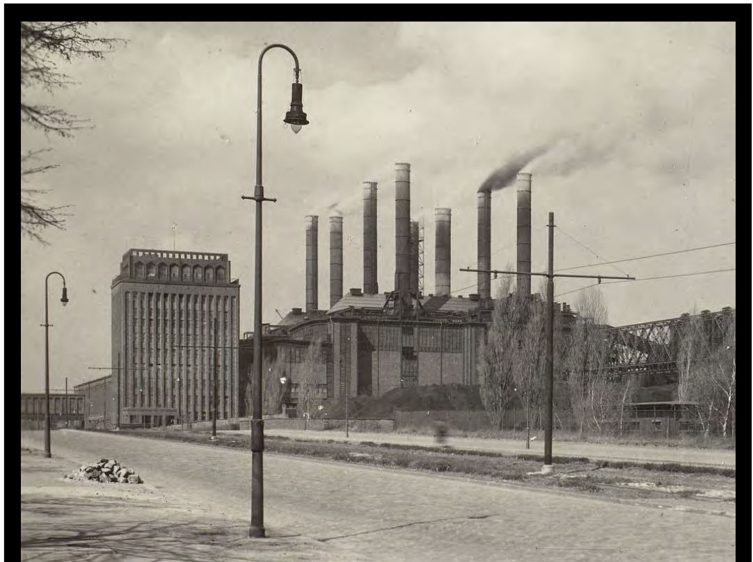
Vierflammige Graetzin-Gashängeleuchten an Manfey-Stahlmasten am Kraftwerk Klingenberg in Berlin-Rummelsburg (1957). Bild Dt. Fotothek Hauptkatalog. 0134656
