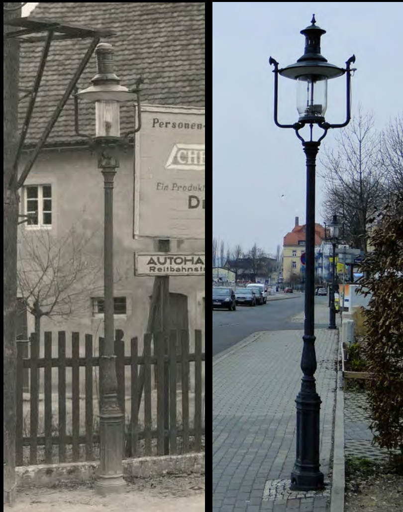
Links: Gasleuchte mit Glaszylinder und seitlichen Rohrstreben in einem Dresdner Vorort (um 1910), Dt. Fotothek bika 038_0000825; rechts eine Neuentwicklung der Firma Trapp in Mainhausen, die optisch eine gewisse Ähnlichkeit mit dem frühen Modell aufweist. Modelle dieses Typs wurden in Pieschen aufgestellt. In beiden Fällen sind sie auf Blochmann-Kandelabern montiert. Bild Joachim Raetzer (2013)
