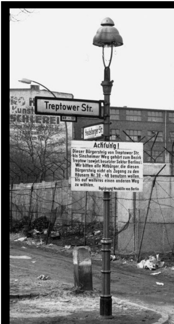
Bündelpfeilmast mit „Bamag U7“- Aufsatzleuchte in Neukölln. Bild unbekannt
