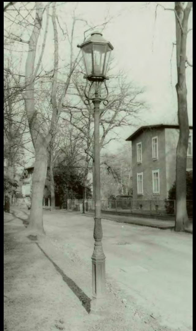
So sehen heute die meisten der Dresdner Gasleuchten aus. Sechseckige Laternen, vorzugsweise auf Dresdner Blochmann-Kandelabern unterschiedlicher Hersteller. Bild: Gasleuchte in Blasewitz, Mendelsohnallee (ca. 1980). Hier stehen auch heute Gasleuchten. Bild Dt. Fotothek Hauptkatalog 0041603
