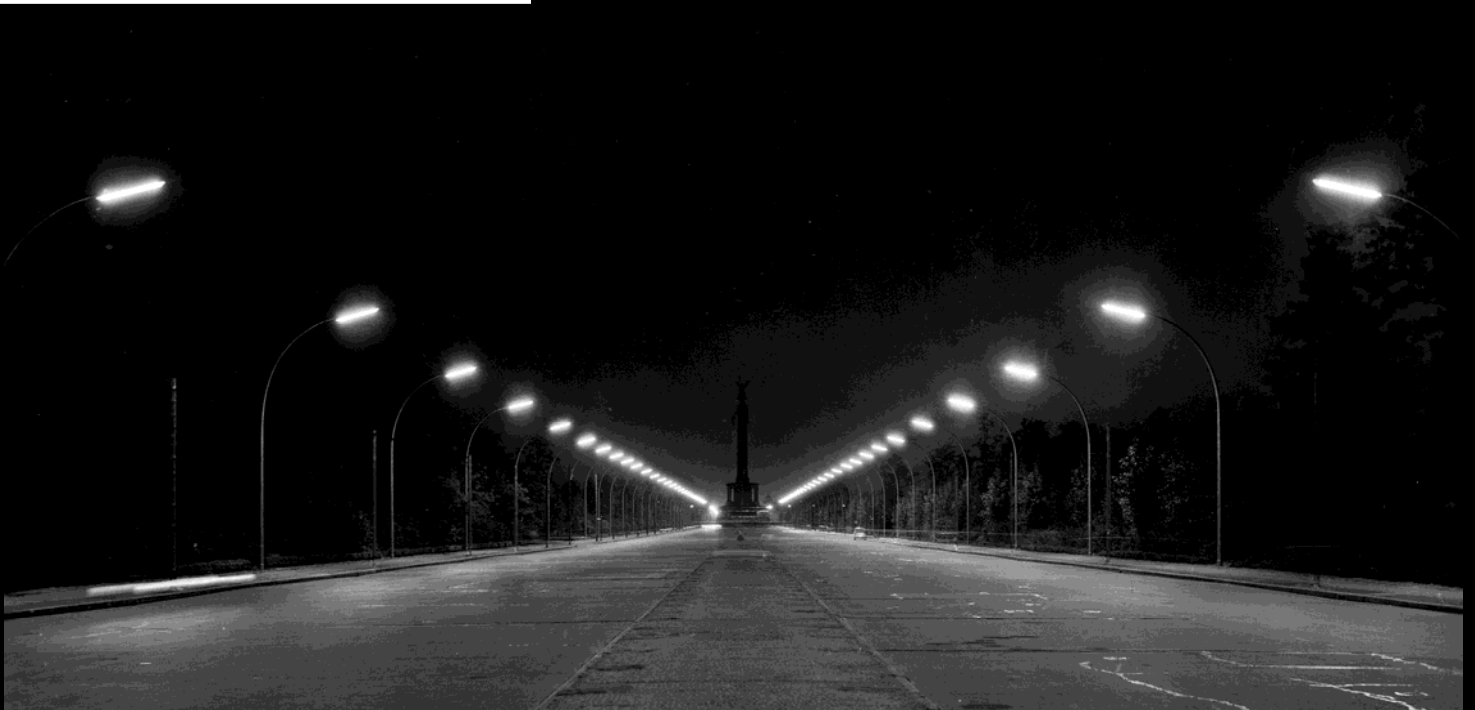
Elektrische Beleuchtung mit Langfeldleuchten an Peitschenmasten auf der Straße des 17. Juni in Berlin-Tiergarten im Juli 1955. Bilder Sammlung Sabine Röck
