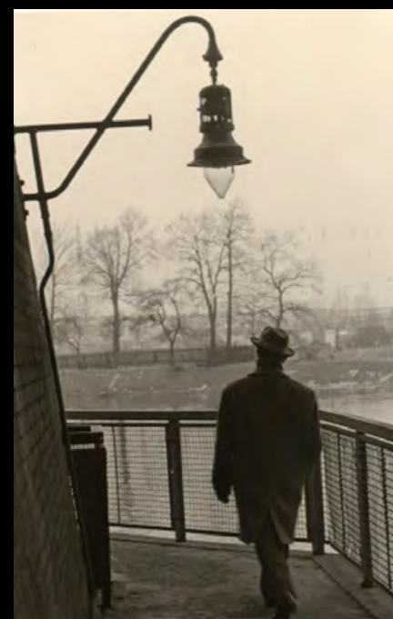
Links: neunflammige BAMAG-Gashängeleuchte A11 in Berlin-Kreuzberg im Jahr 1955, BAMAG-Stahlmast, dazu trostlose Kriegsruinen; rechts BAMAG-Gashängeleuchte an einem von Graetzin angebotenen Stahlwandarm (Hersteller vermutlich Manfey) am S-Bahnhof Jungfernheide
