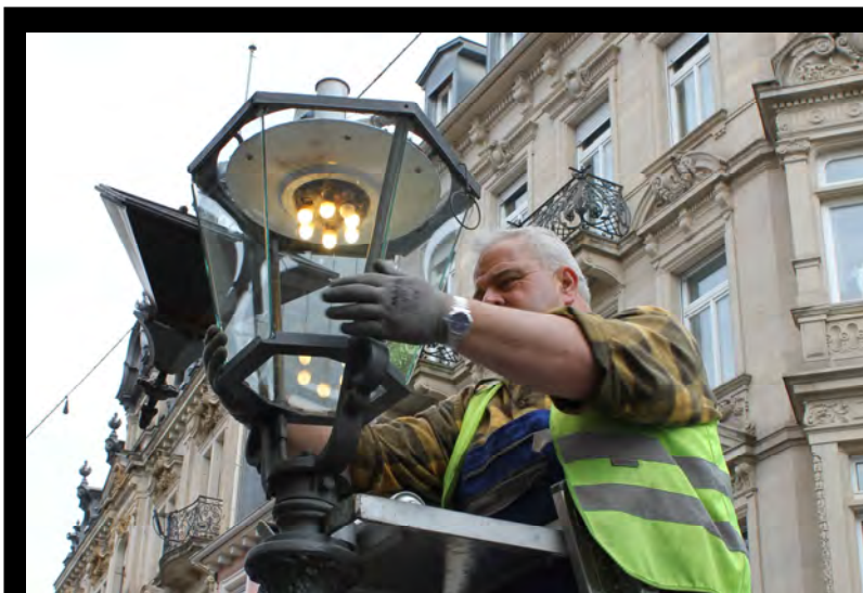
Reinigung einer Gasleuchte in der Innenstadt von Baden-Baden. Bild Oliver Frühschütz
