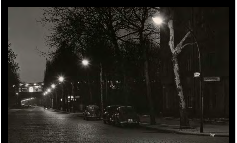
Gasreihenleuchten Typ „Bamag U13H“ am Rohrdamm im April 1957
