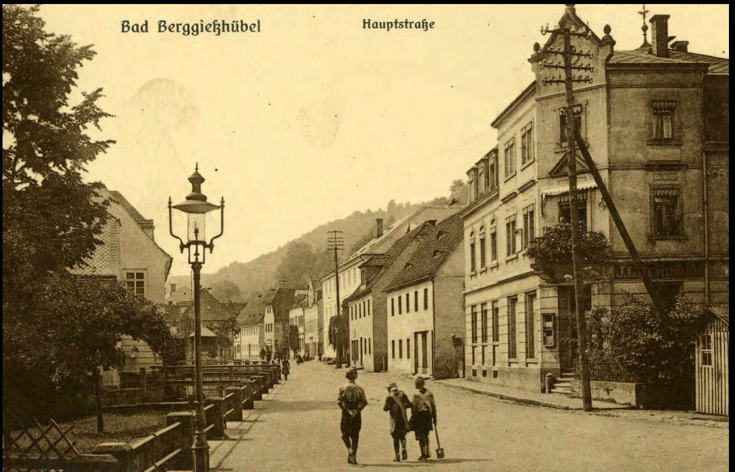
Freilicht-Gasleuchten auf Blochmann-Kandelaber (wie Dresden) in der Hauptstraße (1915); unten Bündelpfeilmast mit Verlängerung und Gashängeleuchte in der Königsstraße (1914). Bilder Brück & Sohn Kunstverlag
