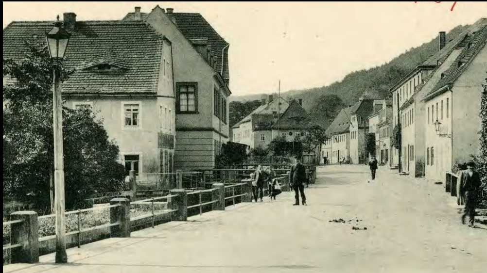
Die Aufnahme aus dem Jahr 1899 zeigt sechsseitige Laternen, die vermutlich mit Öl betrieben wurden. Hinten rechts eine Wandlaterne. Gas gab es noch nicht. Bild Brück & Sohn Kunstverlag
