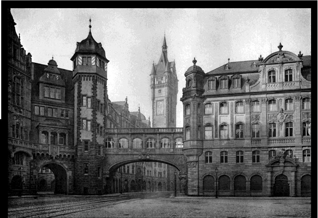
Oben: Blick auf die Braubachstraße und die sogenannte Seufzerbrücke, im Hintergrund der „Lange Franz“, rechts die „Kämmerei“, sie hat ebenfalls bis heute ein Notdach aus der Nachkriegszeit. Auch hier kursierten bereits Pläne, das Dach im originalen Stil zu rekonstruieren.
