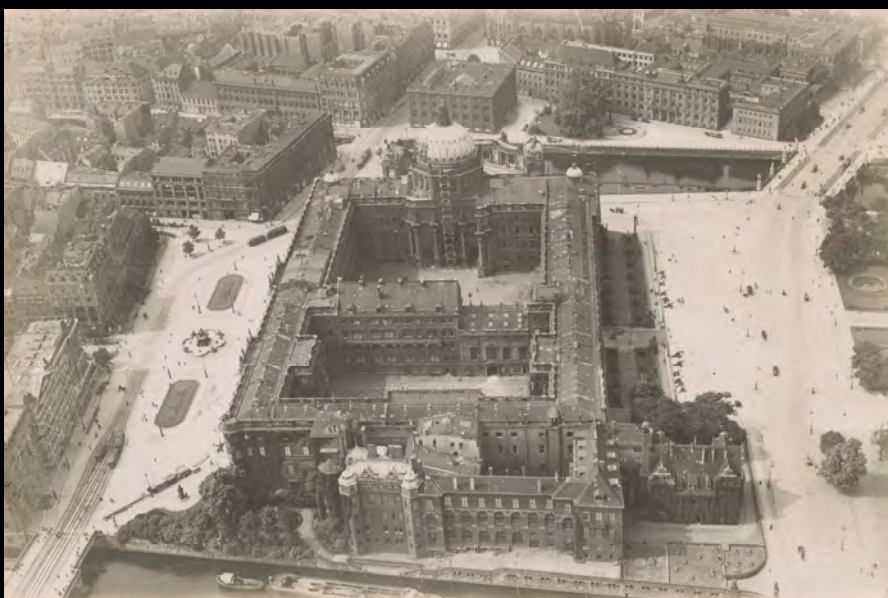
Das Berliner Schloss von Osten aus, am oberen Bildrand die Bauakademie, rechts daneben der Schinkelplatz. Bildquelle unbekannt (um 1920)
