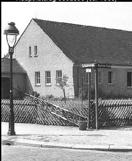
Gasaufsatzleuchte in der Carlowitzstraße (1958). Bild Dt. Fotothek df hp 0007292_033
