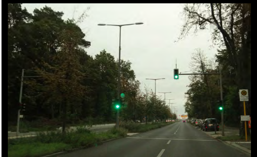
Der Kirchhainer Damm heute, eine Schnellstraße. Bild: BRG
