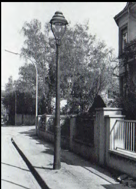
Um 1970: Eine Gasaufsatzleuchte von Rech „Modell Modern“ auf dem sogenannten Kölner Stadtkandelaber. Quelle: Jubiläumsschrift 125 Jahre Gas für Saarbrücken.
