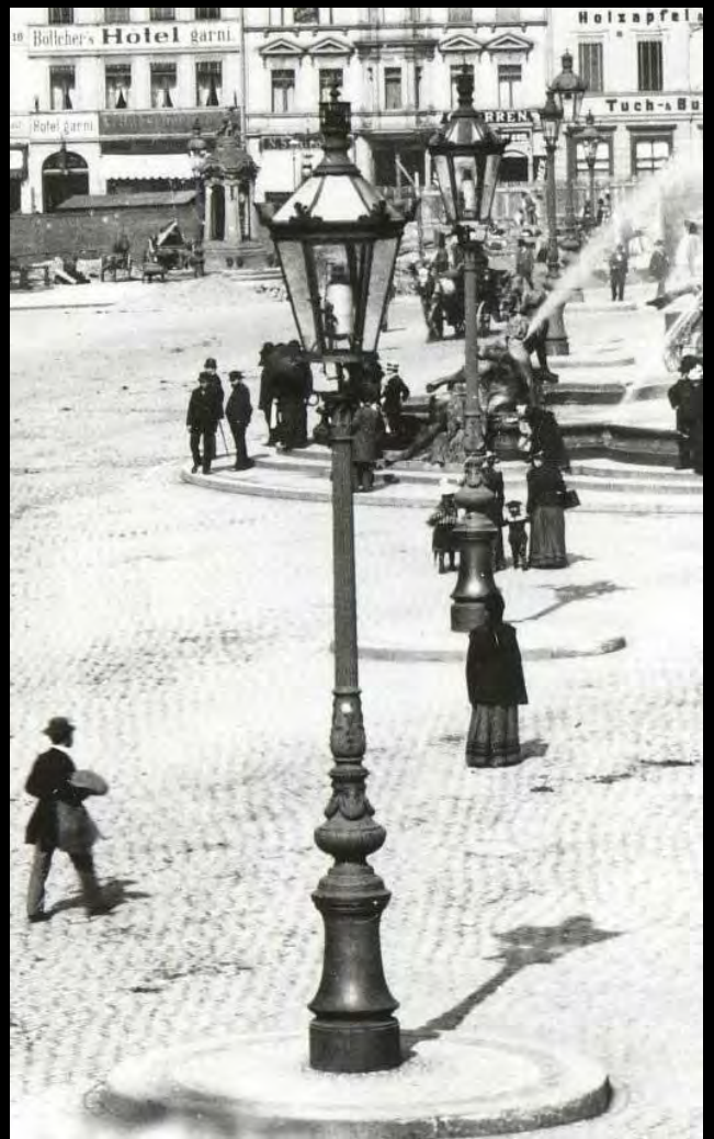
Berlin: Probebeleuchtung mit Regenerativlampen. Links vor dem Palais Hardenberg. Der Leuchtenkopf ist für den schmalen Bündelpfeilmast viel zu wuchtig. Rechts verschiedene Regenerativlampen auf dem Schlossplatz (um 1885). Hier mit Gaskandelabern schwerer Bauart. Bilder Sammlung ProGaslicht
