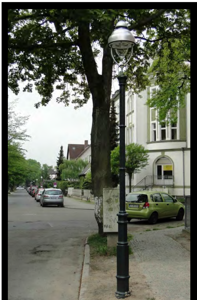
Diese Gaslaternen-Attrappe mit LED – ein schwarz gestrichener, neuer Bündelpfeilmast der Berliner Firma Behr, steht schon seit April 2014 an der Blohmstraße/Ecke Wünsdorfer Straße in Lichtenrade
