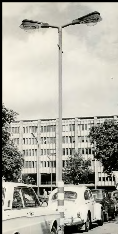
Gerader Stahlmast mit Doppelausleger für zwei GICS-Gasreihenleuchten „L56“
