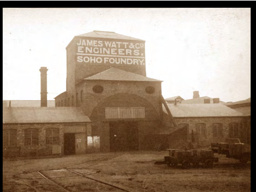
In der am 30. Januar 1796 eröffneten Soho Foundry (Gießerei) fanden erste Experimente mit Gasbeleuchtung statt. Bild www.averyberkel.com
