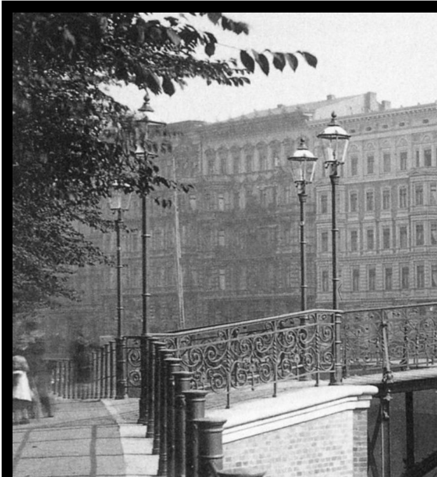
Gasleuchten der Städtischen Berliner Gaswerke (1880) auf der Melchiorbrücke. Das Modell wurde 1847 erstmals in Berlin aufgestellt. Bild Hermann Rückwardt
