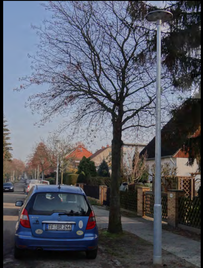
Ein ganzer Straßenzug (Bamberger Straße) mit „UFO“-Leuchten, die Gasaufsatzleuchten wurden 2019 entfernt. Bild Bettina Raetzer-Grimm
