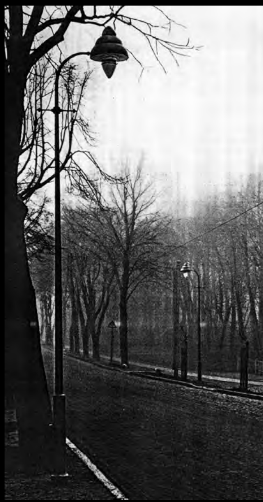
Oben: Frühe Gasansatzleuchte von BAMAG, montiert an einem Stahlmast mit kurzem Ausleger (1930er Jahre). Links eine frühe Ansatzleuchte (1920er Jahre) an einem Rech-Ausleger in Frankfurt am Main-Oberrad; darunter das Rech-Modell „Essen-Elektra“ als Aufsatz- und Ansatzleuchte. Rechts frühe Formen aus den 1920er Jahren: Typische Frankfurter Gusskandelaber mit Verlängerungen für Gashänge- und -ansatzleuchten. Bildausschnitte bzw. Abbildung Sammlung ProGaslicht
