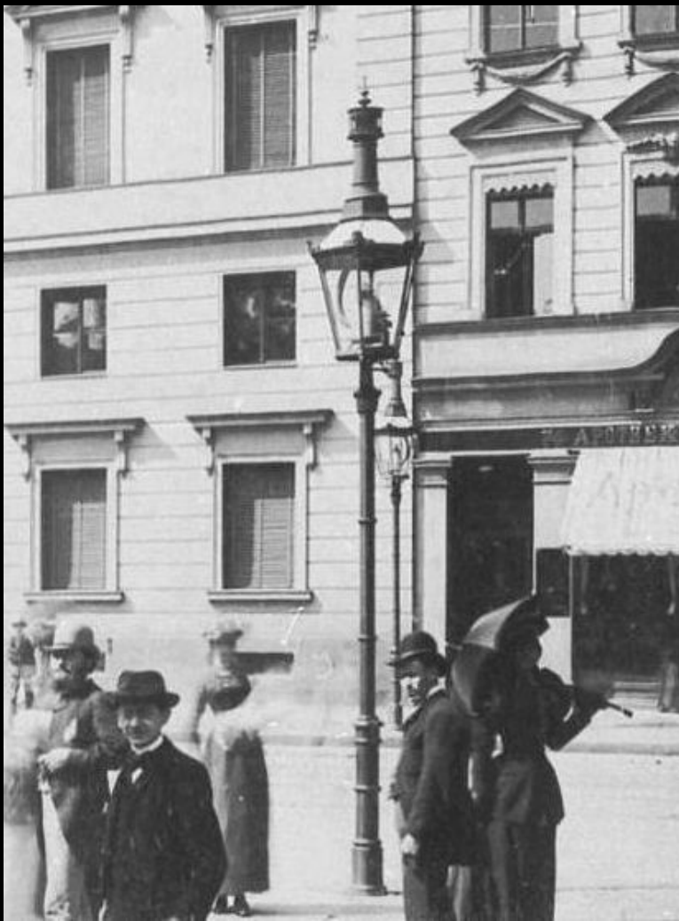
Berlin: Probebeleuchtung mit Regenerativlampen. Links vor dem Palais Hardenberg. Der Leuchtenkopf ist für den schmalen Bündelpfeilmast viel zu wuchtig. Rechts verschiedene Regenerativlampen auf dem Schlossplatz (um 1885). Hier mit Gaskandelabern schwerer Bauart. Bilder Sammlung ProGaslicht
