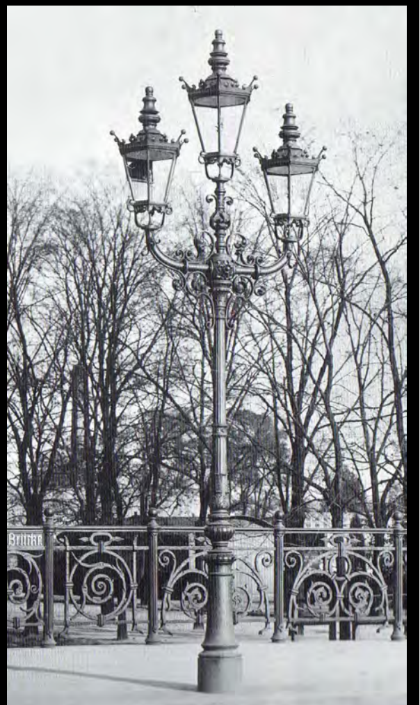
Dreiarmer Gaskandelaber mit sechseckigen Laternen mit Verzierungen auf der Schlesischen Brücke (1885). Bild Slg. PGL
