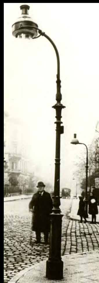
Oben: Frühe Gasansatzleuchte von BAMAG, montiert an einem Stahlmast mit kurzem Ausleger (1930er Jahre). Links eine frühe Ansatzleuchte (1920er Jahre) an einem Rech-Ausleger in Frankfurt am Main-Oberrad; darunter das Rech-Modell „Essen-Elektra“ als Aufsatz- und Ansatzleuchte. Rechts frühe Formen aus den 1920er Jahren: Typische Frankfurter Gusskandelaber mit Verlängerungen für Gashänge- und -ansatzleuchten. Bildausschnitte bzw. Abbildung Sammlung ProGaslicht
