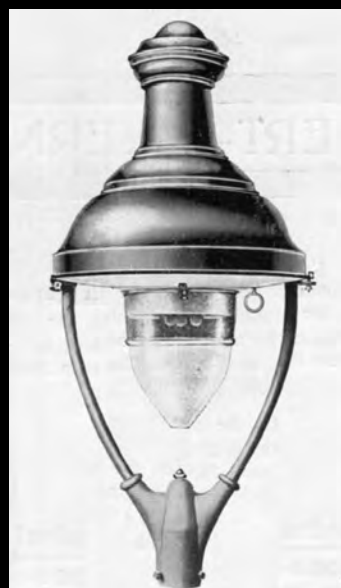
Von links: Rundmantellaterne No. 44b von Julius Pintsch. Hier bereits mit Pilzbrenner und Meteorit-Zünder aus der Nachkriegszeit. Vorher mit Dortmunder Zünder und Stehlichtbrenner; Schneider-Aufsatzleuchte „Nr. 1009“ mit Invertbrenner um 1913. In den 1980er Jahren als Zierleuchte „Modell Dortmund“ neu aufgelegt; daneben zweimal Schneider-Aufsatzleuchte „Modell Köln“ mit neuem Bügel und geschlossenem Fuß. Links ältere Form, jedoch bereits mit Gruppenbrenner u. Blohmglöcke. Rechts Ausführung ab 1927 mit Bügel „g“.
