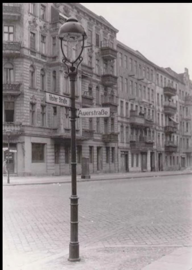
Berlin-Friedrichshain, Tilsiter Straße: In den 1920er Jahren lösten Gasaufsatzleuchten allmählich die Modellleuchten ab. Die Gasbeleuchtung wurde weiter modernisiert. Mit der Bildung von Groß-Berlin leuchteten etwa 80.000 Gaslaternen in der Hauptstadt. Bild: unbek./Sammlung PGL
