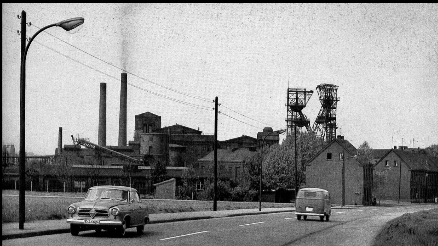
Gasreihenleuchten an hohen Masten mit kurzen Auslegern in der Borussiastraße mit Blick auf Zeche Oespel um 1958.
