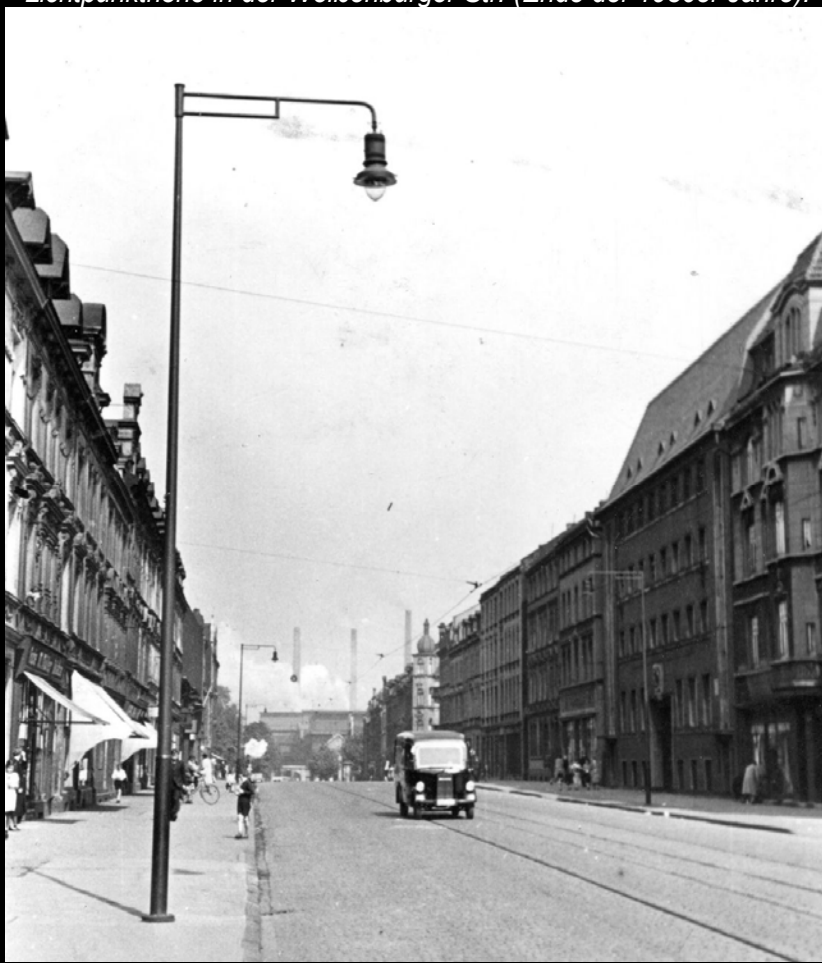
Unten Thomas-Hängeleuchten an Benteler-Masten mit 7,50 Meter Lichtpunkthöhe in der Weißenburger Str. (Ende der 1930er Jahre).
