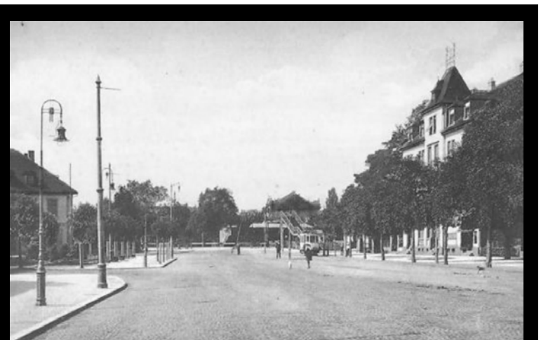
↑ Hängelicht-Kandalaberaufsätze auf Gussmaste süddeutscher Bauart mit Himmel-Inverthängeleuchten. Am Westbahnhof um 1910. Bild Sammlung Klaus Gevatter
