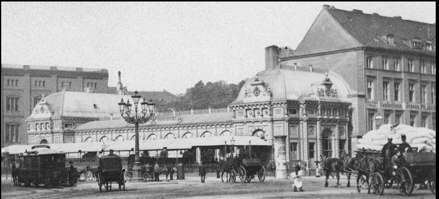
Am südlichen Ende der Schlossfreiheit war das 1882-83 errichtete und recht beliebte Café Helms. Es befand sich in einem Interimsbau, den die renommierten Berliner Architekten Hermann Ende und Wilhelm Böckmann entworfen hatten. Es handelte sich um ein frühes Beispiel eines Fertighauses mit Eisenfachwerk-Konstruktion in Deutschland. Die beiden Flügelpavillons des Gebäudes verband ein langgezogener Hallentrakt, in dem die Wirtsstube lag. Das nach seinem Betreiber benannte Café Helms entwickelte sich zu einem beliebten Treffpunkt der Berliner Gesellschaft, existierte aber nur zehn Jahre lang. Der Abriss erfolgte ab 1893. Davor ein fünfarmiger Gaskandelaber von Strack. Bild Hermann Rückwardt
