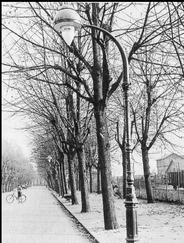
Oben: Vulkan Modell Nr. 61 auf Gussmast süddeutscher Bauart; unten Vulkan-Ansatzleuchte an einem auf Gussmast aufgesetztem Ausleger, Philippsruher Allee 1935. Bilder: Stadtwerke Hanau GmbH
