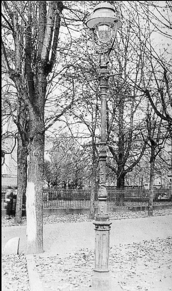
Oben: Vulkan Modell Nr. 61 auf Gussmast süddeutscher Bauart; unten Vulkan-Ansatzleuchte an einem auf Gussmast aufgesetztem Ausleger, Philippsruher Allee 1935. Bilder: Stadtwerke Hanau GmbH
