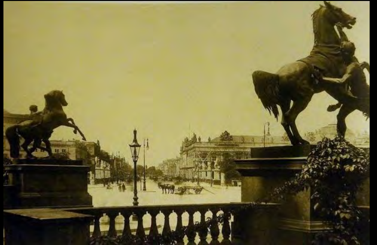
Ein weiteres Mal der Blick von den Schlossterrassen in Richtung „Unter den Linden“. Vergleichsbild auf Seite 29. Nun ist eine Siemens-Regenerativlampe auf einem schweren Gaskandelaber zu sehen, außerdem sind im Hintergrund elektrische Bogenlampen zu erkennen. Bildquelle unbek./Slg. ProGaslicht
