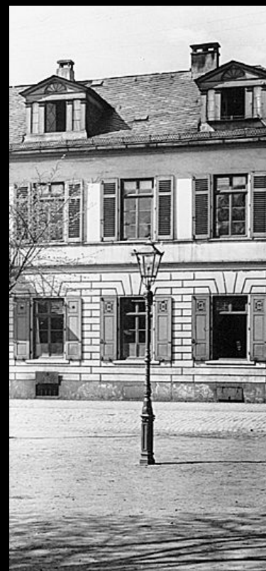
↑ Vierseitige Gaslaterne mit Kandelaber süddeutscher Bauart. Die Laterne ist bereits mit stehendem Gasglühlicht ausgestattet. Bildquelle unbekannt.
