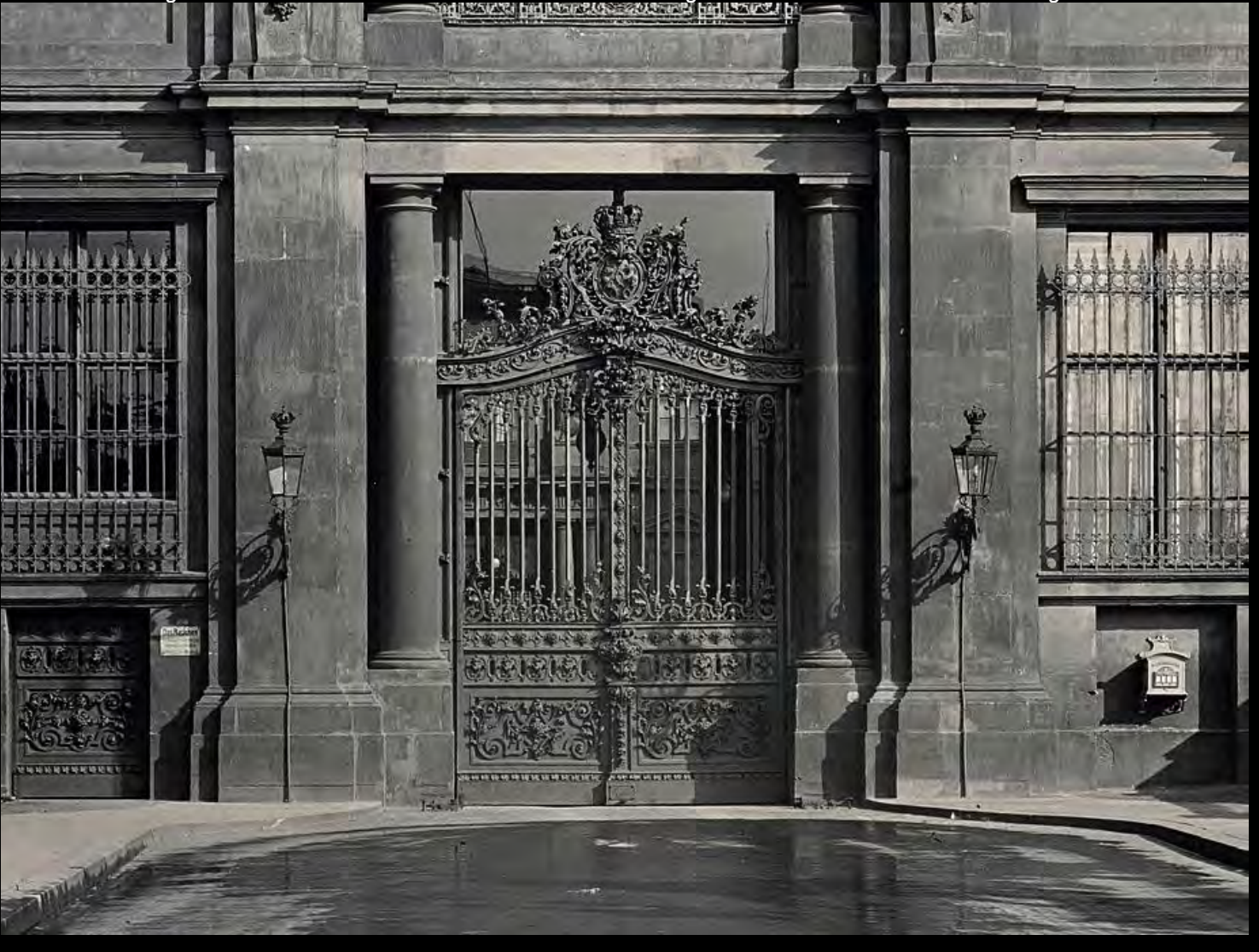
Das Portal IV des Berliner Schlosses und die Lustgartenterrasse mit den beiden Rossebändigern. Auf dem Bildausschnitt unten sind die beiden sechseckigen Gaslaternen an Wandkonsolen gut zu erkennen. Sie sind mit Stehlichtbrennern ausgerüstet. Eine Besonderheit sind die Dachbekrönungen der Laternen. Bild unbekannt/Slg. PGL
