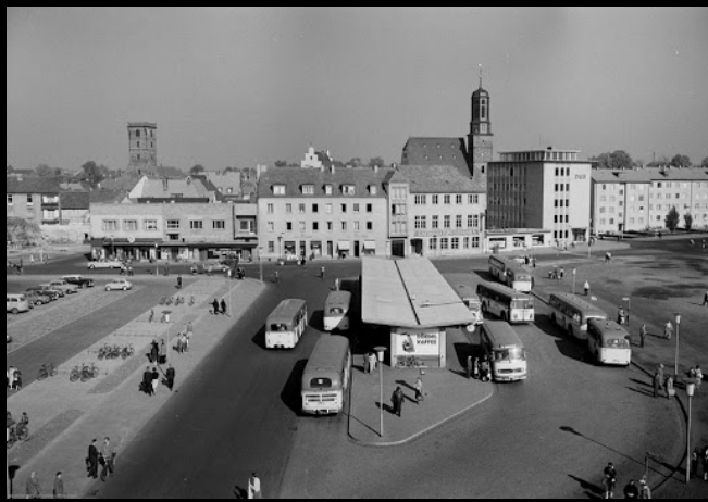
Der Freiheitsplatz wurde zu einem trostlosen, „zeitgemäßen“ Busbahnhof.
