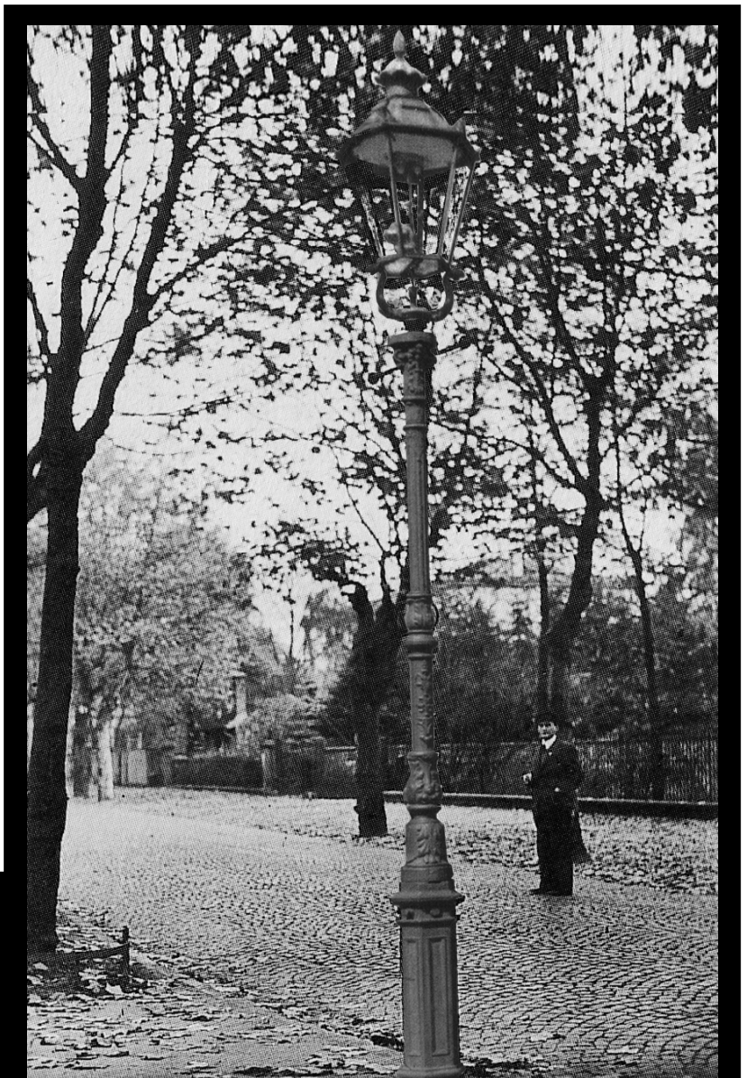
↑ Sechsecklaterne „Modell Freiburg“ mit bereits nachgerüstetem Pilzbrenner auf Gusskandelaber süddeutscher Bauart. Bild Sammlung Klaus Gevatter
