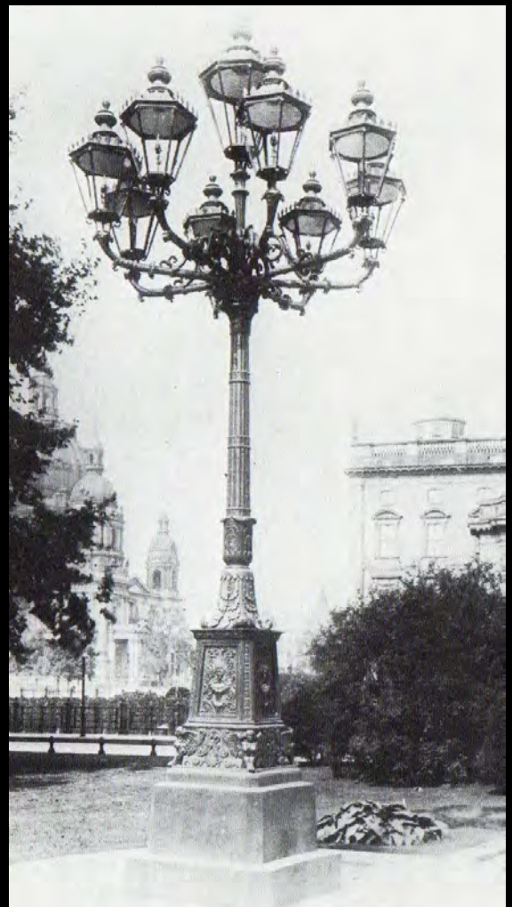
Oben: Standort Schinkelplatz (1912). Ursprünglich war die mittlere, achteckige Laterne größer als die acht anderen. Erst mit der Montage der Berliner Modellleuchten (Bilder links) änderte sich das.
