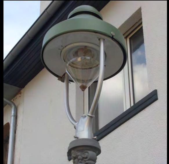
*LED-Gaslaternen-Attrappe mit bereits nach kurzer Zeit verschmutzter Glasglocke*
