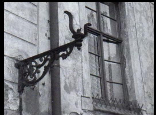
Sichtbare Spuren der Gasbeleuchtung. Oben ein „vergessener Wandarm“, unten ein im Pflaster sichtbarer Erdkorb zur Befestigung der Laterne. Bilder Archiv ProGaslicht und Oliver Fröhschütz
