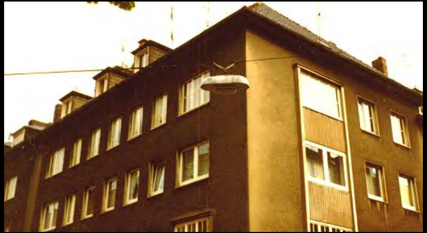
Die Gasreihenleuchte von Stein & Vendel war nur für die Montage an Straßenüberspannungen konzipiert. Bilder: Sammlung Klaus Gevatter
