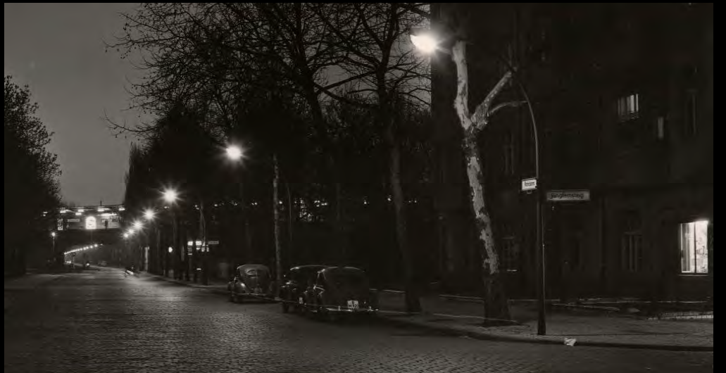
↑ Die Entwicklung der Gasreihenleuchte führte zum Aufstellen der dazu passenden Bogenauslegermaste, wahlweise auch als Peitschenmaste oder als Gaspeitsche bezeichnet. Hier auf dem Rohrdamm in Berlin-Siemensstadt im April 1957. Bildquelle: unbekannt/Sammlung ProGaslicht
