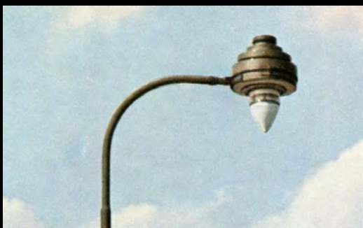
Bogenauslegermast mit Gasansatzleuchte von RECH Modell 33c in Düsseldorf. Bild Archiv Klaus Gevatter
