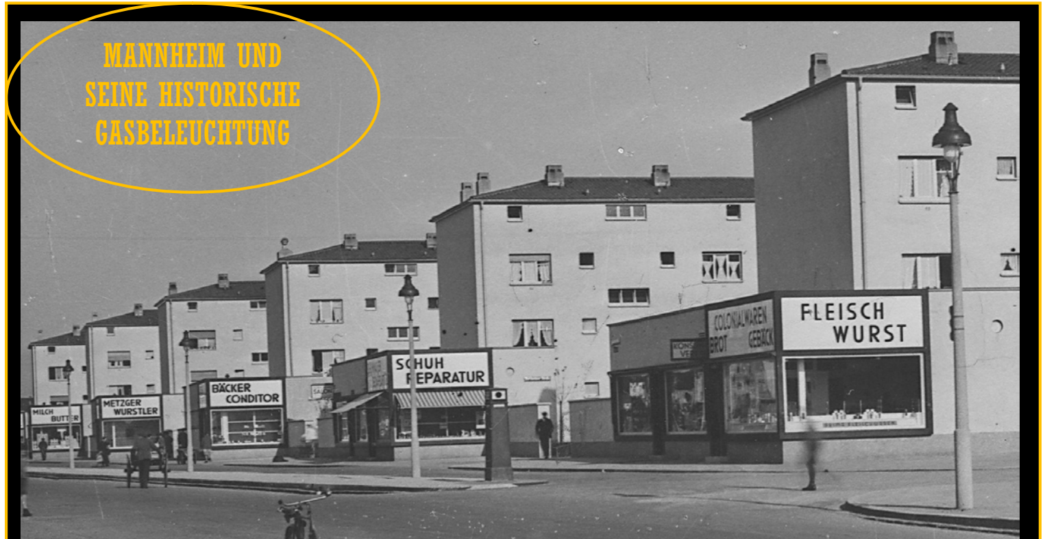
Die Bäckerwegsiedlung. Bild Marchivum ABO 1698-4-178; unten Wuthsche Brauerei. Bild Marchivum KF033565. Auffällig die Beton-Gaskandelaber mit Gasleuchten der „Bauart Köln“ (um 1931)
