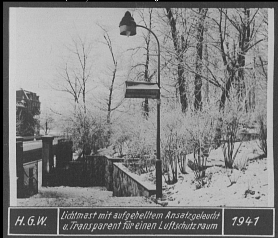
↑Frühe kurze Auslegermaste mit Gasansatzleuchten in Reutlingen. Links ein Mast aus Beton, rechts ein Stahlmast; unten ein kurzer Bogenauslegermast mit Ansatzleuchte und Verdunkelung, außerdem ein mit Gas beleuchtetes Transparent-Hinweisschild für einen Luftschutzkeller (1941). Bilder: Sammlung Klaus Gevatter
