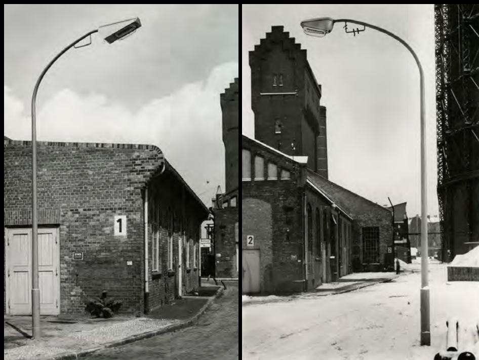
↑Gasreihenleuchten an Peitschenmasten auf dem Gelände des Gaswerks Berlin-Schöneberg, Torgauer Straße (frühe 1950er Jahre). Links der Prototyp; rechts BAMAG U13B
