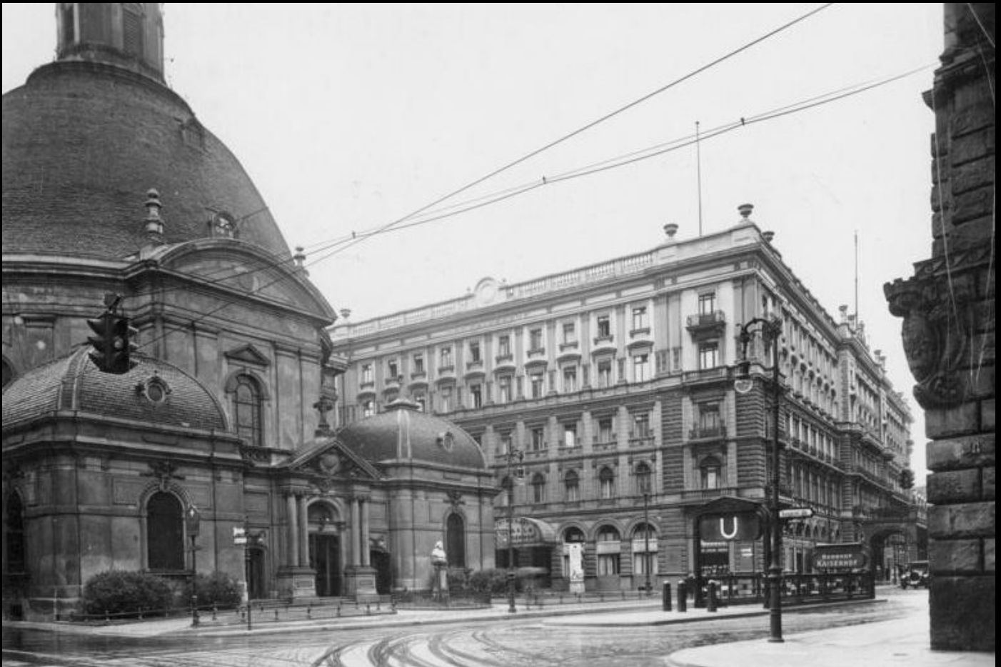
Blick von der Mohrenstraße zum Hotel „Kaiserhof“ und zum östlichen Eingang des gleichnamigen U-Bahnhofes. Links die Dreifaltigkeitskirche. Die Aufnahme von 1931 zeigt eine über der Straße aufgehängte Verkehrsampel sowie Pressgaskandelaber. Die protestantische Kirche hat eine bewegte Geschichte: 1737-39 erbaut, wurde Otto von Bismarck hier konfirmiert. 1932/33 predigte in der Kirche der am Widerstand gegen die Nazis beteiligte und 1945 von ihnen ermordete Dietrich Bonhoeffer. Die Kirche brannte 1943 nach einem Bombenangriff aus und wurde dann als Bunker umfunktioniert. 1947 wurde die Kirchenruine gesprengt. Bild Bundesarchiv 183-1982-1213-508
