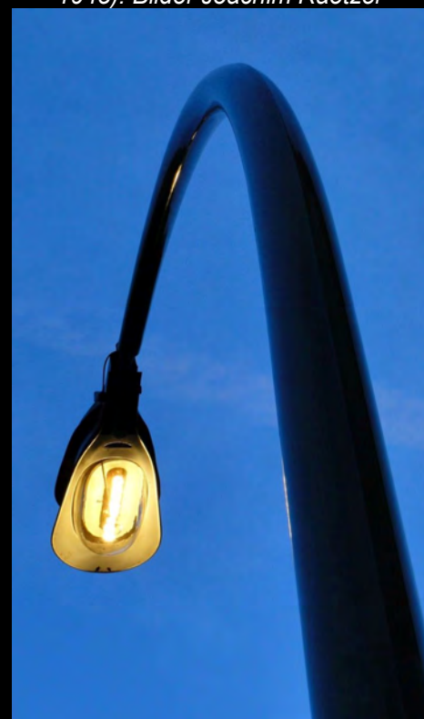
↑↓ Gasreihenleuchten in der Obermainanlage, oben mit einem Gasmast älterer Bauart (vermutlich vor 1945). Bilder Joachim Raetzer
