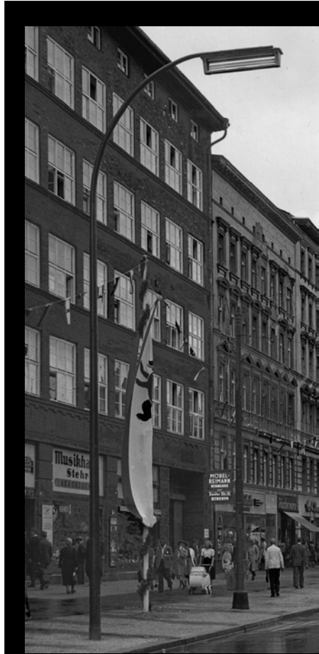
↑ Peitschenmast mit elektrischer Langfeldleuchte früher Bauart in Berlin-Wedding, Müllerstraße im Juni 1951. Bild Archiv Sabine Röck
