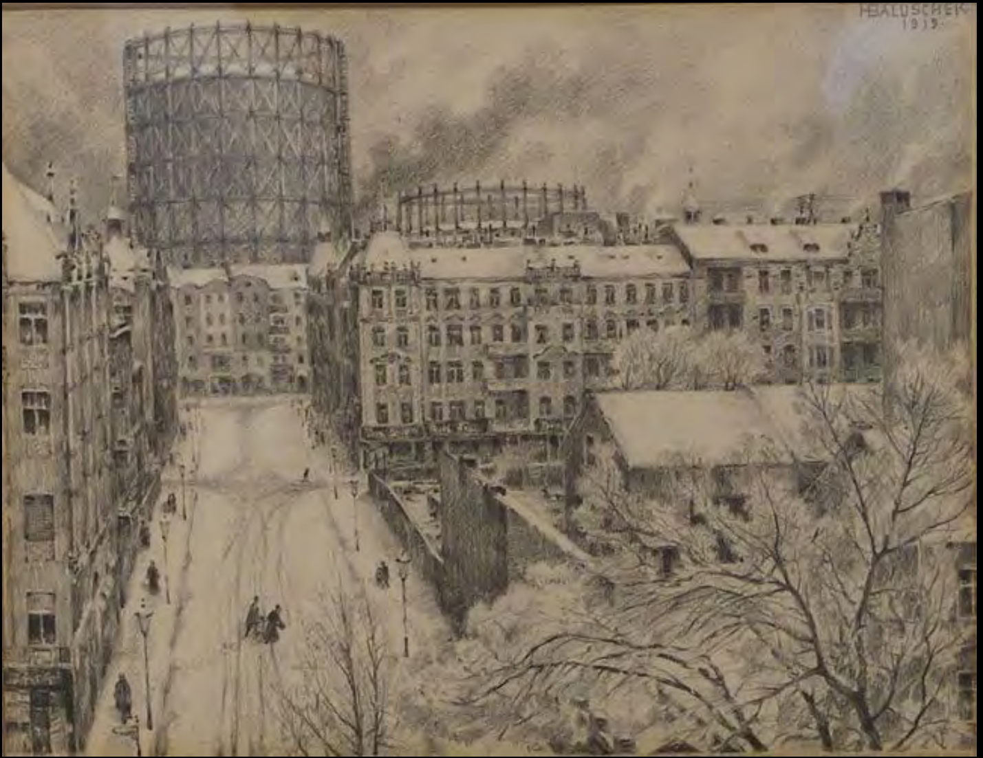
Die Straßenflucht der Albertstraße in Berlin-Schöneberg. An deren Ende ist das große Gaswerk mit den Gasometern zu sehen. Der Künstler wohnte in der obersten Etage des Hauses Hauptstr. 34/35 mit Blick auf den Gasometer. Die großstädtische Mietskasernenbebauung, rechts im Bild die niedrige Altbebauung, wenig später abgerissen, zeigen hier einen Wintereindruck. Der große Gasometer selbst ist nahezu komplett gefüllt. Die wenigen Menschen auf der Straße vermitteln insgesamt einen ruhigen Bildeindruck. Bild „Albertstraße in Schöneberg“ Hans Baluschek (1919)
