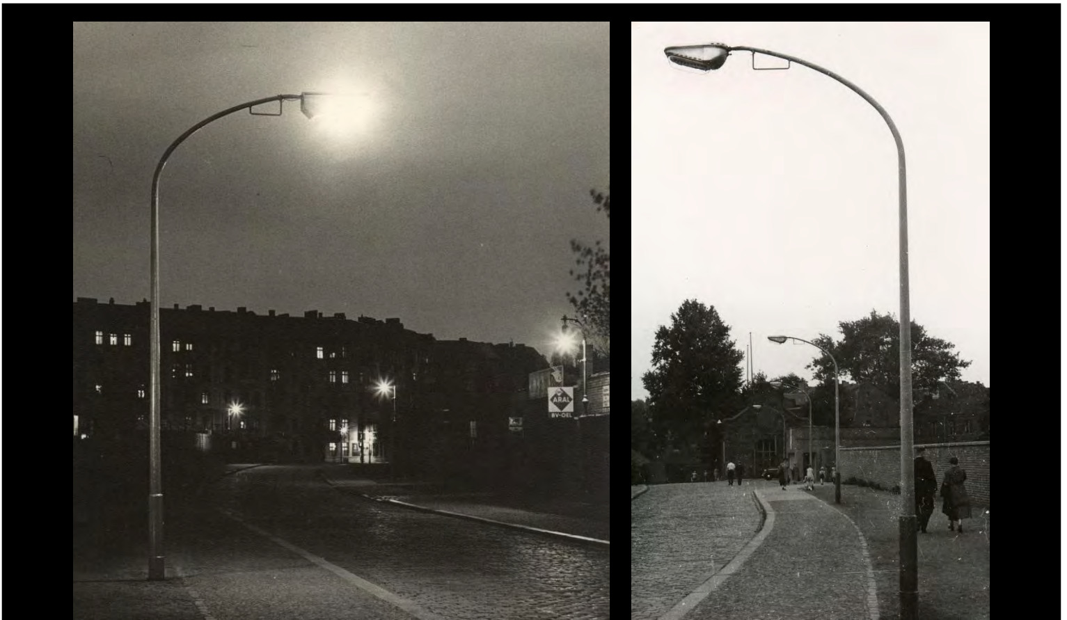
Am Gaswerks-Standort Torgauer Straße in Berlin-Schöneberg wurde immer wieder experimentiert. Oben links der Reihenleuchten-Prototyp an einem frühen Gaspeitschenmast; rechts die Reihenleuchte BAMAG U13B. Die Gasmaste besaßen anfangs ein Leitereisen. Unten Reihenleuchten-Prototypen auf dem GASAG-Werksgelände. Im Vordergrund eine bemerkenswerte Gas-Großflächenleuchte (Hersteller vermutlich Firma RECH). Bildquelle: GASAG
