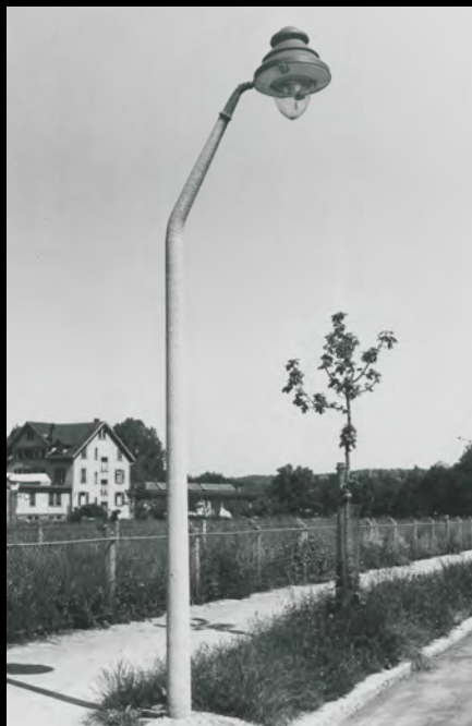
↑Frühe kurze Auslegermaste mit Gasansatzleuchten in Reutlingen. Links ein Mast aus Beton, rechts ein Stahlmast; unten ein kurzer Bogenauslegermast mit Ansatzleuchte und Verdunkelung, außerdem ein mit Gas beleuchtetes Transparent-Hinweisschild für einen Luftschutzkeller (1941). Bilder: Sammlung Klaus Gevatter
