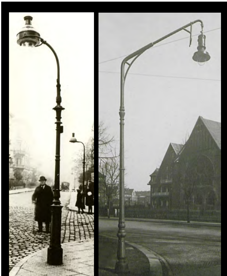
Links: Gusskandelaber in Frankfurt am Main mit einem aufgesteckten Bogenausleger als Verlängerungsstück sowie einer Gasansatzleuchte (1920er Jahre); rechts Jugendstilkandelaber in Hamburg, Schäferkampsallee. Hier ebenfalls mit einem Ausleger als Mastverlängerung sowie einer Gashängeleuchte (1927). Bilder Archiv ProGaslicht
