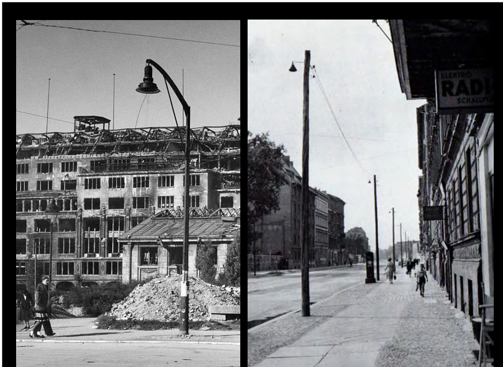
Links: Beschädigte neuzeitliche Gashängeleuchte sowie eine Gasaufsatzleuchte (hinten links) auf dem Wittenbergplatz in Berlin. Im Hintergrund das vom Bomben getroffene Kaufhaus des Westens (KaDeWe); rechts provisorische elektrische Beleuchtung in der Köpenicker Straße in Berlin. Ausleger mit Leuchten, montiert an Holzmasten, der Strom kommt über eine Freileitung. Bild links: Quelle unbekannt, rechtes Bild aus: „Mehr Licht“ – von Herbert Liman.
