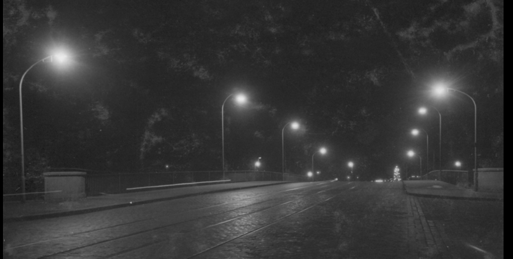
↕ Berlin-Moabit (Westsector): Gasansatzleuchten an Bogenauslegermasten (Peitschenmasten) an der nördlichen Seestraßenbrücke im März 1952. Auf der Brücke selbst stehen Bogenauslegermasten mit elektrischen Hängeleuchten. Vergleich Tag/Nacht. Bildquelle BEWAG-Archiv/Archiv Sabine Röck
