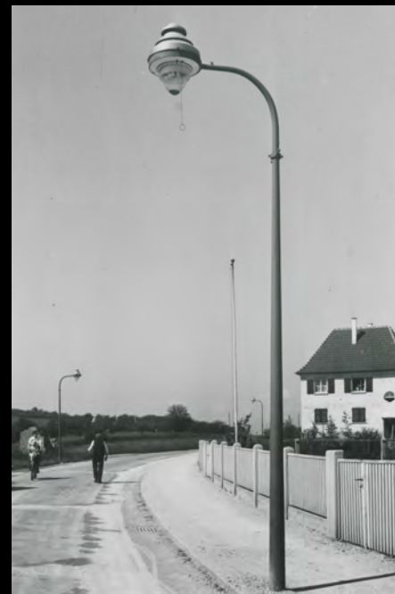
↑Frühe kurze Auslegermaste mit Gasansatzleuchten in Reutlingen. Links ein Mast aus Beton, rechts ein Stahlmast; unten ein kurzer Bogenauslegermast mit Ansatzleuchte und Verdunkelung, außerdem ein mit Gas beleuchtetes Transparent-Hinweisschild für einen Luftschutzkeller (1941). Bilder: Sammlung Klaus Gevatter
