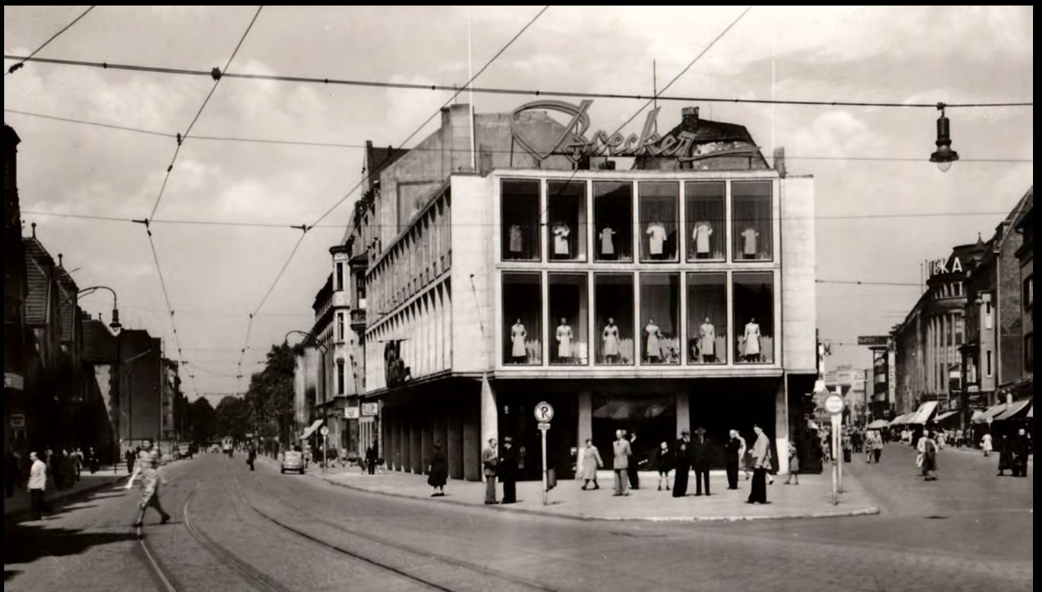
↑ Gelsenkirchen in den 1950er Jahren. Die Bahnhofstraße wird mit Gas beleuchtet. Vorn rechts eine typische Gashängeleuchte, hinten links Hängeleuchten an Jugendstil-Auslegermasten. Bild (Ansichtskarte) Sammlung Bruckmann
