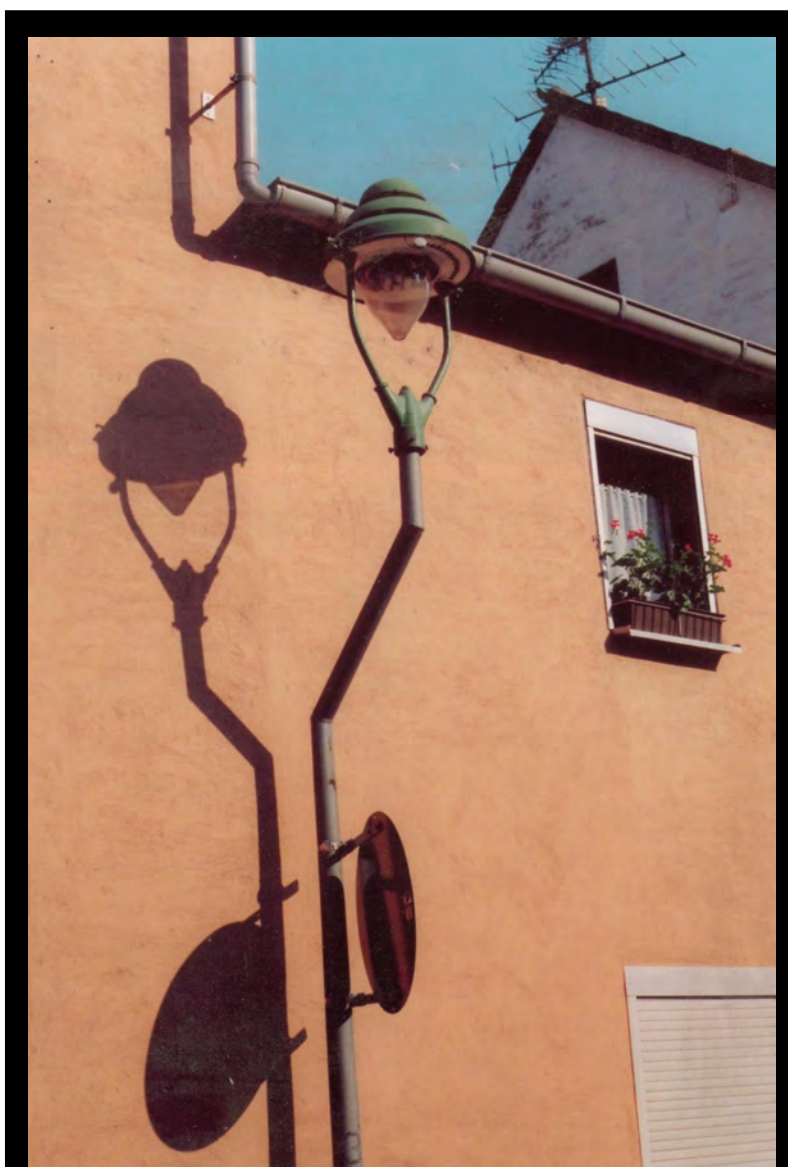
Eine Besonderheit waren die zweifach abgeknickten Stahlgasmaste. Bilder ⚡ (um 2005) Bettina Raetzer-Grimm
