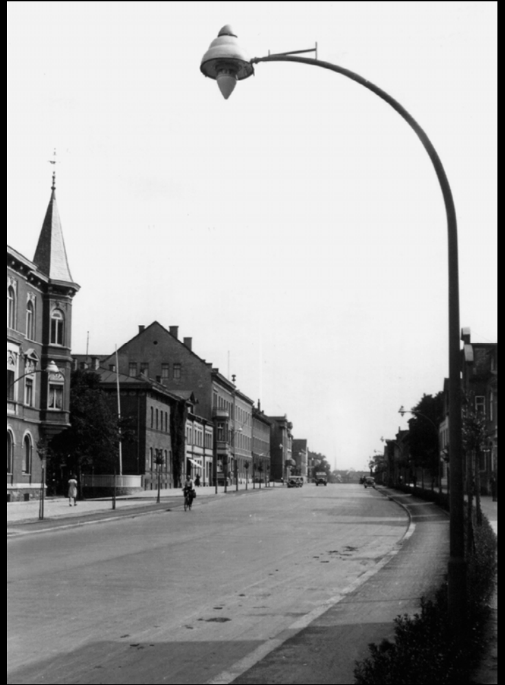
Gasansatzleuchte BAMAG U11 an einem Bogenauslegermast (1938) in Königsberg/Preußen, Deutschordensring. Bildquelle unbekannt/Sammlung ProGaslicht
