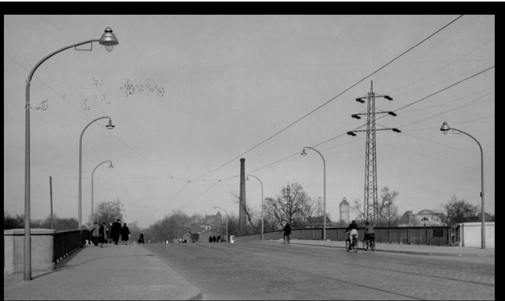
↕ Berlin-Moabit (Westsector): Gasansatzleuchten an Bogenauslegermasten (Peitschenmasten) an der nördlichen Seestraßenbrücke im März 1952. Auf der Brücke selbst stehen Bogenauslegermasten mit elektrischen Hängeleuchten. Vergleich Tag/Nacht. Bildquelle BEWAG-Archiv/Archiv Sabine Röck
