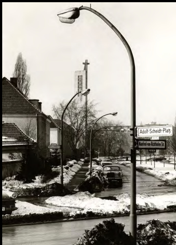
↑ Berlin-Tempelhof: Im Vordergrund eine Gasreihenleuchte U13B mit dem typischen zweifach abgeknickten Gas-Peitschenmast, weiter hinten eine U13H mit üblichem Gas-Peitschenmast; unten BAMAG-Werbung für Gasdruckfernzündler und Reihenleuchten, daneben Wartung einer Gasreihenleuchte in Berlin (1950er Jahre). Bildquellen unbekannt/Sammlung ProGaslicht
