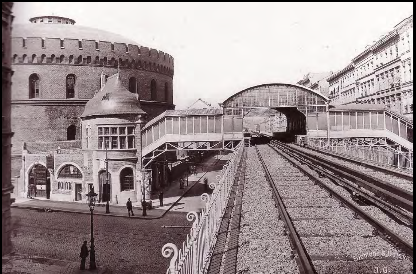
Die Hochbahnstation Prinzenstraße, links ein Gasometer des Gaswerks Gitschiner Straße. Hier wurde von der englischen ICGA am 30. August 1825 der Grundstein für die erste Berliner „Gaserleuchtungsanstalt“ gelegt. Insgesamt vier Gasbehälter befanden sich an diesem Standort, der während des Zweiten Weltkrieges schwer getroffen wurde. Nach 1945 wurde die Gasproduktion an dieser Stelle nicht mehr aufgenommen. Bildquelle Siemens & Halske
