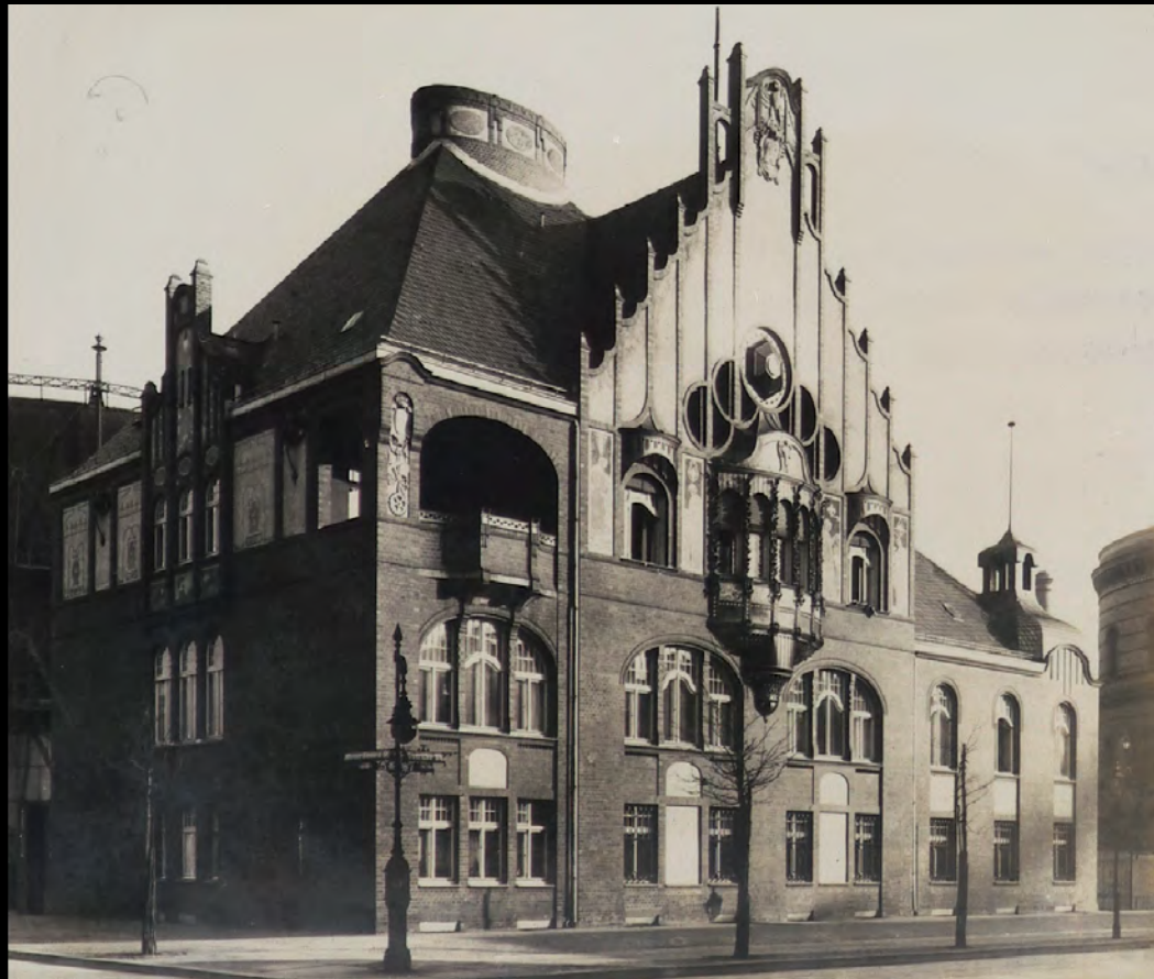
Das repräsentative Verwaltungsgebäude des Gaswerks Charlottenburg. An der Straßenecke steht eine Feuerwehr-Gaslaterne (Kombination Gashängeleuchte mit Feuermelder). Bildquelle GASAG
