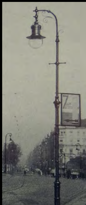
Auch Pressgasbeleuchtung stand für Fortschritt. Hier ein frühes Modell an der Warschauer Brücke. Bild: Sammlung ProGaslicht
