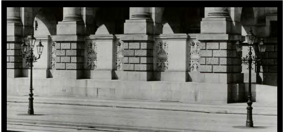
Repräsentative Gaskandelaber mit drei Berliner Modelleuchten vor dem Reichstag um 1895. Die Modelleuchten („Schinkeillaternen“) wurden 1893/94 von der städtischen GASAG entworfen. Der Entwurf des Kandelabers stammt von 1890. In den ersten Jahren waren die davor montierten Laternen noch mit Schnittbrennern ausgestattet, ab 1894 dann die Modelleuchten mit stehendem Gasglühlicht. Bildquelle unbekannt
