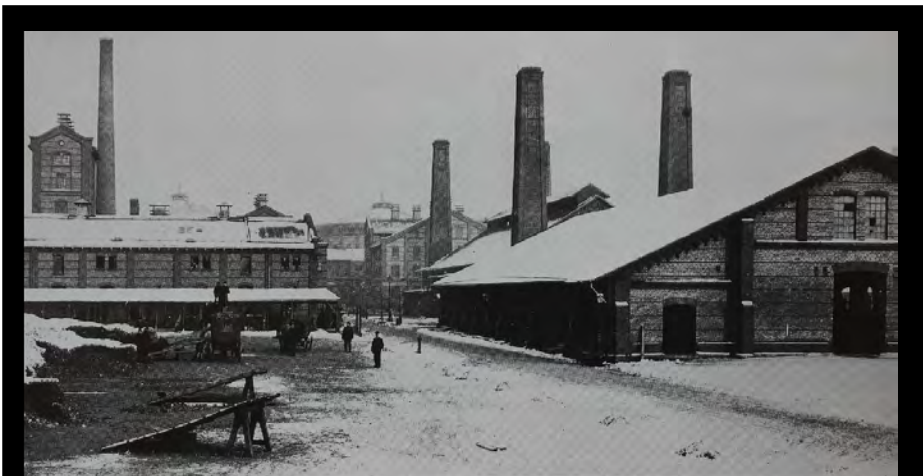
↑ Das städtische Berliner Gaswerk in der Müllerstraße im Jahr 1897.
