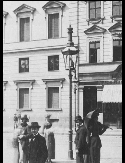
Oben: Gaslaterne mit Regenerativ-Brenner auf einem Bündelpfeilmast am Palais Hardenberg um 1891. Unten: Verschiedene Gaslaternen am Molkenmarkt um 1885. Links eine Regenerativ-Laterne von Friedrich Siemens. Bildquellen unbekannt
