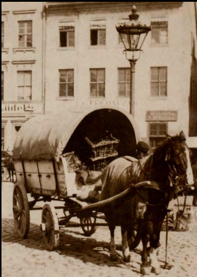
Neuer Markt um 1880: Sechsseitige Gaslaterne (Sonderbauform), vermutlich auf einem Bündelpfeilmast. Bildquelle unbekannt
