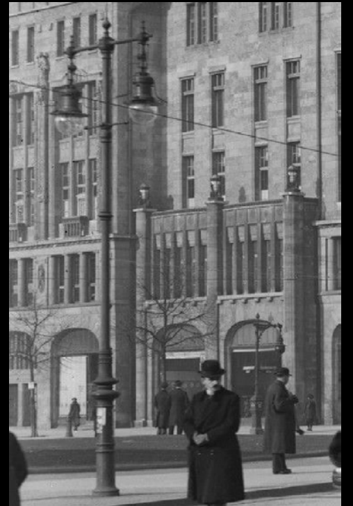
Doppelarmiger Pressgas-Kandelaber auf dem Wittenbergplatz. Bild Slg. PGL
