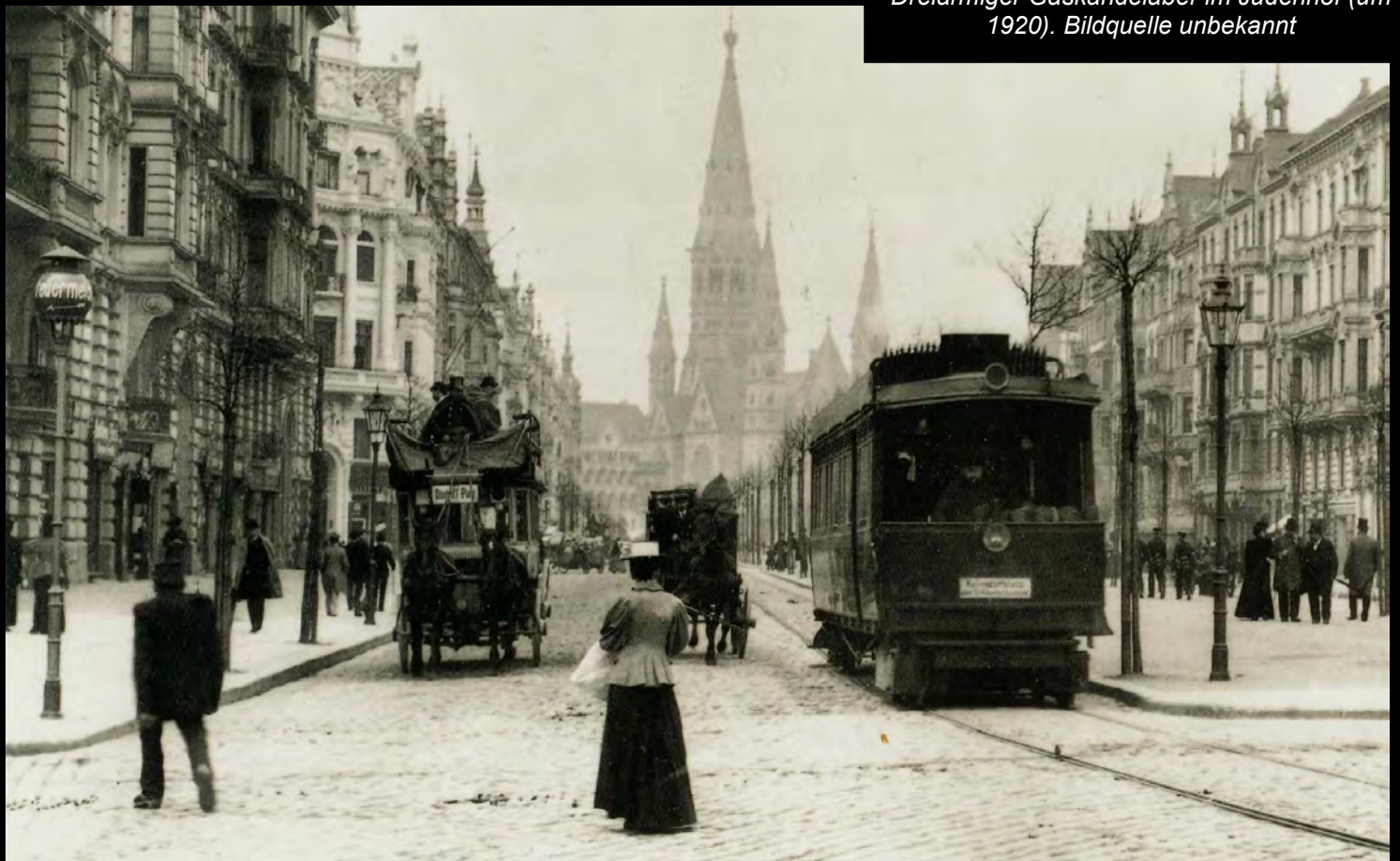
Die Tauentzienstraße um 1897, im Hintergrund die Kaiser-Wilhelm-Gedächtnis-Kirche. Bemerkenswert der am linken Bildrand sichtbare Bündelpfeilermast mit einer Transparent-Gaslaterne, eine Kugelleuchte mit der Aufschrift „Feuermelder“ und einem Pfeil. Zu sehen ist auch ein Dampftriebwagen. Sogenannte Dampfstraßenbahnen verkehrten in Berlin von 1888 bis 1898.
