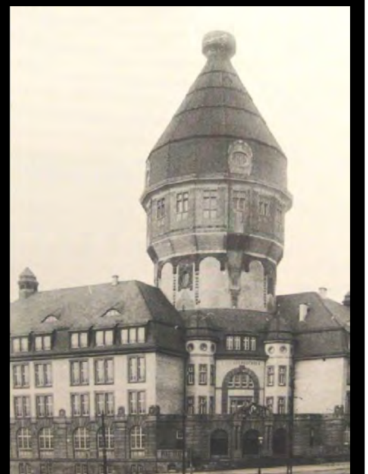
Für das Ortsbild von Luzenberg prägend war neben dem Gaswerk auch der zwischen 1906 und 1909 errichtete Wasserturm (Bild vor 1945). Der Turm wurde im Zweiten Weltkrieg schwer beschädigt, später wiedererrichtet. Dabei wurde das Dach einfacher und flacher gebaut, ganz im Stil der Nachkriegszeit. Bild: unbek./Postkarte
