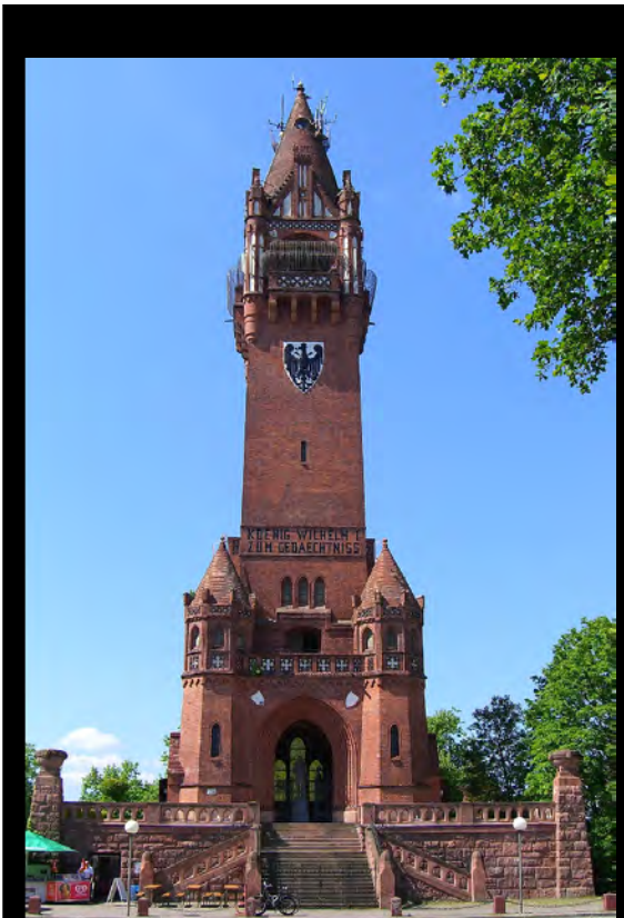
Der Grunewaldturm (damals Kaiser-Wilhelm-Turm) wurde 1899 fertiggestellt, nachdem der Kreistag des Landkreises Teltow zwei Jahre zuvor die Errichtung beschlossen hatte. Bild: Times
