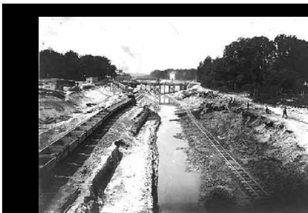
Der Bau des Teltowkanals
