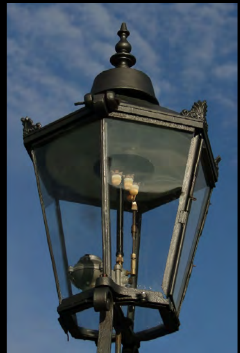
Private Gaslaterne in Dresden-Zschachwitz (Bilder von 2015). Dabei wurde ein originaler halbrunder, vierflammiger Brenner eingebaut. Bilder: Joachim Raetzer
