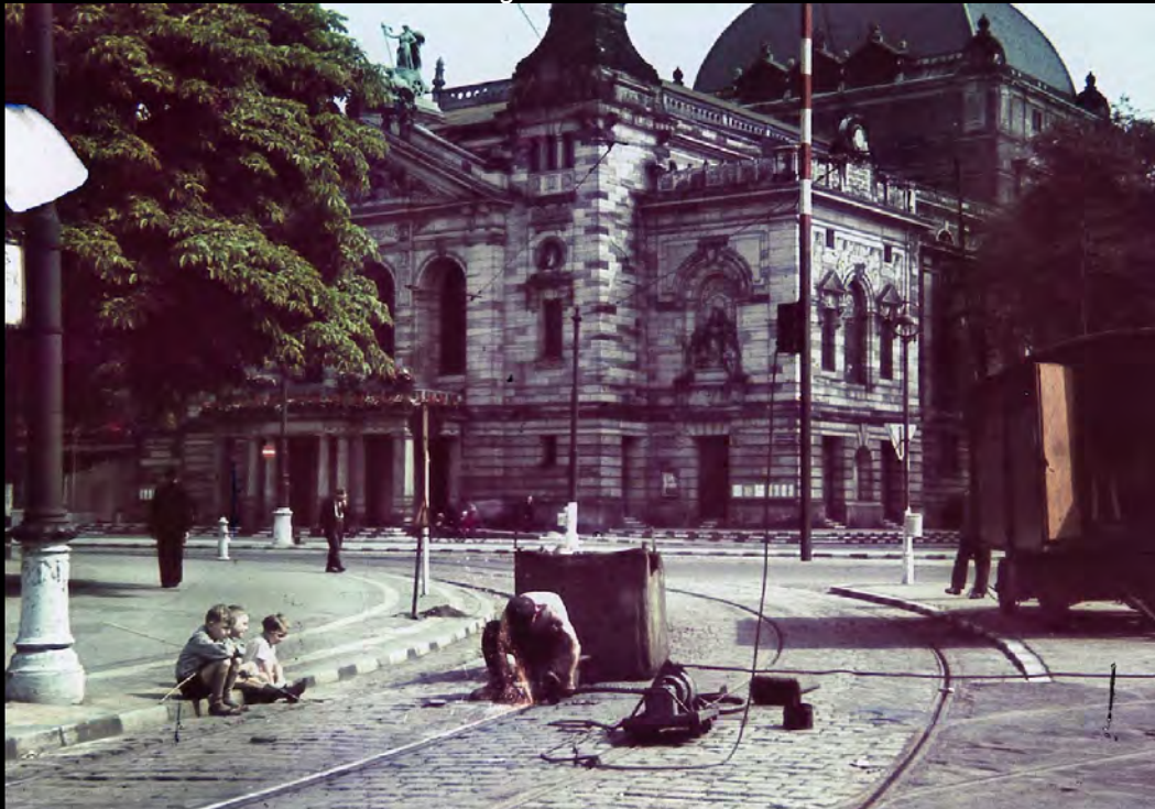
Unten: Gleisbauarbeiten am Schauspielhaus. Hier war der Endpunkt mehrerer Straßenbahnlinien, die in Richtung Norden führen (Linien 23, 24, 25). Die weiß gestrichenen Sockel von Masten oder Kandelabern waren damals üblich und dienten der Verkehrssicherheit. Bild: unbekannt/Slg. PGL
