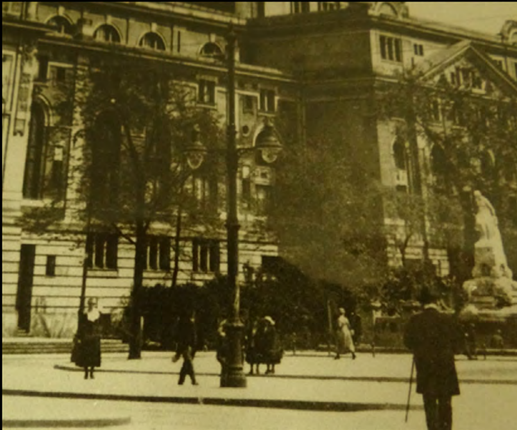
Oben: Szene Ende der 1920er Jahre. Auffällig die beiden Gasansatzleuchten, die mit Auslegern an einem Straßenbahn-Fahrleitungsmast befestigt waren. Bild: Institut für Stadtgeschichte Frankfurt am Main.
