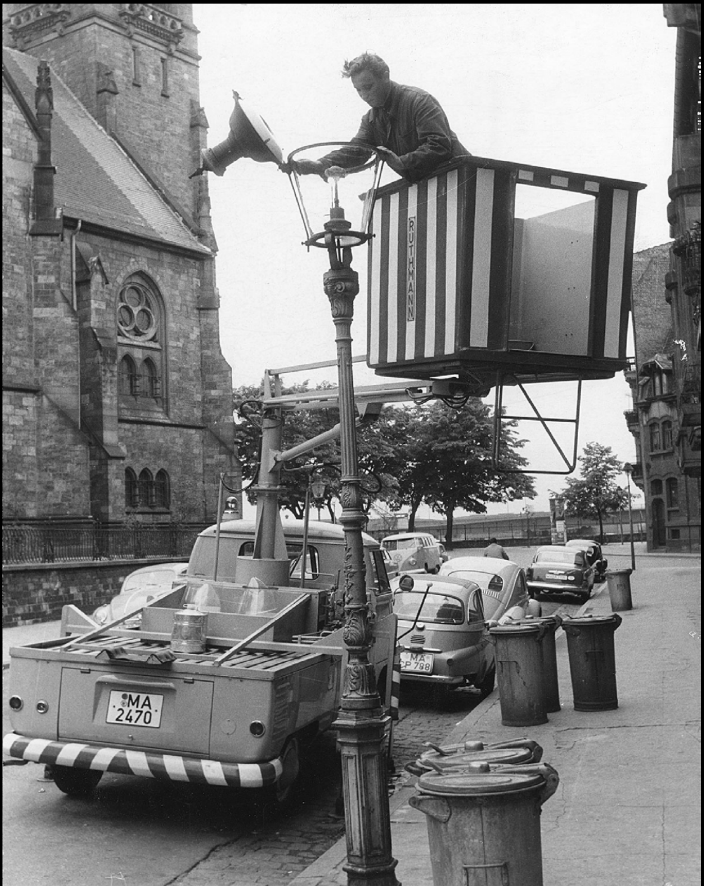
Die Lutherstraße etwa 1961/62. Ein Gaslaternenmonteur bei der Arbeit. Zu sehen ist das bekannte Rundmanteldach „Modell Mannheim“ von Vulkan, wie im 1. Teil beschrieben. Interessanterweise stehen hier Rundmantel und Aufsatzleuchten gemischt. Auf der Ladefläche liegen Auer-P40-Glocken, mit und ohne den Rhenag-Streifen. Hier in der Neckarstadt wurde schon sehr früh alles abgebaut. Bild: Archivum KF 025902
