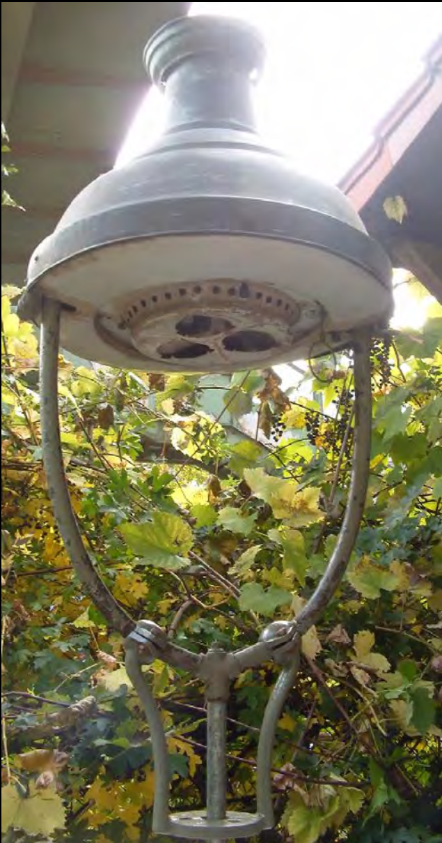
Bild links: Auch nach dem Krieg wieder im Einsatz. Das Große Modell Köln von GICS mit dreiflammigen Invert einbau. Leider fehlen noch Teile, u.a. Zugzylinder und GK Ring 665; rechts: Sondermodell der GICS-Aufsatzleuchte „Modell Wartburg“.
