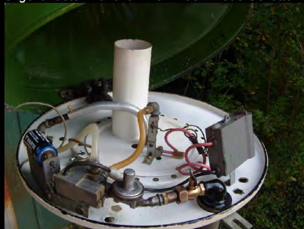
Auf druckwellenlosen Erdgasbetrieb umgestellte Vulkan G 87, mit elektronischem Dämmerungsschalter von Kalin Feinbau Frankfurt/M. Frühe Ausführung mit Funkenzündung und einer nur während des Zündvorgangs halbminütig brennenden Zündflamme. Man erkennt vorn den Motorschaltblock, links den Schaltkasten mit Batterie, rechts den Funkengenerator und in der Mitte die Düse der funkengezündeten Zündflamme. Bilder: Klaus Gevatter
