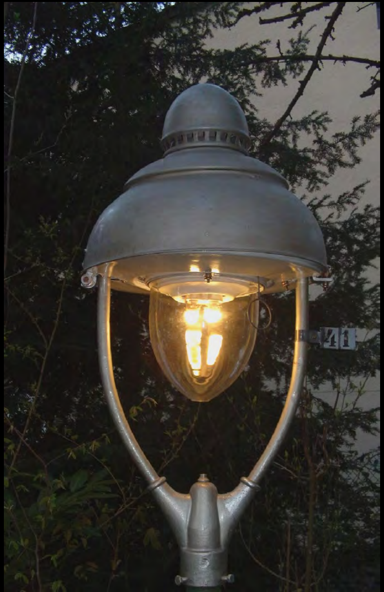
Bild links: Auch nach dem Krieg wieder im Einsatz. Das Große Modell Köln von GICS mit dreiflammigen Invert einbau. Leider fehlen noch Teile, u.a. Zugzylinder und GK Ring 665; rechts: Sondermodell der GICS-Aufsatzleuchte „Modell Wartburg“.
