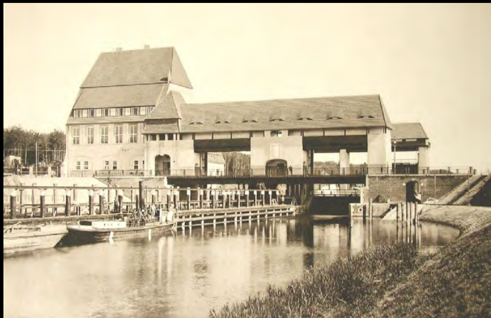
Die zwischen 1901 und 1906 errichtete Schleusenanlage Kleinmachnow. Der Höhenunterschied zwischen dem Wasserspiegel der mittleren Spree und der Potsdamer Havel wird dank dieser einzigen Schleuse des Teltowkanals überwunden. Bild Postkarte/unbekannt
