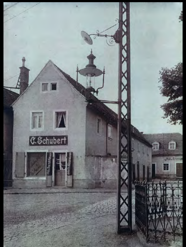
Freilicht-Gaslaternen der Firma Rech in Dresdner Vororten (um 1900). Links auf einem Blochmann-Kandelaber, rechts mit Halterung an einem Fahrleitungsmast der Straßenbahn montiert. Die Abschlüsse an den beiden Rohrstreben der Laternen sind unterschiedlich, links trompetenartig (wie beim heutigen Modell „Rastatt“), rechts pagodenförmig.
