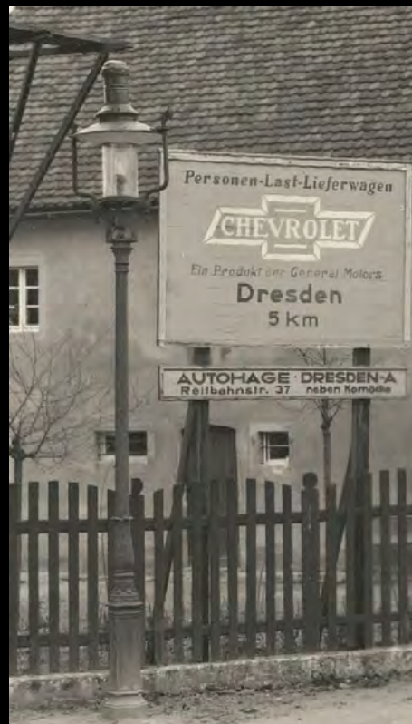
Freilicht-Gaslaternen der Firma Rech in Dresdner Vororten (um 1900). Links auf einem Blochmann-Kandelaber, rechts mit Halterung an einem Fahrleitungsmast der Straßenbahn montiert. Die Abschlüsse an den beiden Rohrstreben der Laternen sind unterschiedlich, links trompetenartig (wie beim heutigen Modell „Rastatt“), rechts pagodenförmig.
