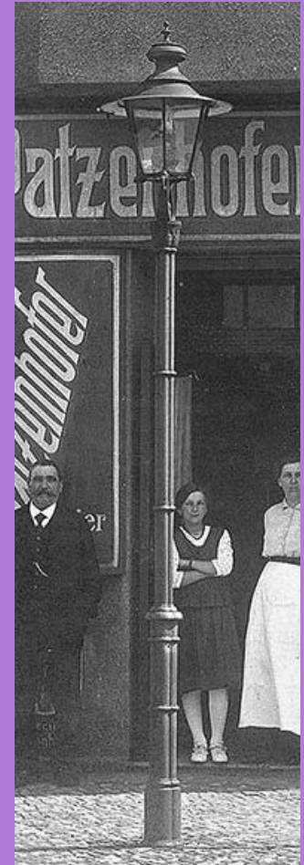
Groß-Lichterfelde: Die Bismarck-, Ecke Ulmenstraße und eine ungewöhnliche Gaslaterne auf einem Bündelpfeilmast. Die Gaslaterne ähnelt einer Laterne auf einem Bild aus Spandau (Bild rechts). Bildquelle (links) Archiv Wolfgang Holtz
