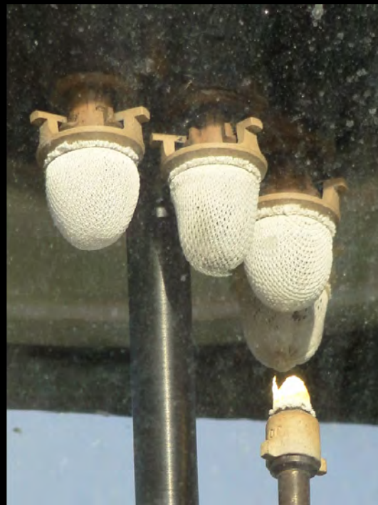
Private Gaslaterne in Dresden-Zschachwitz (Bilder von 2015). Dabei wurde ein originaler halbrunder, vierflammiger Brenner eingebaut. Bilder: Joachim Raetzer
