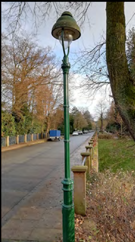
Bündelpfeilmast mit Leuchte „Bamag U7“. Bild: Bertram Hock.
