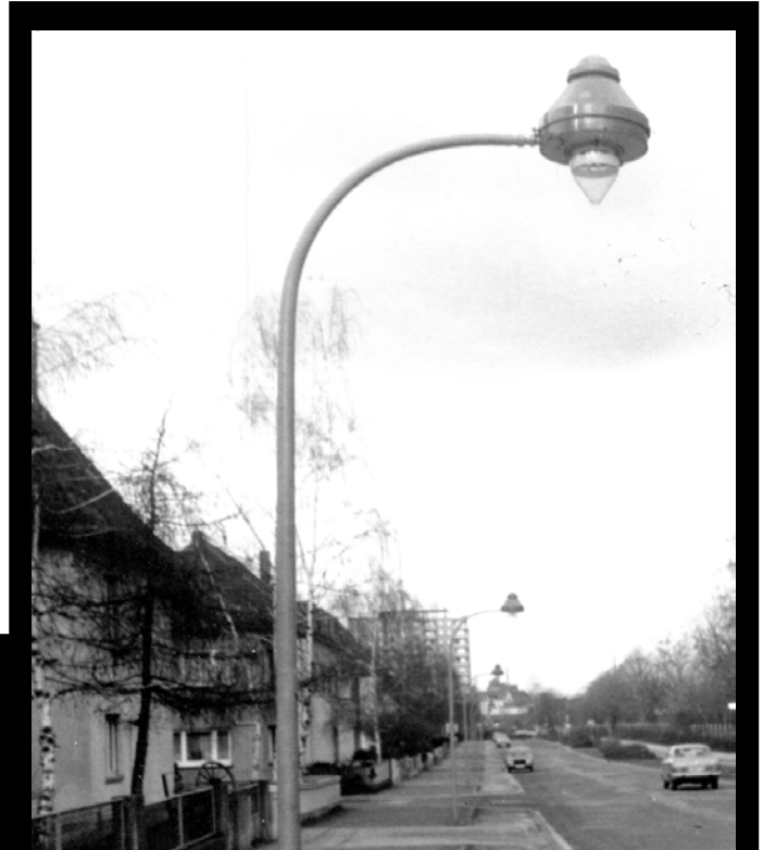
In vielen Städten verbreitet, doch in Mannheim selten: Oben: Ansatzleuchte von Vulkan, Am Herzogenriedpark. Unten: Gas-Pilzleuchte Modell Frankfurt mit Bamag-Zünder, Stephanienufer. Links: Bamag-Reihenleuchte U 13 B, die alte sogenannte Berliner Form.
