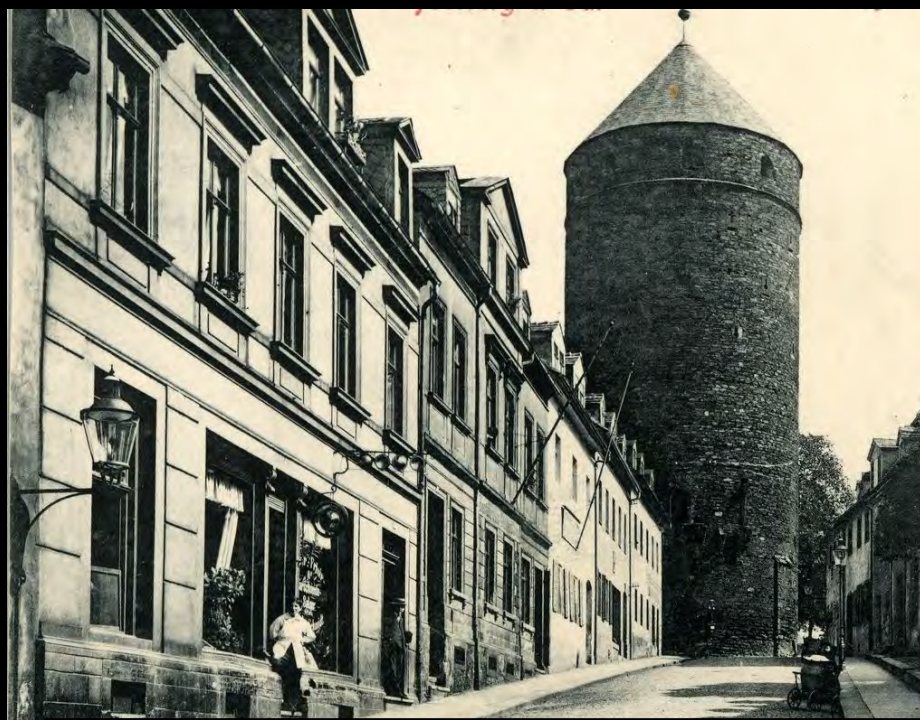
Gaslaterne an einfacher Wandbefestigung in der Donatsgasse mit Donatsturm (1913). Bild: Brück & Sohn Kunstverlag
