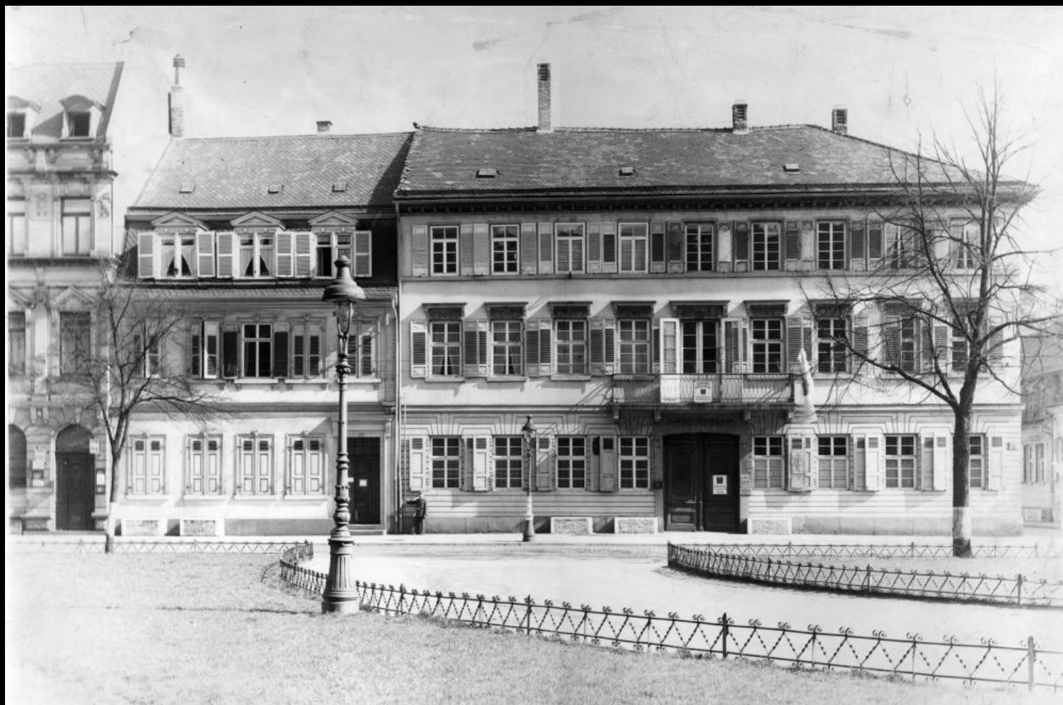
Aufsatzleuchten Modell Köln von Gebr. Schneider auf Gusskandelabern Mainzer Bauart.
