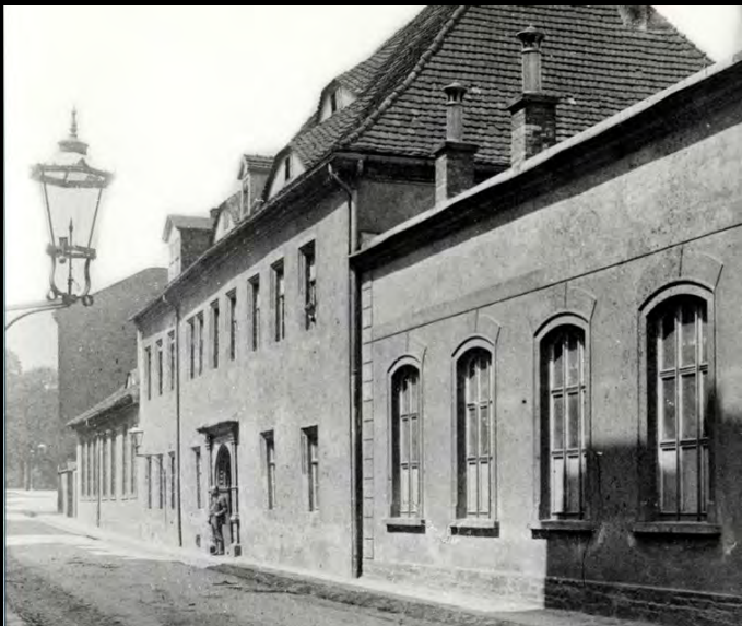
Eine sechseckige Gaslaterne mit Wandhalterung am alten Chemisches Institut der Bergakademie in der Brennhausgasse (um 1900).
