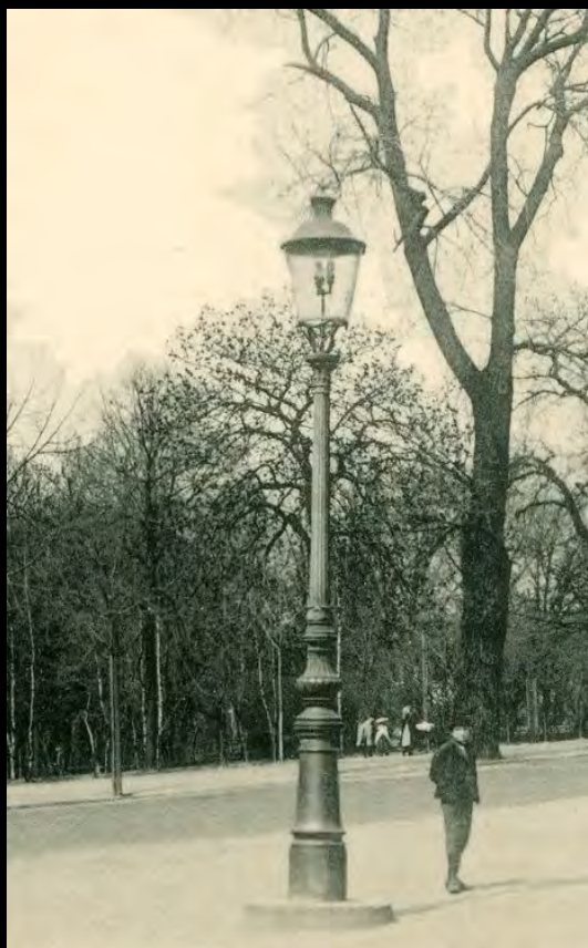
Rundmantellaterne mit zweiflammigem Stehlicht-Brenner auf Gusskandelaber (1903)
