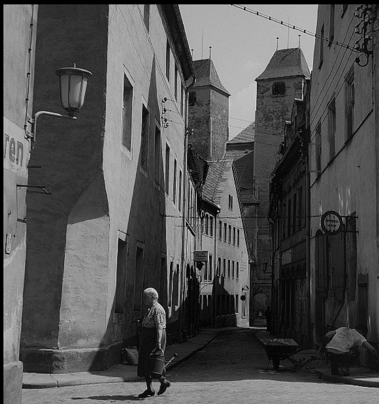
Die Enge Gasse: Elektrische Beleuchtung, montiert an Hauswänden und mittels Freileitung versorgt. Hinten links eine Wandhalterung ohne Gaslaterne (1964). Bild: Dt. Fotothek df Hauptkatalog 0002665
