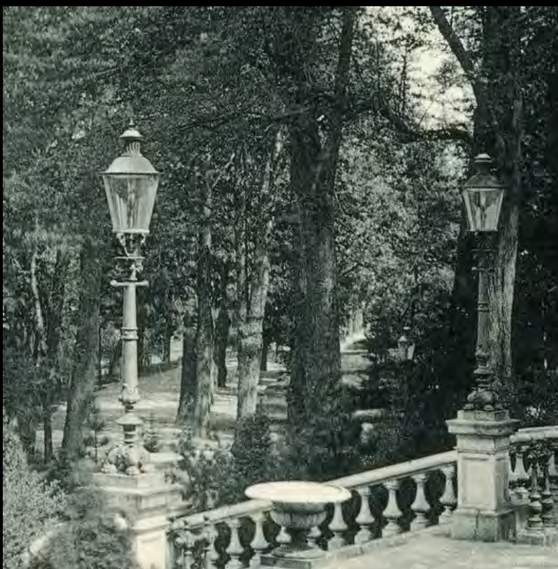
Rundmantellaternen auf gusseisernen Maueraufsätzen im Albertpark (1906). Bild: Brück & Sohn Kunstverlag
