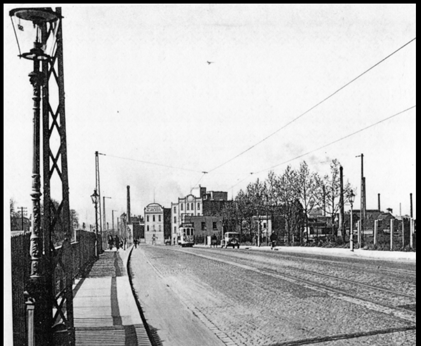
Rundmantellaternen mit Meteor-Zündern und Pilzbrennern. Luzenbergbuckel 1930er Jahre.
