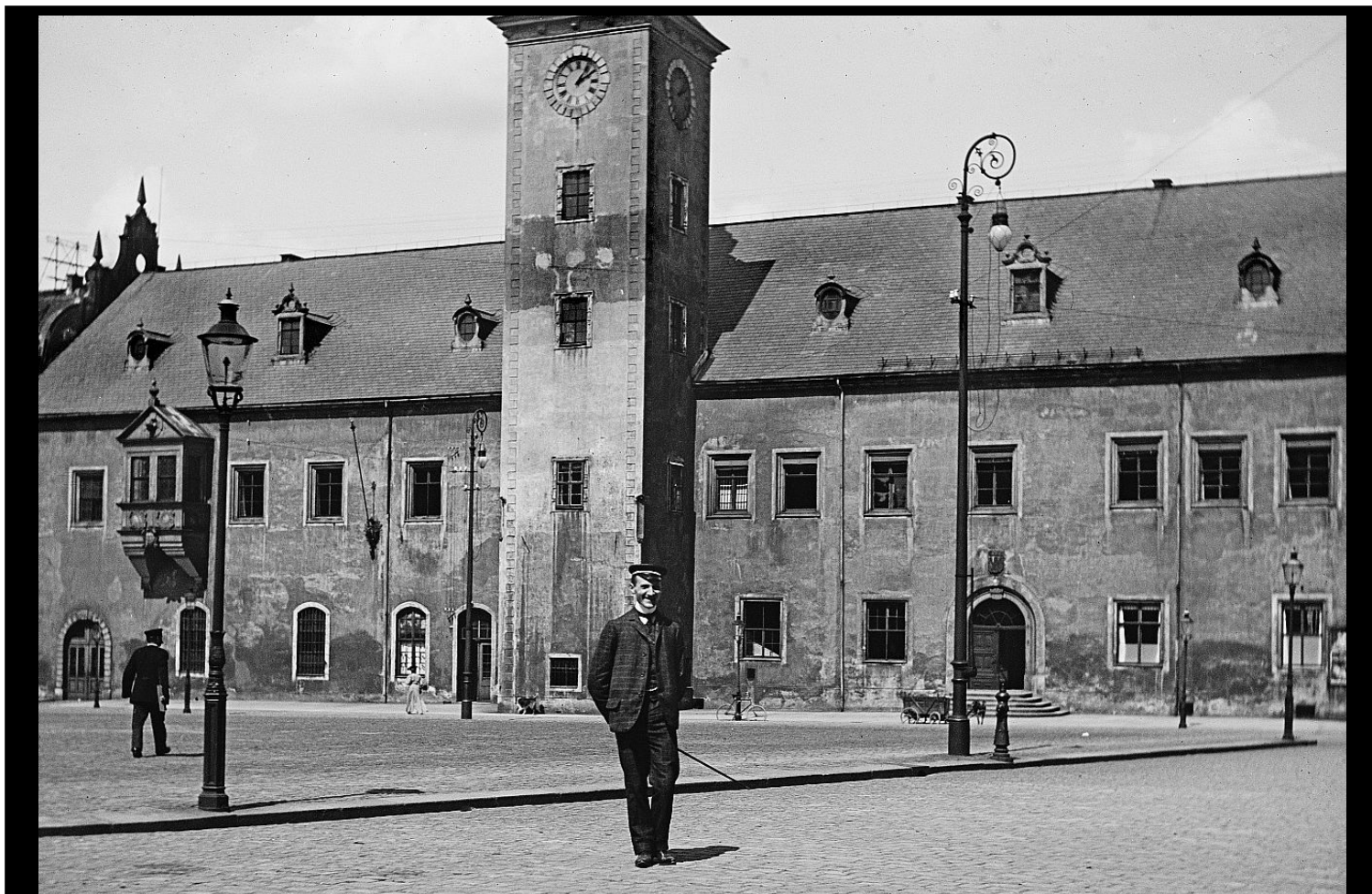
Gaslicht und elektrisches Bogenlicht (ca. 1910). Das Rathaus mit Obermarkt. Der Gaskandelaber entspricht dem Dresdner „Blochmann-Kandelaber“. Die Ritterlaterne mit Stehlicht und Fernzündler. Bild: Deutsche Fotothek df Hauptkatalog 0443826
