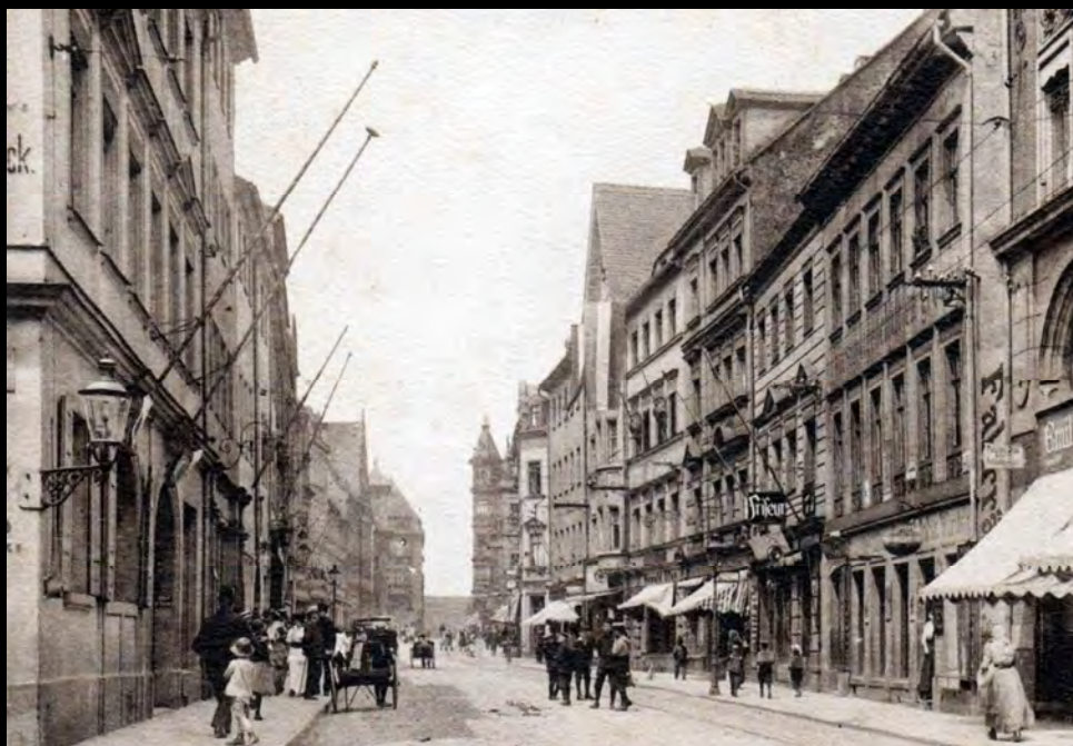
Die Erbische Straße um 1910. Gut zu erkennen die Ritterlaterne mit Wandkonsole, oben links der Wandhaken der Fahrleitung. Die Straßenbahnschienen sind etwas verschwommen. Bild: Sammlung Thorsten Adler
