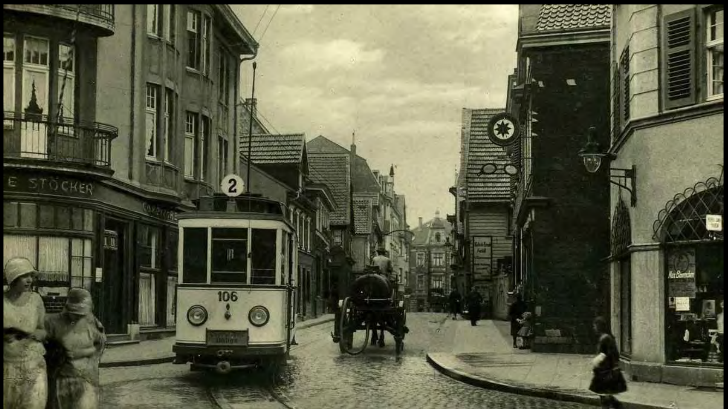
Rechts ein frühes Gasansatzleuchten-Modell – Hersteller vermutlich Fa. Rech – an einer Wandhalterung mit waagerechten Tragrohren. Bildquelle unbekannt
