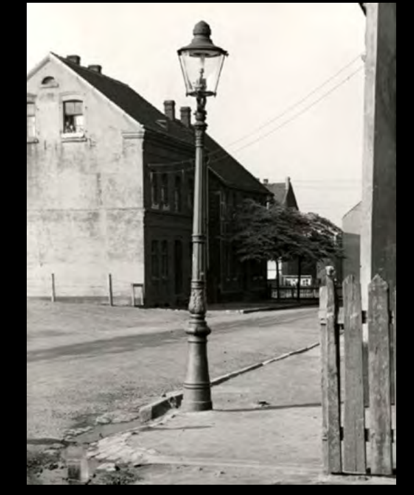
Oben: Gashänge-Invertleuchte an Mastverlängerung in der Kaiserstraße (um 1915). Unten: Rundmantellaterne auf einem Kieserling-Kandelaber. Standort unbekannt.
