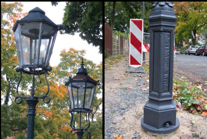
Seit vielen Jahren verschwinden Gaslaternen und werden durch Elektrolaternen im historisierenden Stil ersetzt (Bild links). Schon lange werden originale Dresdner Gaskandelaber elektrifiziert, indem man Revisionsklappen hineinschneidet.
