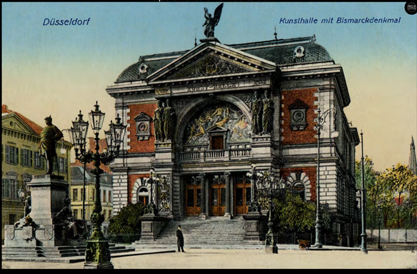
Oben: Am Ratinger Tor sind 1905 Frankfurter Gusskandelaber zu sehen, nun bestückt mit dem heute bekannten Modell „Alt-Düsseldorf“ und stehendem Gasglühlicht mit Handbetrieb. Unten: Um 1910 stehen prächtige mehrarmige Gaskandelaber mit den „Alt-Düsseldorfer“ Laternen vor der Kunsthalle und dem Bismarckdenkmal. Bildquellen: unbekannt/Ansichtskarten
