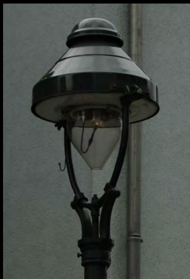
Gaslaternen auf Stühlen-Kandelabern tragen heute fast ausschließlich das Düsseldorfer Standard-Dach.
