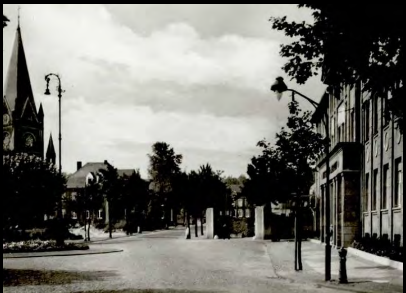
Ansatzleuchte „Bamag U12“ an einem abgesägten Hamburger Gashängelichtmast am Hauptbahnhof (1950er Jahre). Bildquelle unbek.
