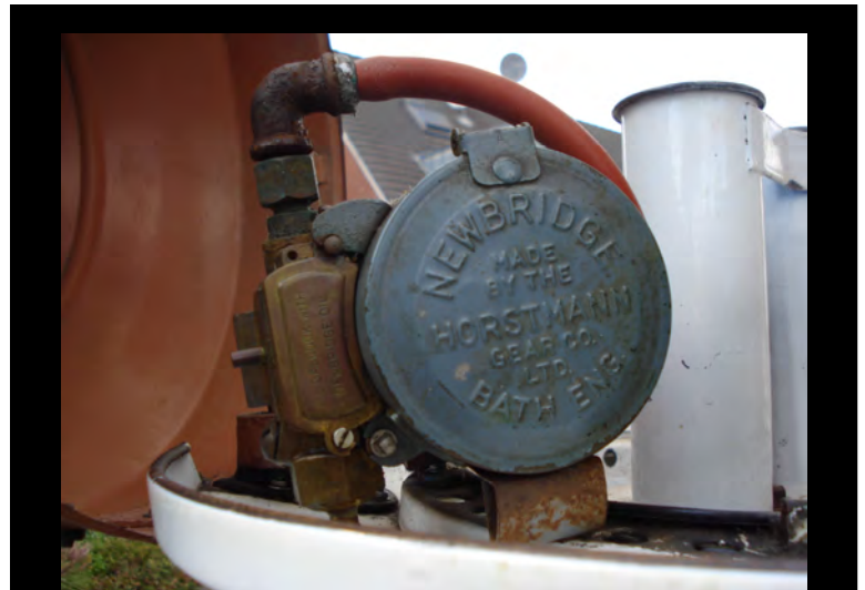
Die Horstmann-Schaltuhr von außen und innen. Die Innenseite des Gehäusedeckels mit Fabrikationszettel der Firma Horstmann. Hier fehlt leider nach den handschriftlichen Eintragungen ein eingestempeltes Fabrikationsdatum. Bilder: Rolf Hölterhoff
