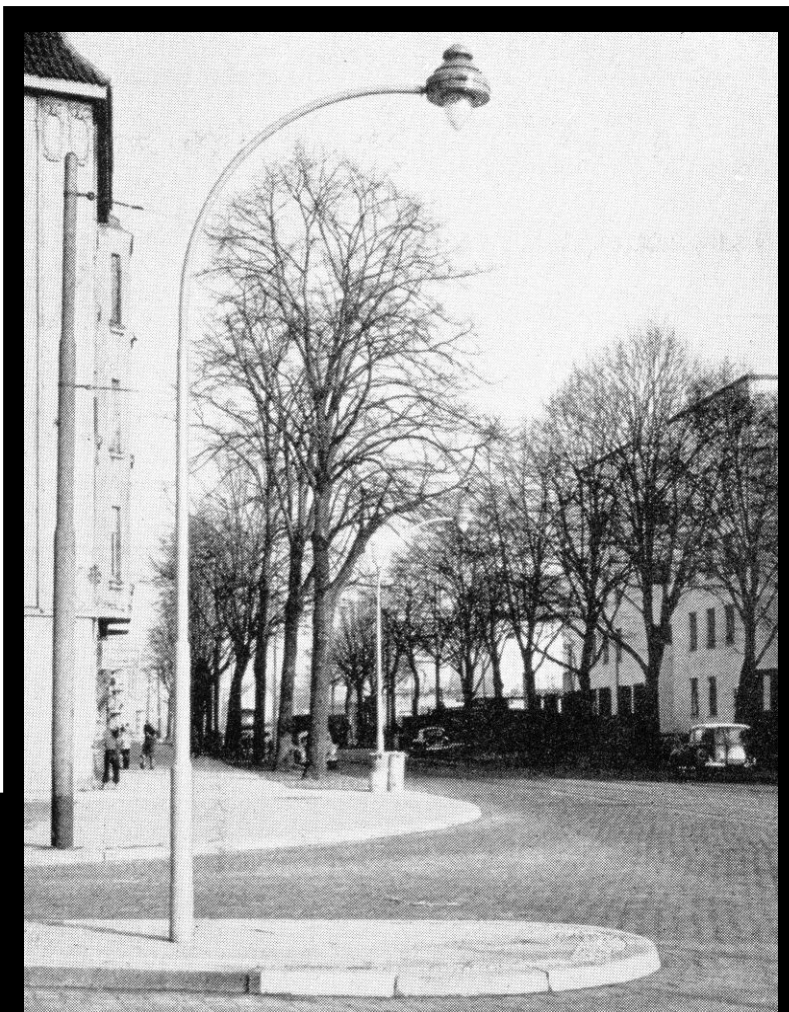
Gasansatzleuchte „Modell Dresden“ von Rech – mit Blohmglocke – an einem klassischen Auslegermast (1953). Dieser Mast war eine Entwicklung der Gasbeleuchtungsindustrie. Bildquelle: Slg. Klaus Gevatter
