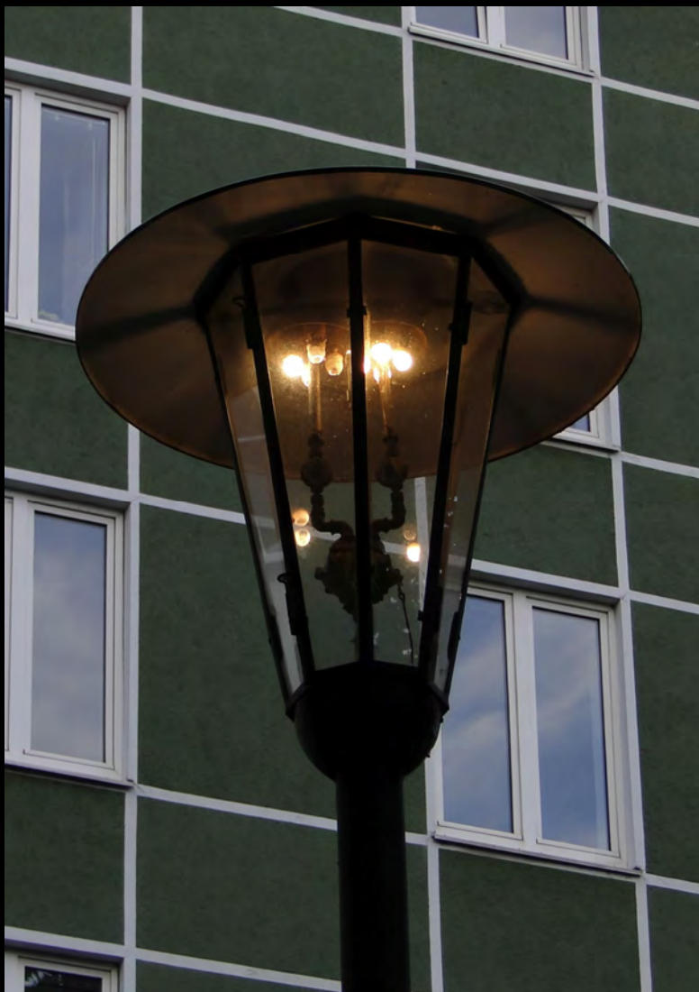
Pilz-Gasleuchte mit zwei 4-flammigen Brennern. Bild: Joachim Raetzer
