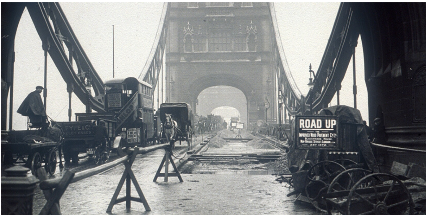
Bild: Bauarbeiten auf der Brücke, Gashängeleuchten (von Sugg) sind zu erkennen. Bild: unbekannt
