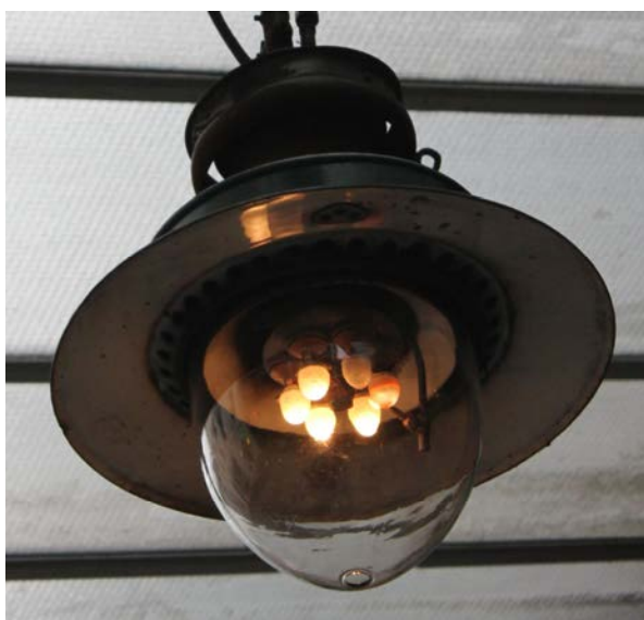
Oben: Gashängeleuchte von Sugg, Bild: Oliver Frühschütz; unten: die heutige Beleuchtung der Tower Bridge ist elektrisch, die Farbe der Kandelaber gewöhnungsbedürftig. Bild: unbekannt. Rechts nächtliche Anstrahlung. Bild: Deliffe
