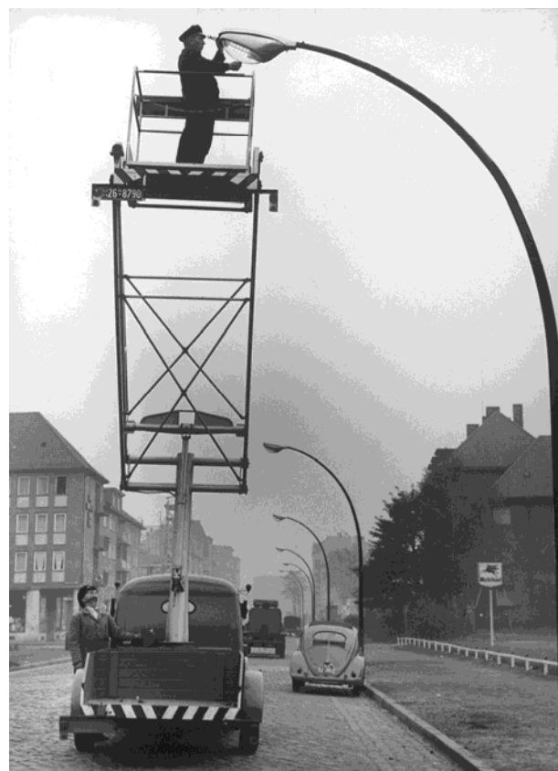
Oben: Für die Wartung der Reihenleuchten an bis zu 7,5 Meter hohen Masten wurden Turmwagen erstmals unverzichtbar. Unten: Gaslaternen trotz der Überschwemmung bei der schweren Sturmflutkatastrophe vom Februar 1962.
