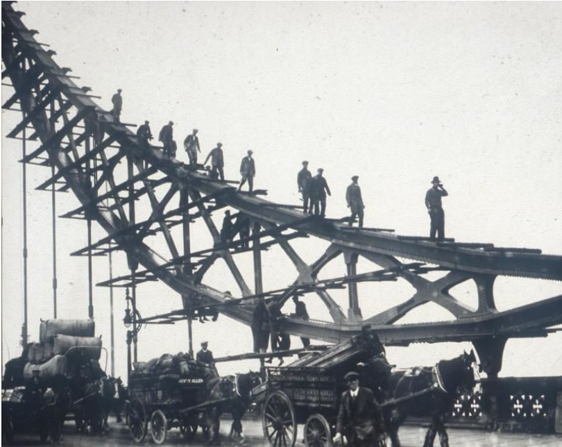
Arbeiter auf der Tower Bridge während des Baus.
