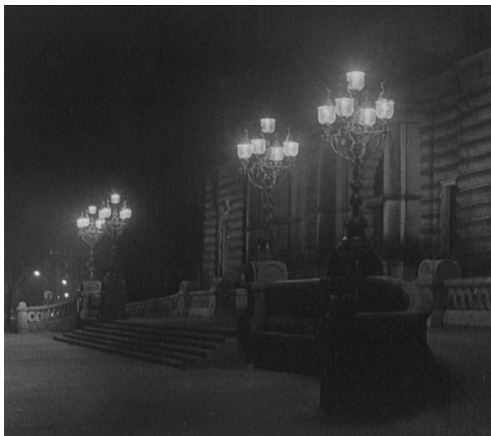
Links: Dovenfleet 1883 mit früher Ausführung der Sechsscheibenlaterne. Hier noch ohne Gasglühlicht und ohne Fernzündler. Rechts mehrarmige Gaskandelaber auf dem Sievekingplatz mit Glasmantellaternen.
