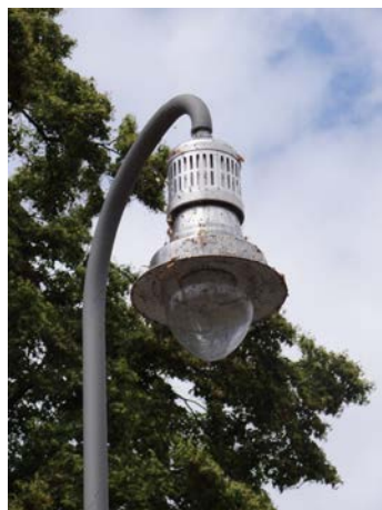
Oben: Elektrische Laternen im „Gasleuchten-Look“. Teils erst kürzlich aufgestellt, sind sie schon stark verdreht oder der Ausleger ist verbogen. Bilder: ProGaslicht e.V.
