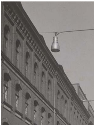
Gasleuchten mit Zeiss Oval-Spiegeln (um 1933) an Straßenüberspannungen
