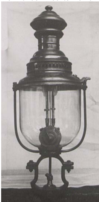
Die klassische Hamburger Glasmantellaterne, bei Vulkan anfangs geführt als Modell Nr. 17 u. 18, wurde mit geänderter Entlüftungshaube auch an Bremen und andere Städte geliefert. Nach der Modernisierung mit Fernzündler und Pilzbrenner (li.) durchlief ihr Innenleben mehrere experimentelle Entwicklungsschritte: In der Mitte mit Zeiss-Ovalspiegel 1933, rechts mit Blohmglocke (nach 1935), s. a. Reportage über Glasglocken in den Zündfunken Nr. 42-44. Letztere vermochten sich jedoch nicht durchzusetzen.
