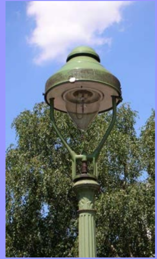
Von links nach rechts: Rech-Modell „Modern“ mit konkavem Reflektor, Modell „Modern“ auf Stahlmast vor Gründerzeitfassaden in der Weberstraße; Rech-Modell „Neulicht 52“ mit Flansch Lyra
