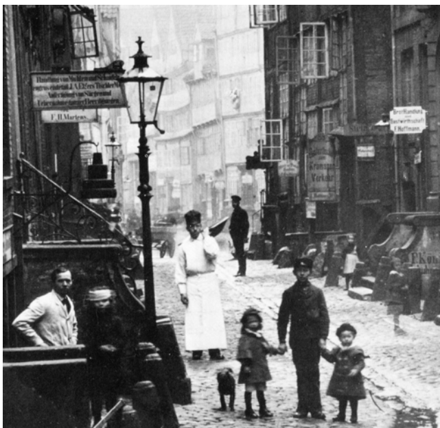
Links: Dovenfleet 1883 mit früher Ausführung der Sechsscheibenlaterne. Hier noch ohne Gasglühlicht und ohne Fernzündler. Rechts mehrarmige Gaskandelaber auf dem Sievekingplatz mit Glasmantellaternen.
