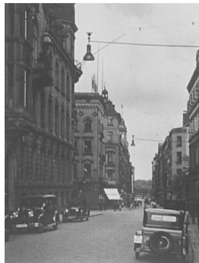
Gasleuchten mit Zeiss Oval-Spiegeln (um 1933) an Straßenüberspannungen
