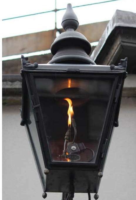
Oben: Brücken-Gaslaterne der ersten Generation im Museum der Tower Bridge, Bild: unbekannt; unten vierseitige Gaslaterne der Fa. Sugg mit offenen Flammen. Einige dieser Laternen werden heute aus historischen Gründen in London so betrieben. Bild: Oliver Frühschütz
