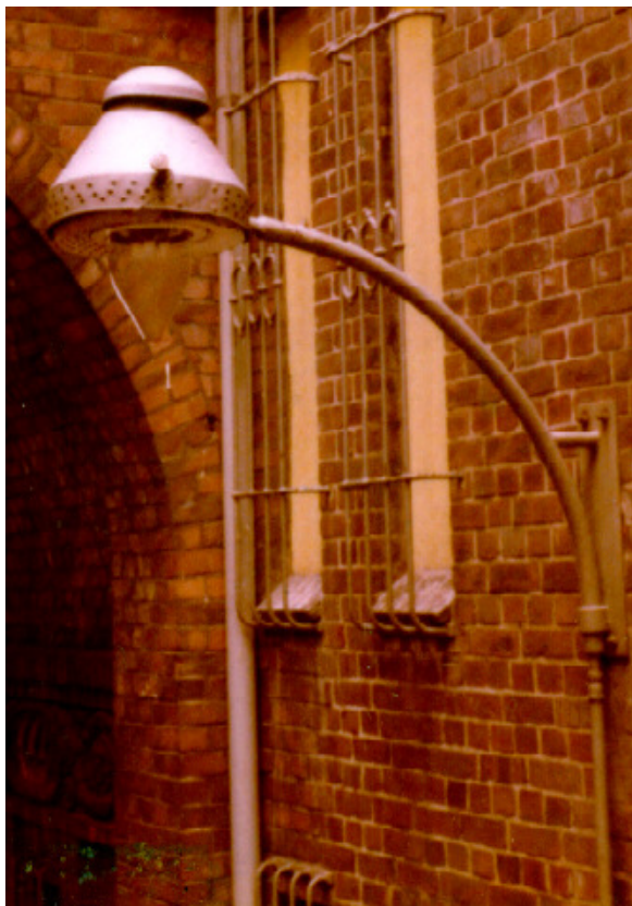
Einige Exemplare der Gasansatzleuchten (großes Bild oben sowie links oben Bamag U 11) blieben bis ganz zuletzt in Betrieb. So auch links unten das Schwestermodell U 12 am Michaelisstieg um 1980. Erkennbar die wegen des Kalin-Dämmerungsschalters bei der Umstellung vorgenommenen Bohrlöcher. Bild links: K. Gevatter; unten Ansatzleuchten U11 und U12 in einem Bamag-Prospekt
