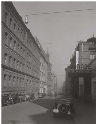
Gasleuchten mit Zeiss Oval-Spiegeln (um 1933) an Straßenüberspannungen
