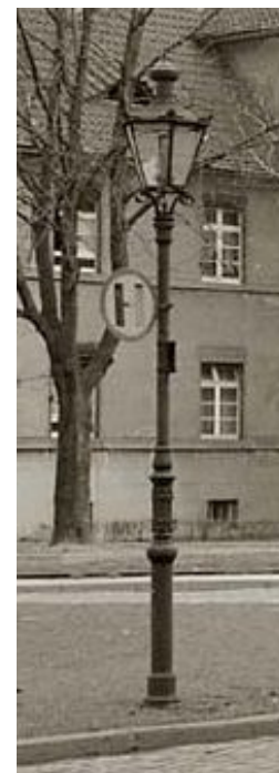
Oben: Bonn-Graurheindorf (1955). Schneider Modell 444 (Alt-Bonn) auf einem Kandelaber mit „Stahlseele“, die Verzerrungen täuschen eine „Gussoptik“ vor.
