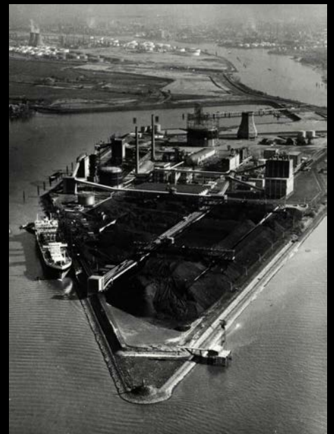
Die 1960 gebaute Kokerei Kattwyk in Hamburg-Wilhelmsburg wurde 1981 abgerissen
