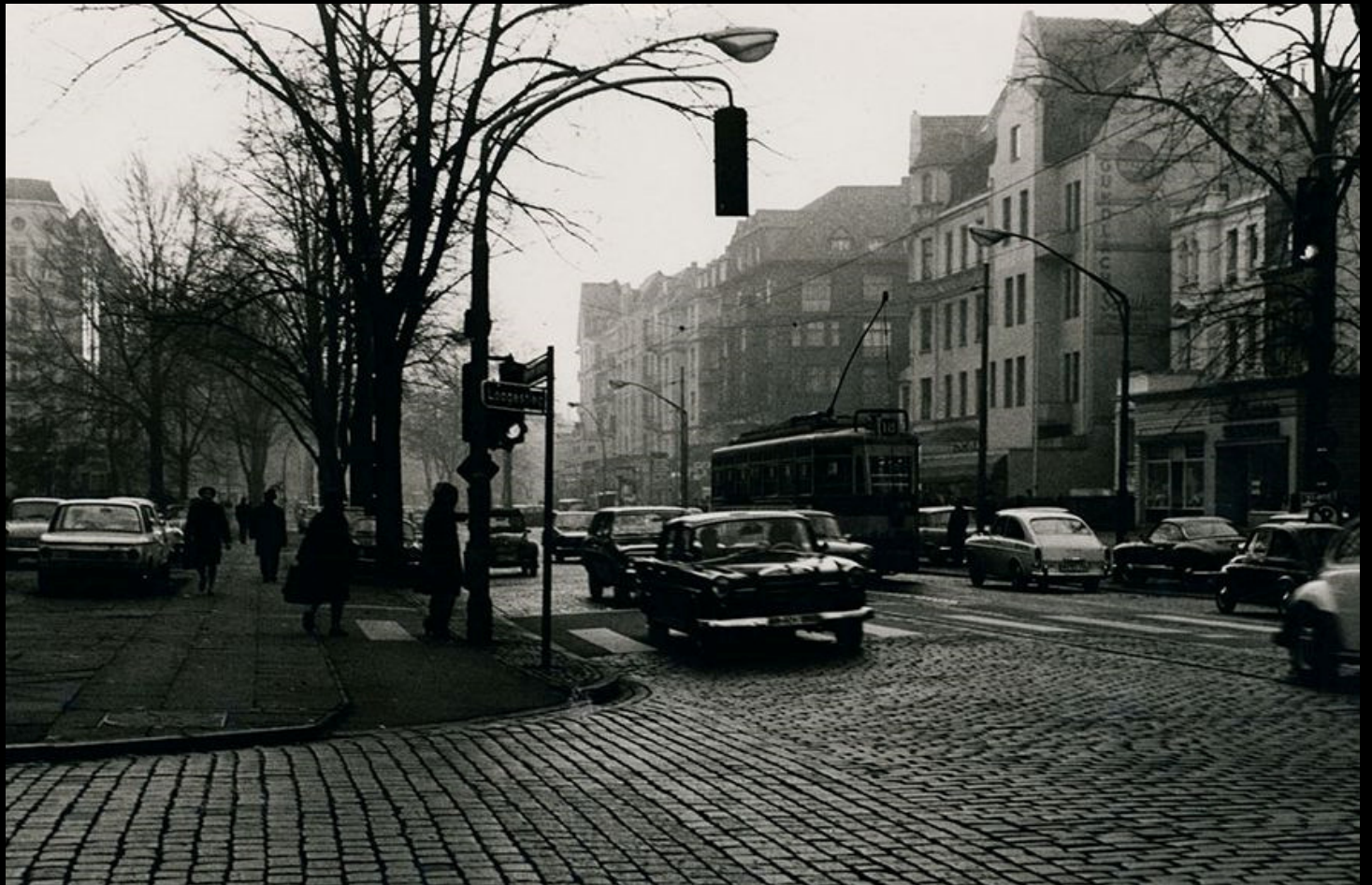
Hamburg-Eppendorf, Eppendorfer Landstraße: Gasmaste, die ursprünglich für Hängeleuchten konstruiert worden waren, wurden hier umgebaut und daran Gasreihenleuchten montiert (1960er Jahre). Bild: Heidi Pulley Boyes
