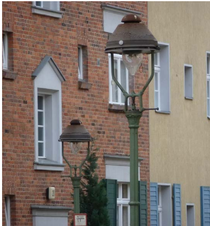
Überbleibsel aus DDR-Zeiten: Aufsatzleuchten von VEB Leistner in Berlin-Köpenick. Sie wurden vor einigen Jahren durch Bamag-U7-Gasleuchten ersetzt. Bild: Slg. PGL
