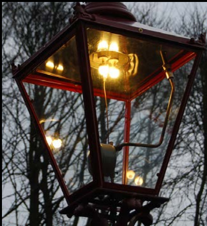
Londons Gaslaternen werden üblicherweise mit Horstmann-Zünduhren geschaltet. Bilder: PGL und Oliver Frühschütz
