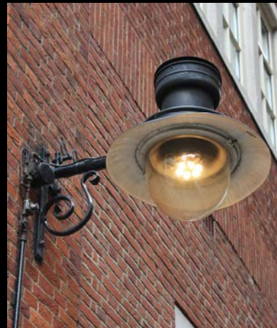
Londons Gaslaternen werden üblicherweise mit Horstmann-Zünduhren geschaltet. Bilder: PGL und Oliver Frühschütz
