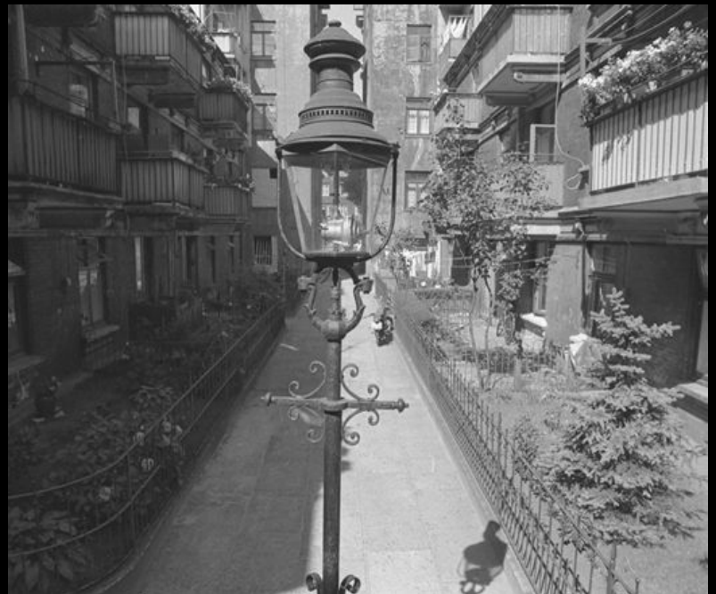
Oben: Eine Gasansatzleuchte, Typ „Bamag U11“ in der Afrikastraße; rechts eine Rundmantellaterne, die als sechsseitige Laterne umgebaut wurde (Eppendorf, 1960er Jahre).
