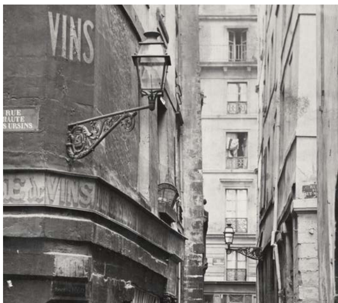
Gaslaternen in der Rue de Glatigny (zwischen 1853 und 1870), Bild: Charles Marville
