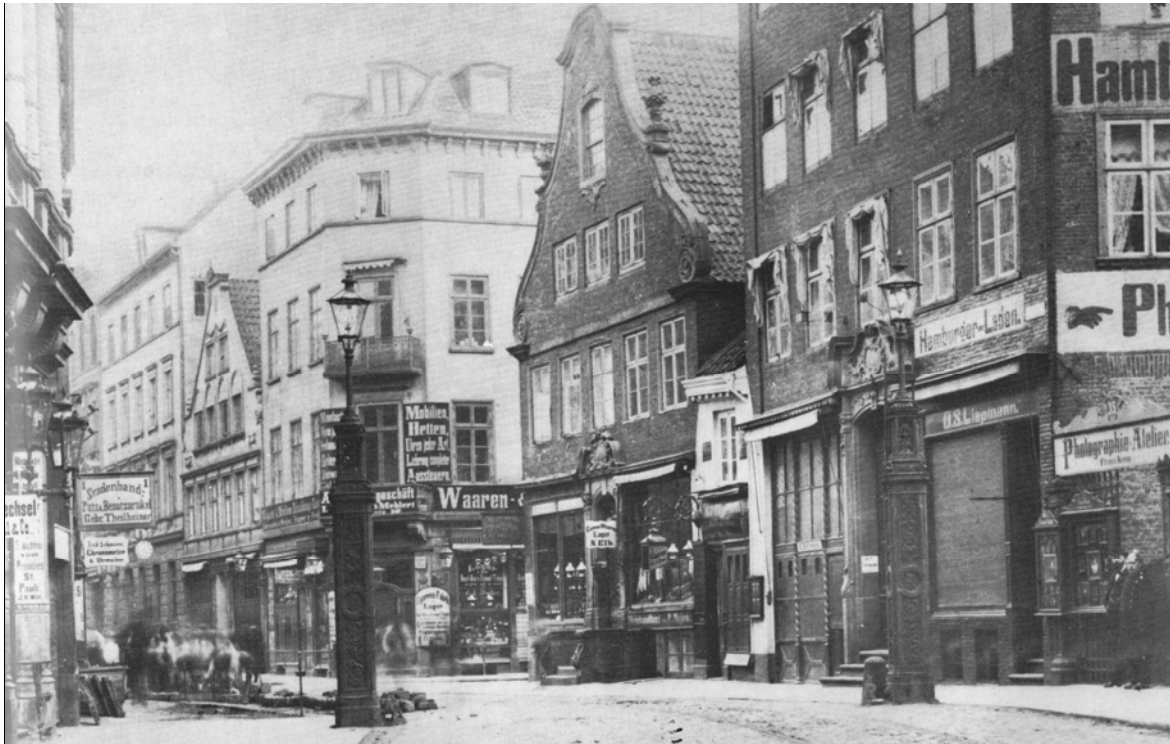
Das Nobistor (1880) ist ein ehemaliges Stadttor von Altona, die beiden gusseisernen Grenzpfosten wurden zwischen 1839 und 1848 aufgestellt und existieren bis heute. Die Gaslaternen wurden nach 1857 (Einführung der Gasbeleuchtung in Altona) montiert. Die heute dort installierten elektrischen Laternen spotten übrigens jeder Beschreibung.
