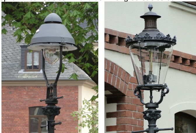
Typisch für Zwickau: Die Leistner-Gasaufsatzleuchten (links und unten), vor etwa 15 Jahren wurden neue Rundmantellaternen aufgestellt (oben rechts). Bilder: Sammlung ProGaslicht
