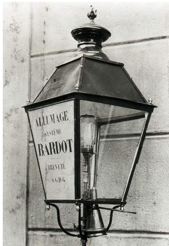
Oben: Französische Gaslaterne mit Auer-Brenner; unten verschiedene Laternen-Typen der Firma Himmel (Tübingen) mit einfachem oder mehrfachem Auerbrenner (Stehlicht)
