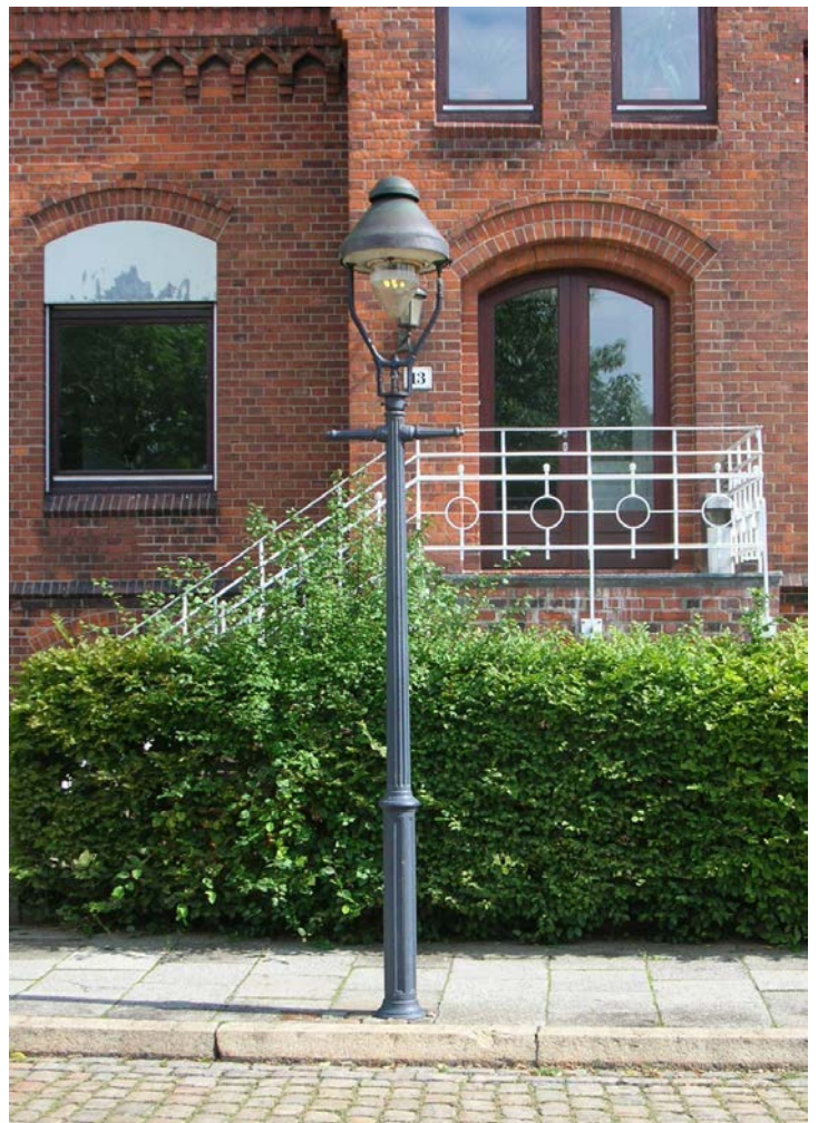
Gasauflatzleuchte mit Francke-Kandelaber auf dem ehemaligen Gaswerksgelände in Woltmershausen. Bild: Hans Stefan Eckhardt
