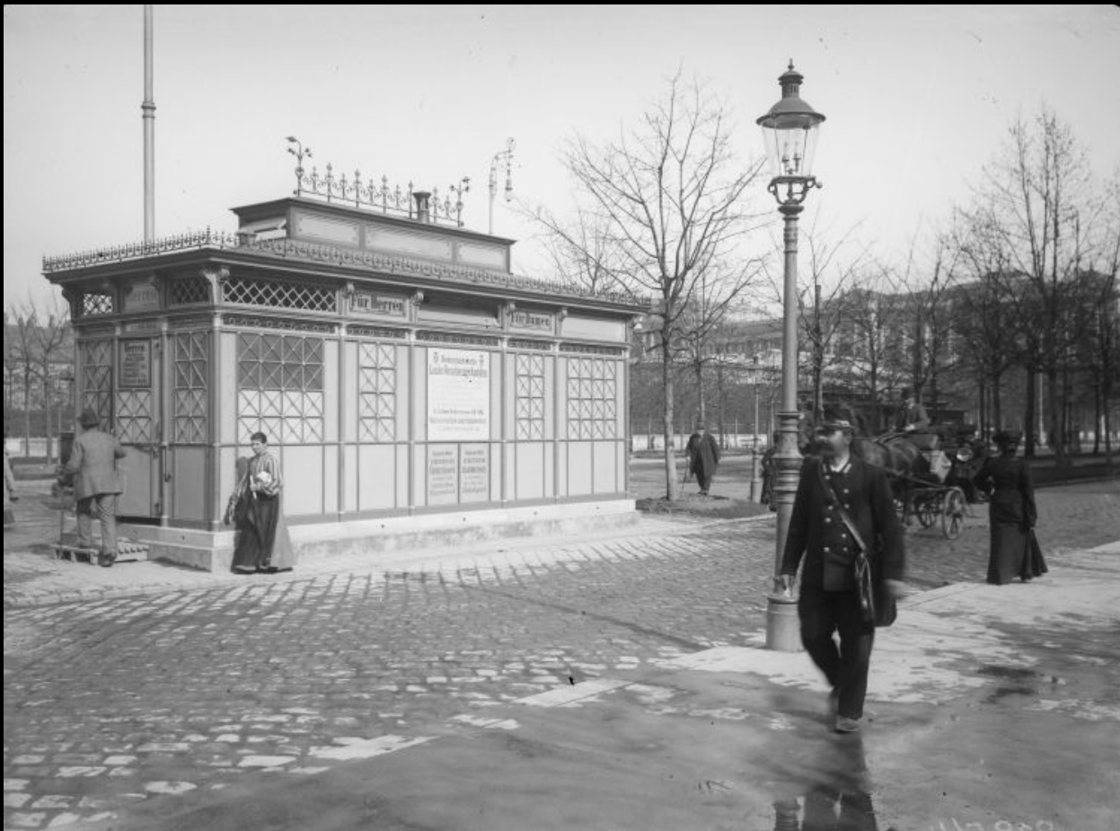
Gaslaterne der Stadt Wien mit zweifachem Auerbrenner und stehendem Glühlicht, im Hintergrund eine öffentliche Bedürfnisanstalt. Bildquelle: unbek./Slg. PGL
