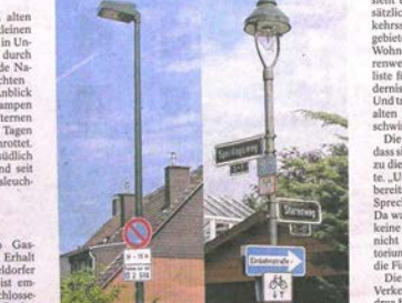
Nicht gerade ein schöner Anblick: Die neuen Elektrolampen (li.), die die Gaslaternen auf dem Starenweg ersetzen. Foto: Schafmeister
