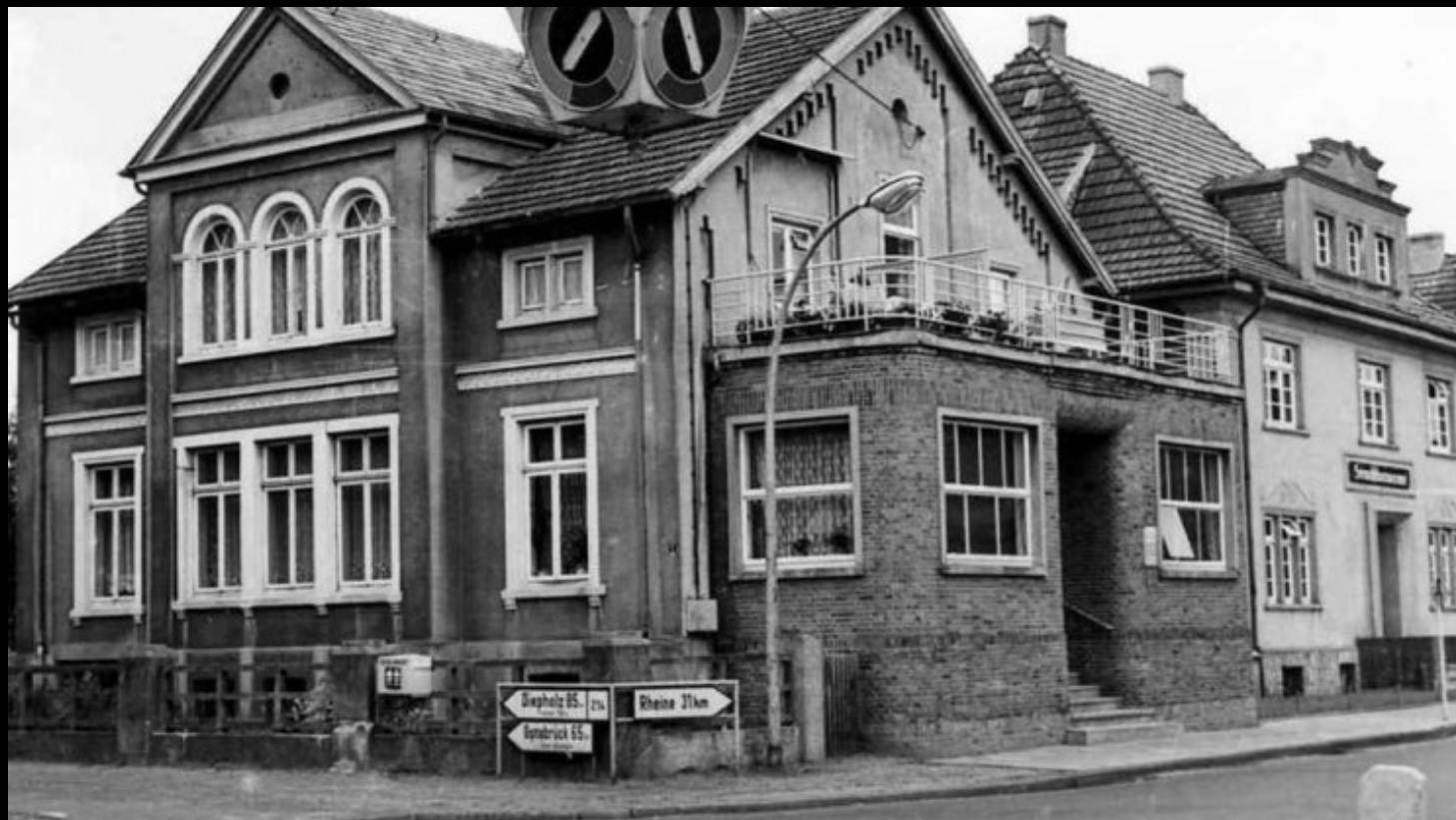
Eine Heuer-Ampel regelte den Verkehr auf der Kreuzung Georg- und Kaiserstraße in Lingen/Ems. In Bildmitte eine Gasreihenleuchte des Modells „Bamag U13H“. Die Heuer-Ampel verschwand 1963. Das Foto entstand Mitte der 1950er Jahre. Bild: Stadtarchiv Lingen
