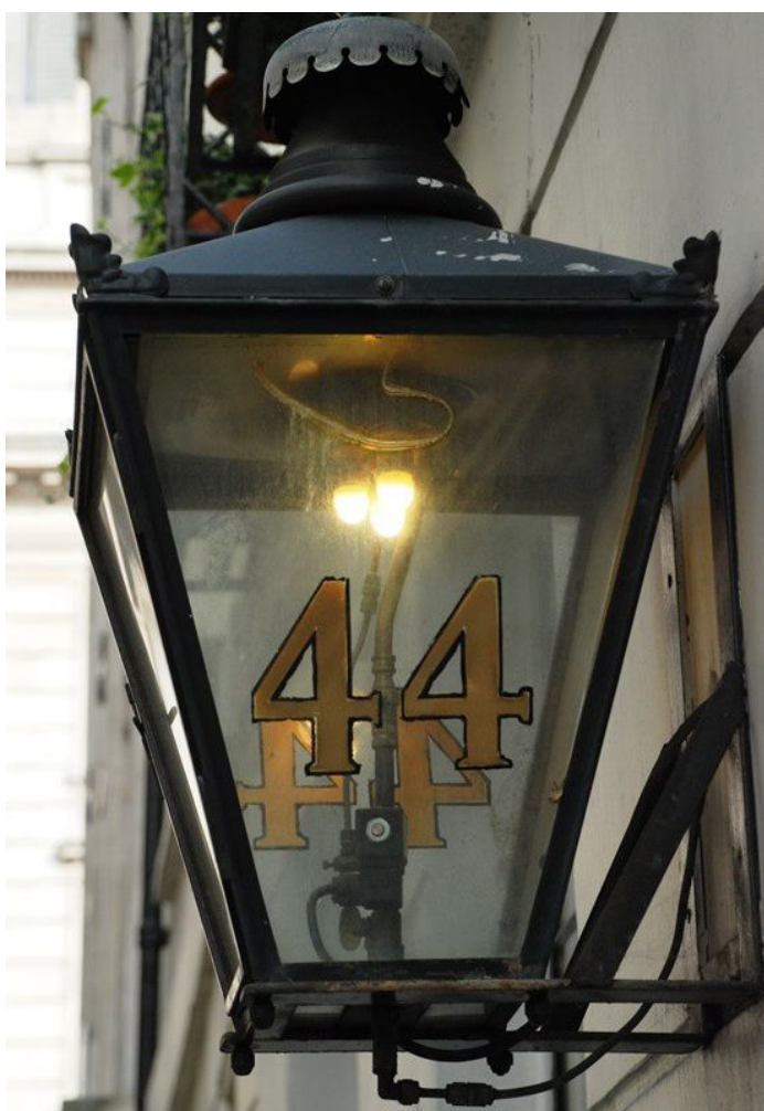
Links: Typische Vierseitige Gaslaterne englischer Bauart; rechts Rochester-Gasleuchte. Bilder: Slg. PGL und Markus Jurziczek
