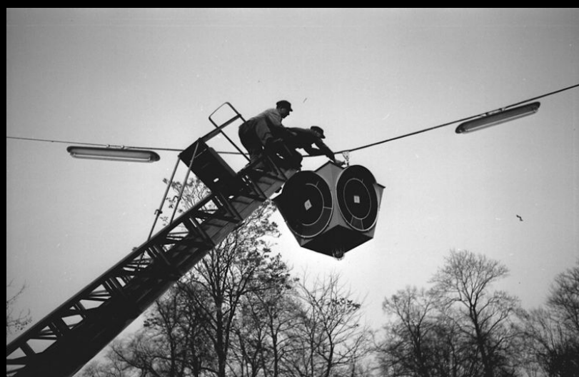
Montage einer Heuer-Ampel. Bild und Ort unbek./Slg. PGL
