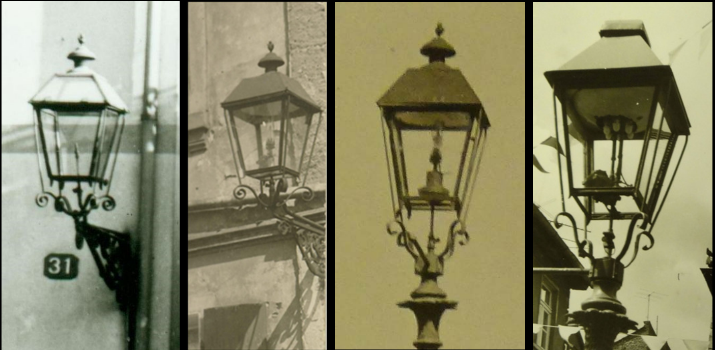
Die technische Entwicklung am Beispiel einer vierseitigen Biedermeier-Gasleuchte aus Frankfurt am Main. V.l.n.r.: Einfacher Brenner/Offene Flamme, die Laterne besitzt anfangs ein gläsernes Dach; Auer-Brenner mit Zugzylinder und stehendem Gasglühlicht; Auer-Brenner mit Zugzylinder, stehendem Gasglühlicht und Gasdruckfernzündung/Meteor; sechsflamiger Gruppenbrenner (hängendes Gasglühlicht) und Gasdruckfernzündung/Bamag. Bilder: Slg. PGL
