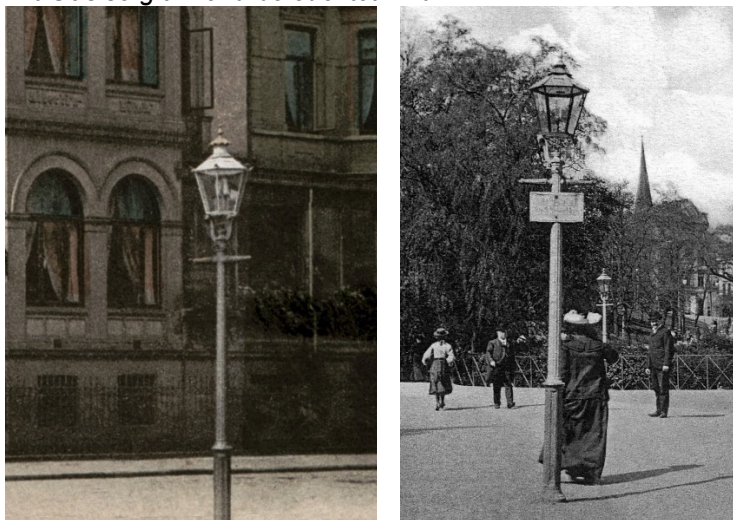
Sechseckige Gasleuchten auf Gusskandelabern der Bremer Firma Carl Francke waren typisch für die Hansestadt. Bilder: unbek./Sammlung ProGaslicht
