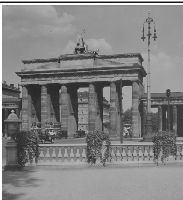
Besonders auffällig im Stadtbild Berlins waren Hochmaste für die elektrische Beleuchtung. Mal einfach gestaltete Stahlmaste, mal aufwändig verzierte Betonkandelaber. Links Hochmast mit elektrischen Leuchten auf dem Spittelmarkt (1931), Bild: Max Mossmann; rechts Betonkandelaber vor dem Brandenburger Tor (1930), Bilder: Rechts Deutsche Fotothek, 0195069_2
