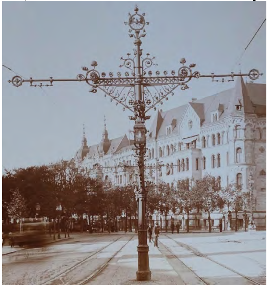
Fahrleitungsmast für die elektrische Straßenbahn (Entwurf von Franz Schwechten), daran waren jeweils zwei vierseitige Gaslaternen mit stehendem Gasglühlicht befestigt (Bildmitte). Die Laternen wurden nach 1918 abgebaut und an anderen Orten auf Sockel oder Kurzmasten montiert. Die aufwändig gestalteten Fahrleitungsmaste blieben bis in die 1930er Jahre. Bild: unbek./Slg. PGL
