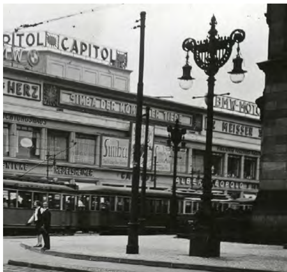
Schwechten-Gaskandelaber nach dem Umbau auf Pressgaslicht (1928), hier mit unterschiedlichen Gasleuchten. Bilder: Unbek./Slg. PGL
