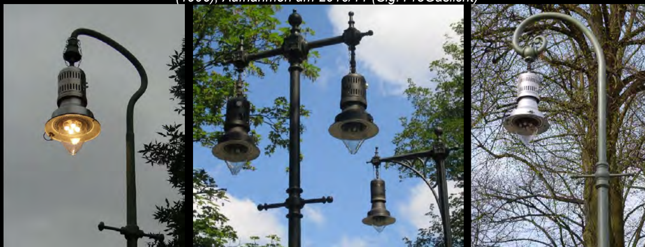
Von links: „Schwanenhals“-Mast (Entwurf 1926); „Doppelgalgen“ (1906); „Bischofsstab“ (1908), Aufnahmen 2012/14
