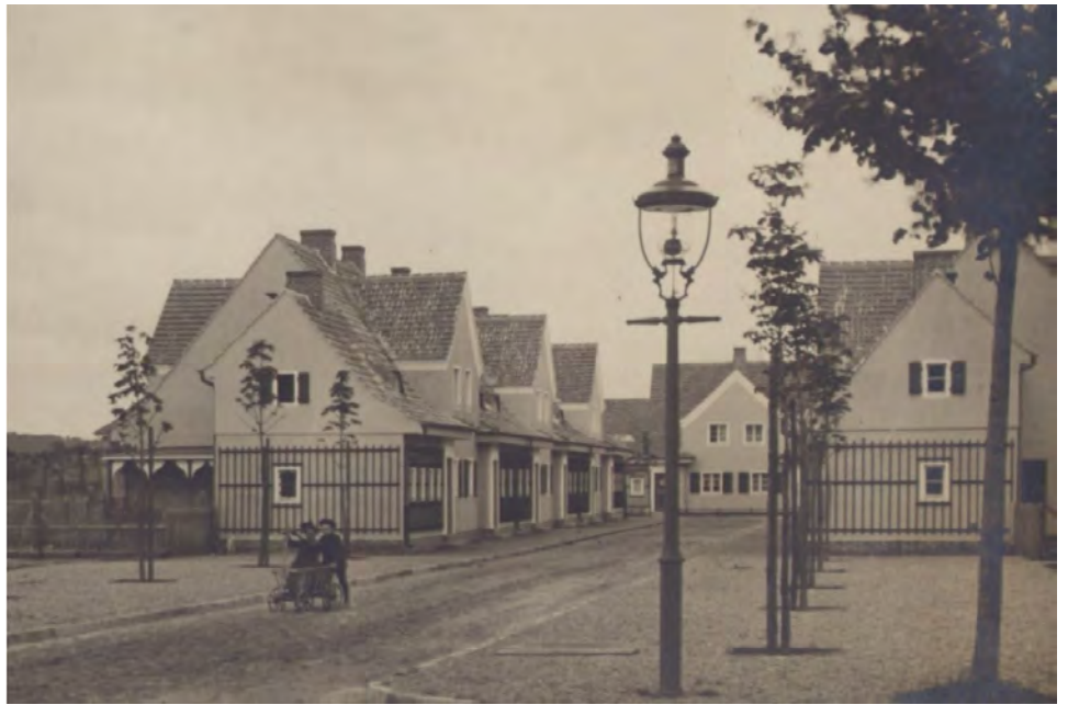
Von Gaslaternen wie hier in Tegel/Am Steinberg wollten sich die städtischen Gaswerke trennen. Die oben abgebildete Leuchte war von einem nicht bekannten Hersteller, der Kandelaber kam von Carl Franke aus Bremen. Bild: unbek./Slg. PGL
