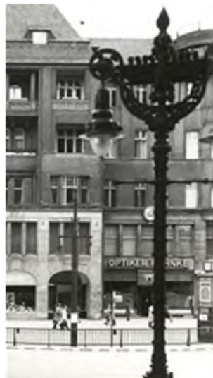
Schwechten-Gaskandelaber nach dem Umbau auf Pressgaslicht (1928), hier mit unterschiedlichen Gasleuchten. Bilder: Unbek./Slg. PGL
