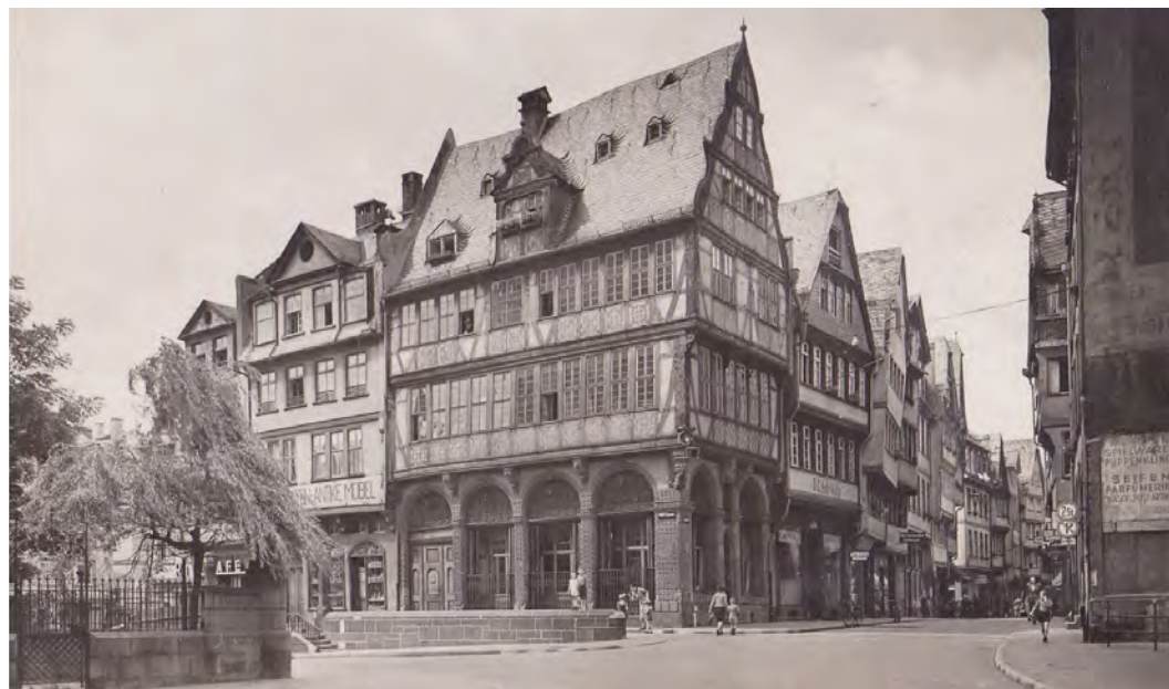
Das Haus „Zur Goldenen Waage“ im Jahr 1940. Es ging im Bombenhagel 1944 unter. Inzwischen ist es – hervorragend rekonstruiert – wieder da. Bild: Postkarte/Slg. PGL
