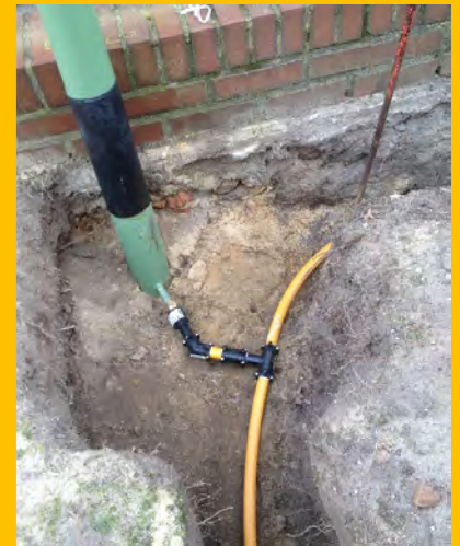
Links: Die Druckwellenschaltung im Detail; rechts vom Netzbetreiber angeschlossener Gaslichtmast. Bilder: Sammlung Nico Kiefer
