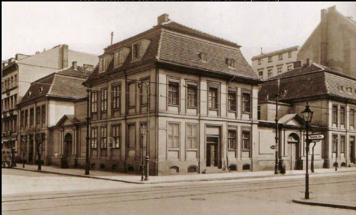
Die Umstellung steht bevor: Berliner Modelleuchten (rechts zweiflammliges Stehlicht) werden gegen Gashängeleuchten (siehe Bildmitte, Bischofsstabmast, vermutlich für Pressgas) ausgetauscht. Tauben-, Ecke Kanonierstraße (um 1913).
