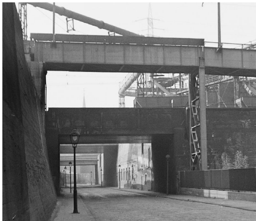
Die Laarer Straße in Duisburg. Heute ist hier eine Brache und anstelle der Gaslaternen stehen hässliche Elektroleuchten. Bildquelle: Meyerul
