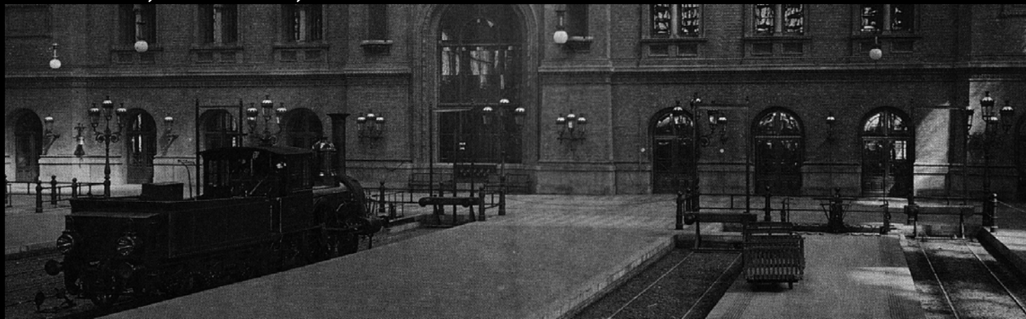
Gaskandelaber und Gaswandlaternen im Anhalter Bahnhof (um 1919)
