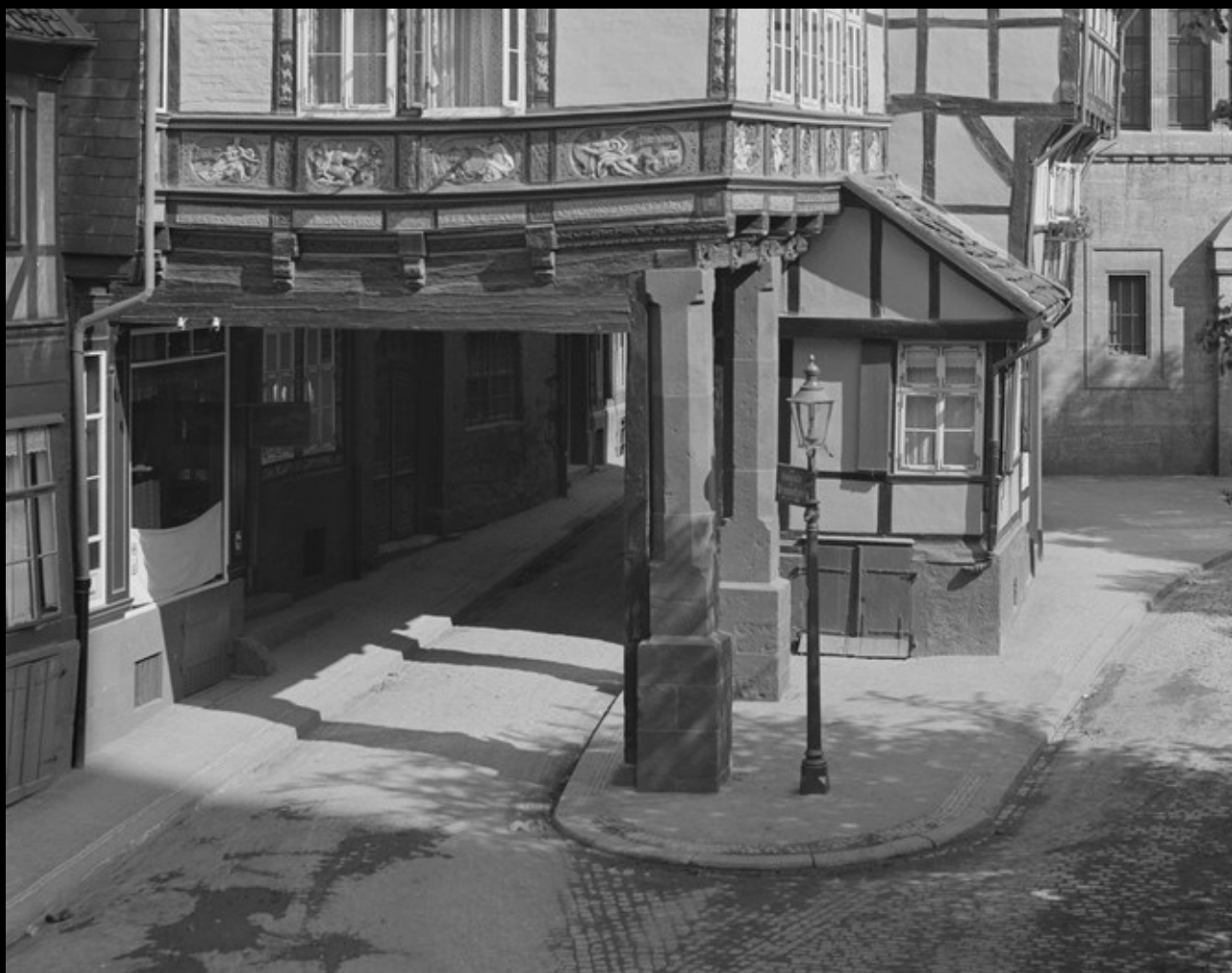
Pfeilerhaus mit Rundmantellaterne und Meteor-Fernzünder. Bild: Slg. PGL
