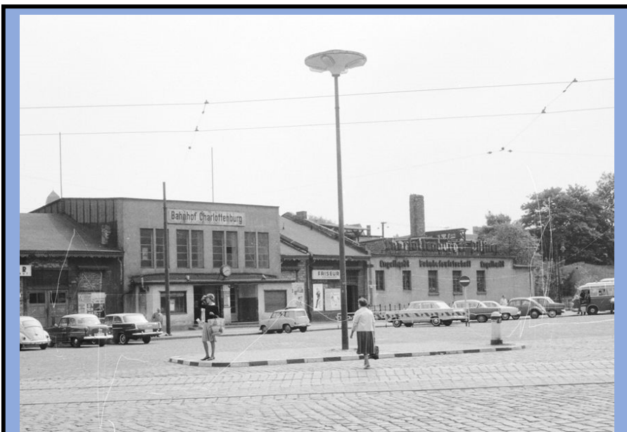
Auch die in den 1950er Jahren aufkommenden elektrischen Großflächenleuchten bekamen vonseiten der GASAG-Ingenieure eine Antwort. Hier eine große Pilzleuchte vor dem S-Bahnhof Charlottenburg, bestückt mit vier Gasreihenleuchten-Brennern. Bild: Slg. PGL
