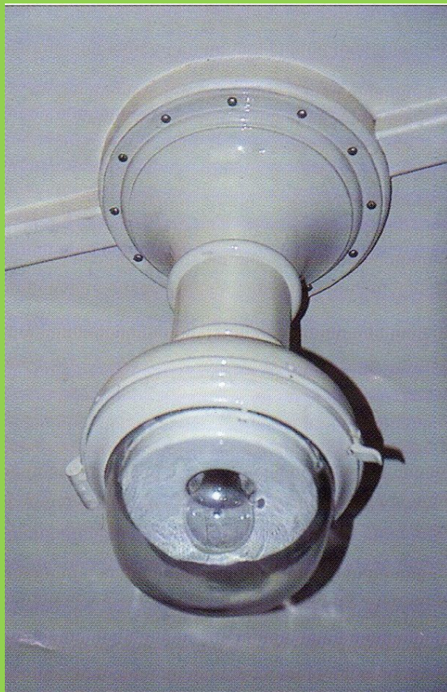
Oben: Ehemalige Gaslampe für Eisenbahnwagen, umgebaut auf Strom und mit Glühbirne bestückt.
