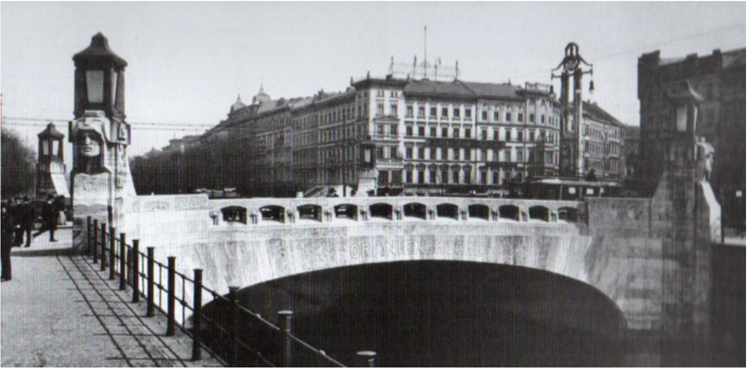
Eine der außergewöhnlichsten Brücken Berlins war die mit mächtigen Lichtständern und Sockeln mit Masken ausgestattete Oranienbrücke. Bilder: Waldemar Titzenthaler
