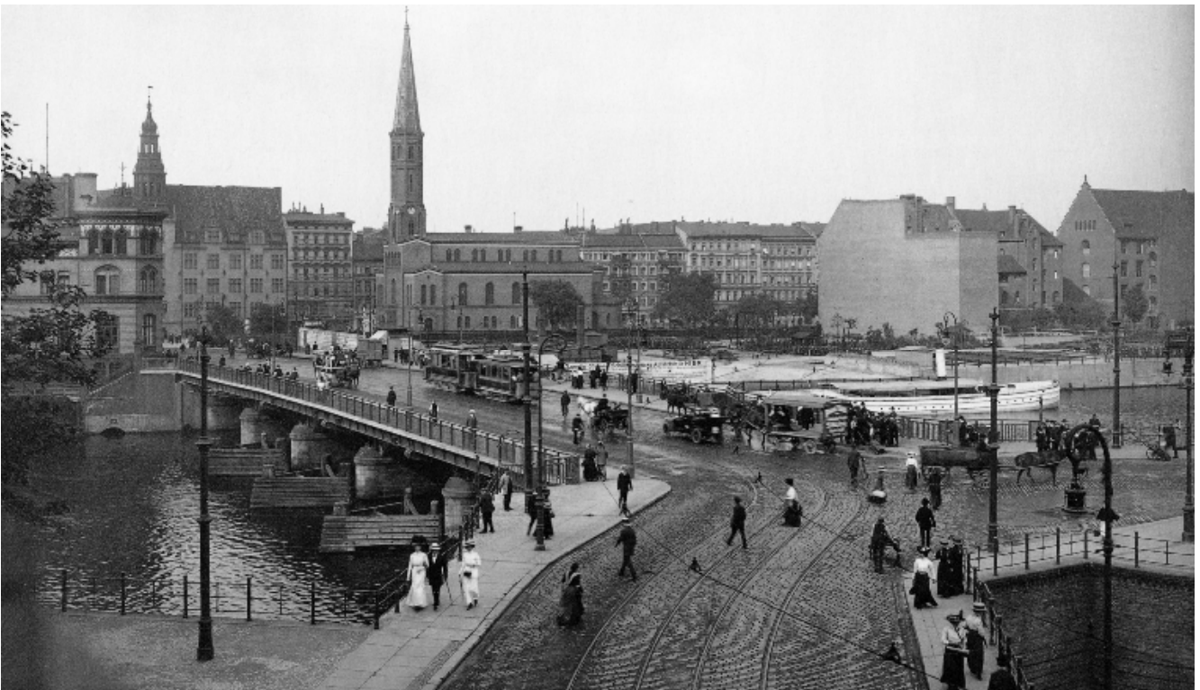
Auf der 1912 verbreiterte Schillingbrücke wurden Gashängeleuchten aufgestellt. Bild: Hermann Rückwardt
