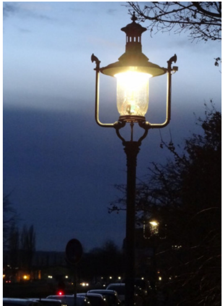
Das Gasleuchtenmodell „Rastatt“, eine Neubau-Gasleuchte der Firma Trapp, in Pieschen.
