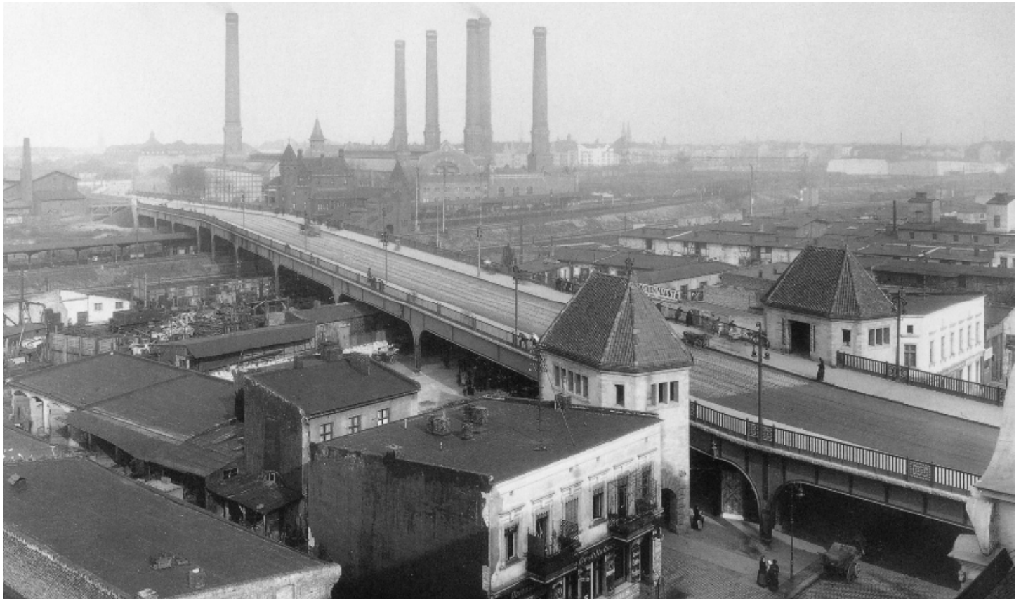
Die Putzlitzbrücke kurz nach ihrer Fertigstellung im Jahr 1912, Bild: Hermann Rückwardt
