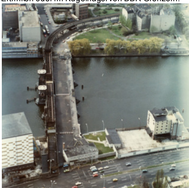
Die abgeriegelte Oberbaumbrücke (1983) – oben Kreuzberg (Westsektor). Quelle: unbekannt.
