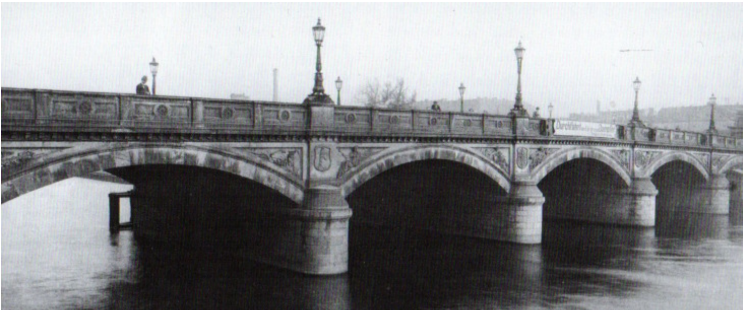
Die Schillingbrücke um 1880 mit schweren Gaskandelabern und ausladenden Sockeln, Bildquelle: unbekannt/Slg. ProGaslicht
