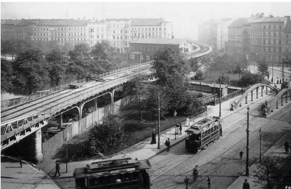
Großes und kleines Bild: Die Wassertorbrücke am Wassertorplatz, Bildquelle: unbekannt/Slg. PGL
