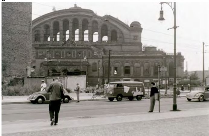
Viele Ex-Pressgaskandelaber hatten den Krieg überstanden, sie wurden später für die Niederdruck-Gasbeleuchtung eingesetzt wie hier vor der Ruine des Anhalter Bahnhofs. Bild: Slg. PGL
