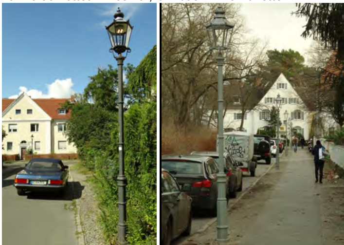
Oben: Vor zwei Jahren war hier nur Gasbeleuchtung, inzwischen stehen hier Elektroattrappen. Die Laternen wirken wegen des fehlenden „Innenlebens“ leblos.
