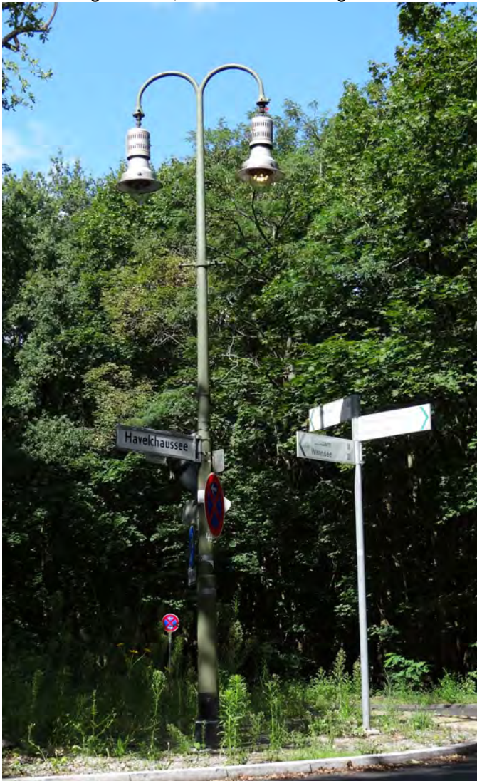
Vernichtet und entsorgt: Der einzige zweiarmige Stahlmast mit Gashängeleuchten. Bild: Bettina Raetzer-Grimm
