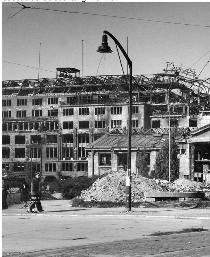
Der Wittenbergplatz 1945, das Pressgaslicht ist erloschen, immerhin steht der Auslegermast mit der Leuchte noch. Weiter hinten eine Gasaufsatzleuchte.
