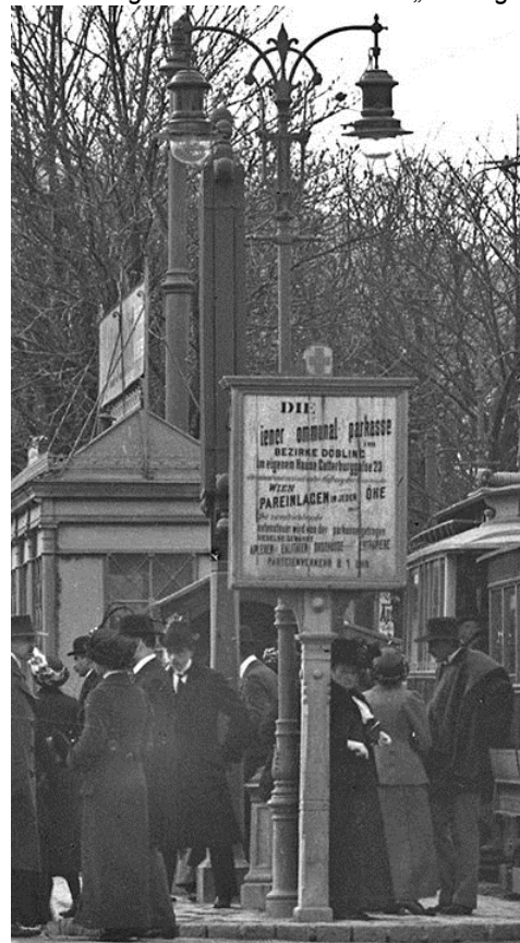
Doppelarmiger Gaskandelaber mit Starklicht-Leuchten.
