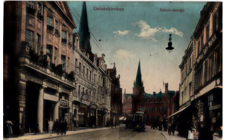
Gelsenkirchen: Doppel-Überspannung mit Pressgasleuchten (vermutlich Graetzin), Bild: Slg. PGL
