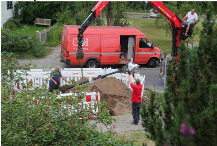
*Abriss einer Gas-Modelleuchte. Bild: Slg. PGL*
