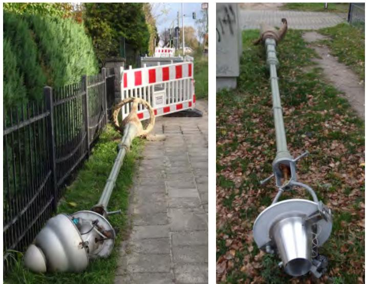
Abgesehen von der Beseitigung etlicher Gasbeleuchtungsanlagen wird Berlin inzwischen in großem Stil mit LED-Straßenleuchten ausgerüstet. Dies geschieht stadtweit. Im Westteil Berlins werden vor allem die ab 1955 eingesetzten Langfeldleuchten – Hersteller die Firma Franz R. Conrad/ „Conradlicht“ bzw. „Konstruktionslicht“) – demontiert und durch LED-Leuchten ersetzt.
