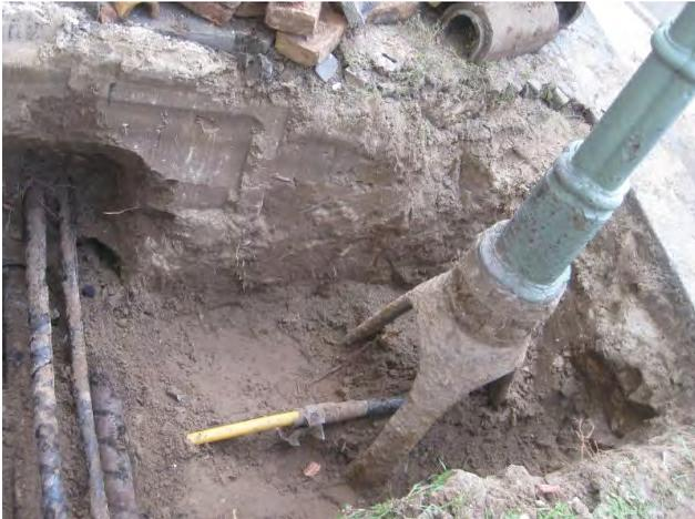
Oben: Freilegung einer Gasleuchte kurz vor deren Entfernung; unten Aufstellung einer elektrischen Leuchte. Die Aufnahmen entstanden auf der Wilhelmsaue in Wilmersdorf (2017).
