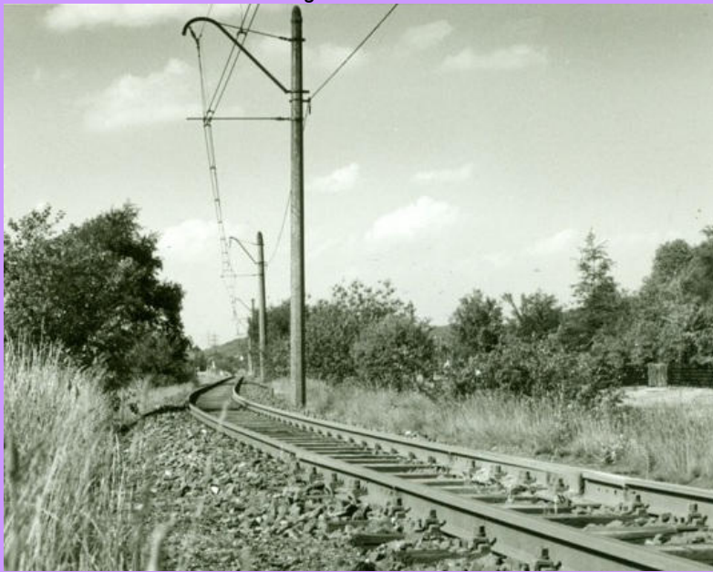
Betonmast mit Ausleger (ähnlich den Auslegern der Deutschen Reichsbahn ab 1925); rechts Gittermast als Mitteltragmast (Frankfurt-Goldstein um 1975), Bilder: links unbek. Ort und Quelle, rechts Sven Lehmann
