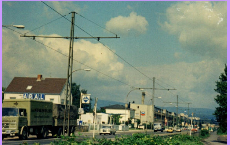
Oben: Links (1966) und rechts Gitter-Mitteltragmaste mit geraden Auslegern, die Konstruktion wird später vereinfacht. Der Fahrdrabt wird dann nicht mehr an einem Querdraht, sondern direkt am Ausleger-Tragrohr montiert (Frankfurt am Main-Hausen und -Praunheim), Bilder: Bettina Grimm
