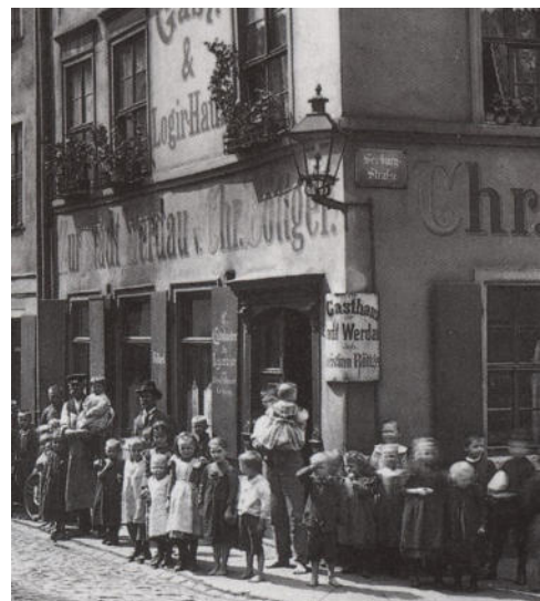
Vierseitige Gaslaternen, links mit offener Flamme an der Peterskirche (1877), rechts mit typischer Leipziger Wandmontage in der Seeburgstraße (1899).
