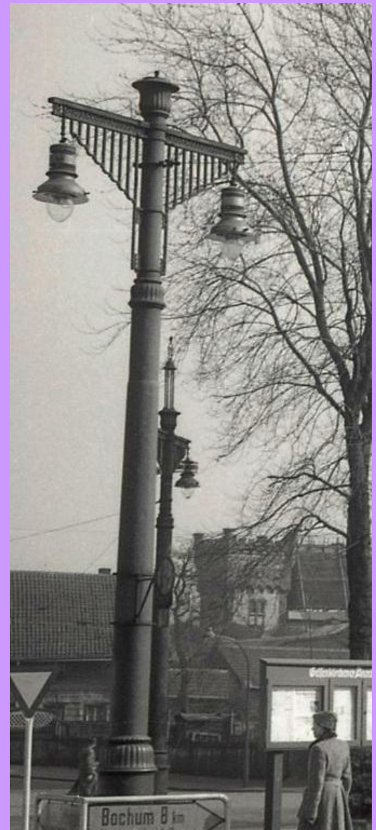
Fahrleitungsmaste mit Gashängeleuchten in Gelsenkirchen (Ueckendorfer Platz), die Mastkrone ist vasenförmig. Im Hintergrund eine Gasansatzleuchte. Bildausschnitt/Quelle: Gelsenkirchener Geschichten
