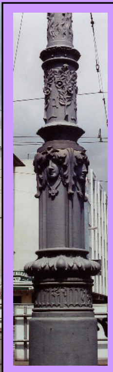
Frankfurt am Main. Links und Mitte: Vor etwa fünf Jahren wurde völlig überraschend dieser Stahlrohrmast mit Jugendstilsockel aufgestellt – doch nach ein paar Monaten verschwand er wieder. Der Mast war ein Hingucker, historisch leider etwas falsch „zusammengesetzt“. Der Sockel gehörte zu einem in Frankfurt weit verbreiteten Lichtmast mit Bogenausleger für eine elektrische Leuchte. Die Kombination mit der „Zwiebel“-Mastspitze gab es so wohl nicht, da zum „Zwiebel“-Mast ein anderer Sockel gehört. Was war aber der Grund für das plötzliche Aufstellen und wieder Entfernen? Angeblich wollte man das Stadtbild verschönern, aber der Mast sei an dieser Stelle ungeeignet gewesen und eine sichere Fahrleitungsmontage nicht möglich. Der wunderbare Mast soll seitdem sein Dasein auf einem Hof der Stadtwerke fristen. Rechts daneben: Der letzte historische Stahlgittermast in Frankfurt. Kürzlich stand er noch an den Riederhöfen. Bilder: Bettina Grimm
