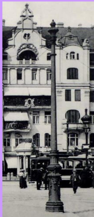
Dresden: Während am Albertplatz ein wichtiger Sockel den konisch nach oben verjüngenden Mast ziert, fallen die Maste im Betriebshof Blasewitz eher bescheiden aus. Die oberen Mastabschlüsse unterscheiden sich deutlich, die „Zwiebel“ erscheint repräsentativer, der „Kegel“ eher schlicht.
