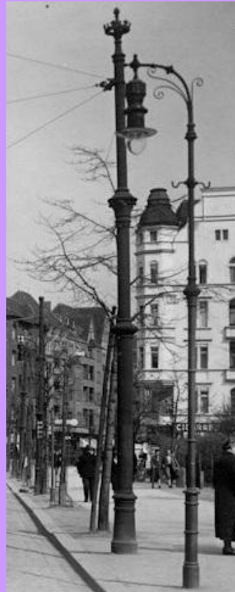
Links: Fahrleitungsmast der 1. Generation mit Sockel, wuchtigen Zierringen und gusseiserner Krone als Mastspitze (Berlin-Wilmersdorf, Augustastraße 1920), davor eine Gashängeleuchte; rechts typischer Rundstahlmast aus Wien mit etwas weniger aufwändigen Zierringen und unauffälliger Mastspitze, die vermutlich aus Blech gefertigt wurde (Wien, Weißkirchnerstraße 1905) Unten: Stahlmast mit Berliner Standard-Ausleger in der Kleiststraße (1904). Bilder: Slg. PGL
