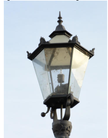
Oben: Mit Natriumdampfampe bestückte „Leipziger Schinkellateme“ in recht ungepflegtem Zustand, da notwendige Reinigungen bei elektrischen Leuchten meist unterbleiben. Unten eine auf LED umgebaute Laterne. Bilder: Bettina Grimm
