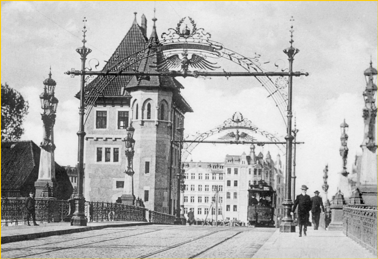
Die Kaiserbrücke in Königsberg/Pr. mit Fahrleitungsportalen aus reich verzierten Rohrmasten und Querträgern. Die Brücke ist mit Gaskandelabern auf Obelisken bestückt. Bild: Sammlung ProGaslicht
