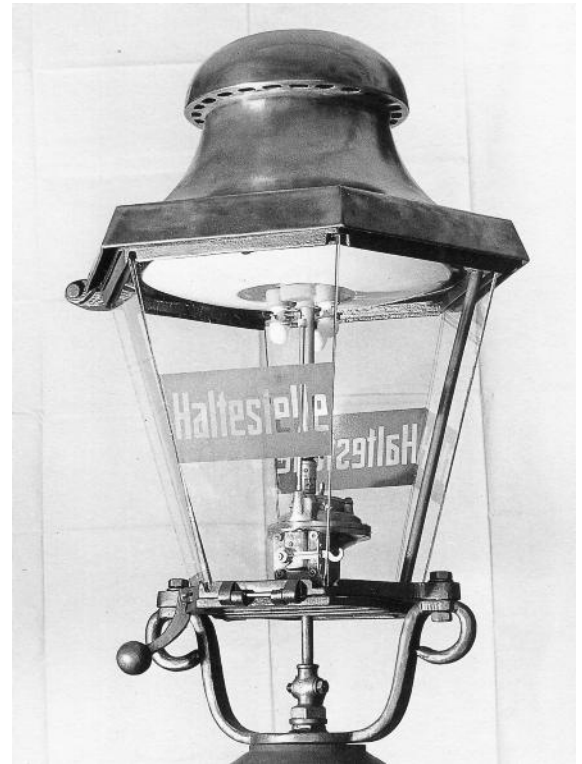
Gasleuchte für Straßenbahnhaltestellen mit Schiriko-Fernzünder, Bild: Manfred Stopp
