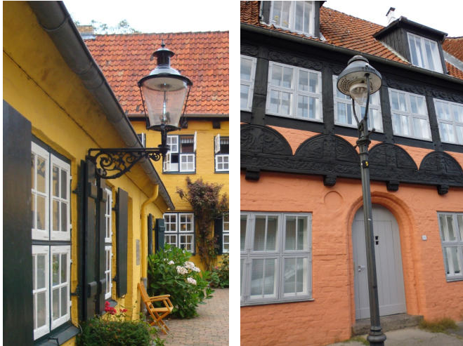
Typische Gasleuchten in Lübeck: Rundmantellaterne in einem Gang, Aufsatzleuchte mit Bündelpfeilmast. Bilder: unbek. und Tilman Agena
