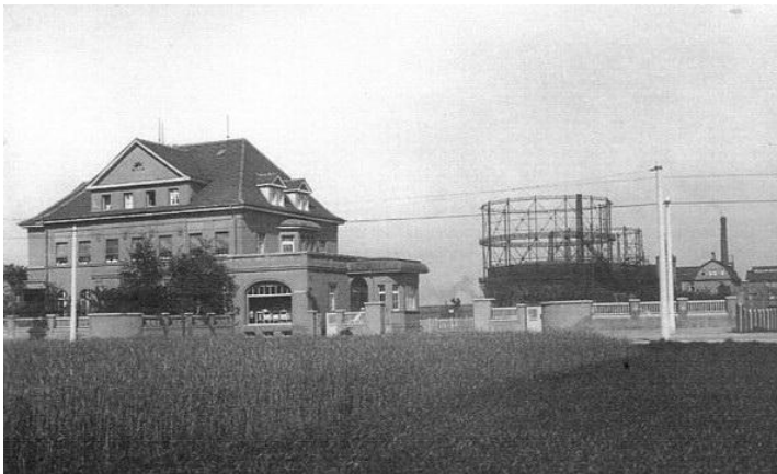
Die Gasanstalt III in Engelsdorf (1920), Bild: Slg. PGL
