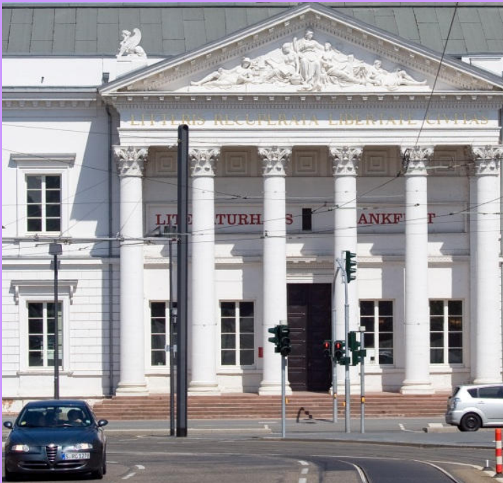
Turmhoher Mast der neuesten Generation vor dem Portal der alten Stadtbibliothek in Frankfurt am Main. Der Mast wirkt hier absolut störend, hier hätte man eine andere Lösung finden müssen. Wenige Jahre vorher standen hier Rundstahlmaste, die sich nahtlos ins Stadtbild eingefügt hatten. Bild: Slg. PGL
