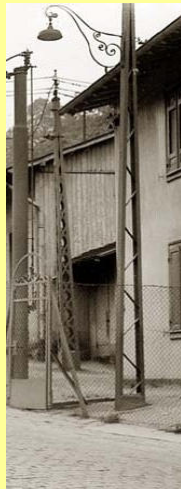
Düsseldorf: Typischer Hochmast für elektrisches Bogenlicht. Um 1910. Ein einziger existiert noch. Bildmitte oben: Seltsame Konstruktion elektrischer Leuchten an einem Fahrleitungsmast (Reutlingen, um 1955)
