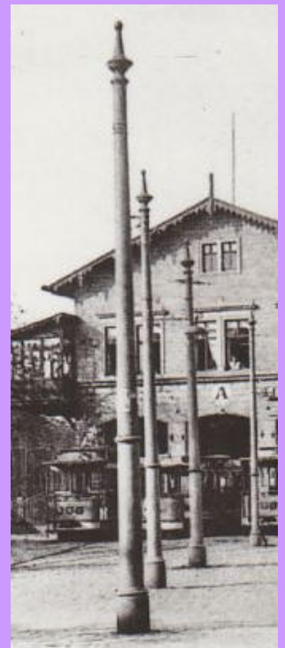
Dresden: Während am Albertplatz ein wichtiger Sockel den konisch nach oben verjüngenden Mast ziert, fallen die Maste im Betriebshof Blasewitz eher bescheiden aus. Die oberen Mastabschlüsse unterscheiden sich deutlich, die „Zwiebel“ erscheint repräsentativer, der „Kegel“ eher schlicht.
