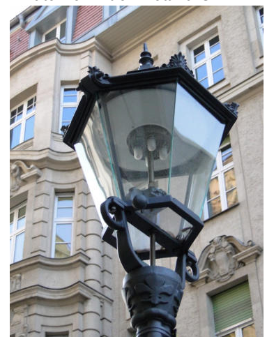
Oben: Mit Natriumdampfampe bestückte „Leipziger Schinkellateme“ in recht ungepflegtem Zustand, da notwendige Reinigungen bei elektrischen Leuchten meist unterbleiben. Unten eine auf LED umgebaute Laterne. Bilder: Bettina Grimm
