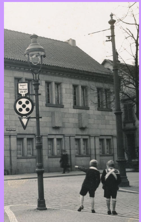
Oben: Weit verbreitet und Stadtbild prägend waren in den 1920er und 1930er Jahren die Gasleuchte „Bauart Köln“ und der Rundstahlmast mit „Zwiebel“ Links: Recht selten waren diese Gittermaste, die gleichzeitig eine Überspannung für elektrisches Licht trugen. Gasleuchten gibt es außerdem. Bilder: Slg. PGL
