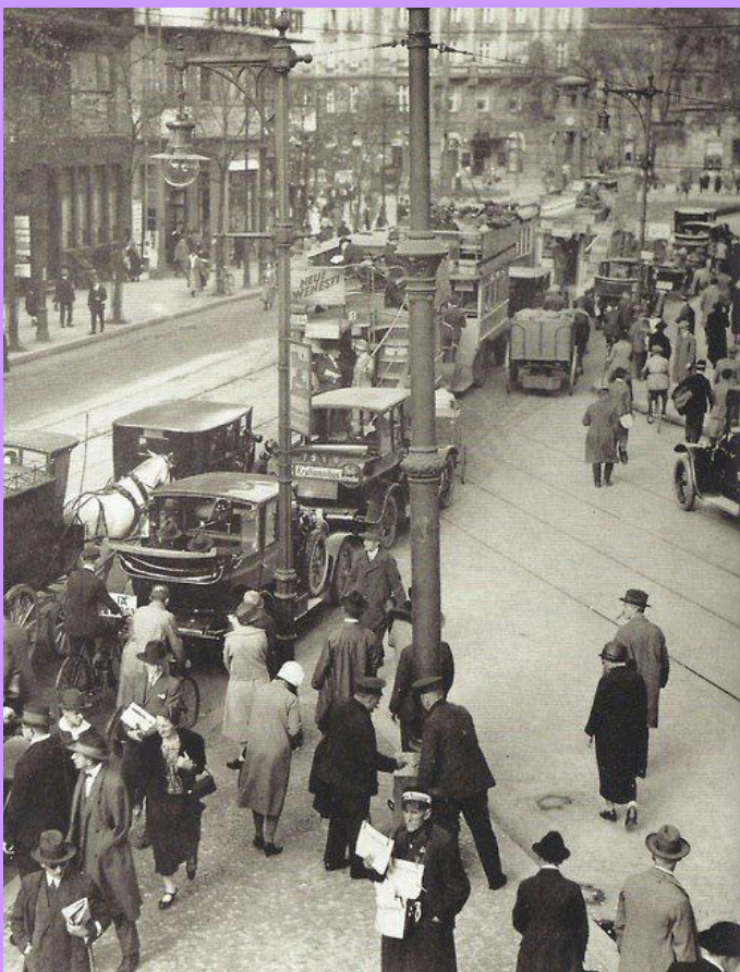
Berlin um 1925, Kurfürstendamm mit Pressgas-Hängeleuchten, im Vordergrund ein Mast für die Straßenbahn, die Zierringe sind gut zu erkennen, Bild: Willy Pragher
