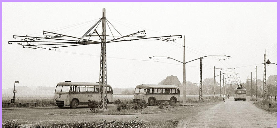
Oben und unten rechts: In den 1950er Jahren setzten viele Städte auf den elektrischen Obus. So auch in Berlin (oben) und in Moers (rechts). In Berlin-Marzahn war es damals noch ausgesprochen ländlich. Beeindruckend die Wendeschleife mit dem Gittermast, der mit seinen vielen Auslegern wie eine gewaltige Spinne aussieht. Ganz rechts lugt eine Gasleuchte hervor.
