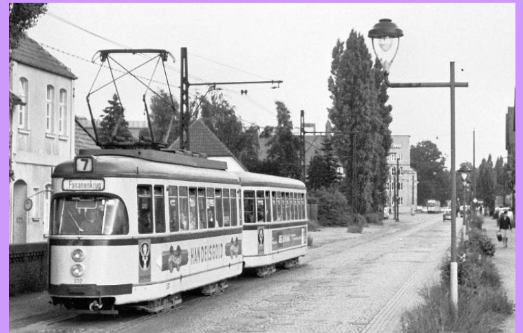
Oben: Links Vierkant-Gittermast mit Spann-Gewichten und gebogenem Ausleger für Einfachfahrleitung (Müncheberg, 2012); in der Mitte Mast mit geradem langem Ausleger für zwei Fahrdräfte (Augsburg 1930); rechts Gittermast mit geradem Ausleger für einen Fahrdrabt, am rechten Straßenrand typische Hannoveraner Gasaufsatzleuchten (Hannover um 1960), Bilder: Slg. PGL
