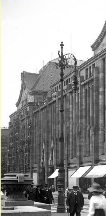
Düsseldorf: Typischer Hochmast für elektrisches Bogenlicht. Um 1910. Ein einziger existiert noch. Bildmitte oben: Seltsame Konstruktion elektrischer Leuchten an einem Fahrleitungsmast (Reutlingen, um 1955)
