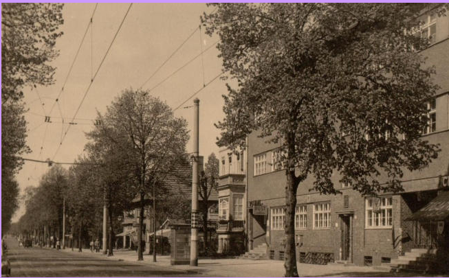
Oben: In der Bahnhofstraße in Berlin-Lichtenrade ist 1955 eine sehr moderne Kettenfahrlösung installiert. Gashängeleuchten an Schwanenhals-Kandelabern sorgen für Licht.
