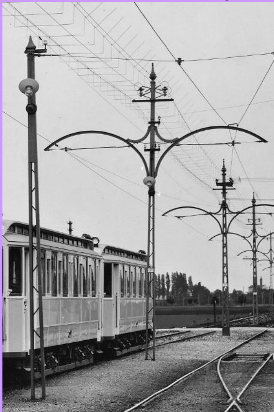
Mitteltragsmaste mit Einfach-Fahrleitung in Wien-Mödling um 1910; Bild: Slg. PGL; Rechts: Montagearbeiten in München, Bild: Deutsche Fotothek
