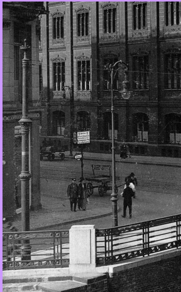
Berlin: Die Maste sind mit Kronen geschmückt. Auch eine Pressgasleuchte ist zu sehen. Ab den 1930er Jahren werden die Kronen durch einfache Blechdeckel ersetzt.
