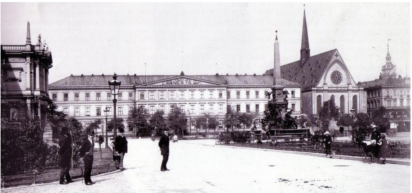
Sechseckige Modelleuchten auf sogenannten Siemens-Kandelabern vor dem Augusteum.
