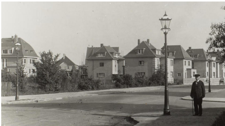
Neue Gusskandelaber im Stil der frühen 1920er Jahre mit „Leipziger Schinkellaterne“ in der Pistoriusstraße.
