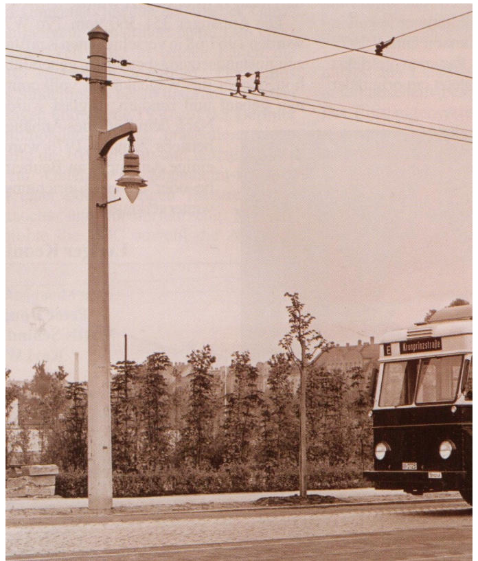
Betonmast für die Befestigung der Fahrleitung von Obus und Straßenbahn in der Antonienstraße. An Auslegern sind seltene Gashängeleuchten der Firma Thomas aus Leipzig mit Blohmglocken montiert. Bild: Archiv Werner Stock
