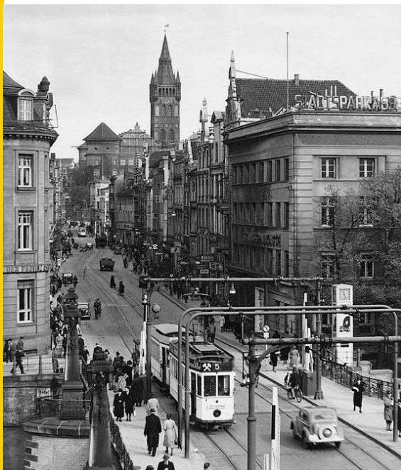
Die Krämerbrücke mit Fahrdrahtbefestigung ohne aufwändige Verzierungen, sie wurde 1945 zerstört.
