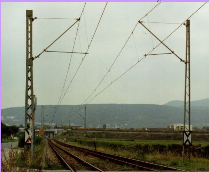
Links: Zwei verschiedene Gittermaste auf der landschaftlich reizvollen Strecke der Überlandstraßenbahn von Ludwigshafen nach Bad Dürkheim (Rhein-Haardt-Bahn, um 2015), im Hintergrund der Pfälzer Wald; rechts Vierkantgittermast mit Gewichten zur Fahrdrahtbespannung und modernem Ausleger, ähnlich den heute üblichen der Deutschen Bahn AG. (Thüringerwaldbahn).
