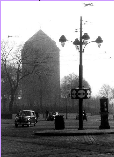
Hamburg: Oben Mast mit drei Maxilux-Ansatzleuchten; unten sogar mit vier, Hersteller Firma Rech. Bestückung mit Blohm-Glocken. Auch die Richtungspfeilschilder sind gasbeleuchtet.
