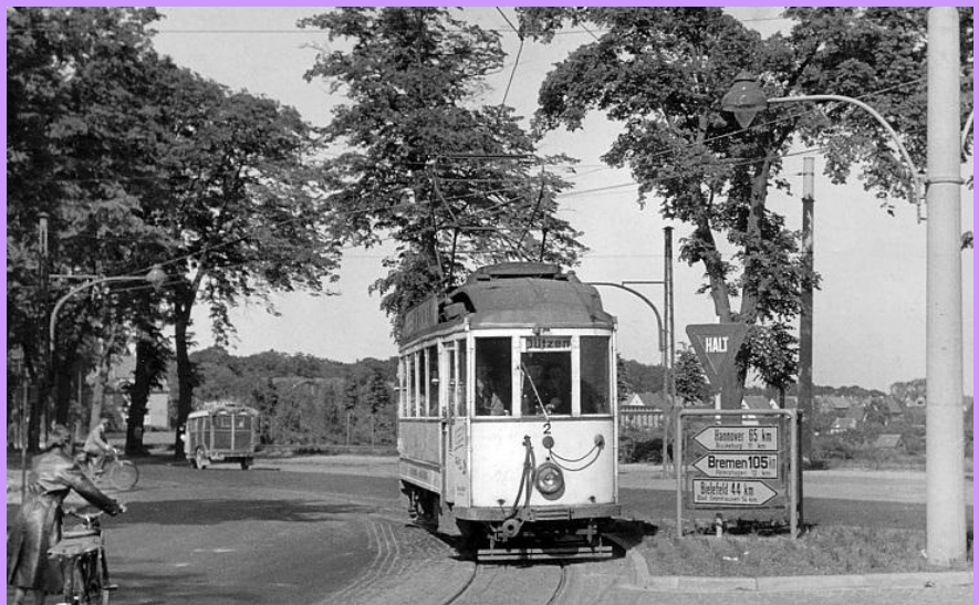
Unten: In den 1950er Jahren brachte man gelegentlich Ansatzleuchten mit Auslegern an Fahrleitungsmaste an wie hier in Minden. Bild: Archiv schmalspur-ostwestfalen
