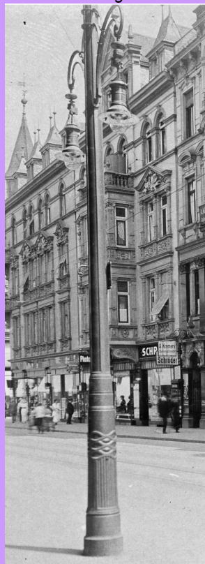
Oben: Gaslaternen und Gittermaste prägen das um 1910 entstandene Bild vom Straßenbahnbetriebshof Dresden-Mickten. Unten: Links der Blick auf einen Rohmast mit Jugendstilauslegern und Gashängeleuchten, in der Mitte ein Mast mit Bischofsstab-Auslegern, rechts wieder feinsten Jugendstil bei diesem Mast in Gelsenkirchen. Als Spitze dient das Symbol des Bergbaus, Schlägel und Bergeisen. Bildausschnitte: Slg. PGL
