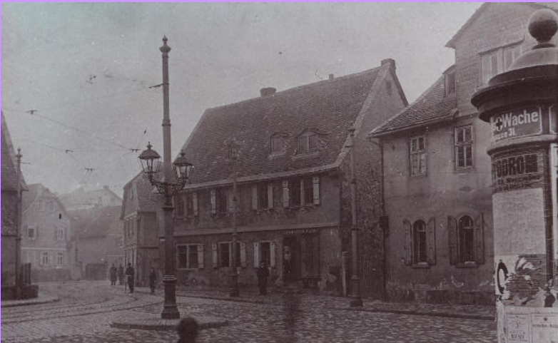
Bilder: Oben Aufnahme aus Frankfurt-Bockenheim (Kirchplatz) mit mehreren Masten, auf der kleinen Verkehrsinsel ist der Mast mit zwei Gaslaternen bestückt. Bemerkenswert auch die Plakatsäule rechts. Unten links ein Mast mit drei Berliner Modelleuchten (Berlin, Hallesches Tor). Rechts – leider angeschnitten – Mast mit drei, eventuell auch vier Modelleuchten „Alt-Königsberg“ (Königsberg, Gesekusplatz). Bilder: Slg. PGL und W. Titzenthaler
