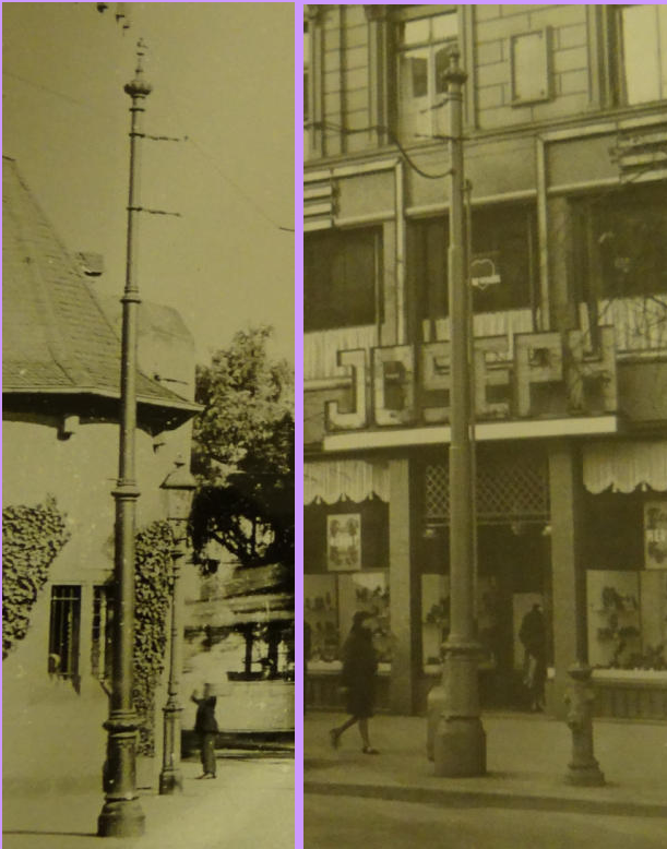
Der künstlerische Geschmack ändert sich. Links die erste Mast-Generation mit Zieringen (um 1900), dahinter eine vielseitige Gasleuchte, rechts eine moderne Variante, hier ist der Mast aus einem „Guss“ sichtbar zweifach abgetreppt, aber nach wie vor mit Zierspitze („Zwiebel“) und Schmuck-Sockel. Bilder aus Frankfurt am Main; Quelle: Slg. PGL
