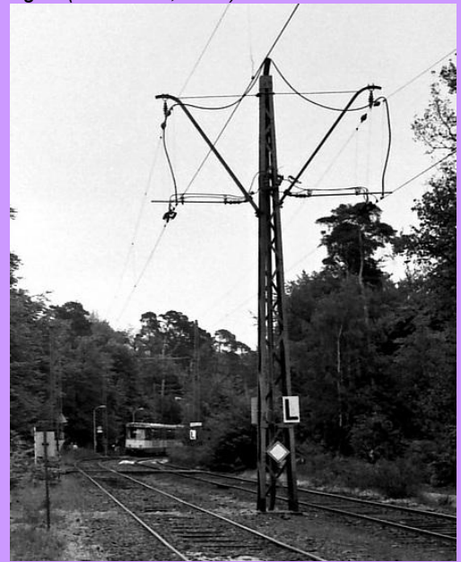
Betonmast mit Ausleger (ähnlich den Auslegern der Deutschen Reichsbahn ab 1925); rechts Gittermast als Mitteltragmast (Frankfurt-Goldstein um 1975), Bilder: links unbek. Ort und Quelle, rechts Sven Lehmann
