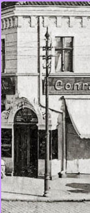
Rundstahlrohrmast zur Befestigung der elektrischen Freileitung (Insterburg), Bild: Slg. PGL
