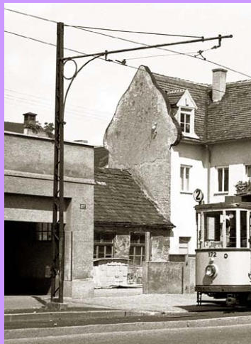
Oben: Links Vierkant-Gittermast mit Spann-Gewichten und gebogenem Ausleger für Einfachfahrleitung (Müncheberg, 2012); in der Mitte Mast mit geradem langem Ausleger für zwei Fahrdräfte (Augsburg 1930); rechts Gittermast mit geradem Ausleger für einen Fahrdrabt, am rechten Straßenrand typische Hannoveraner Gasaufsatzleuchten (Hannover um 1960), Bilder: Slg. PGL
