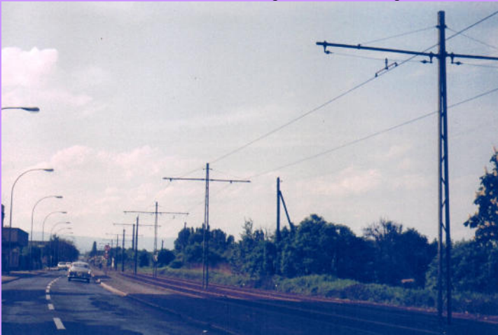
Oben: Links (1966) und rechts Gitter-Mitteltragmaste mit geraden Auslegern, die Konstruktion wird später vereinfacht. Der Fahrdrabt wird dann nicht mehr an einem Querdraht, sondern direkt am Ausleger-Tragrohr montiert (Frankfurt am Main-Hausen und -Praunheim), Bilder: Bettina Grimm
