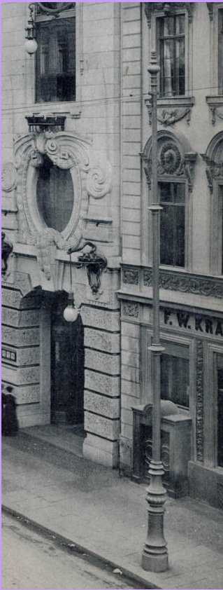
Hochmast zur Befestigung von Überspannungen für elektrische Beleuchtung in Berlin (Leipziger Straße), um 1910. Bild: Slg. PGL
