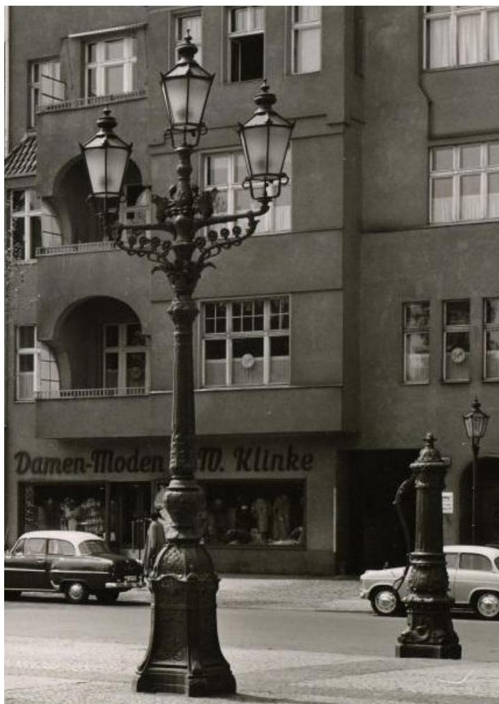
*Klausener Platz: Hier wurde bei den Modelleuchten des Gaskandelabers versuchsweise Milchglas eingesetzt, was sich jedoch nicht bewährte. Bild: Slg. PGL*
