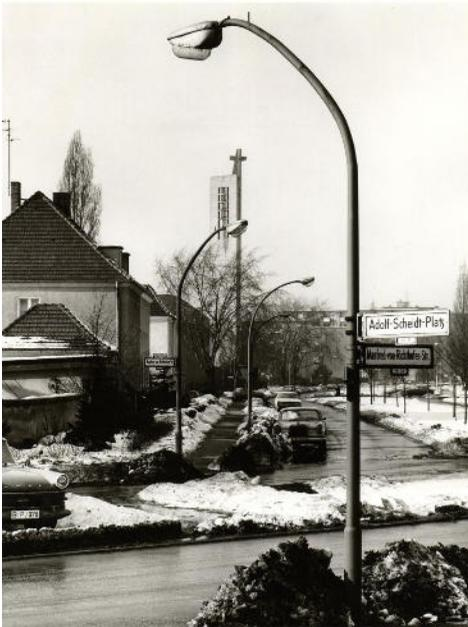
Tempelhof/Manfred-von-Richthofen-Straße: Deutlich sind beide Varianten der Gasreihenleuchte zu erkennen. Im Vordergrund Typ „U13B“ auf dem zweifach abgeknickten „Berliner Mast“, im Hintergrund Typ „U13H“ auf eleganter wirkendem Peitschenmast. Letztere Variante setzte sich schließlich durch.
