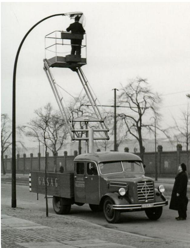
*Oben: Neuaufrichtung von Gasreihenleuchten im Tausch gegen Hängeleuchten (im Bild hinten). Rechts: Montage der Gasreihenleuchte Typ U13B (1955) in der Torgauer Str.*
