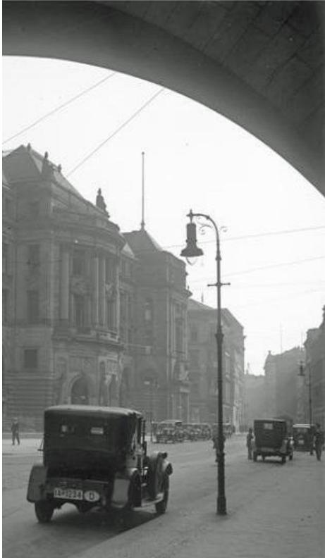
*Oben: Die Mauerstraße in Mitte in den 1920er Jahren. Gashängeleuchte an einem gusseisernen Bündelpfeilmast mit aufgesetztem parabelförmigen Ausleger der Berliner Firma Osenberg.*
