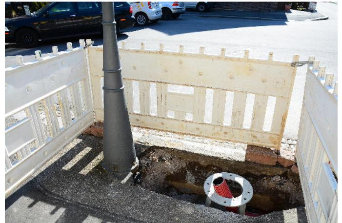
April 2016: Die letzte Stunde des Original-Gaskandelabers ist eingeläutet. Der Erdbock für die elektrisch betriebene Attrappe steht bereits. Bild: Holger Drosdeck
