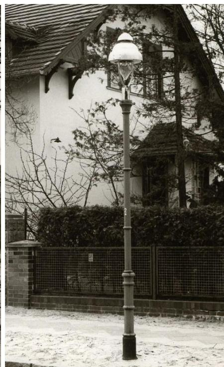
*Links: Selten anzutreffen war eine auf Stahlmast montierte Modelleuchte wie hier in Spandau (1960); rechts das leuchtende Symbol West-Berlins. Die über 30.000 mal aufgestellte Gasaufsatzleuchte des Typs „Bamag U7“. Hier auf dem klassischen viergliedrigen Bündelpfeiler. Doch die GASAG verwendete auch zahlreiche Stahlmaste. Bilder: Slg. PGL*
