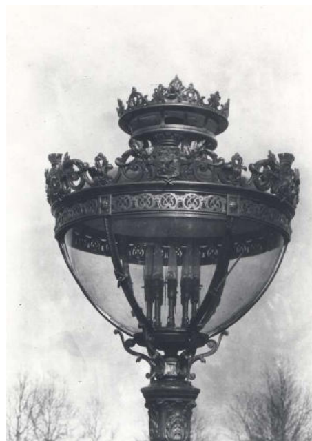
LINKS: Auf der Weltausstellung 1900 wurden diese Gaslaternen mit Gruppenbrenner nach dem neuen Patent von Louis Denayrouze vorgestellt. Die Brenner funktionierten auf 20mBar, damals ein recht hoher Druck. Die Laternen standen am Eiffelturm.
