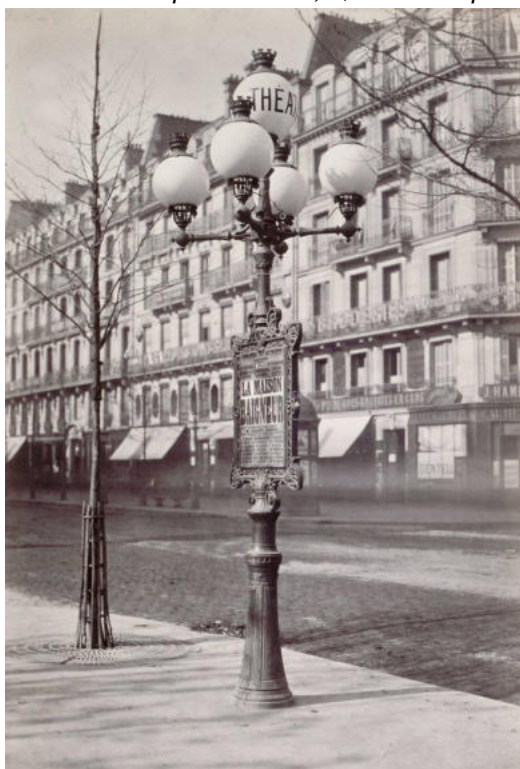
Gaskandelaber mit Kugelleuchten auf dem Boulevard de Sébastopol um 1864, Bild: Charles Marville
