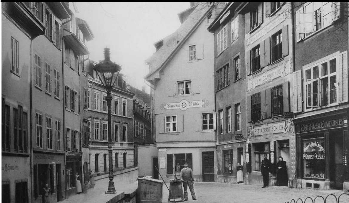
Ausladende sechsseitige Gaslaterne mit dreifach stehendem Glühlicht vor Rümelins Mühle mit Rümelinsplatz 1899
