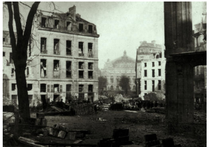
Avenue de l'Opéra, démolition, Charles Marville
