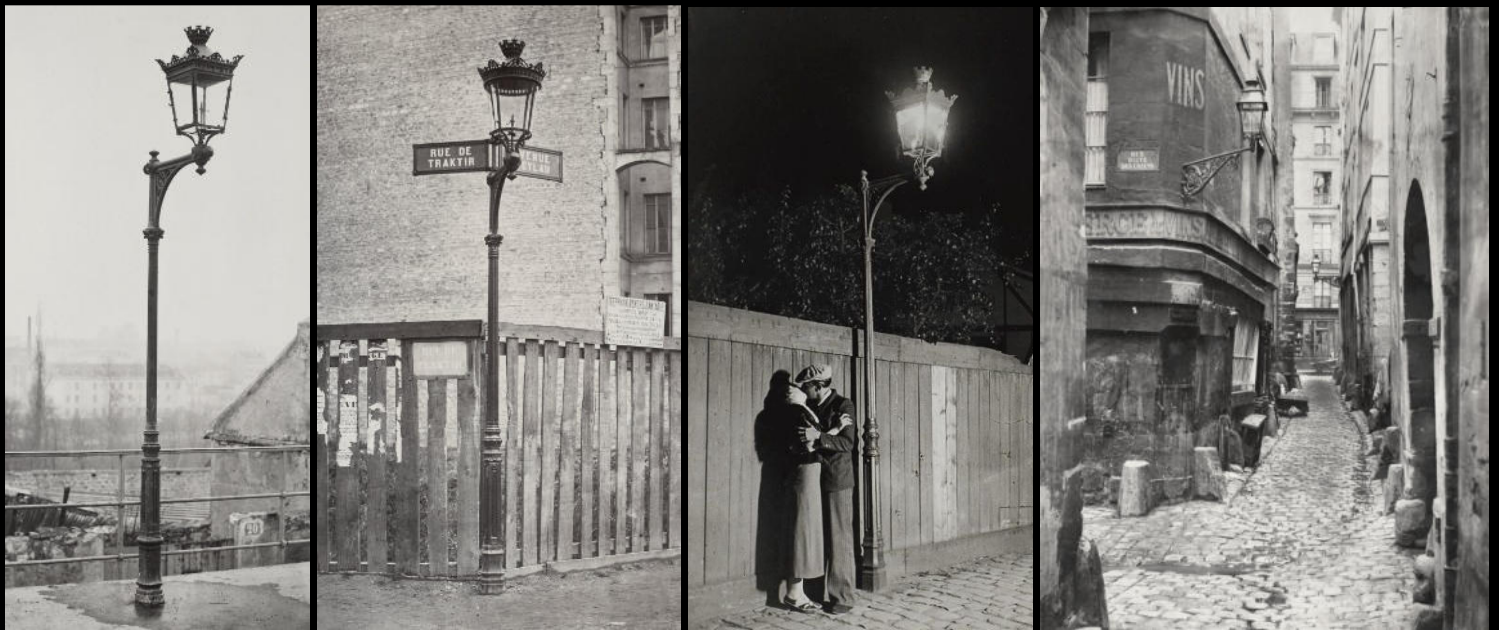
V.l.n.r. Weit verbreiteter schlanker Gaskandelaber mit Ausleger, vierseitige Laternen mit Zierrat, in der Mitte eine Rundmantellaterne an einem Kandelaber mit Straßennamensschild/Candelabre console avec inscription des noms des rues. Gaslaternen waren schon immer beliebte Treffpunkte mit romantischem Ambiente. Rechts vierseitige Laterne ohne Zierrat an einem Wandausleger in der rue de Glatigny 1853-70.
