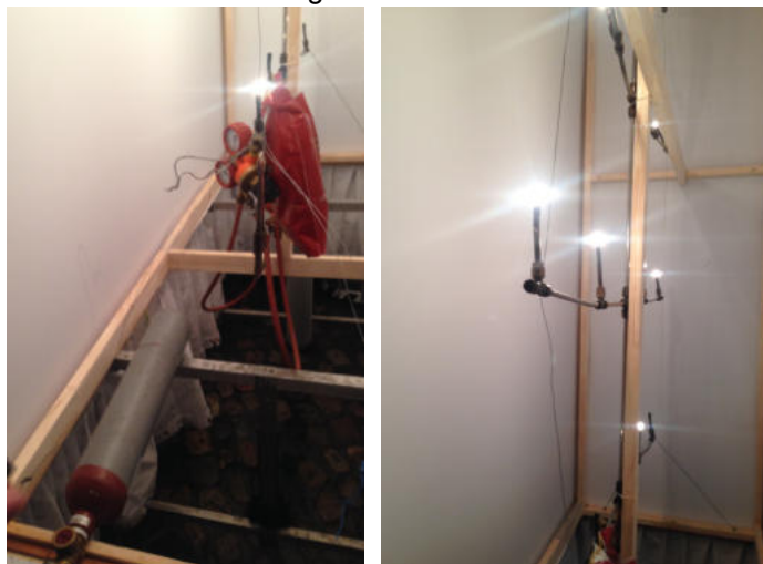
Das interessante Innenleben einer großen Laterne. Bis zu 20 Brenner sorgen für Gaslicht.
