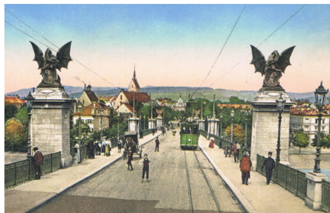
Oben: Spalentor 1890, vierseitige Gaslaternen mit Glasdach im französischen Stil auf „süddeutschem“ Gusskandelaber; unten: Wettsteinbrücke um 1900 mit sechsseitigen Gaslaternen, ausgerüstet mit einfachen stehenden Glühlicht.
