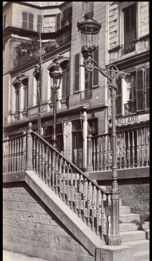
Sonderbauform eines Kandelabers mit Seitenausleger und Rundmantellaterne am Boulevard Saint Martin. Bilder: Charles Marville und Eugène Atget
