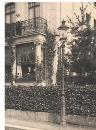
Der für Basel typische Kandelaber in „süddeutscher Bauart“, links mit vierseitiger Leuchte im französischen Stil, rechts mit Rundmantellaterne Typ „Ritter“.
