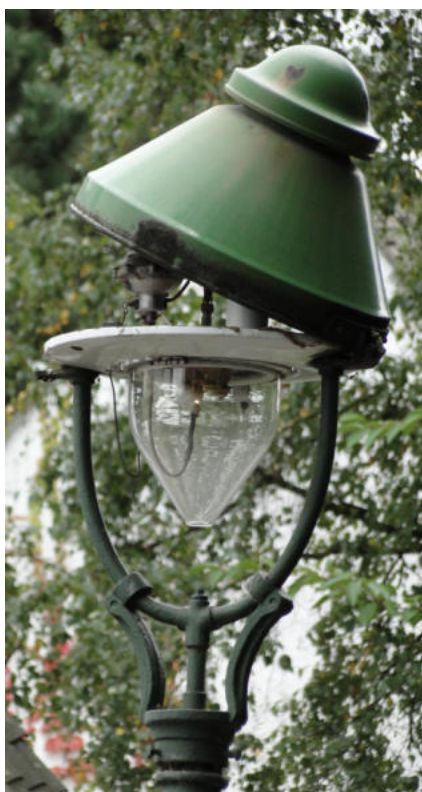
Oben: Sogenannte „Stühlen-Leuchte“; unter dem Dach der RECORD-Fernzünder; rechts RECORD-Fernzünder mit Deckel (oben) und Zünder mit Zusatzgerät für Erdgasbetrieb (unten) anstelle des Deckels. Der in Düsseldorf oft verwendete Begriff „Stühlen-Leuchte“ ist genau genommen nicht richtig, da die Firma Stühlen ausschließlich Kandelaber, aber keine Leuchten hergestellt hat.
