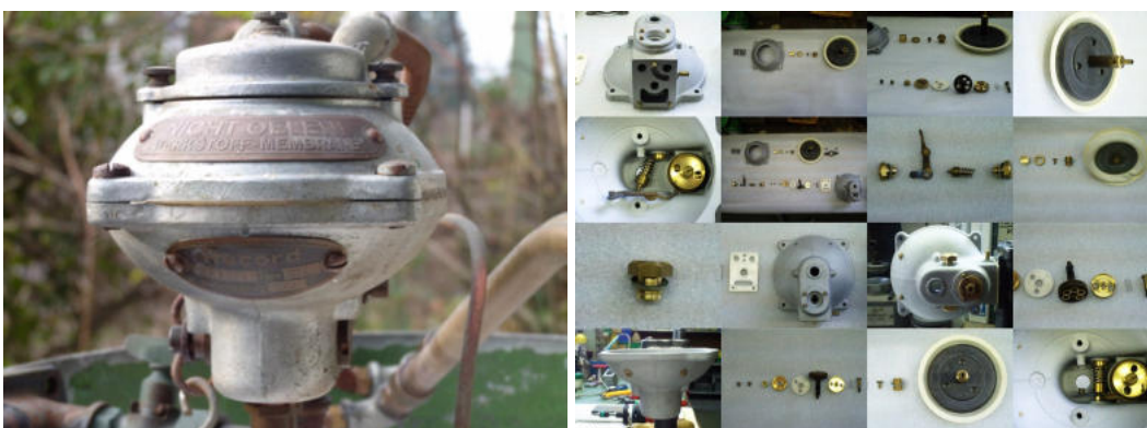
Links: RECORD-Gasdruckfernzündler mit Herstellerschild und Warnhinweis; rechts Bestandteile des RECORD-Gasdruckfernzündlers, Bildquellen: Klaus Gevatter (links) und F. Trapp GmbH (rechts).
