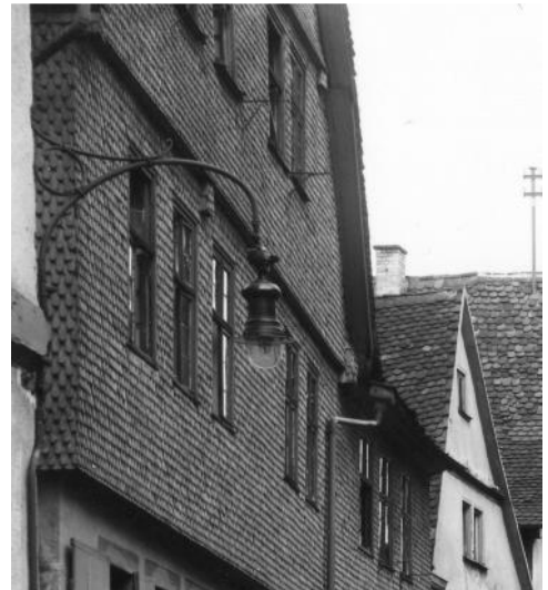
Invert-Gashängeleuchte mit freiliegendem BAMAG-Fernzünder in der Altstadt von Büdingen (1930er Jahre), Bild: Stadtarchiv Büdingen
