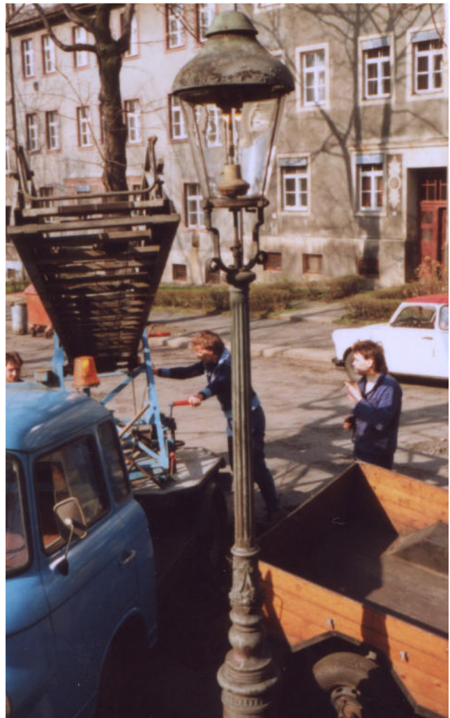
Links: Vierseitige Gaslaterne mit METEOR-Fernzünder in Wiesbaden um 1960; rechts eine Rundmantellaterne von Vulkan „Modell 25“ in Chemnitz 1990. Der Fernzünder ist ohne Funktion, die Gasleuchte auf Dauerbetrieb gestellt, das Dach ist wie die gesamte Laterne in sehr schlechtem Zustand. Bilder: Stadtarchiv Wiesbaden und Klaus Gevatter.
