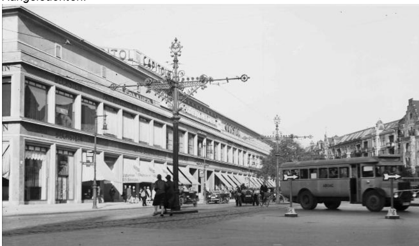
Auf dem Bild ganz unten sind die umgebauten Gaskandelaber zu sehen, anstelle der vierseitigen Laternen tragen die Lichtsäulen nun zwei Pressgas-Hängeleuchten.
