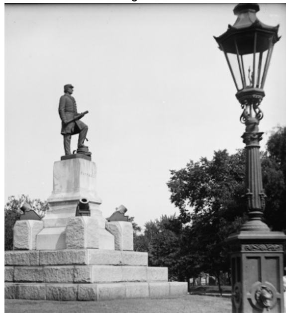
Die Farragut Statue mit einem Gaskandelaber auf einem Steinsockel, ausgestattet mit einer achtseitigen Schmuckleuchte und Schnittbrenner. Bilder: Library Of Congress
