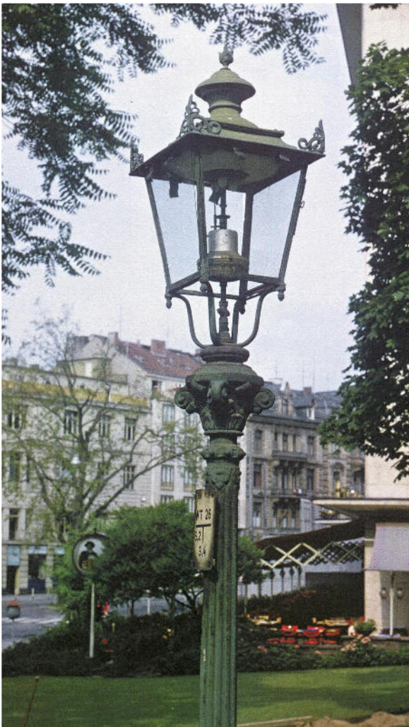
Links: Vierseitige Gaslaterne mit METEOR-Fernzünder in Wiesbaden um 1960; rechts eine Rundmantellaterne von Vulkan „Modell 25“ in Chemnitz 1990. Der Fernzünder ist ohne Funktion, die Gasleuchte auf Dauerbetrieb gestellt, das Dach ist wie die gesamte Laterne in sehr schlechtem Zustand. Bilder: Stadtarchiv Wiesbaden und Klaus Gevatter.
