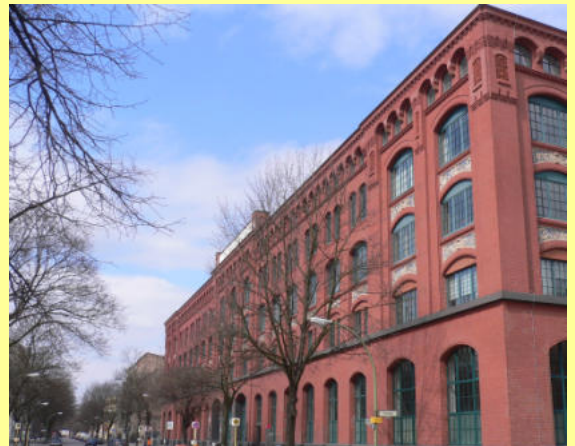
AEG-Apparatefabrik in Berlin-Gesundbrunnen (1888-1890), Bild: Georg Slickers
