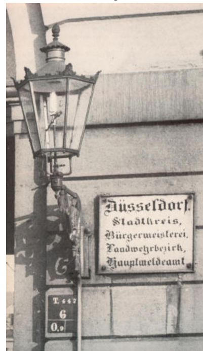
Oben: Plakat für MULTIPLEX-Gasfernzündler; unten Düsseldorf Gaslaterne mit stehendem Gasglühlicht und Schwenkhebelhahn für Handbetrieb (1897), Bilder: Slg. PGL
