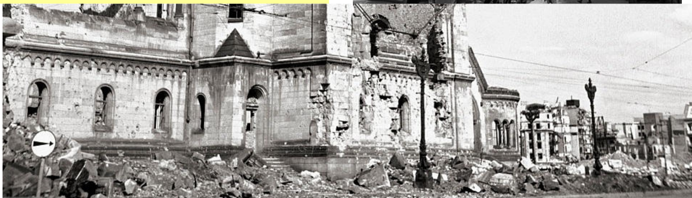
Seitenfront der zerstörten Gedächtnis-Kirche, die Gaskandelaber stehen fast unversehrt, nur die Gashängeleuchten fehlen.
