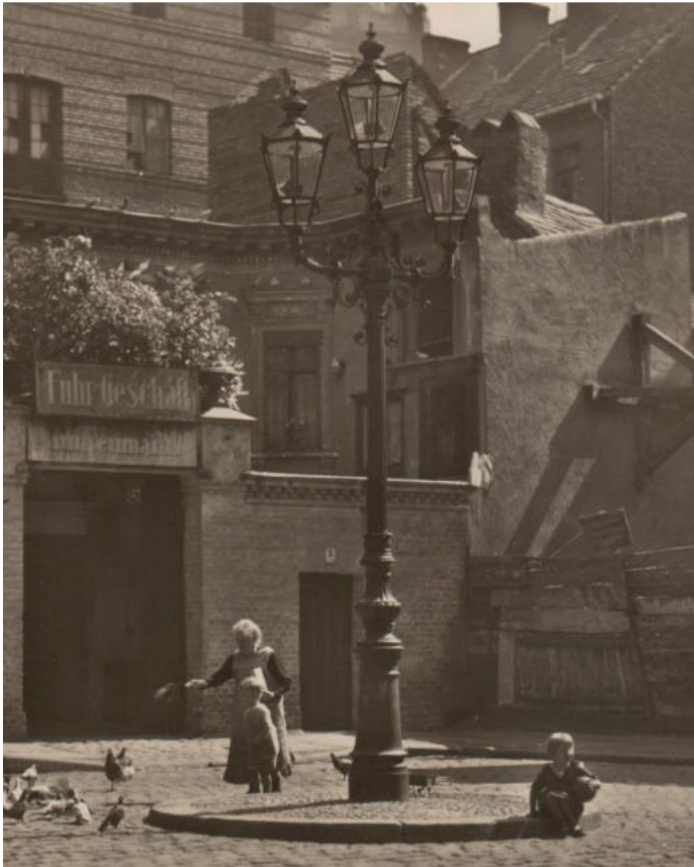
Oben: Dreiarziger Platzkandelaber mit Berliner Modelleuchten und BAMAG-Fernzündern im Großen Jüdenhof (1930er Jahre); unten Vierseitige Alt-Frankfurter Gasleuchte mit BAMAG-Fernzünder im Stadtteil Sachsenhausen (1960er Jahre), Bilder: Slg. PGL
