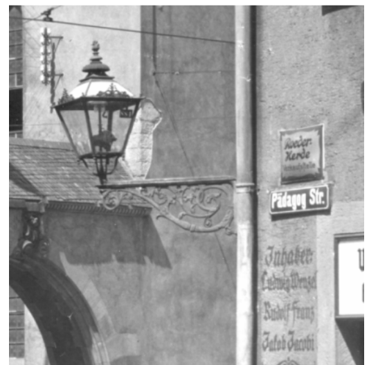
Invert-Gashängeleuchte mit freiliegendem BAMAG-Fernzünder in der Altstadt von Büdingen (1930er Jahre), Bild: Stadtarchiv Büdingen
