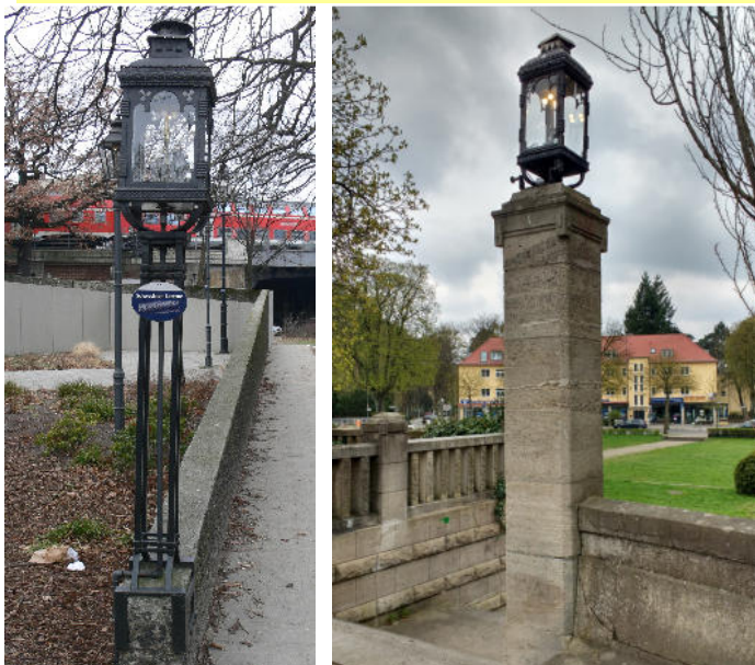
Links: Mit schmiedeeisernem Gestell im Gaslaternen-Freilichtmuseum, rechts mit Steinsockel auf dem Ludolfingerplatz in Berlin-Frohnau. Nicht gerade schön wirkt der „Kabelsalat“ des Schaltgerätes, und auch die zerbrochene Scheibe lässt die Laterne schlecht aussehen.
