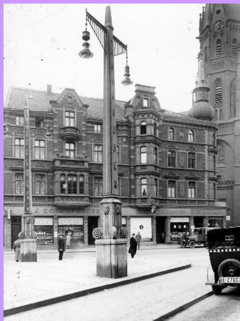
Oben links: Essen/Im Segeroth um 1920 mit Wandlaterne von Rech; rechts Essen/Auguststraße 1930, Gaslaterne der Bauart „Köln“ mit Gusskandelaber, im Hintergrund ein Gasometer. Unten Bilder aus Gelsenkirchen. Die Stadt bestach durch eine Anzahl imposanter Jugendstilkandelaber mit Gashängeleuchten, v.l.n.r.: Neumarkt, am Kaiserlichen Postamt, am Rathaus. Soweit bekannt sind alle im Zweiten Weltkrieg zerstört worden. Bilder: unbekannt/Slg. ProGaslicht.
