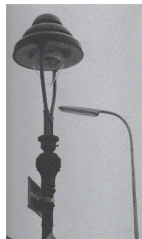
V.l.n.r.: Sechsstufige Modellleuchten in der Amalienstraße um 1908, Probebetrieb von Bamag U13H-Reihenleuchten an Wandbefestigungen in der Hirschstraße im September 1955, Schneider-Ansatzleuchte „Modell 52“ als Wandlaterne in der Bäder-, Ecke Rebenstraße, und schließlich der Abgesang: Eine Rech-Gasleuchte „Modell Modern“ wird durch eine elektrische Langfeldleuchte ersetzt.
