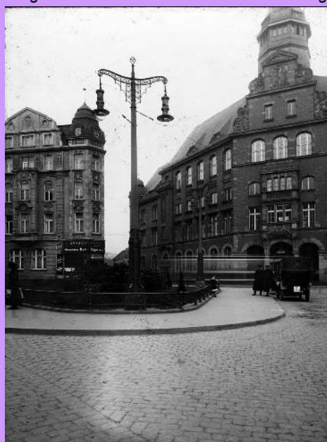
Oben links: Essen/Im Segeroth um 1920 mit Wandlaterne von Rech; rechts Essen/Auguststraße 1930, Gaslaterne der Bauart „Köln“ mit Gusskandelaber, im Hintergrund ein Gasometer. Unten Bilder aus Gelsenkirchen. Die Stadt bestach durch eine Anzahl imposanter Jugendstilkandelaber mit Gashängeleuchten, v.l.n.r.: Neumarkt, am Kaiserlichen Postamt, am Rathaus. Soweit bekannt sind alle im Zweiten Weltkrieg zerstört worden. Bilder: unbekannt/Slg. ProGaslicht.
