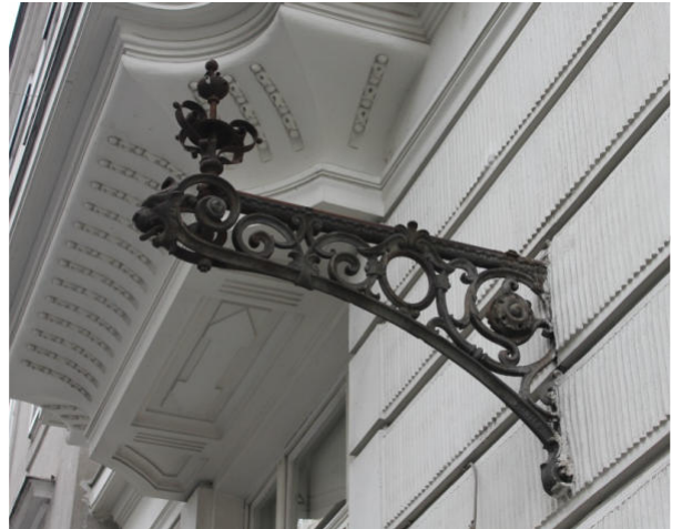
Bilder: Links einer von zwei Gashängeleuchten in der Wiener Josefstadt an der ehemaligen Gaswerksdirektion, inzwischen auf Strom umgebaut. Links unten: Wandarm mit Restaurantschild, daneben ein Bild der Frontseite des Wandarmes. Oben und unten: Wandarm mit elektrisch umgebauten Leuchten oder ganz ohne. Unten: Vierseitige Ex-Gasleuchten im Volksgarten.
