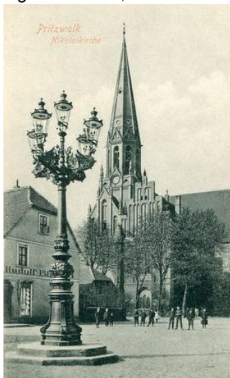
Gaskandelaber mit Rundmantellaternen um 1910, Bild: Slg. PGL
