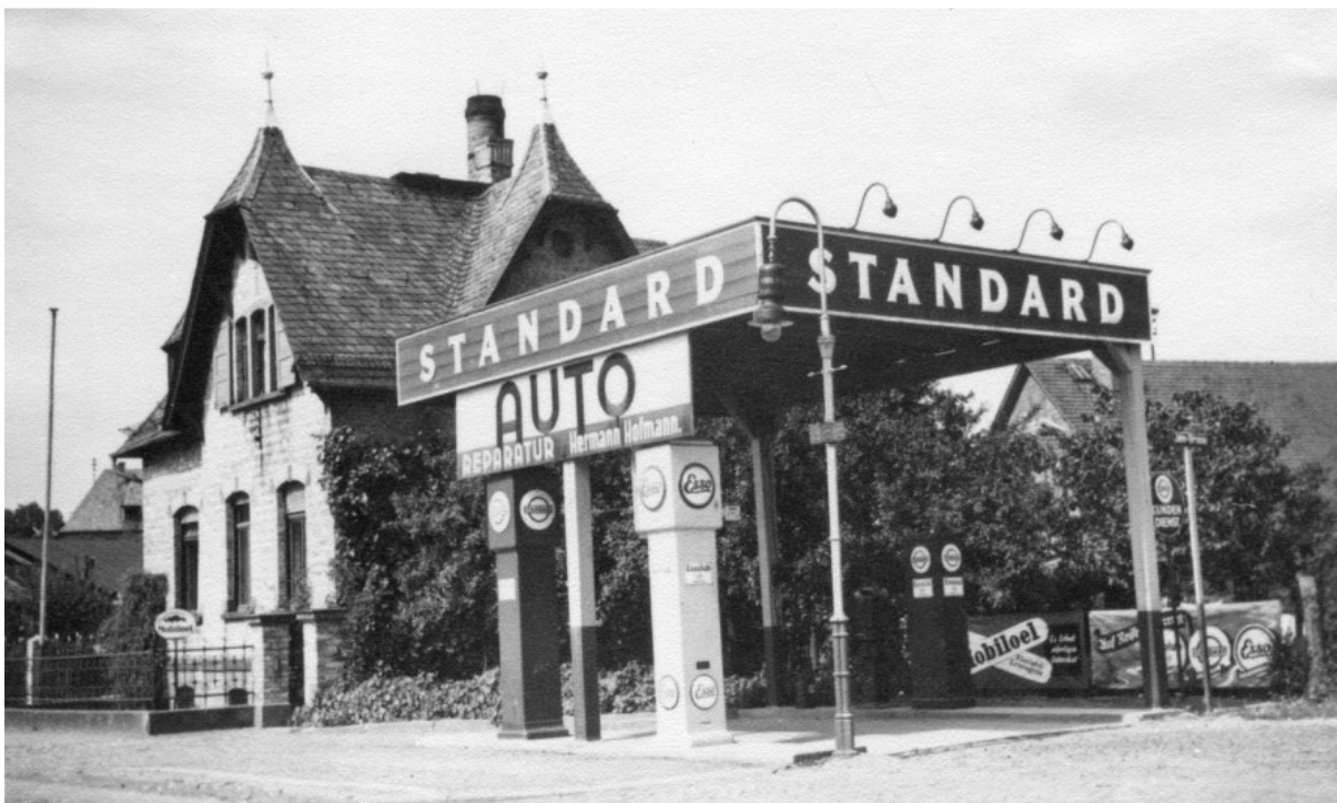
Welch ein Bild: So wie hier in der Berliner Straße sahen einst Tankstellen mit angeschlossener Autowerkstatt aus. Davor steht eine Gashängeleuchte mit Bündelpfeilmast.
