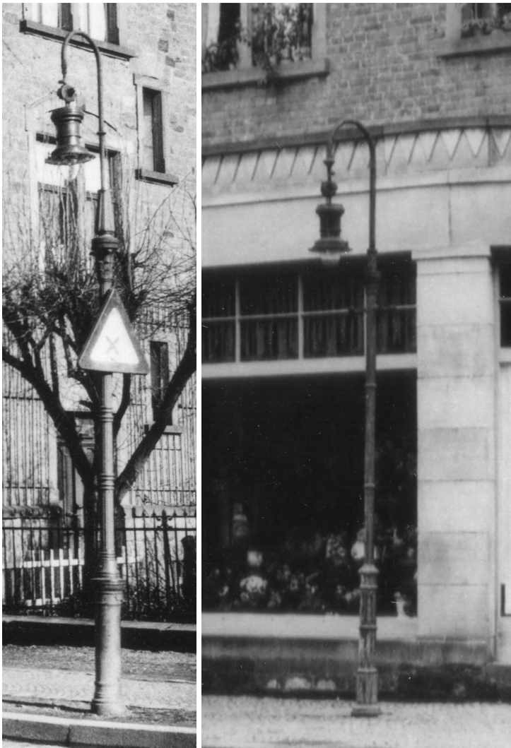
Links: Gashängeleuchte mit Gusskandelaber und Verlängerungsstück der Firma Himmel aus Tübingen in der Gymnasiumstraße; rechts ein Bündelpfeiler in der Bahnhofstraße.
