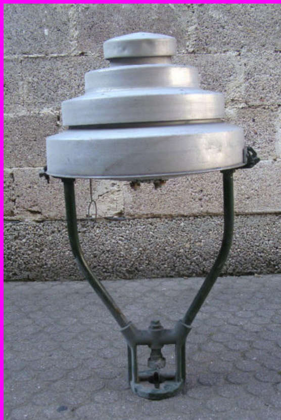
Oben: Das Rech-Leuchtenmodell „33c“ mit dreigliedrigem Stufendach als Variante für seitliche Montage (Ansatzleuchte). Erkennt jemand die Straße in Düsseldorf? Wann dieser Leuchtentyp in Düsseldorf ausgemustert wurde, ist aktuell nicht bekannt. Unten das gleiche Modell als Aufsatzleuchte, Bilder: Slg. PGL und Klaus Gevatter
