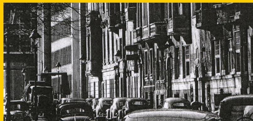
Die Berger Straße im Jahr 1960. Sehr ungewöhnlich muten diese Gasleuchten an. Das rechtwinklige Untergestell trägt teilweise Dächer des Rech-Modells „Dresden“ (vom links), aber auch schon konische Dächer, die vielleicht von der Firma Vulkan stammen könnten. Bild: Slg. PGL
