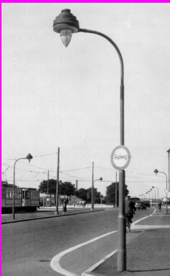
Oben: Das Rech-Leuchtenmodell „33c“ mit dreigliedrigem Stufendach als Variante für seitliche Montage (Ansatzleuchte). Erkennt jemand die Straße in Düsseldorf? Wann dieser Leuchtentyp in Düsseldorf ausgemustert wurde, ist aktuell nicht bekannt. Unten das gleiche Modell als Aufsatzleuchte, Bilder: Slg. PGL und Klaus Gevatter
