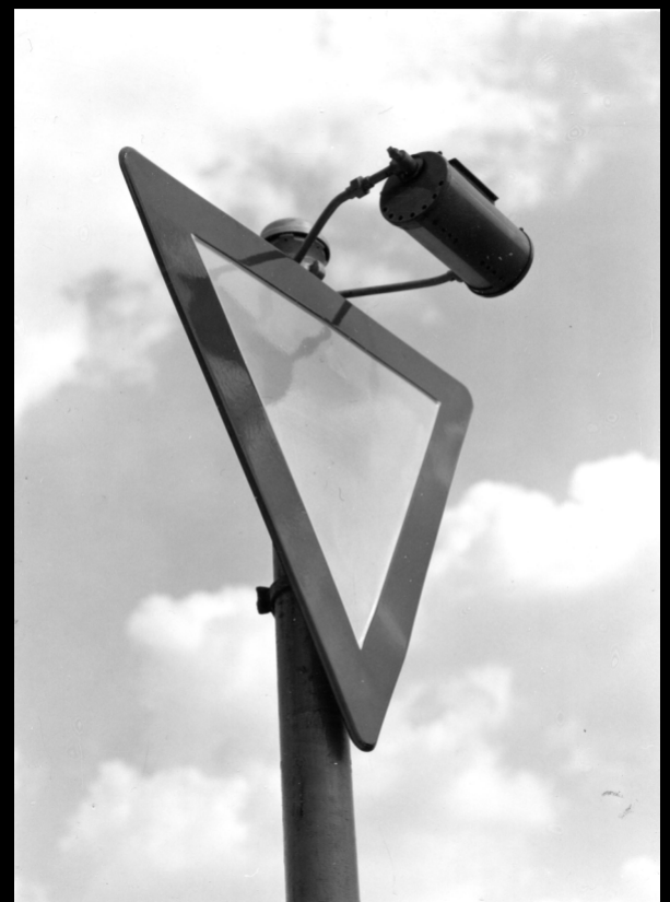
Oben: Von den Berliner Städtischen Gaswerken GASAG entwickelt: Verkehrsschilder mit Anstrahlung durch Gasglühlicht.
