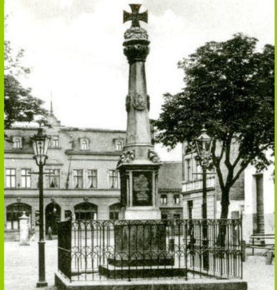
Das 1872 erbaute Kriegerdenkmal in Gerresheim um 1905, Zwei „Alt-Düsseldorfer“ auf Franke-Kandelabern, links mit Einbaubrenner, rechts mit Stehlicht. Bild: Slg. PGL
