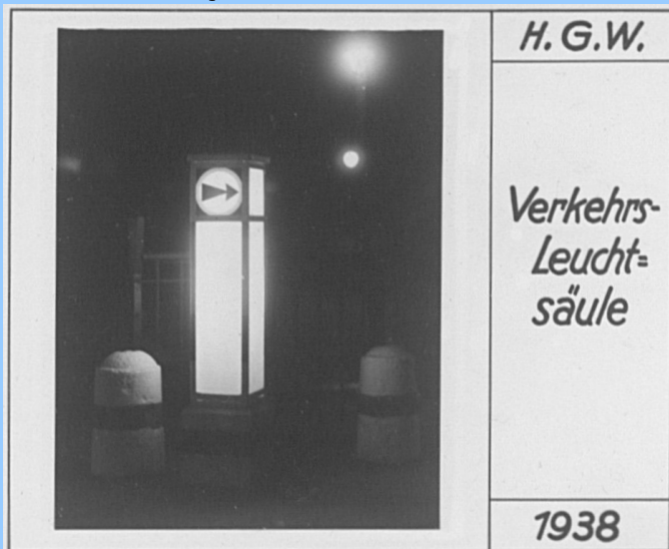
Oben: Leuchtsäule mit Gasglühlicht außen und innen
