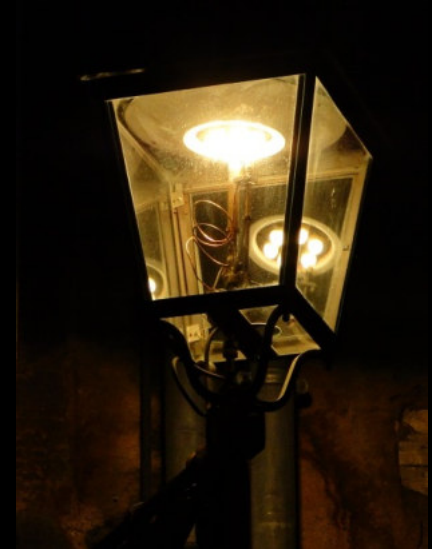
Dreimal Gaslicht aus Frankreich: V.l.n.r. Offene Flamme bei einer Gas-Ausstellung in Lille 1995; Gasstraßenleuchte mit Stehlicht in Malakoff bei Paris (2011) und sechsflamrige Gasleuchte mit heute üblichem hängendem Gasglühlicht in Sarlat-la-Canéda (2013). Bilder: Sammlung ProGaslicht
