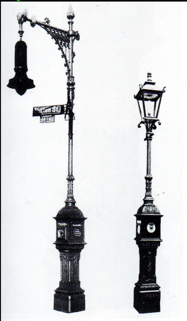
Feuermelder-Gaslaternen: Links in Kassel, rechts in Berlin. Unten ebenfalls zwei typische Berliner Modelle, ein Feuermelder mit aufgesetztem Kandelaber mit Ausleger und Gashängeleuchte, daneben eine Variante mit vierseitiger Gasleuchte. Die letztgenannten waren noch bis in die 1960er Jahre vereinzelt in Berlin anzutreffen, allerdings fehlte da bereits die Leuchte.
