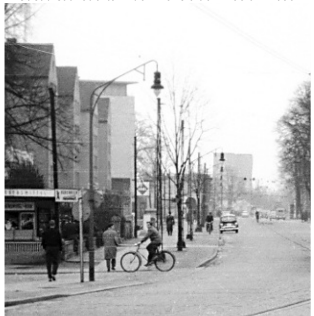
Gashängeleuchten an Stahlmasten mit weitem Ausleger (Bamag) in der Fackenburger Allee (um 1955). Bild: Slg. PGL
