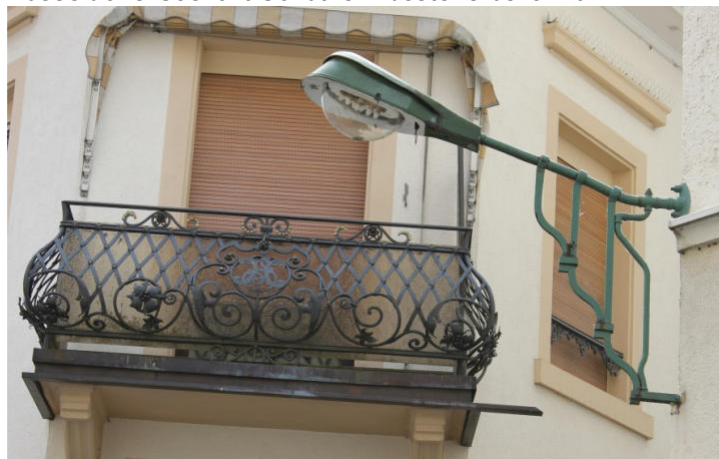
Die Wandhalterungen im Jugendstil trugen ursprünglich Gashängeleuchten. In den 1950er Jahren wurden die Rohre begradigt und die damals modernen Gasreihenleuchten montiert. Die Stadt hat angeblich vor, alle Wandhalterungen zu demontieren. Bild: Oliver Frühschütz
