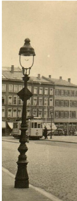
Oben: Ritter-Rundmantellaternen auf Kandelabern (oben eine schlanke Variante) oder wahlweise an Wandhalterungen prägten Worms um 1900. Unten: In den 1920er Jahren begann der Siegeszug des „Modells Köln“, links eine Graetzin-Leuchte mit „Dachform B“ in der Landwehrstraße auf modernem abgetreppten Stahlmast. Rechts auf einem wuchtigen Wormser Stadtkandelaber.
