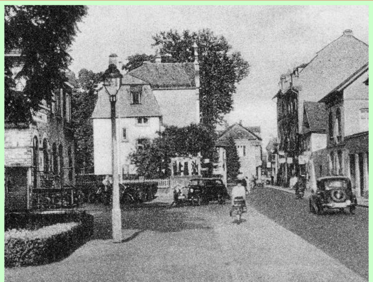
Betonkandelaber mit einer Rech-Gasleuchte „Modell Modern“ in der Oberhöchstader Straße (Anfang der 1950er Jahre).
