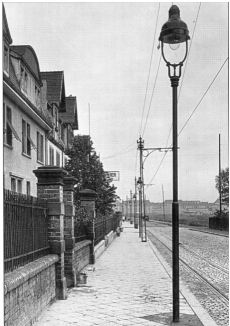
Oben: Ritter-Rundmantellaternen auf Kandelabern (oben eine schlanke Variante) oder wahlweise an Wandhalterungen prägten Worms um 1900. Unten: In den 1920er Jahren begann der Siegeszug des „Modells Köln“, links eine Graetzin-Leuchte mit „Dachform B“ in der Landwehrstraße auf modernem abgetreppten Stahlmast. Rechts auf einem wuchtigen Wormser Stadtkandelaber.
