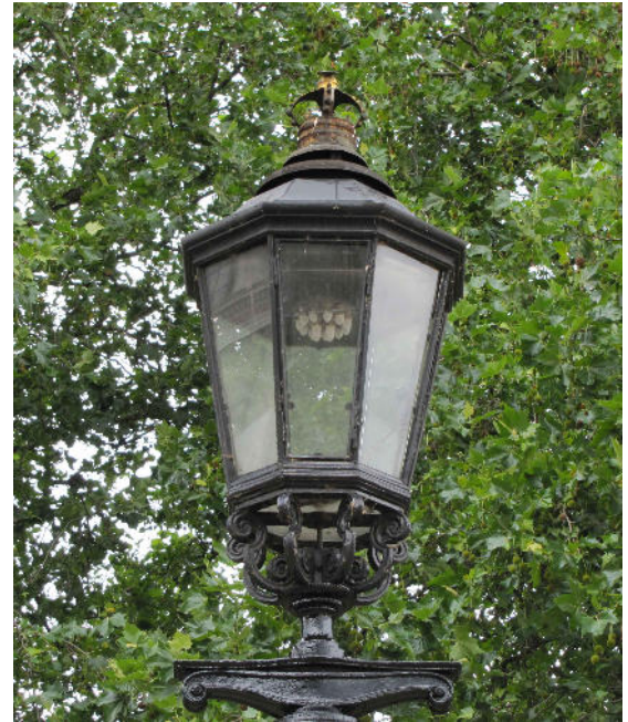
15-flammige Gasleuchte, Bild: Martin Kupf
