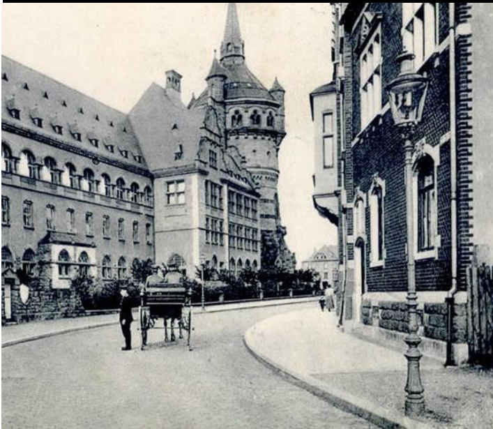
Oben: Ritter-Rundmantellaternen auf Kandelabern (oben eine schlanke Variante) oder wahlweise an Wandhalterungen prägten Worms um 1900. Unten: In den 1920er Jahren begann der Siegeszug des „Modells Köln“, links eine Graetzin-Leuchte mit „Dachform B“ in der Landwehrstraße auf modernem abgetreppten Stahlmast. Rechts auf einem wuchtigen Wormser Stadtkandelaber.
