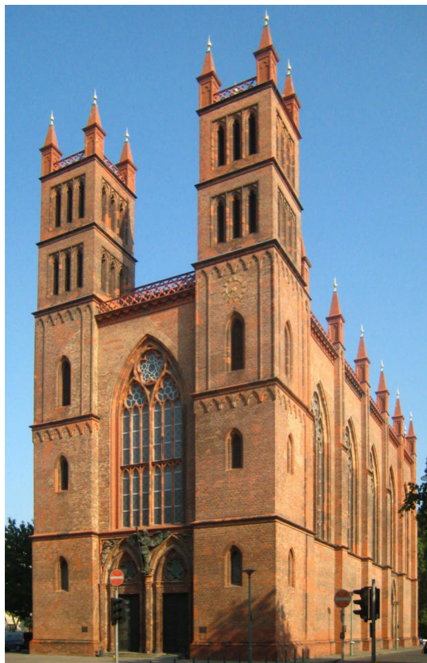
Wie lange steht sie noch? Die zwischen 1824 und 1831 nach Plänen von Karl Friedrich Schinkel erbaute Friedrichswerdersche Kirche, Bild: Beek100
