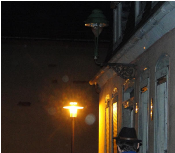
Ein Bild der Schande, aufgenommen in der Straße Luginsland: Im Vordergrund ein Gusswandarm mit stillgelegter Gaslaterne, montiert
