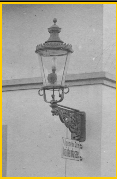
Oben: Rundmantellaterne mit Stehlicht und Fernzündung in der Poststraße; unten gleiches Modell als Wandlaterne, Bild: Stadtarchiv Oberursel
