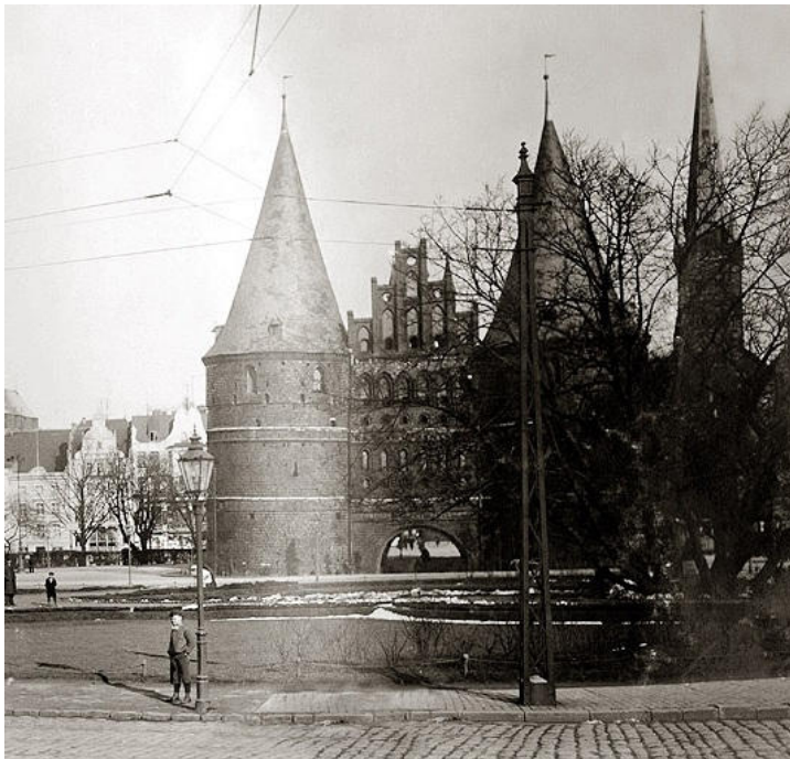
Sechseckige Lateme auf Bündelpfeilmast, im Hintergrund eines der Lübecker Wahrzeichen: Das Holstentor. Bild: Slg. PGL
