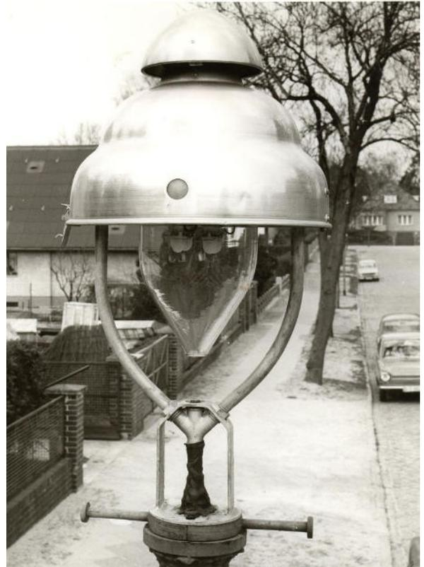
*Wurde zur Stadtbild prägenden Gasleuchte Berlins: Das Modell Bamag U7, hier eine Aufnahme von 1975, versuchsweise mit einer elektrischen Funkenzündung und Kalin-Schaltgerät ausgestattet, Bild: Slg. PGL*
