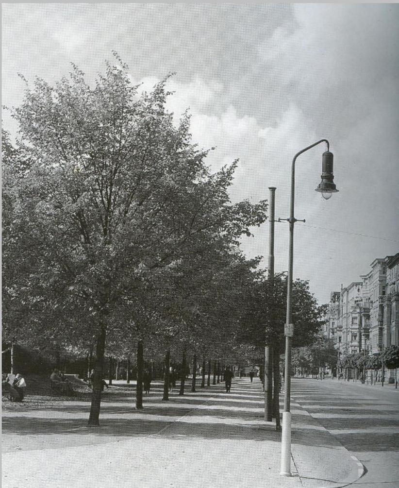
Die Königstraße um 1940 mit einer Gashängeleuchte von Graetzin (kleine Ausführung, vierflammig) auf einem Mast der Eisengießerei Vollgold/Torgelow, Bild: unbekannt/Slg. PGL
