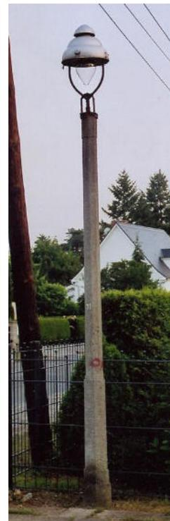
Da die Bakelit-Dächer über die Jahre durch Witterungseinflüsse stark in Mitleidenschaft genommen waren, begann die GASAG nach 1990 damit, diese Leuchten durch Gasleuchten des Typs „Bamag U7“ auszutauschen. Das Ergebnis waren dabei auch Betonkandelaber mit darauf montierter „Bamag U7“, ein etwas außergewöhnlicher Anblick (Bild oben rechts).
