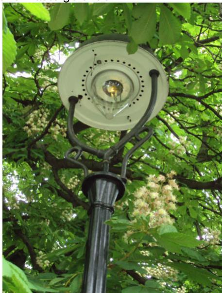
*Bündelpfeiler mit Mastabschluss in Huf-Form, das „Bullenbein“, darauf eine zweiflammige Gasleuchte der Firma Ehrich & Graetz (Modell 1762), Bild: Oliver Frühschütz*
