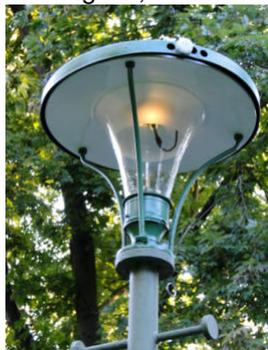
*Links: Ein Kind der frühen 1950er Jahre war die Gas-Pilzleuchte der Firma BESEG (Modell von 1953) mit Glaskelch. Die fast zart und schwungvoll wirkende Gasleuchte wurde auf einem Stahlmast der Firma Langmatz montiert (wie rechts oben),*
