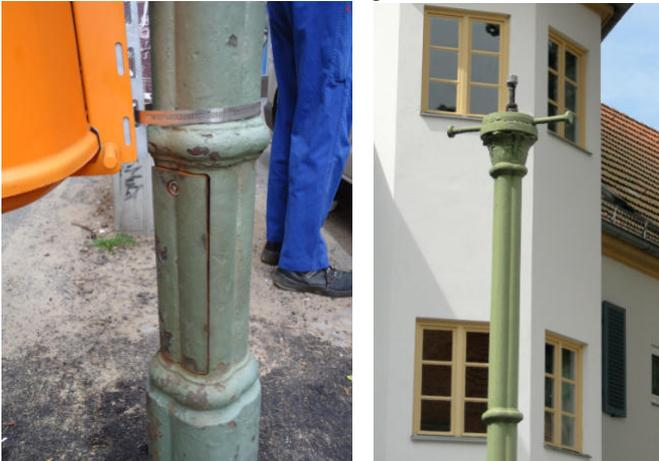
Nicht schön! Links: Bündelpfeilemast mit kürzlich hinein geschnittener Mastklappe für die Elektrobeleuchtung. Rechts ein enthaupteter Bündelpfeiler. Bilder: Slg. PGL
