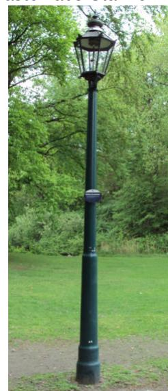
*Links: Die Vorspiegelung falscher Tatsachen. Jeder denkt hier an einen Gusskandelaber, doch das ist nur vorgetäuscht. Es handelt sich um einen Stahlrohlmast mit Verzierungen aus Gussringen eines unbekanntem Herstellers; rechts: die umgekehrte Täuschung. Dieser 1920 entworfene Mast ist nicht aus Stahl, sondern aus Gusseisen ohne jeden Zierrat. Hersteller die Kölner Firma Peter Stühlen. Derartige Maste findet man heute auch in Düsseldorf und Nettetal-Lobberich.*
