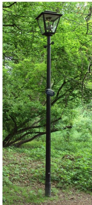
*Stahlmast der oberbayrischen Firma Langmatz mit vierseitiger Gasleuchte, ein Modell aus den 1930er Jahren,*
