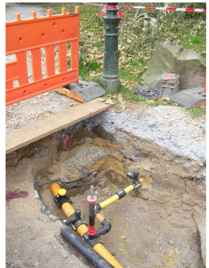
Oben links: Die Wandarme ohne Gasleuchten am Schloss Jägerhof wirken geradezu bizarr; rechts: Eine im Hofgarten frei gelegte Gasleitung aus Kunststoff, Bilder: Thomas Schmitz.
