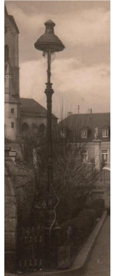
Bamag U5-Gasauflaufleuchte auf einem „Süddeutschen Kandelaber“ im Bildausschnitt. Die komplette Aufnahme umseitig.
