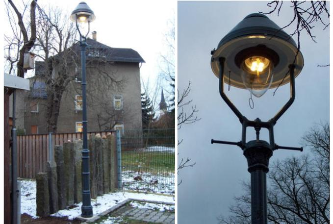
Die neu installierte Gasleuchte ist bestens aufgearbeitet und ans Gasnetz angeschlossen.
