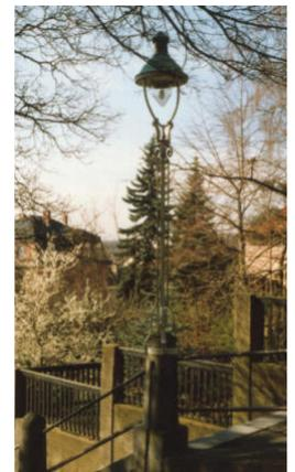
*Links: In Bad Nauheim kam auch ein besonderer Gusskandelaber zum Einsatz, hier mit einem Modell Modern von Rech bestückt, daneben Ausschnittvergrößerungen des Kandelabers und des Sockels mit schönen Verzierungen; rechts eine auf Strombetrieb umgebaute Leuchte „Kölner Bauart“ auf einem Gittermast als Maueraufsatz, Bilder: Slg. ProGaslicht und Klaus Gevatter (rechts).*
