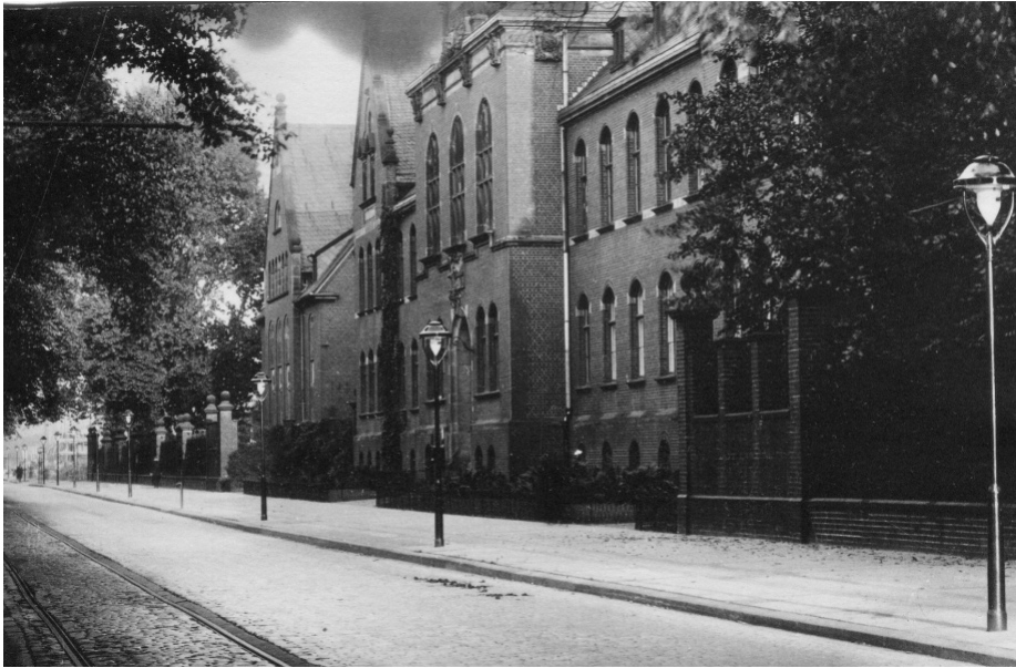
In den 1930er Jahren wurden mehr und mehr Gasaufsatzleuchten eingesetzt, meist auf gasführenden Stahlmasten (Bild links), alternativ verwendete man die historischen Gusskandelaber und versah sie mit Verlängerungsstücken (Zeichnung rechts, Modellleuchte zum Vergleich). Ziel war auch eine Verlagerung der Lichtpunkthöhe nach oben.
