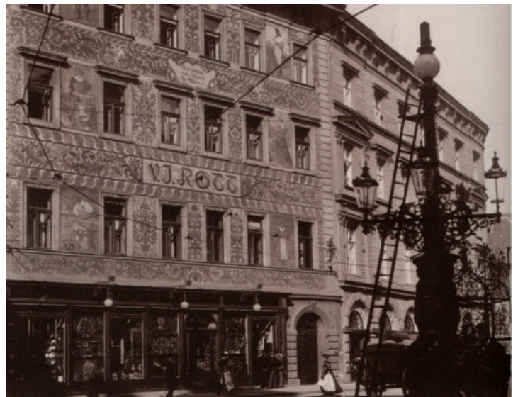
Vierarmige Lichtsäule mit zusätzlicher Kugelleuchte (vermutlich Gas) auf dem Kleinen Ring, Nordseite. Bild: Slg. ProGaslicht
