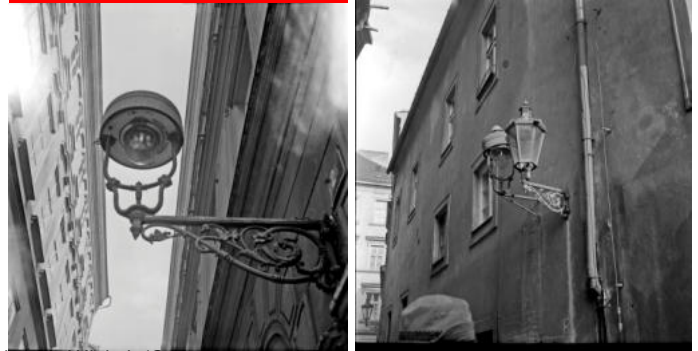
Altstadt-Winkel (Stare mesto), auf dem rechten Bild sieht man, dass eine Standard-Gasleuchte durch eine elektrisch betriebene Gasleuchte ersetzt wird (1970er Jahre). Bilder: Martin Kubík
