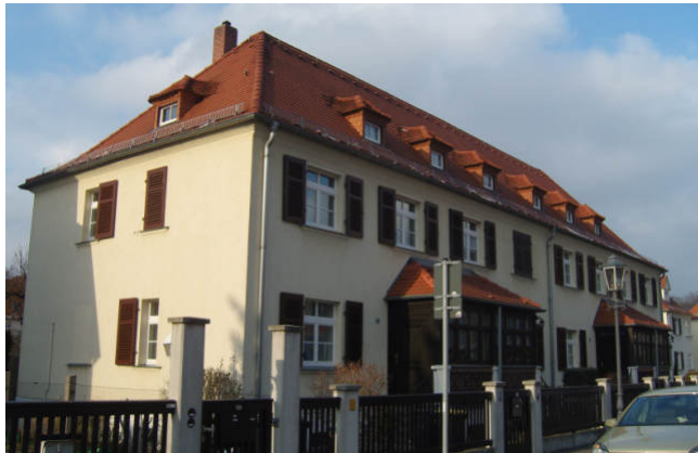
Reihenhaus in der Duckwitzstraße 13 mit Gasleuchte, Bild: Z thomas
