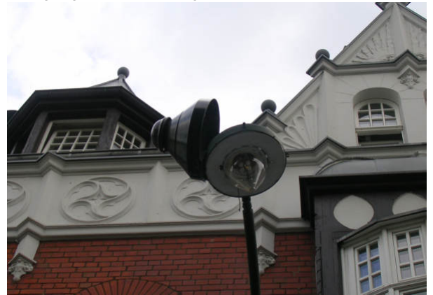
Aufgeklappte Gasleuchte in der Cheruskerstraße, Bild: Thomas Schmitz
