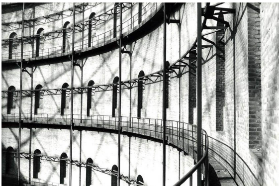
Einer der Gasometer kurz vor der Sprengung, Bild: Michael Tschanz/facebook
