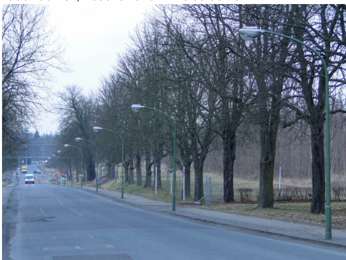
Gasreihenleuchten auf dem früheren Gaswerksgelände, Bild: J. Raetzer
