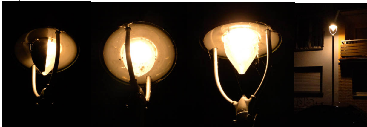
Viermal LED in der Nistergasse: Merkwürdig anzuschauen die halbseitig in Schwarz gestrichene Glasglocke. Ansonsten jede Menge tote Insekten. Die Leuchten mit LED sind ein Friedhof für Kleinstlebewesen. Und die Proportionen (Lichtpunkthöhen) stimmen auch nicht. Bilder: Bettina Grimm
