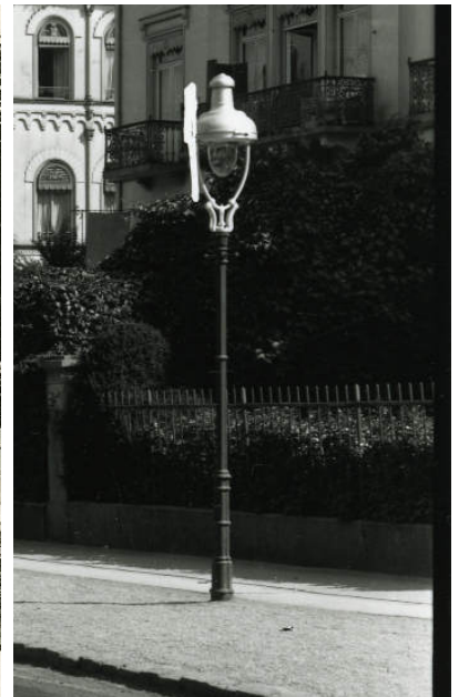
Das Rech-Modell „Elektra 1910“ gehört zu den unmittelbaren Vorläufern des sogenannten Modells Köln, der wohl erfolgreichsten Gasleuchte überhaupt. Links eine Abbildung aus dem Buch „Die Gasdruckfernzündung Bamag“ von 1912; daneben eine Ausschnittaufnahme aus dem Kurort Bad Homburg (Kaiser-Friedrich-Promenade) mit zwei Elektra-Modellen auf Gittermast-Konstruktionen; rechts eines der typischen Modelle Köln – hier von der Konkurrenz, der Firma Bamag – montiert auf dem klassischen Bündelpfeilmast, ebenfalls Bad Homburg. Bilder bzw. Bildausschnitte : Slg. PGL (links) und Stadtarchiv/Fotosammlung Bad Homburg (Mitte und rechts).
