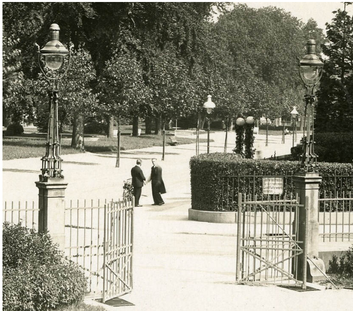
Das Rech-Modell „Elektra 1910“ gehört zu den unmittelbaren Vorläufern des sogenannten Modells Köln, der wohl erfolgreichsten Gasleuchte überhaupt. Links eine Abbildung aus dem Buch „Die Gasdruckfernzündung Bamag“ von 1912; daneben eine Ausschnittaufnahme aus dem Kurort Bad Homburg (Kaiser-Friedrich-Promenade) mit zwei Elektra-Modellen auf Gittermast-Konstruktionen; rechts eines der typischen Modelle Köln – hier von der Konkurrenz, der Firma Bamag – montiert auf dem klassischen Bündelpfeilmast, ebenfalls Bad Homburg. Bilder bzw. Bildausschnitte : Slg. PGL (links) und Stadtarchiv/Fotosammlung Bad Homburg (Mitte und rechts).
