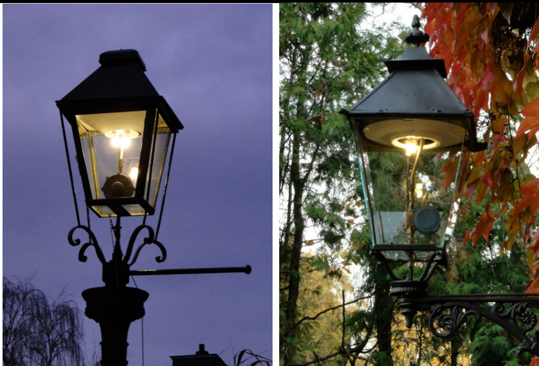
Die Klassiker: Vierseitige Gasleuchten aus Frankfurt und Nürnberg, links die Biedermeier-Laterne in einer Korbkonstruktion, rechts die Nürnberger Schubscheibenlaterne, Bilder: Bettina Grimm (oben) und Thomas Schmitz (unten).
