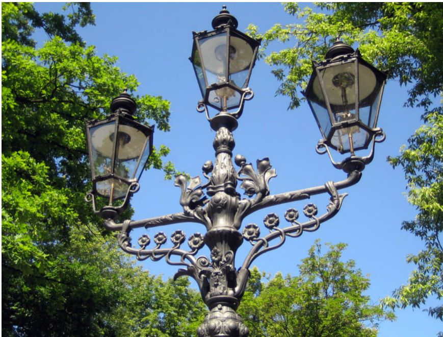
Die volkstümlich „Schinkellaterne“ genannte Berliner Modelleuchte von 1892 dürfte einer der bekanntesten Typen sein. Links ältere Modelle auf einem dreiamigen Kandelaber mit Glasböden, rechts eine modernere Version (unten geschlossen), Bilder: O. Fröhschütz und J. Raetzer
