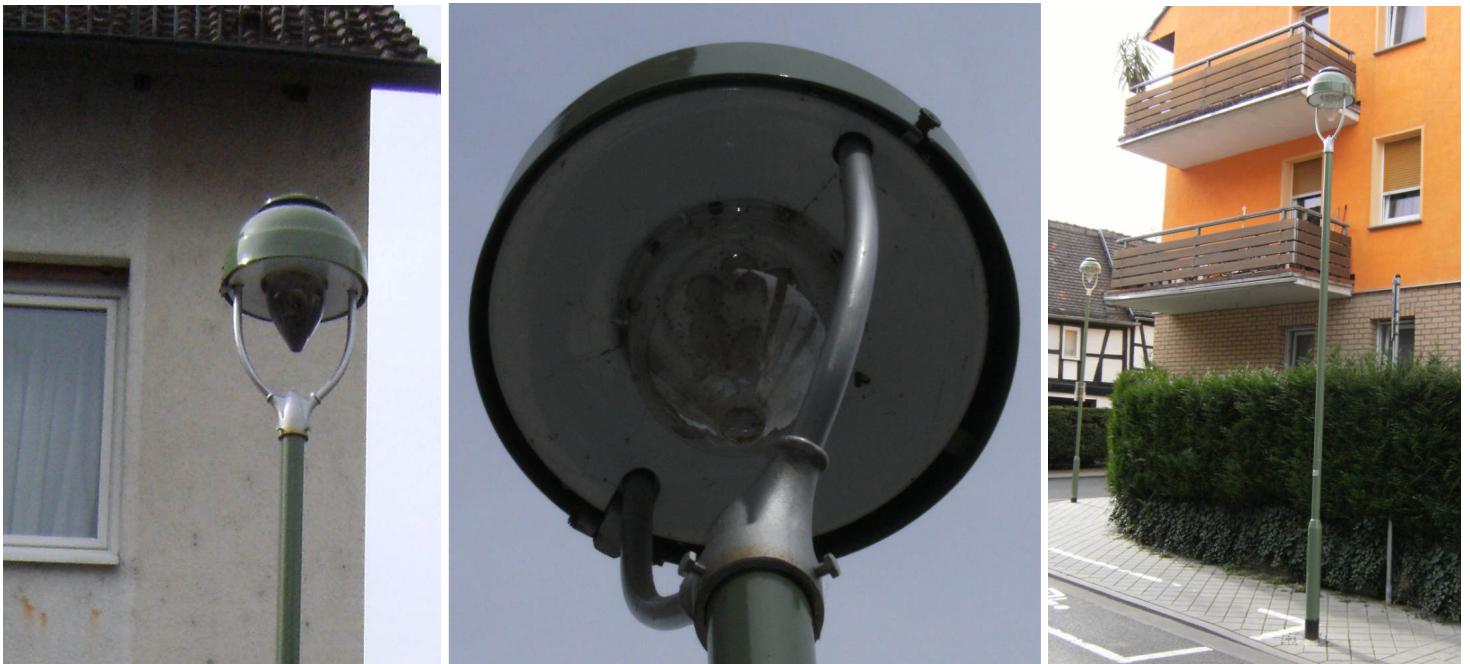
Bilder oben: Gaslaternen-Attrappen mit LED in der Nistergasse; weil das LED-Licht zu grell ist und blendet, wurde die Glasglocke schwarz gestrichen (links); wie Laternen aussehen, die „wartungsarm“, damit aber auch ohne regelmäßige Reinigung sind, zeigt das mittlere Bild. Insekten werden vom LED-Licht angezogen, Glasglocke und Reflektor verschmutzen zusehends; auf dem rechten Bild wird deutlich, dass die Maste und damit die Lichtpunkte zu hoch sind. Bilder: Joachim Raetzer
