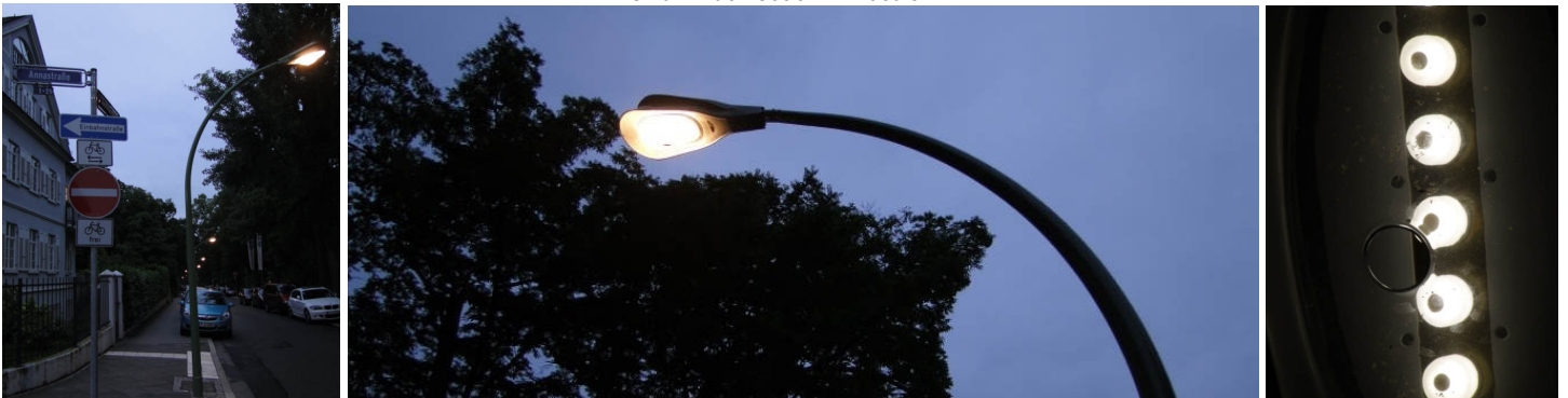
Bilder v.l.n.r.: LED-Gasleuchten-Attrappen in der Justinianstraße. Ihre Form ist ansprechend, das Licht ebenfalls, doch es kommt nicht ganz an Gaslicht heran. Zudem blenden sie etwas. Erstaunlich ist, dass die Gasreihenleuchten-Imitate scheinbar offen sind. Die verwendete Glasschale entspricht derjenigen, die bei Gasleuchten verwendet wird. Elektrische Leuchten wie diese LED's hier müssen vom Prinzip her geschlossen sein. Es darf keine Feuchtigkeit eindringen. Das ist hier offenbar nicht beachtet worden. Bilder: Joachim Raetzer
