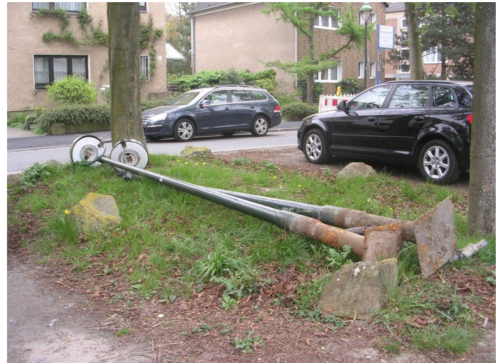
In der Hardtstraße fallen die Gasleuchten dem Abriss zum Opfer. Deutlich zu sehen der außerordentlich gute Zustand der Leuchten und der Gaslichtmaste. Rost Fehlanzeige, braun gefärbt sind lediglich die im Boden verankerten Erdstücke der Laternenmaste.
