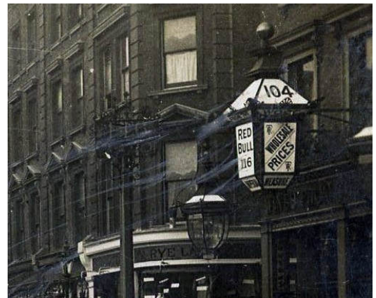
Gewaltige Transparent-Reklame-Gaslaterne in der Peckham High Street, dahinter einer ebenfalls recht große Gas-Straßenleuchte.
