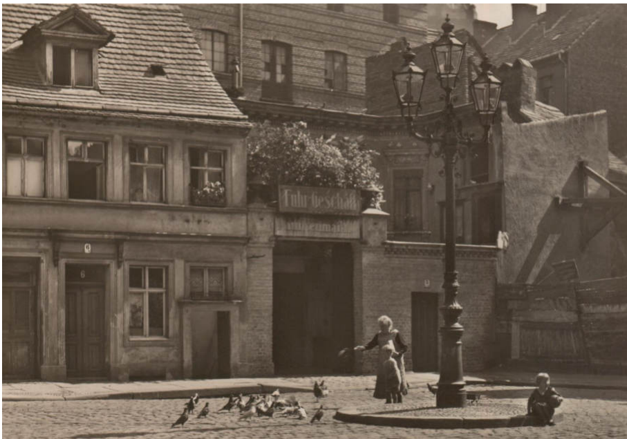
Der „Tiergarten-Kandelaber“ wurde um 1890 entworfen. Auf einem drehsymmetrischen, sich verjüngenden Sockel, der durch mehrere Ringe unterteilt wird, sitzt eine Vasenform mit Verstärkung und Kanneluren, die zwei Ringe mit Wellen und Palmettenbändern trägt. Aus dem darüber befindlichen Akanthusblatt-Kelch wächst ein sich verjüngender Mast mit Kanneluren mit Stegen, der in einem korinthischen Kapitell endet. Über diesem stoßen drei Rohre der Ausleger in einem durch Blumenrosetten gebildeten Knotenpunkt zusammen. Kandelaber und Ausleger bilden eine Kreuzform mit schmiedeeisernen Rankenverzierungen. Links eine Szene vom ehemaligen Jüghof; gut zu erkennen ist der Gasbetrieb; das Bild rechts mit der noch jungen Berliner Mauer und dem Kandelaber mit elektrifizierten Leuchten entstand hinter der Ostseite des Reichstages. Hergestellt wurde der Kandelaber von der Fa. Tangerhütte, Bild links: Sammlung. ProGaslicht; rechts: Sg. Hans Heckmann
