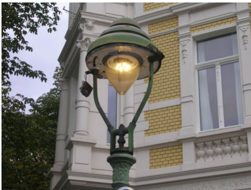
Heraushängendes Schaltgerät in der Weberstraße, Bild: H.-S. Eckhardt
