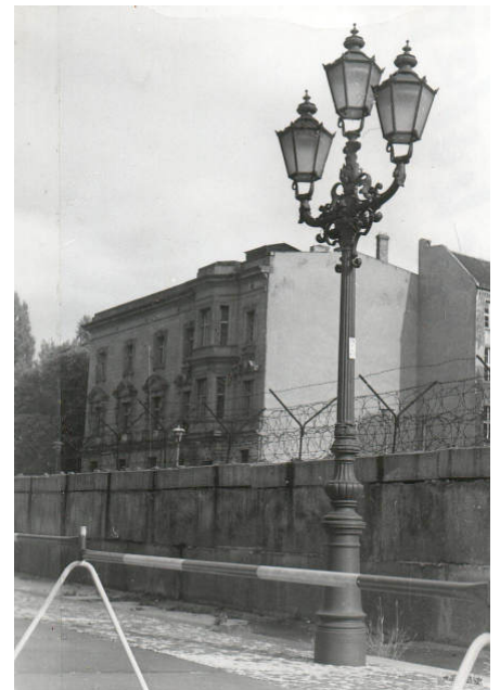
Der „Tiergarten-Kandelaber“ wurde um 1890 entworfen. Auf einem drehsymmetrischen, sich verjüngenden Sockel, der durch mehrere Ringe unterteilt wird, sitzt eine Vasenform mit Verstärkung und Kanneluren, die zwei Ringe mit Wellen und Palmettenbändern trägt. Aus dem darüber befindlichen Akanthusblatt-Kelch wächst ein sich verjüngender Mast mit Kanneluren mit Stegen, der in einem korinthischen Kapitell endet. Über diesem stoßen drei Rohre der Ausleger in einem durch Blumenrosetten gebildeten Knotenpunkt zusammen. Kandelaber und Ausleger bilden eine Kreuzform mit schmiedeeisernen Rankenverzierungen. Links eine Szene vom ehemaligen Jüghof; gut zu erkennen ist der Gasbetrieb; das Bild rechts mit der noch jungen Berliner Mauer und dem Kandelaber mit elektrifizierten Leuchten entstand hinter der Ostseite des Reichstages. Hergestellt wurde der Kandelaber von der Fa. Tangerhütte, Bild links: Sammlung. ProGaslicht; rechts: Sg. Hans Heckmann
