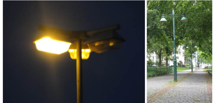
Links: Elektrische Kofferleuchten, hier dreifach an einem Hochmast montiert, Natriumdampflicht, teilweise defekt; rechts: Parkleuchten im Koelzepark in Berlin-Spandau, Bilder: Sammlung ProGaslicht
