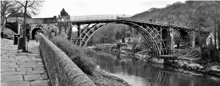
Links: Die Coalbrookdale Bridge war die erste Gusseisenbrücke der Welt, Bild Michael Beckwith; rechts: Die erste deutsche Gusseisenbrücke führte bei Laasan (Niederschlesien) über das Striegauer Wasser, Bild: unbekannt/Böhm-Chronik
