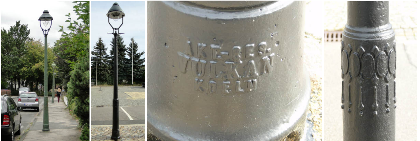
Links: Der Stülen-Kandelaber ist in manchen Straßen Düsseldorfs zu entdecken; rechts: Gusskandelaber der Kölner Vulkan AG mit wenigen Zierelementen im Sockelbereich sowie am oberen Mastabschluss und einer Herstellerkennung, Bilder: Bettina Grimm (links) und Joachim Raetzer.
