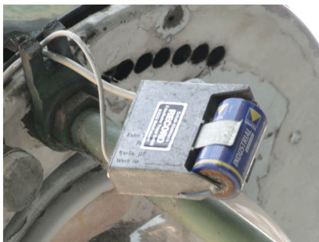
Mutwillig? Die beiden Kabel des Schaltgerätes sind passgenau in die Verschlussgabel eingefädelt. Mit an Sicherheit grenzender Wahrscheinlichkeit können diese Kabel nicht von allein in diese Öse fallen. Die korrodierte Batterie verdeutlicht den Zustand der Zerstörung. Bild: Hans-Stefan Eckhardt
