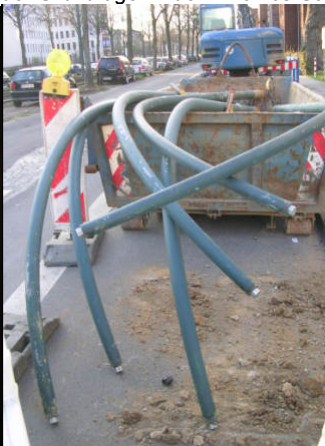
Bilder oben und unten: Auf der Hansaallee war über einen längeren Zeitraum das Gasleuchten-Gemetzel zu beobachten. 137 Gasreihenleuchten wanderten trotz ihres sehr guten Zustandes in den Schrottcontainer. Wie sehr deutlich zu sehen ist, sind keine Korrosionsschäden an den Gas führenden Stahlmasten zu erkennen. Behauptungen, dass solche Gasmasten wegen nachlassender Standsicherheit in großer Zahl entfernt werden müssten, entbehren jeder Grundlage. Bilder: Thomas Schmitz
