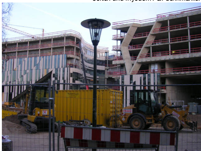
Am Hofgarten entstehen wahre Betonschluchten des „Kö-Bogens“. Gasleuchten wie hier sind in den Augen der Stadtplaner offenbar unpassende Relikte. Zwei Leuchten des Modells „Frankfurt“ wurden inzwischen durch Gaslicht-Attrappen ersetzt. Optisch täuschend echt wird der Gas-Fernzündler als Attrappe eingesetzt, allerdings hat man das Brennerrohr, das zwingend nach oben führen müsste, vergessen. Ein kleiner Lapsus bei der Gestaltung der Fake-Laterne.
