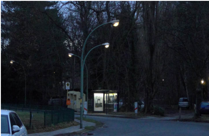
Ein Ensemble von Gas-Reihenleuchten in der Walziger Zeile in Lichtenrade. Diese Gasleuchten sind zum Abriss freigegeben. Die Aufnahme entstand am frühen Morgen. Bild: Bettina Grimm
