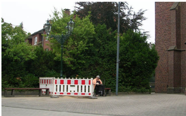
Abgerissen: Der dreiarmlige Gas-Kandelaber in der Kürtenstraße, das Bild zeigt die Absperrung Ende August 2013
