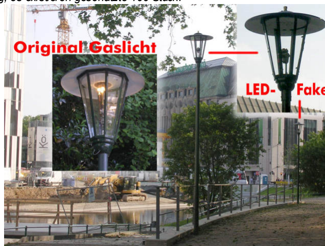
Am Hofgarten entstehen wahre Betonschluchten des „Kö-Bogens“. Gasleuchten wie hier sind in den Augen der Stadtplaner offenbar unpassende Relikte. Zwei Leuchten des Modells „Frankfurt“ wurden inzwischen durch Gaslicht-Attrappen ersetzt. Optisch täuschend echt wird der Gas-Fernzündler als Attrappe eingesetzt, allerdings hat man das Brennerrohr, das zwingend nach oben führen müsste, vergessen. Ein kleiner Lapsus bei der Gestaltung der Fake-Laterne.
