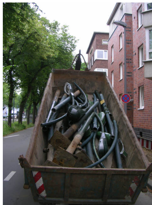
Bilder oben und unten: Auf der Hansaallee war über einen längeren Zeitraum das Gasleuchten-Gemetzel zu beobachten. 137 Gasreihenleuchten wanderten trotz ihres sehr guten Zustandes in den Schrottcontainer. Wie sehr deutlich zu sehen ist, sind keine Korrosionsschäden an den Gas führenden Stahlmasten zu erkennen. Behauptungen, dass solche Gasmasten wegen nachlassender Standsicherheit in großer Zahl entfernt werden müssten, entbehren jeder Grundlage. Bilder: Thomas Schmitz
