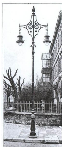
Links: Kandelaber-Sonderbauformen mit Gashängeleuchten von Ehrich & Graetz (1920) in Wiesbaden und Braunschweig. Mitte: Entwürfe der Städtischen Gaswerke Berlin für Pressgasleuchten; rechts: Pressgasleuchte in Berlin-Kreuzberg (1925), Bilder: Slg. PGL
