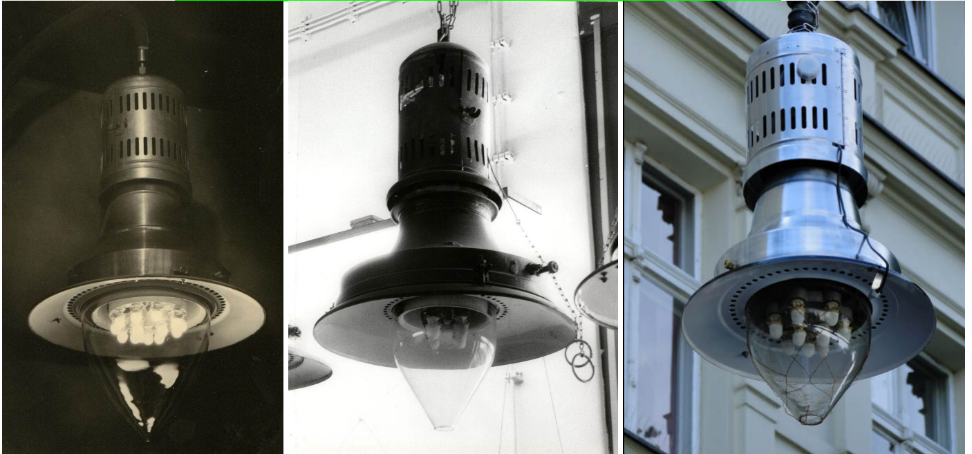
Zeitlos elegantes Design bei den Gashängeleuchten. Anfangs in Handarbeit hergestellt, heute mit vorgefertigten industriellen Bauteilen. V.l.n.r.: Pintsch-Bamag Gashängeleuchte A12, zwölfflammig (1930); Hirschhorn-Gashängeleuchte (1925), vierflammig; Bamag Gashängeleuchte, neunflammig (2012). Bilder: Slg. ProGaslicht
