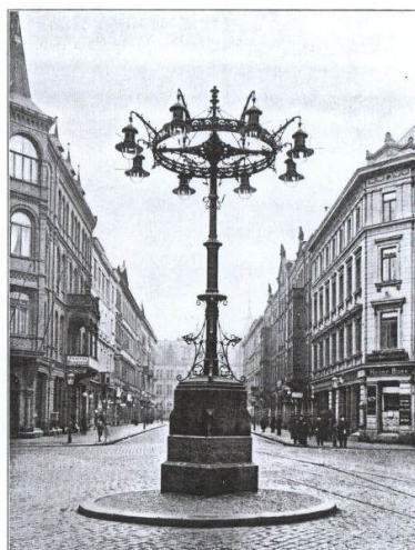
Links: Kandelaber-Sonderbauformen mit Gashängeleuchten von Ehrich & Graetz (1920) in Wiesbaden und Braunschweig. Mitte: Entwürfe der Städtischen Gaswerke Berlin für Pressgasleuchten; rechts: Pressgasleuchte in Berlin-Kreuzberg (1925), Bilder: Slg. PGL
