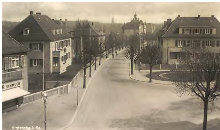
Klotzsche Anfang der 1950er Jahre. Links eine Bamag U7 in der Vorkriegsausführung auf einem Kandelaber von Carl Francke, Bremen, Bild: Stg. PGL
