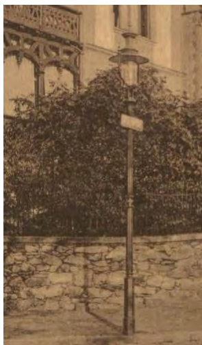
Abb. 13. Rechlsterne mit eingebautem normalen Gasdruckfernzündler „Bamag“ und mit ausgebohrtem Glassantel; Aufstapfützen ohne Hahn
