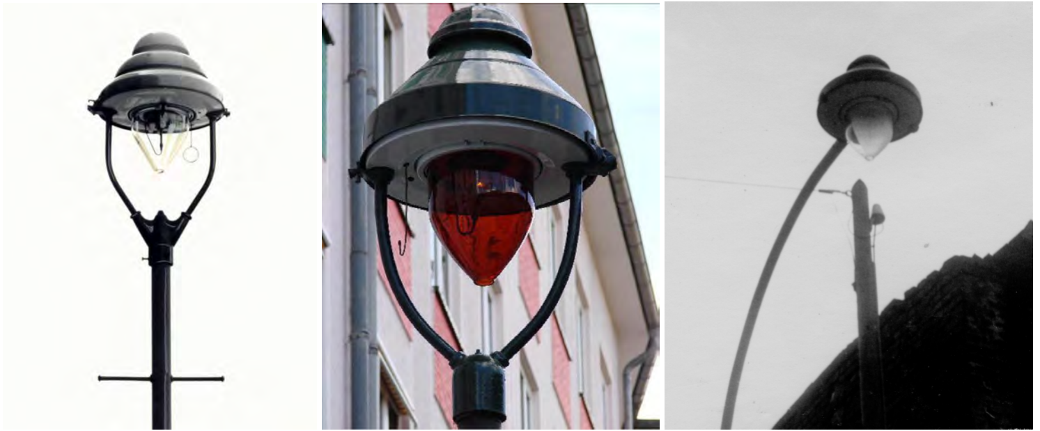
Links: Spitze Rasotherm-Glocke aus DDR-Produktion in einer Würzburger Rech-Gasleuchte; Mitte: Als weitere Besonderheit eine rote Auer-Glocke für den Düsseldorfer „Kontakthof hinter dem Bahndamm“; rechts: Halbseitig mattierte Glocke in Heidelberg.
