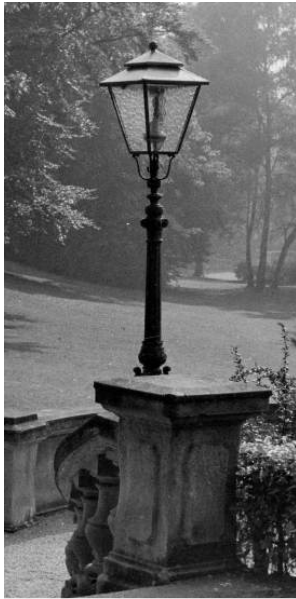
Links: Vierseitige Gasleuchte des Modells „Unter den Linden“ im Nerotal um 1961. Deutlich ist der Meteor-Fernzünder zu sehen; Mitte: Mehrarmiger Gaskandelaber um 1960 auf dem Schlossplatz (Wappeninsel) mit Rundmantel-Gasleuchten; rechts: Der gleiche Kandelaber, aber nun mit elektrischen Leuchten, diese anstatt mit Glasscheiben jetzt mit matten, blinden Plasticscheiben. Der prächtige Lichtständer sieht dadurch verkitscht aus. Bilderausschnitte Stadtarchiv Wiesbaden, rechts: Wikipedia
