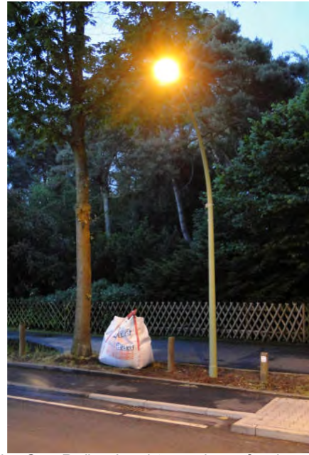
Optisch der Gas-Reihenleuchte nachempfunden, tatsächlich jedoch eine elektrische Leuchte mit Natriumdampfbeleuchtung. Das grell-braunorange Licht blendet extrem und taucht die Umgebung in einen braun-gräulichen Farbton. Bild: Bettina Grimm
