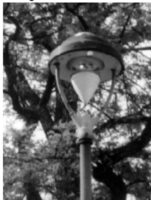
Detmold (li.) und Hannover (Mitte u. re.) blieben der Blohm- bzw. Breitstrahlerglocke bis zuletzt (1982/83) treu.
