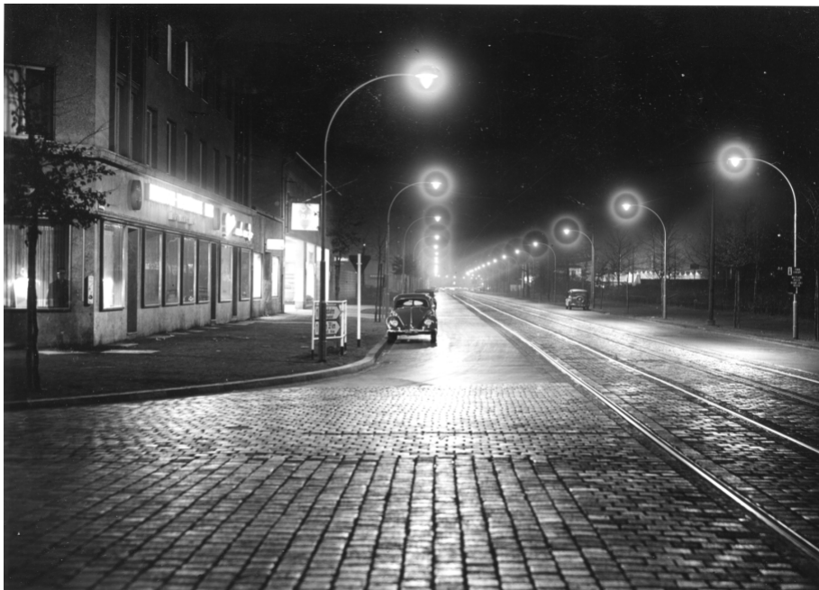
Die Brehmstraße in Düsseldorf (zwischen Mörsenbroich und Düsseldorf), deutlich sieht man die nächtliche Wirkung der Blohm-Glocken in 9-flammigen Ansatzleuchten, sie wurden 1953 aufgestellt. Das Bild entstand kurz danach. Bild: Stadtwerke Düsseldorf
