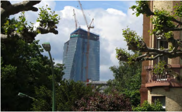
Im Vordergrund eine Natriumdampfleuchte an einem Mast, der einem Gas-Reihenleuchtenmast abgekupfert wurde. Im Hintergrund links das Gas-Original. Das in Bau befindliche Hochhaus wird Teil der Europäischen Zentralbank. Bild: Wikicommons
