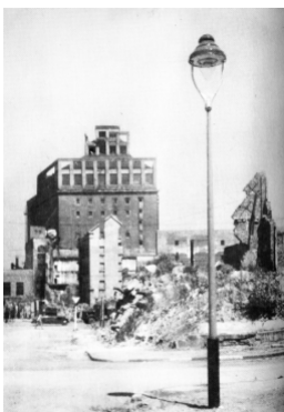
Bild links: Die älteste bekannte Aufnahme mit einer spitzen Klarglocke heutiger Ausführung ist diese, entstanden um 1947 im noch weitgehend kriegszerstörten Dortmund mit einer neuen Schneider-Aufsatzleuchte Modell Neulicht. Bild: Archiv Dortmunder Stadtwerke AG
