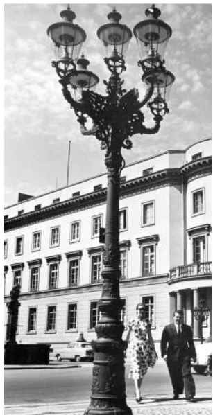
Links: Vierseitige Gasleuchte des Modells „Unter den Linden“ im Nerotal um 1961. Deutlich ist der Meteor-Fernzünder zu sehen; Mitte: Mehrarmiger Gaskandelaber um 1960 auf dem Schlossplatz (Wappeninsel) mit Rundmantel-Gasleuchten; rechts: Der gleiche Kandelaber, aber nun mit elektrischen Leuchten, diese anstatt mit Glasscheiben jetzt mit matten, blinden Plasticscheiben. Der prächtige Lichtständer sieht dadurch verkitscht aus. Bilderausschnitte Stadtarchiv Wiesbaden, rechts: Wikipedia
