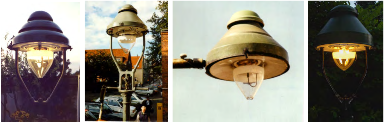
V.l.n.r.: Auer-Glocke „Modell Rhenag“ in Rech-Leuchte; Vulkan 87 in Lübeck mit großer (245mm) Glocke; Schneider-Ansatzleuchte Neulicht-52 mit kleiner (206mm) Glocke in Heidelberg; runde 206er Rhenag-Glocke in einer Braunschweiger Bamag U 10
