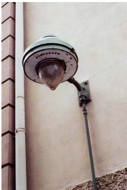
Jämmerlicher Anblick: Auf Strom umgebaute und deshalb wartungsfreie (damit auch reinigungsfreie?) Ex-Gasansatzleuchte, Bild: Bettina Grimm
