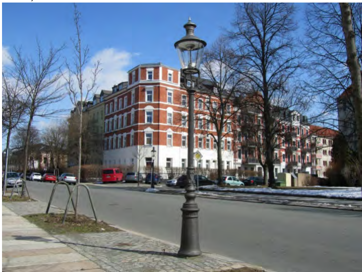
Vor der Demontage: Gasleuchten in der Salzstraße.
